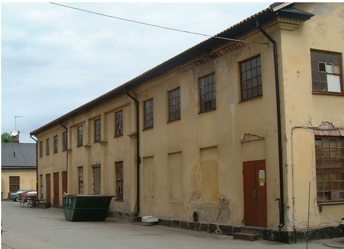
3. Gamla verkstadens fasad mot innergården och delar av södra fasaden, innan renoveringsåtgärderna. Foto: Ove Eriksson, BKL.
