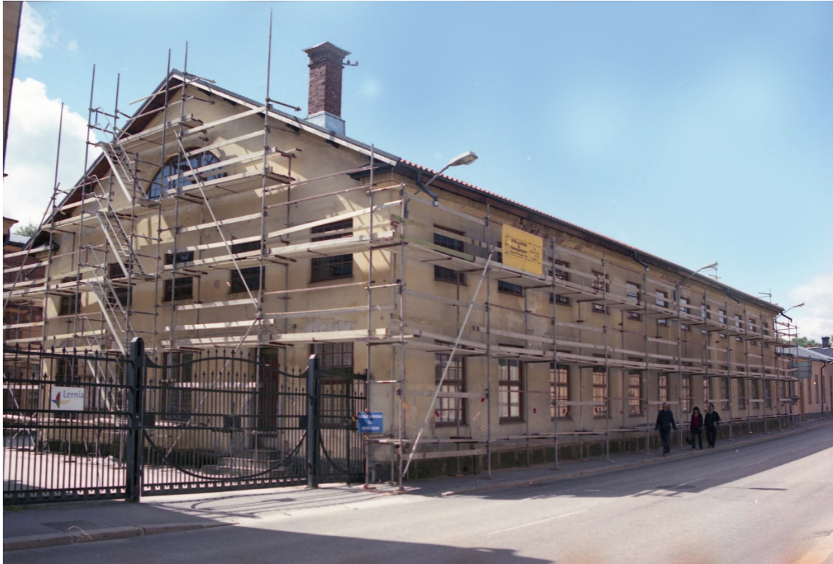
38. Gamla verkstaden mot Glasgatan under renoveringen.
