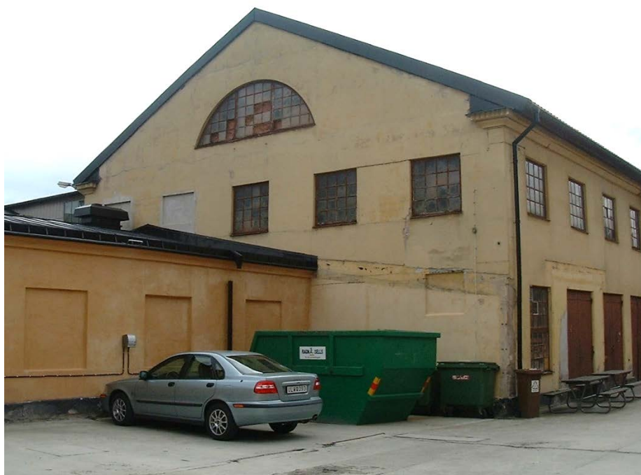
4. Norra fasaden innan renoveringsåtgärderna. Foto: BKL, Ove Eriksson
