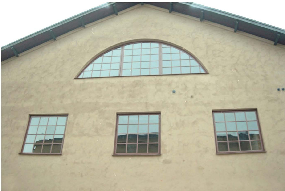
20. Lunettfönstret på södra fasaden efter renoeringen.
