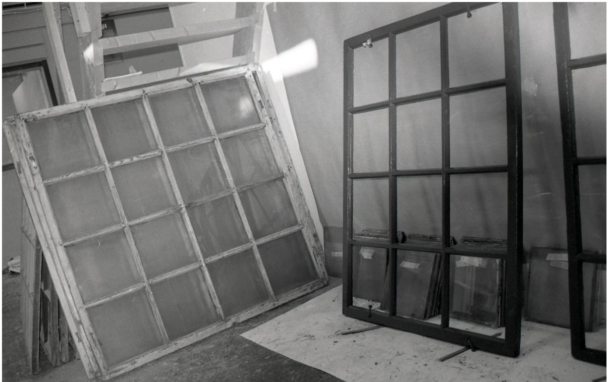
6-9. Fönsterbågar under renovering och målning.
