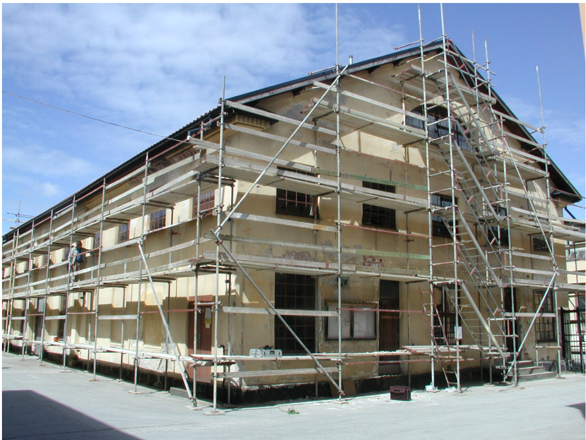
36–37. Gamla verkstaden mot innergården under renoveringen.
