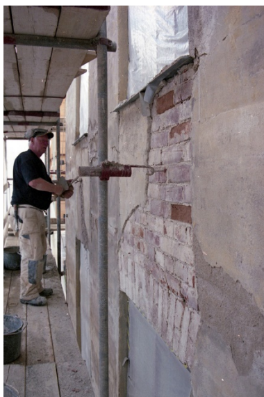
22–29. Löst sittande puts, äldre lagningar och bom höggs ned. Äldre puts bevarades så mycket som möjligt. Delar av byggnaden är uppförd som ett gjuthus, synligt på bilderna i mitten.
