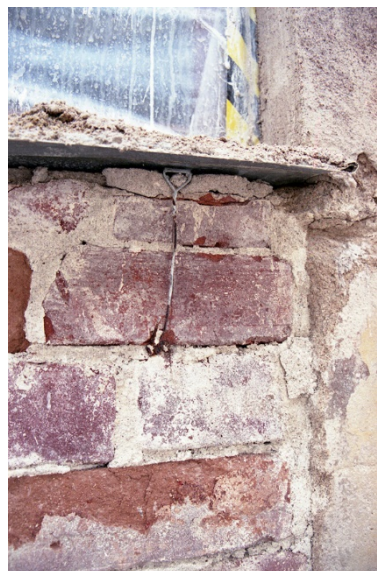
22–29. Löst sittande puts, äldre lagningar och bom höggs ned. Äldre puts bevarades så mycket som möjligt. Delar av byggnaden är uppförd som ett gjuthus, synligt på bilderna i mitten.
