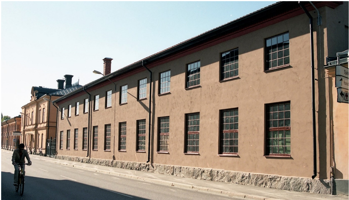
69. Fasaden mot Glasgatan efter renoveringsåtgärderna, fotad mot söder.
