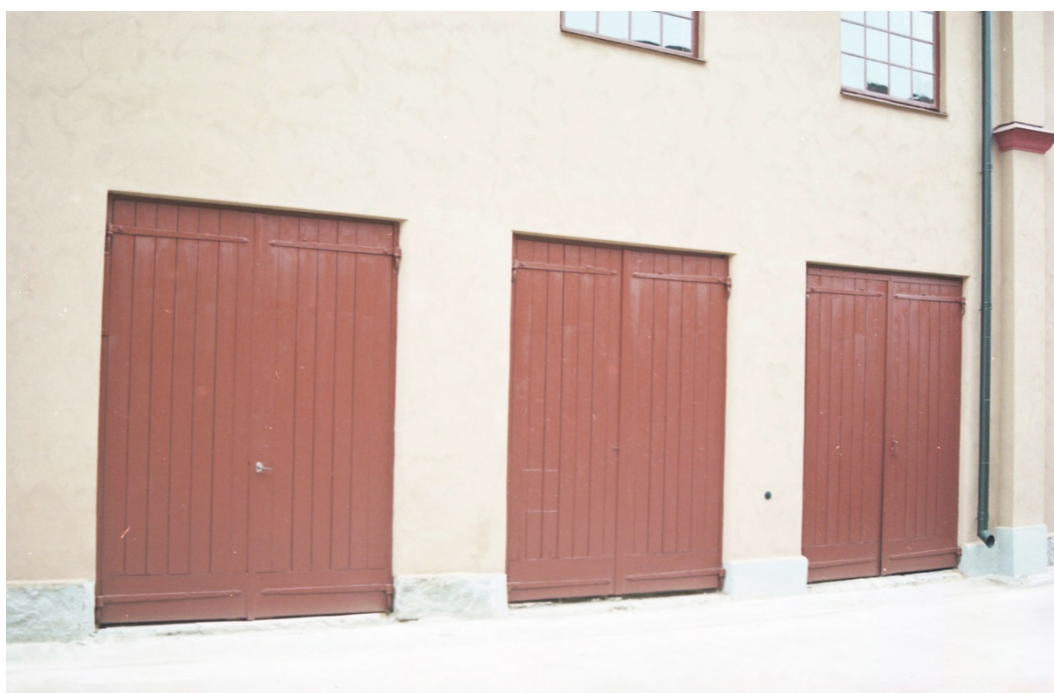
54–55. Garagedörrarna skrapades rent och målades med samma metod som byggnadens fönster.
