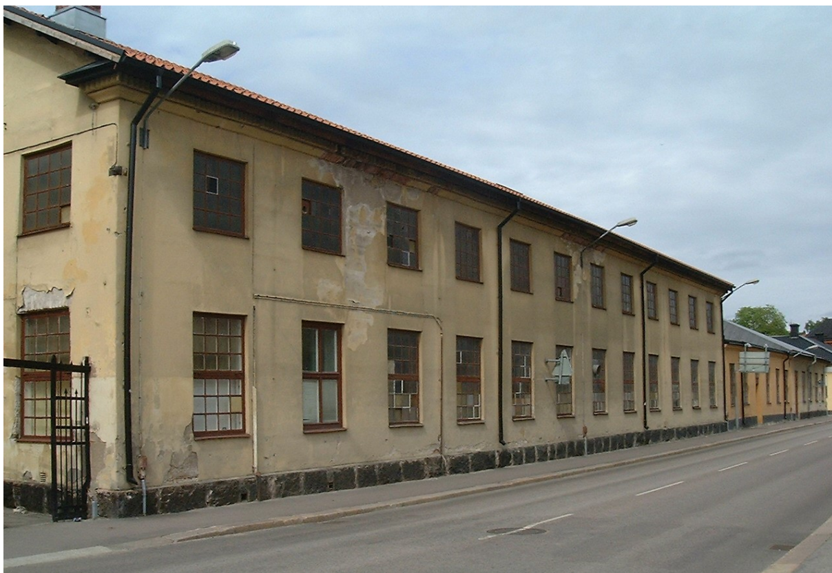
5. Gamla verkstadens fasad mot Glasgatan, innan renoveringsåtgärderna. Foto: BKI, Ove Eriksson.
