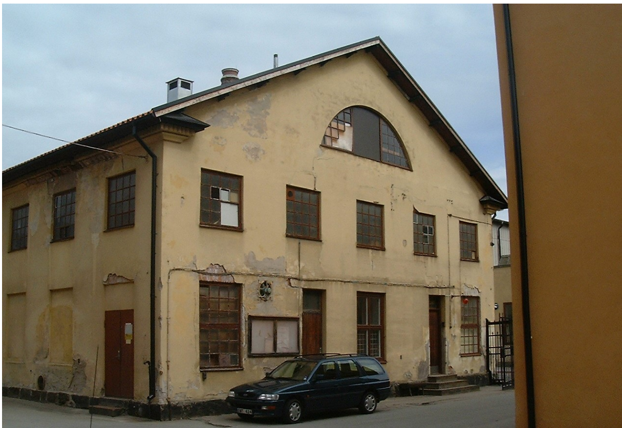
2. Gamla verkstadens södra fasad innan renoveringsåtgärderna. Foto: Ove Eriksson, BKL.
