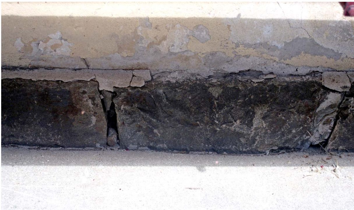
49. På vissa delar var anslutningen mellan sockeln och fasaden samt fogen i en grov puts, troligen cement.
