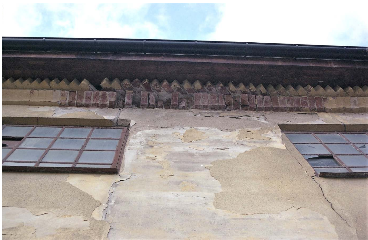
39. Den dekorativa taklisten var i dåligt skick. Stora partier saknade puts och tegelstenar saknades.
