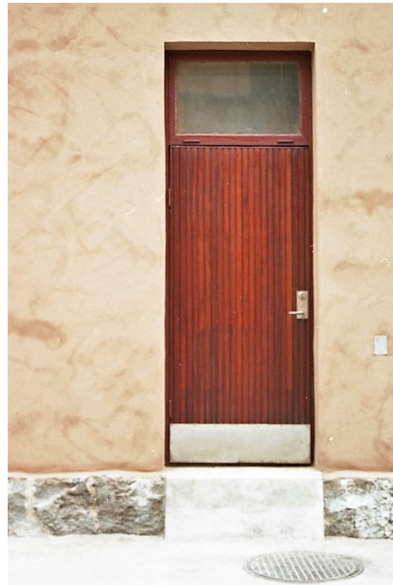
56-59. Äldre fernissa slipades bort på dörrarna med karosseripanel. Därefter behandlades de med oxalsyra eller terpentin för att sen linoljeimpregneras.
