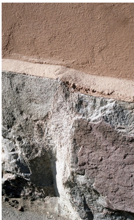
52-53. I anslutningen mellan fasad och sockel lades en fas i hydrauliskt kalkbruk. Fasen följer formen av sockeln.
