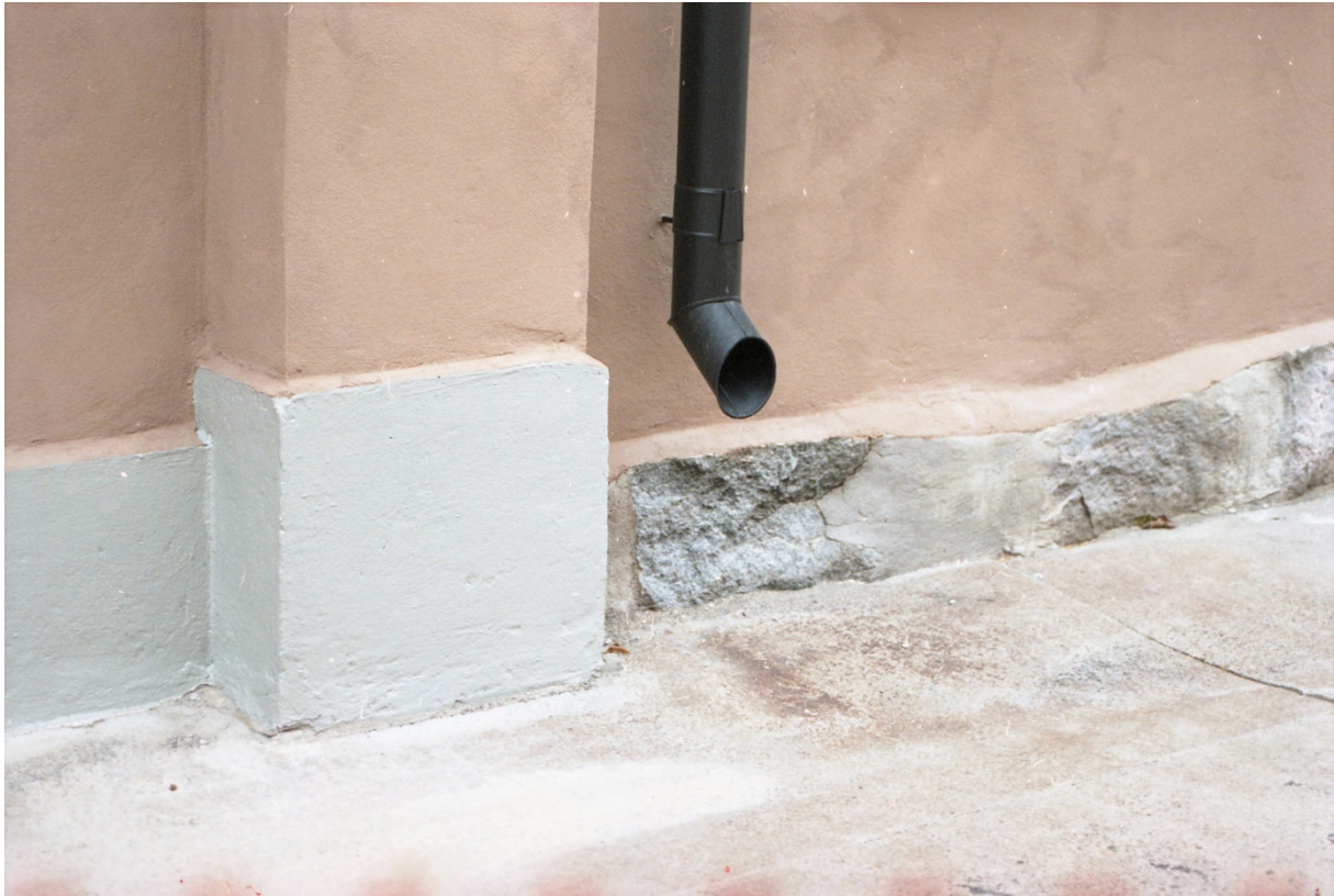
51. Efter renoveringsåtgärderna. Granitsockeln rengjordes och fogades med hydrauliskt kalkbruk. Den putsade sockeln lagades och målades med silikatfärg i en grå kulör.
