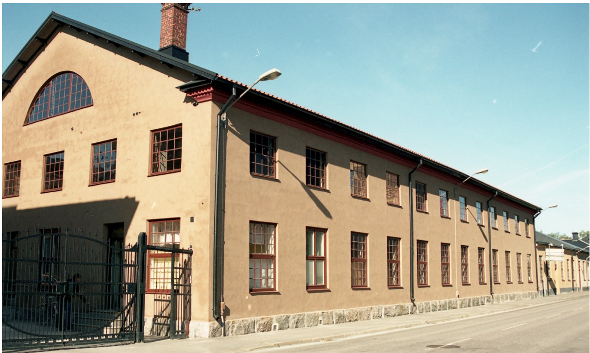
68. Fasaden mot Glasgatan efter renoveringen. Det äldre fönsterglaset placerades främst i fönsterbågarna på det övre våningsplanet och i lunettfönsterna mot norr och söder. Granitsockeln rengjordes från den svarta asfaltsfärgen.
