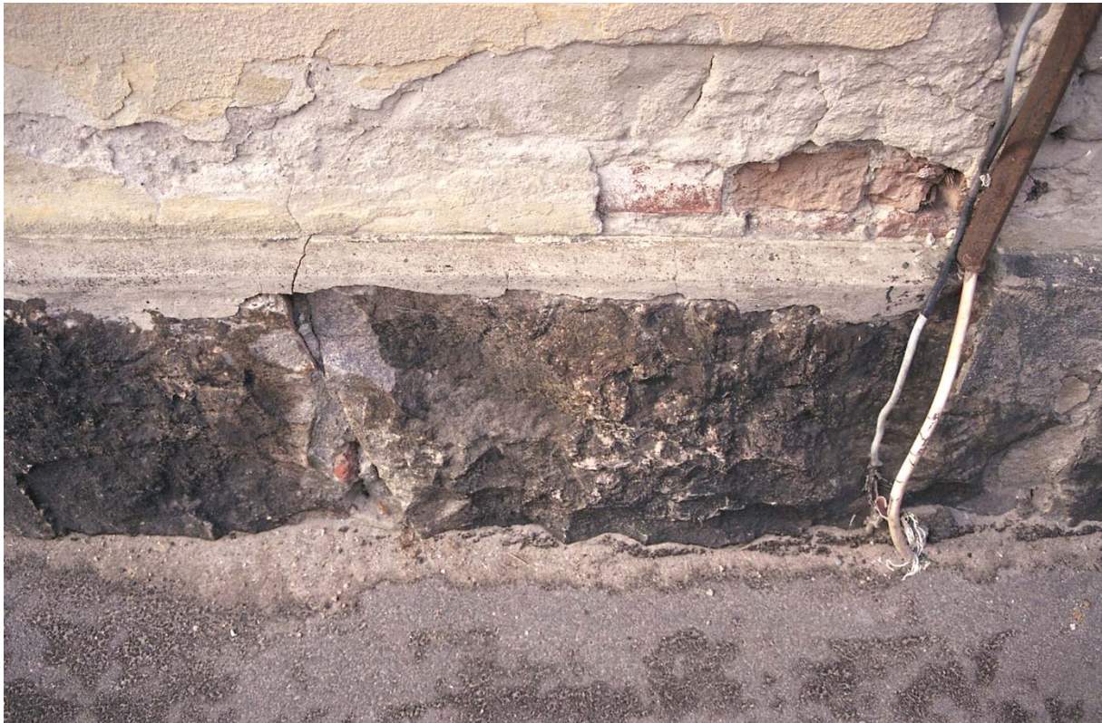
48. Granitsockeln var målad med någon typ av asfaltsfärg. Ett nyare putslager förekom i anslutningen mellan fasad och sockel.
