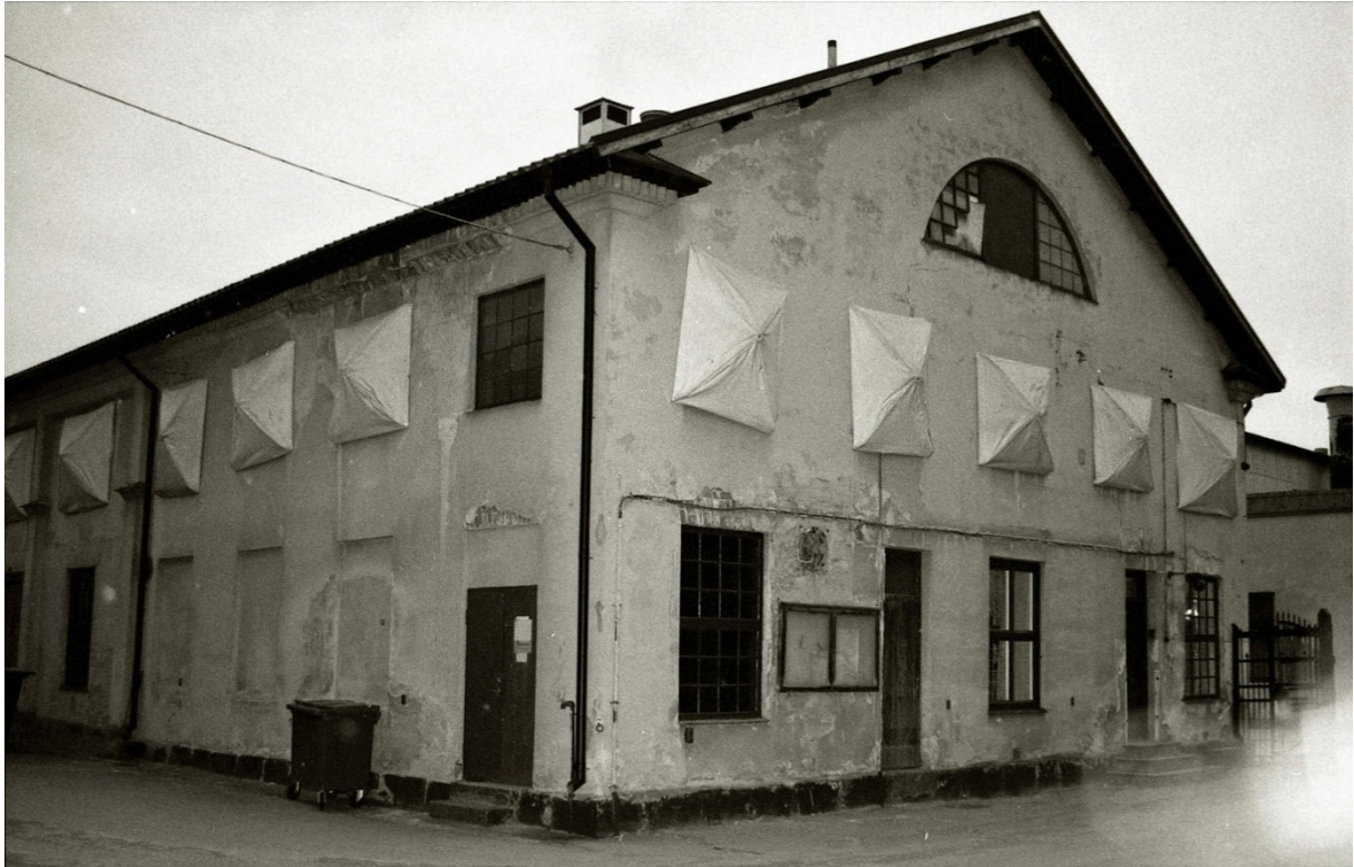
15. Fönsterbågarna plockades ut. Foto taget under januari 2005.
