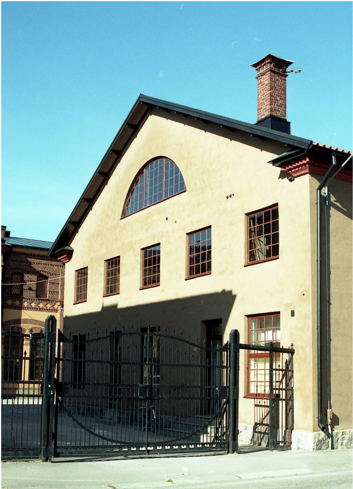
65. KMV-verkstadens fasad mot söder och områdes entré, efter renoveringsåtgärderna. Vindskivor och takfot målades med stubbkära från Wibo.
