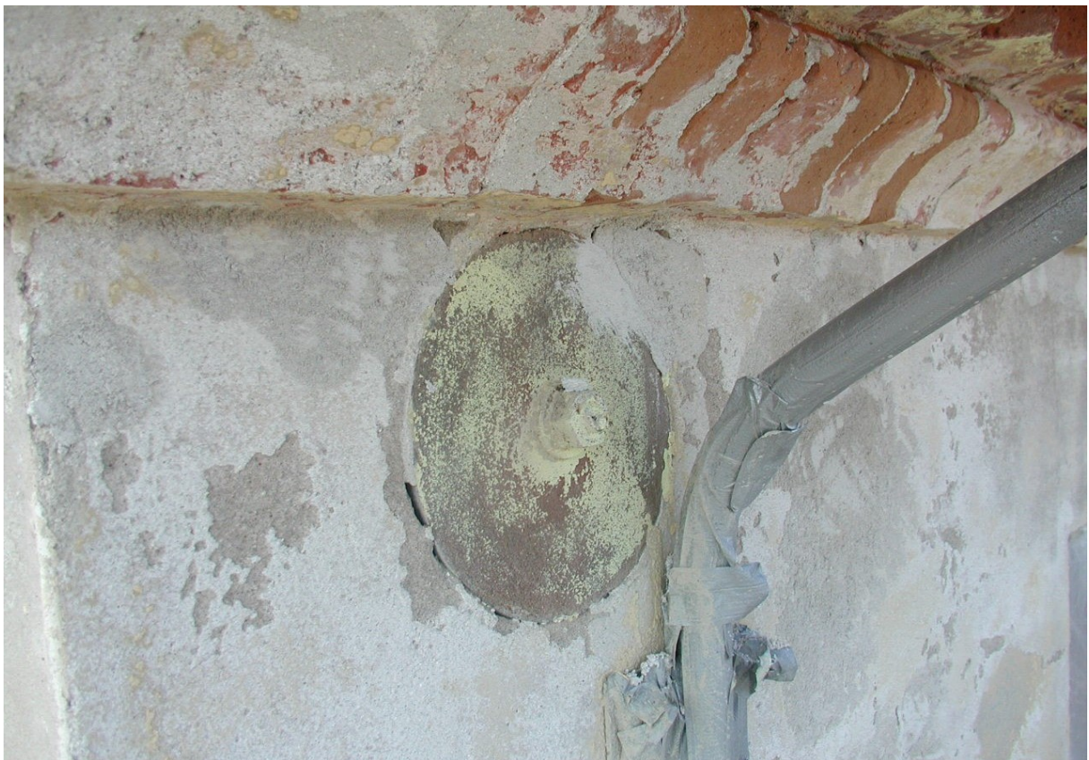
45. Metallplattor förekom på flertal ställen på fasaden. Det spekulerades i om detta kunde vara en fästordning till ett dragjärn. Inga dragjärn återfanns dock i byggnaden.
