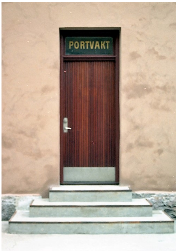
56-59. Äldre fernissa slipades bort på dörrarna med karosseripanel. Därefter behandlades de med oxalsyra eller terpentin för att sen linoljeimpregneras.
