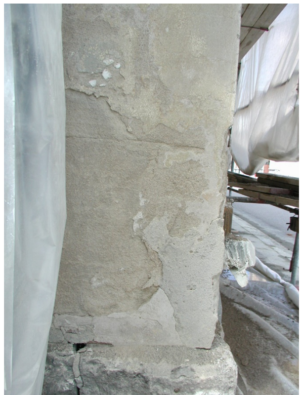
30–35. I putsen på fasaden återfanns ett antal metallplattor som troligen haft en stabiliserande effekt. Samtliga pilastrar hade ett grövre bruk på oöansidan.
