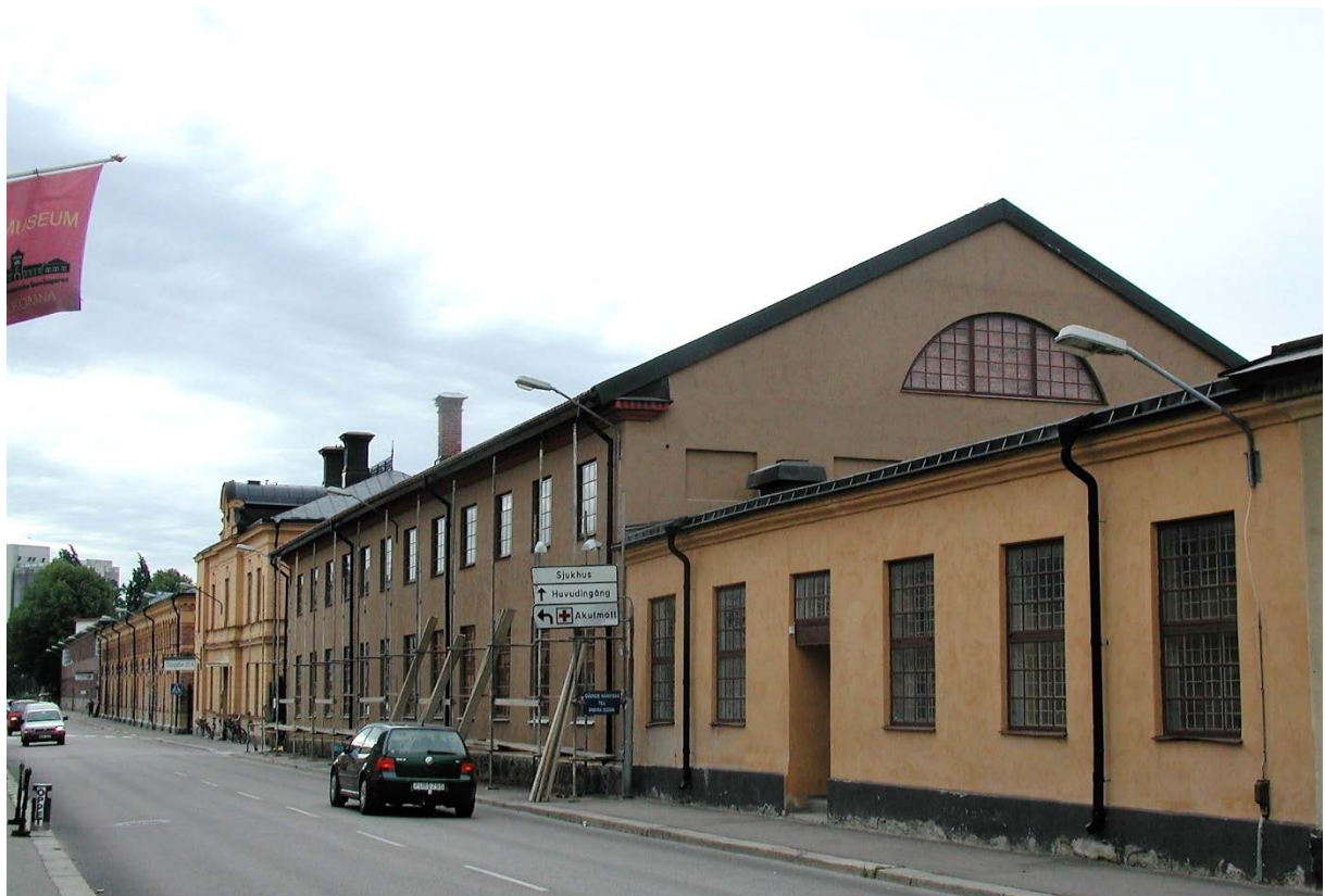
70. Glasgatan med flera av byggnaderna som tillhörde Köpings Mekaniska Verkstad. Under pågående renovering av Gamla verkstadslokalen.
