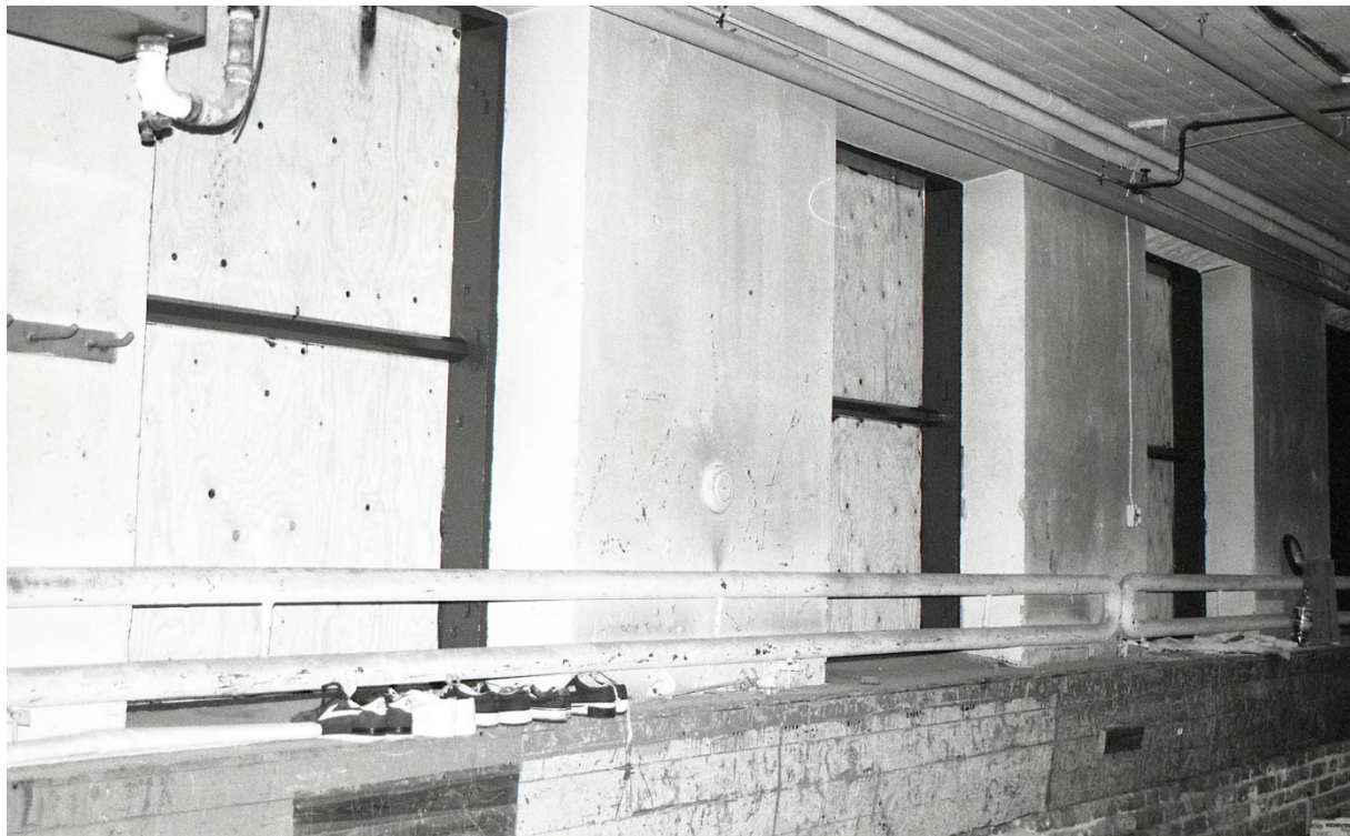
16. Karmarna målades på insidan under etappen för fönsterrenoveringen. Utsidan på karmarna målades efter fasadarbetet.
