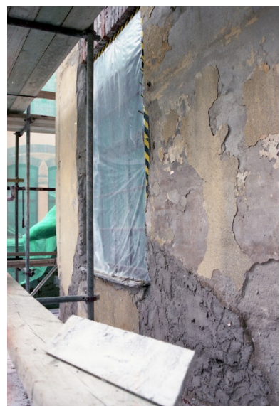
22–29. Löst sittande puts, äldre lagningar och bom höggs ned. Äldre puts bevarades så mycket som möjligt. Delar av byggnaden är uppförd som ett gjuthus, synligt på bilderna i mitten.
