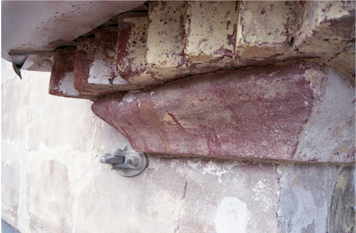
46. Under den nyare putsen på taklisten och pilastrarnas kapitäl återfanns en äldre puts i en mörkröd kulör. Kulören återfanns på taklisten runt hela byggnaden.
