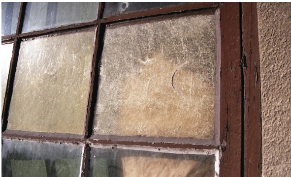
10–14. I flera fönsterbågar var det äldre glaset ersatt med olika material så som floatglas, plexiglas, masonit eller ventilationsanordningar. Fönsterbågar före renoveringen.
