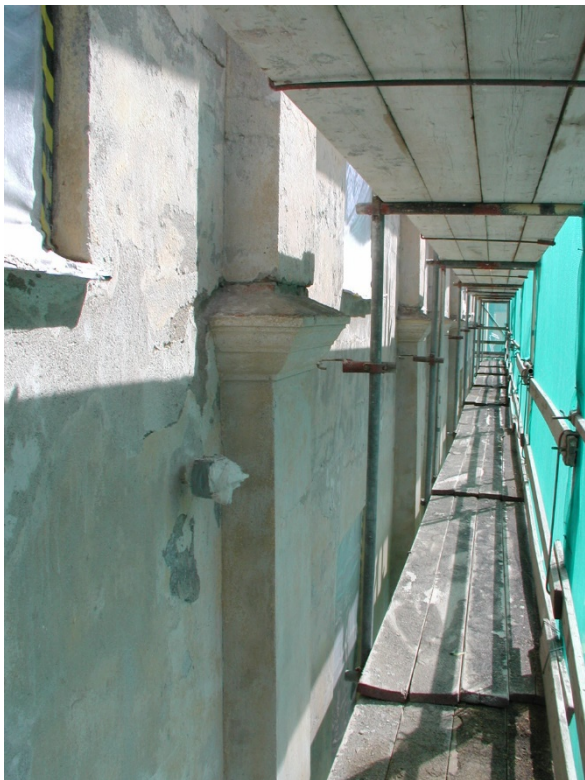
30–35. I putsen på fasaden återfanns ett antal metallplattor som troligen haft en stabiliserande effekt. Samtliga pilastrar hade ett grövre bruk på oöansidan.
