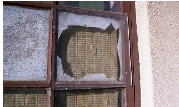
10–14. I flera fönsterbågar var det äldre glaset ersatt med olika material så som floatglas, plexiglas, masonit eller ventilationsanordningar. Fönsterbågar före renoveringen.
