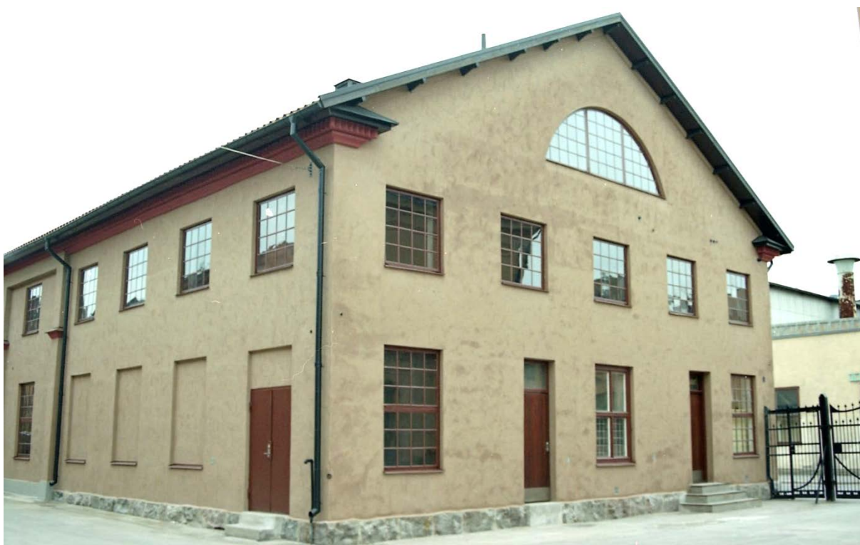
62–64. Den dekorativa takfotslisten infärgades i en röd kulör som tagits fram från den äldre färgsättningen. För att undvika att den röda färgen skulle färga av på fasaden användes en silikatfärg istället för kalkfärg. Tyvärr påverkade detta även den röda kulören som upplevs mer orange än röd.
