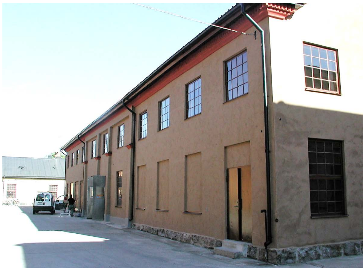
60-61. Fasad mot norr och mot öster efter fasad- och fönsterrenoveringen. På översta bilden pågår renoveringen av garagedörrarna.
