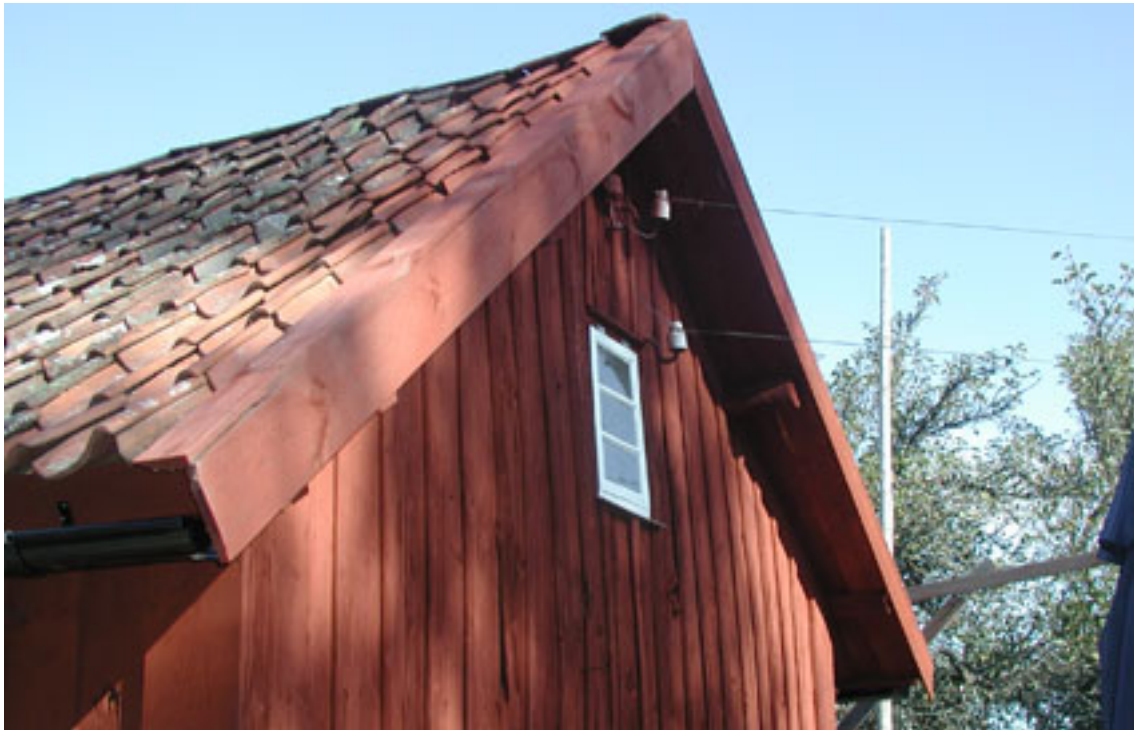
På gavel mot söder finns de gamla elledningarna kvar.
