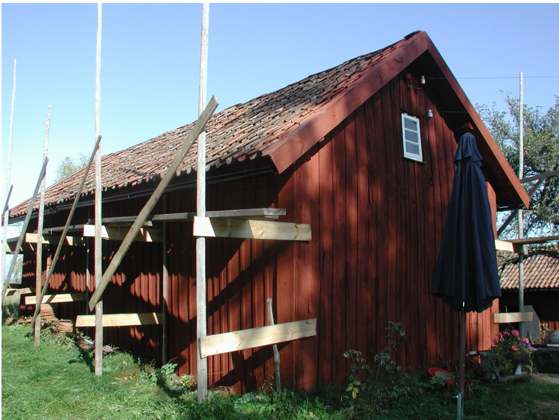
Byggnaden mot väster med det omlagda taket och nya hänggrännor.
