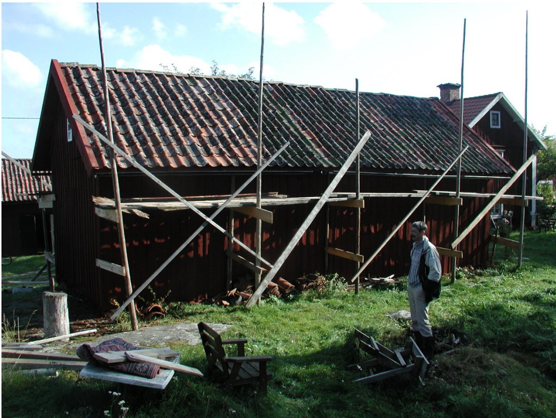
Nytt återanvänt tegel har lagts på det västra takfallet.
