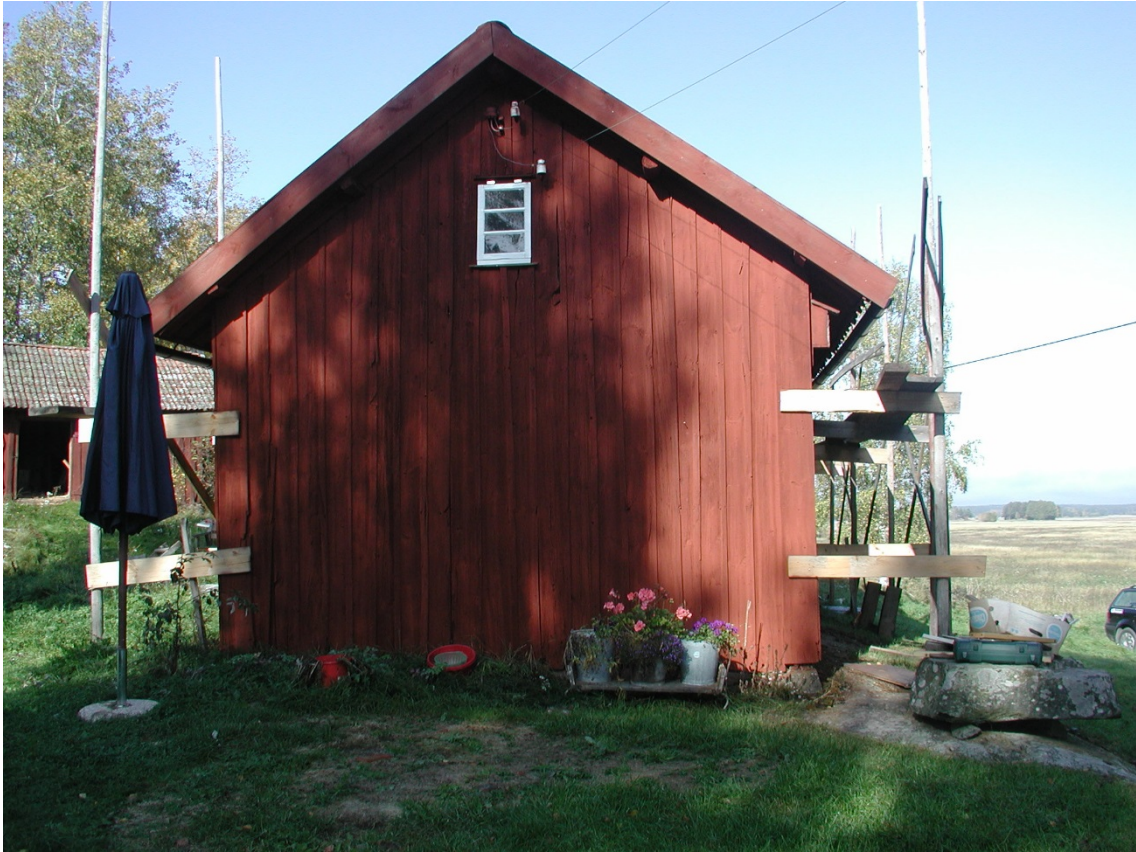
Gavel mot söder med nymålade vindskivor och panel.
