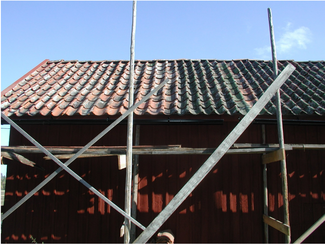
Äldre taktegel har använts vid omläggningen.
