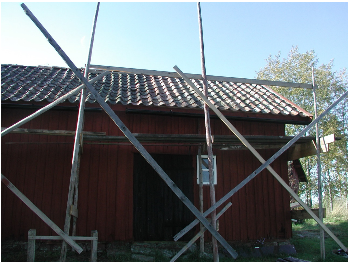
Nytt återanvänt tegel har även lagts på det östra takfallet.
