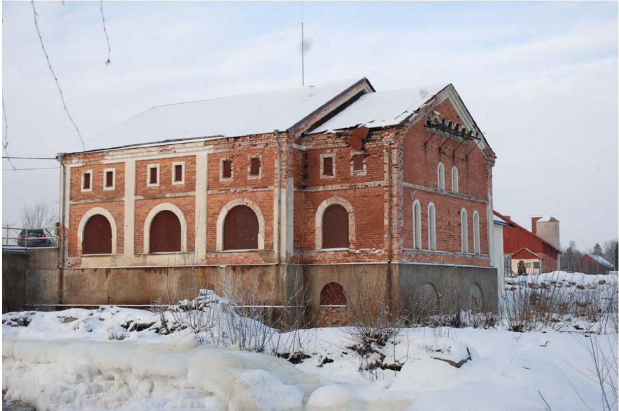
2. Kraftstationens sydöstra fasad innan renoveringen. Kraftiga skador på tegel och puts.
