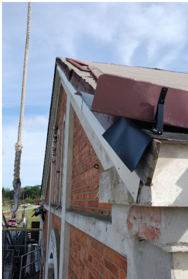
10–15. Ny bandtäckt takplåt ersatt det äldre taket. Fotränna och vindskivor i plåt. Stuprör byttes ut.
