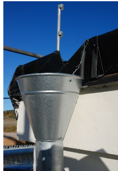
10–15. Ny bandtäckt takplåt ersatt det äldre taket. Fotränna och vindskivor i plåt. Stuprör byttes ut.
