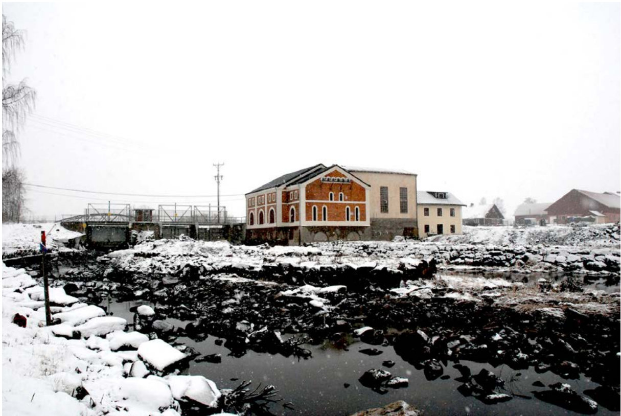
37. Dammområdet åt sydost.
