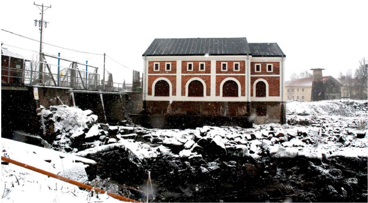
36. Fasad mot söder. T.v. dammluckor och två fåror. I bakgrunden vattentornet.
