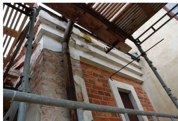
16–18. Stora delar av takfoten var sönderovittrad. Stora partier med puts saknades eller satt löst.
