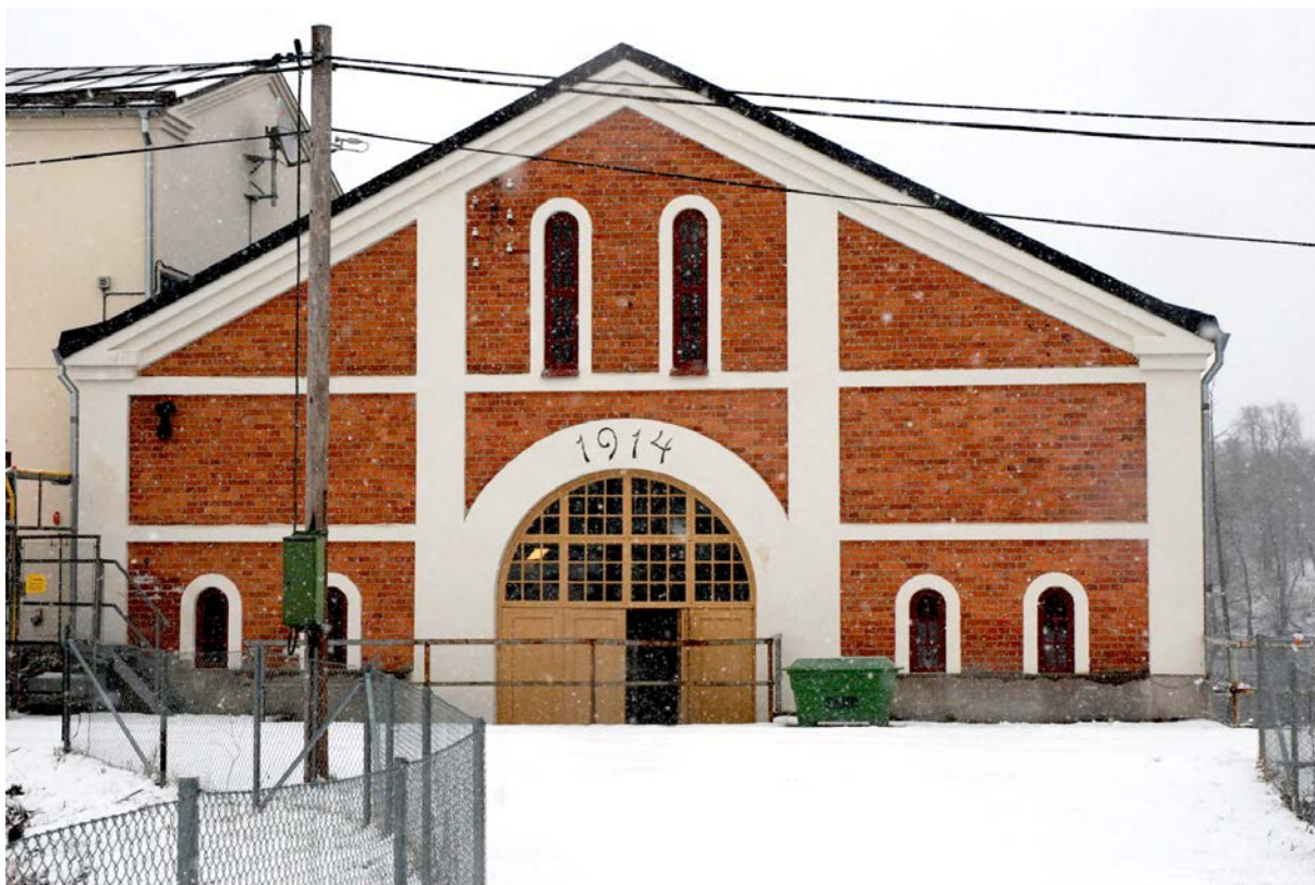
32. Samtliga fönster på kraftstationens västra fasad renoverades. Fönstret över entrén och dörrarna målades med linoljefärg i ljusocker efter läns museets färgsättningsförslag.
