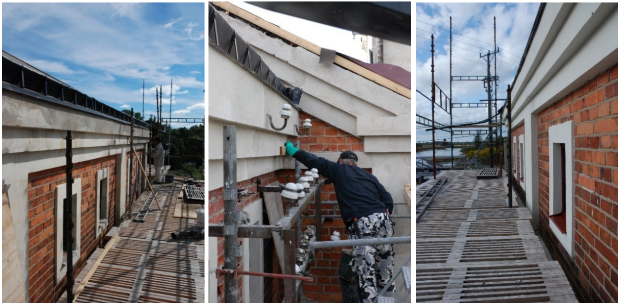
19–25. Äldre frostsprängt tegel har bilats bort och nytt från Bältarbo har murats in på stora delar av fasaden. Putsdetaljer runt fönster och listverk har byggts upp med kalkbruk och därefter avfärgats med kalkfärg.
