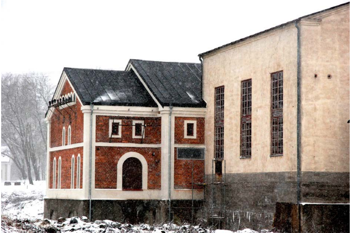
34. Stationens fasad mot norr. Ställverket på södra och östra fasaden bevarades och renoverades. Bandtäckt takplåt lades på båda stationerna. Luckorna i grunden sattes igen.
