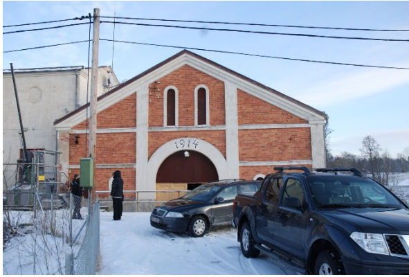
4. Fasad mot väster, det stora fönstret är täckt.
