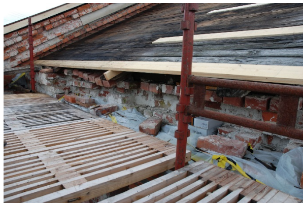
9. Takfoten, kraftigt söndervittrad och saknade fog
