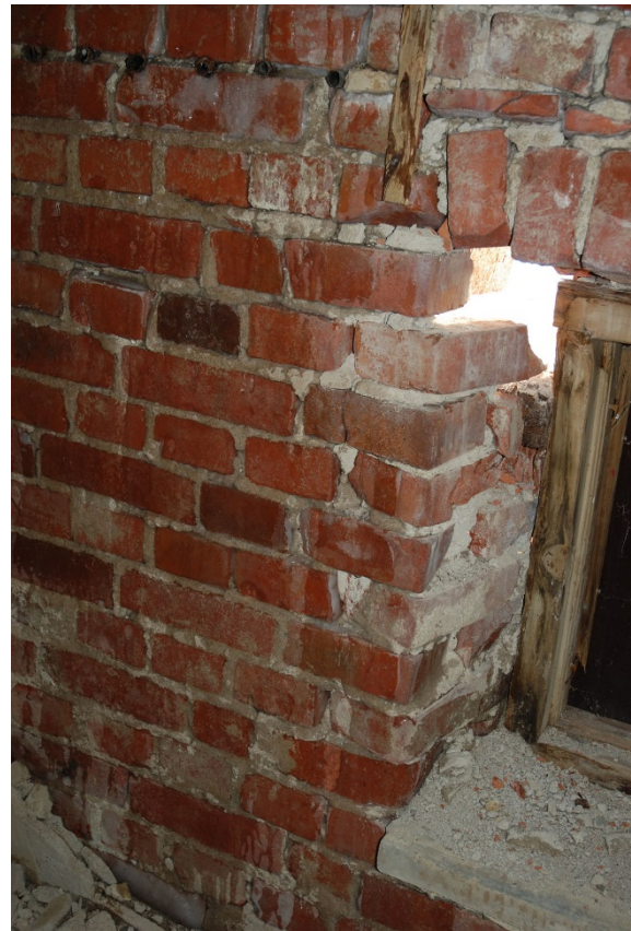
7. Hål vid fönsterovalv.
