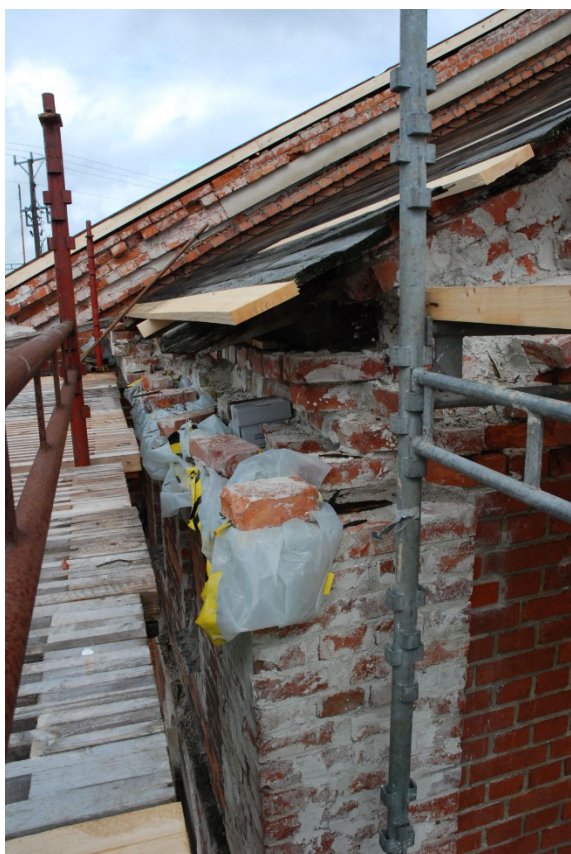
16–18. Stora delar av takfoten var sönderovittrad. Stora partier med puts saknades eller satt löst.
