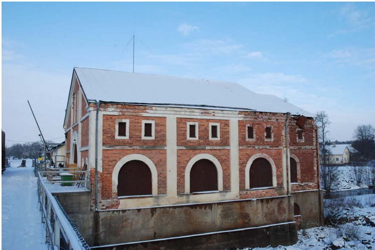
3. Kraftstationens södra fasad, innan renoveringen. Samtliga fönster är igensatta med skiomaterial.
