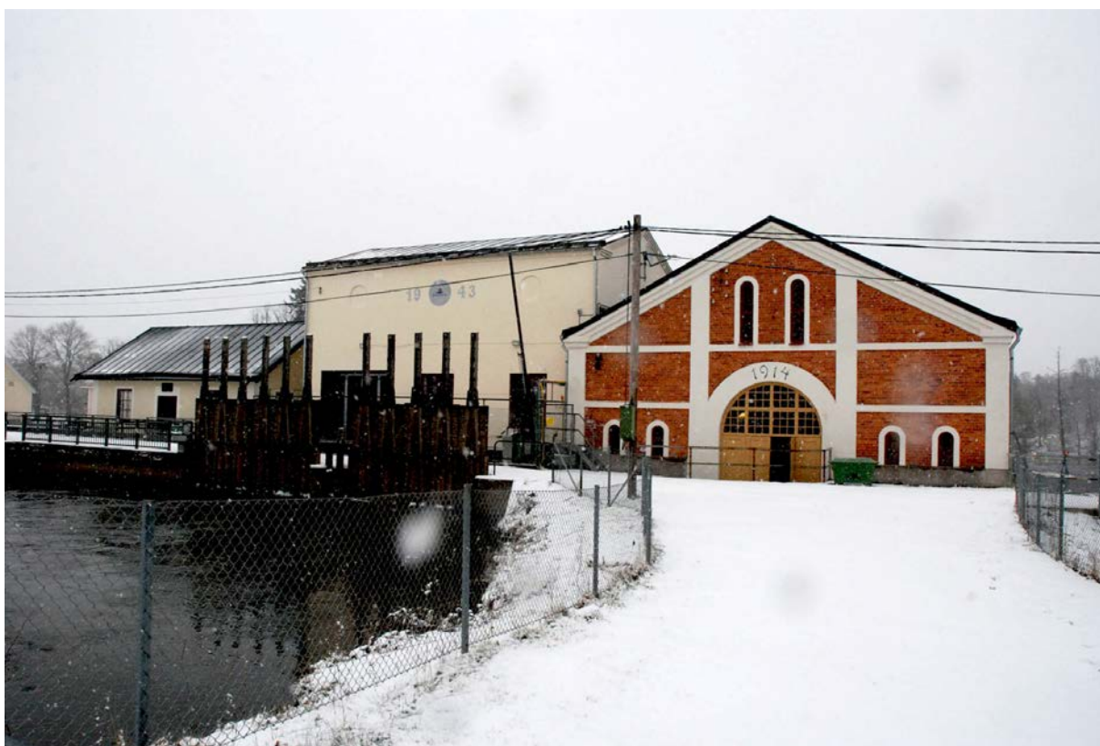
33. Bagarstugan, 1943 års kraftstation med nymålad fasad och emblem samt 1914 års station. T.v. syns delar av dammanläggningen.
