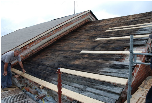
8. Det äldre underlagstaket kompletteras.
