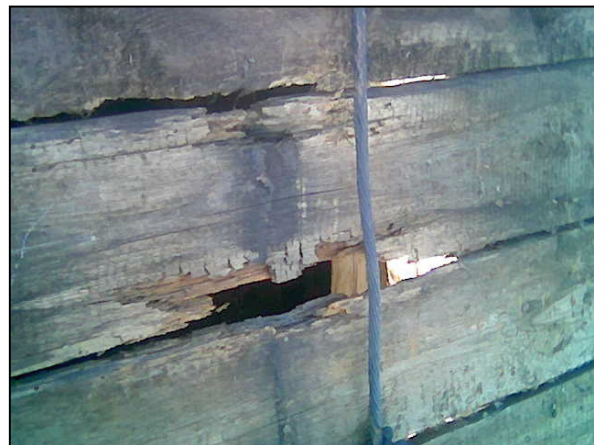
Bild 4. Åskledarfästet har orsakat rötskador.
