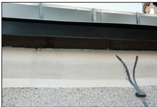
Bild 12. Långhusets takfot med EF plåt.
