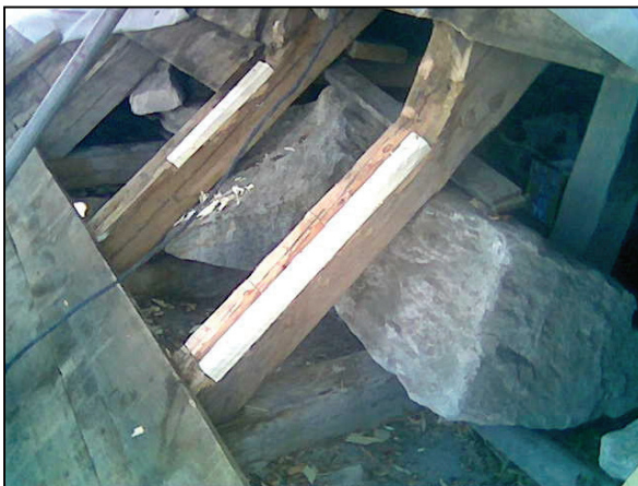
Bild 3. Ilusning av nytt virke i tornets stomme.
