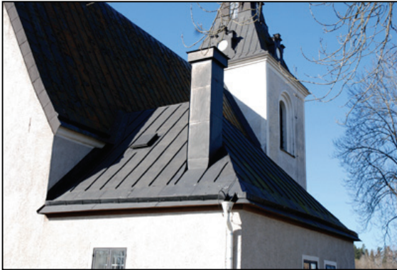
Bild 10. Kyrkan från nordöst innan takomläggningen.
