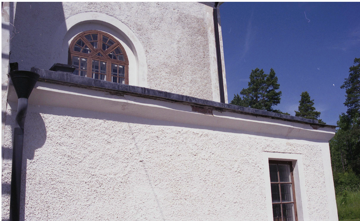
Bild 7: Skador i takfot på sakristian före arbetena.
