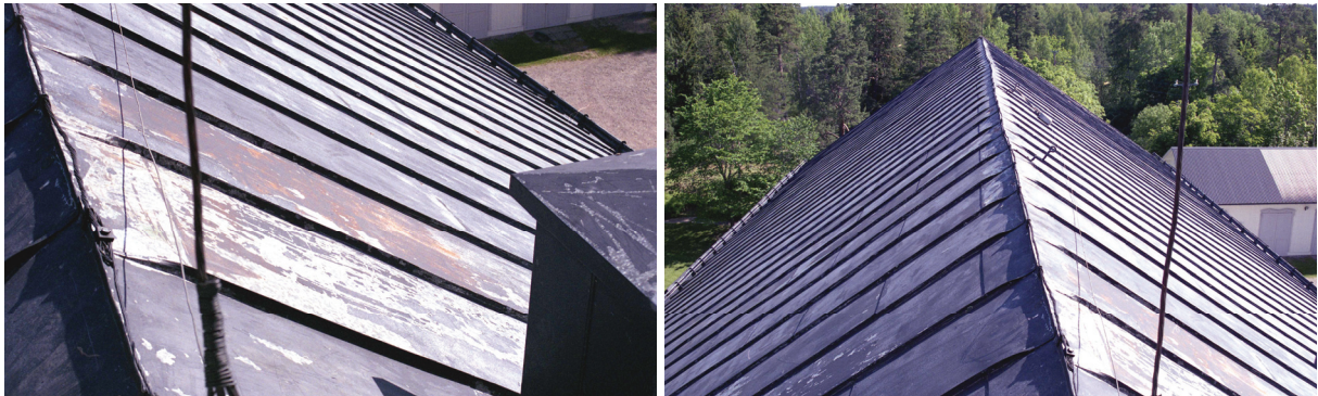
Bild 2 och 3: Plåttaket före åtgärder.
