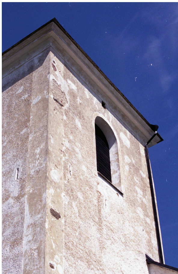
Bild 5: Tornet med flagande stuprör före arbeten.
