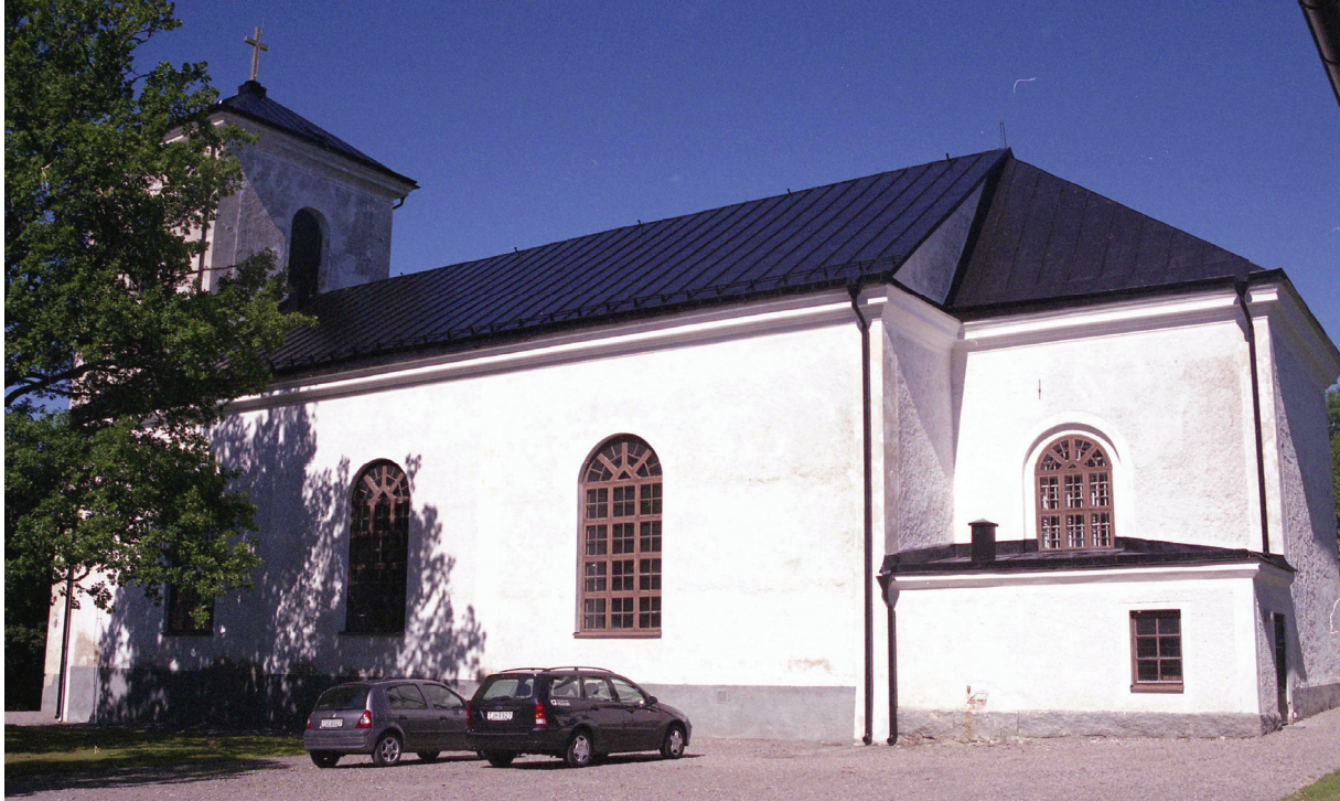
Bild 9: Foto vid slutbesiktning, foto från söder.
