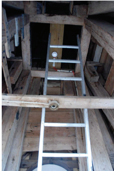
Bild 5: Montering av rökdetektor i tornet.
