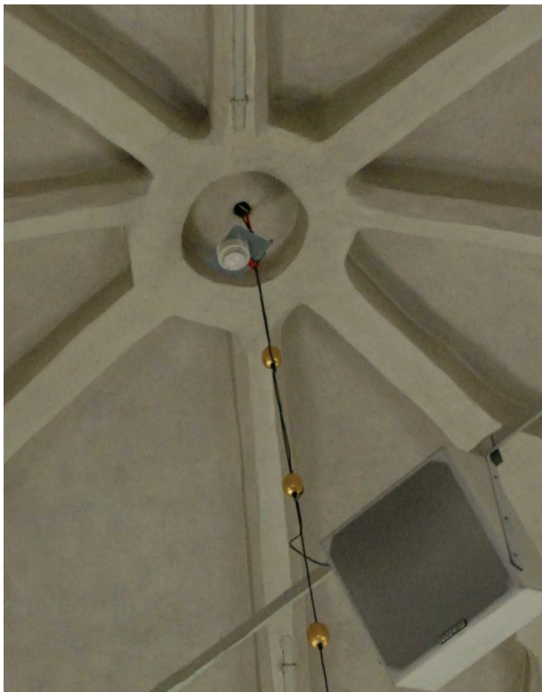
Bild 7: Monterat larm i koret, sladd och montageplåt ej inmålad.
