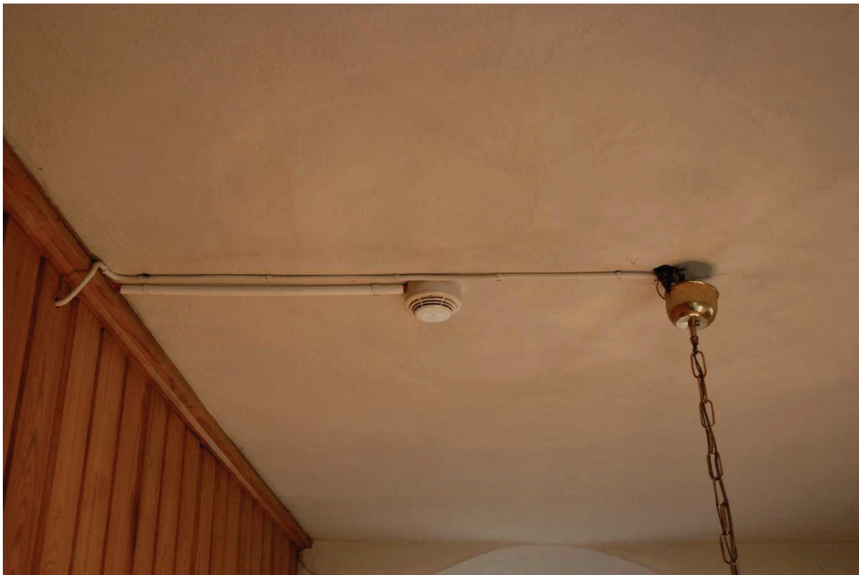
Bild 2: Rökdetektor i vapenhuset.
