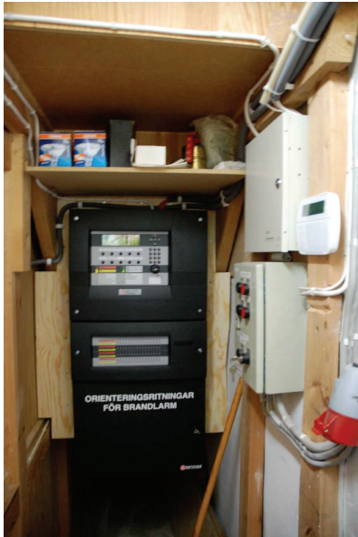
Bild 4: Centraler i skrubben under trappan i vapenhuset.
