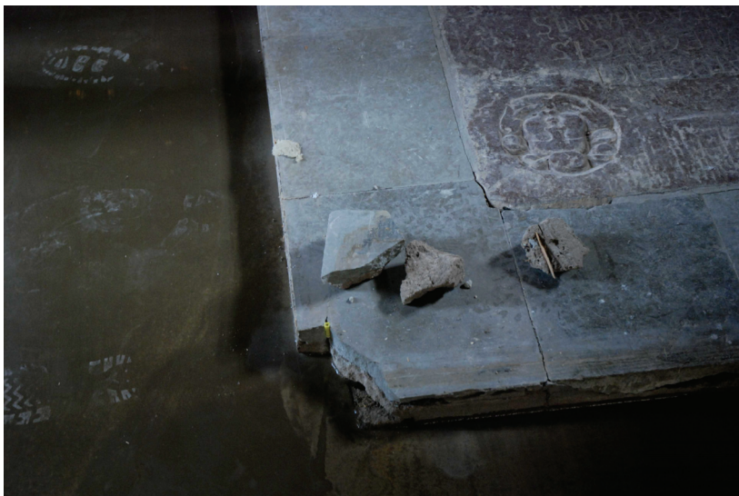
Bild 6: Gammal skada i kantsten kring gravhäll. stenen.
