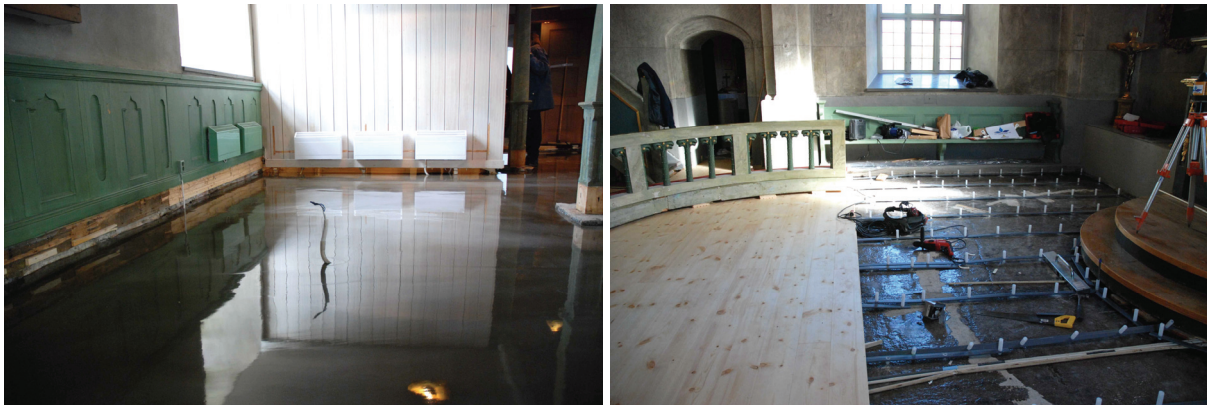
Bild 2: Genomförd behandling med DexorBond Bild 3: Montering av nivellreglar i koret
