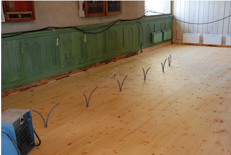
Bild 4: Håltagning i golv till bänkvärme
