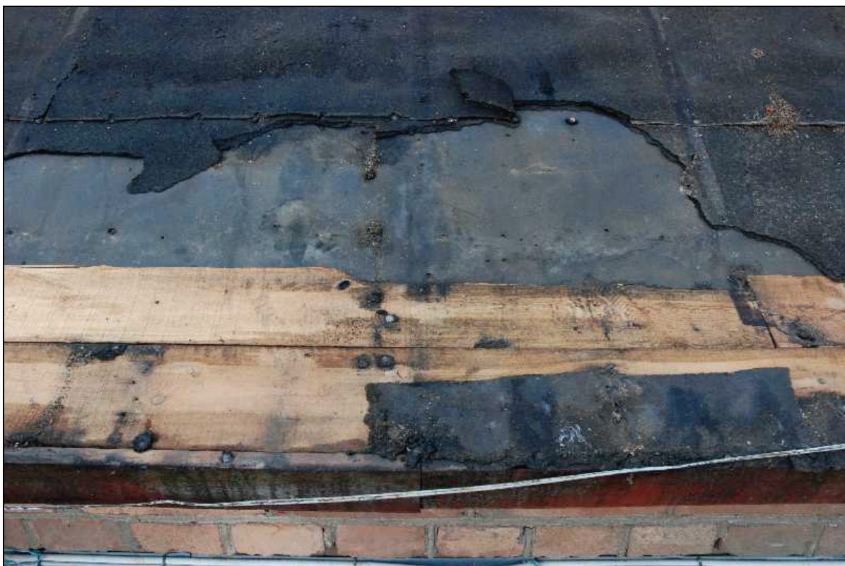
Bilden visar olika lager av takpapp samt tillägget vid takfoten. Foto: Tobias Mårud, VLM.
