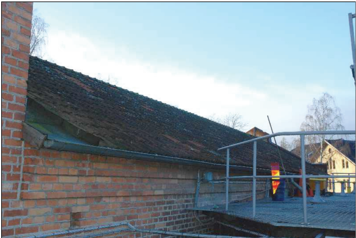
Det bakre norra takfallet innan restaurering. Foto: Tobias Mårud, VLM.
