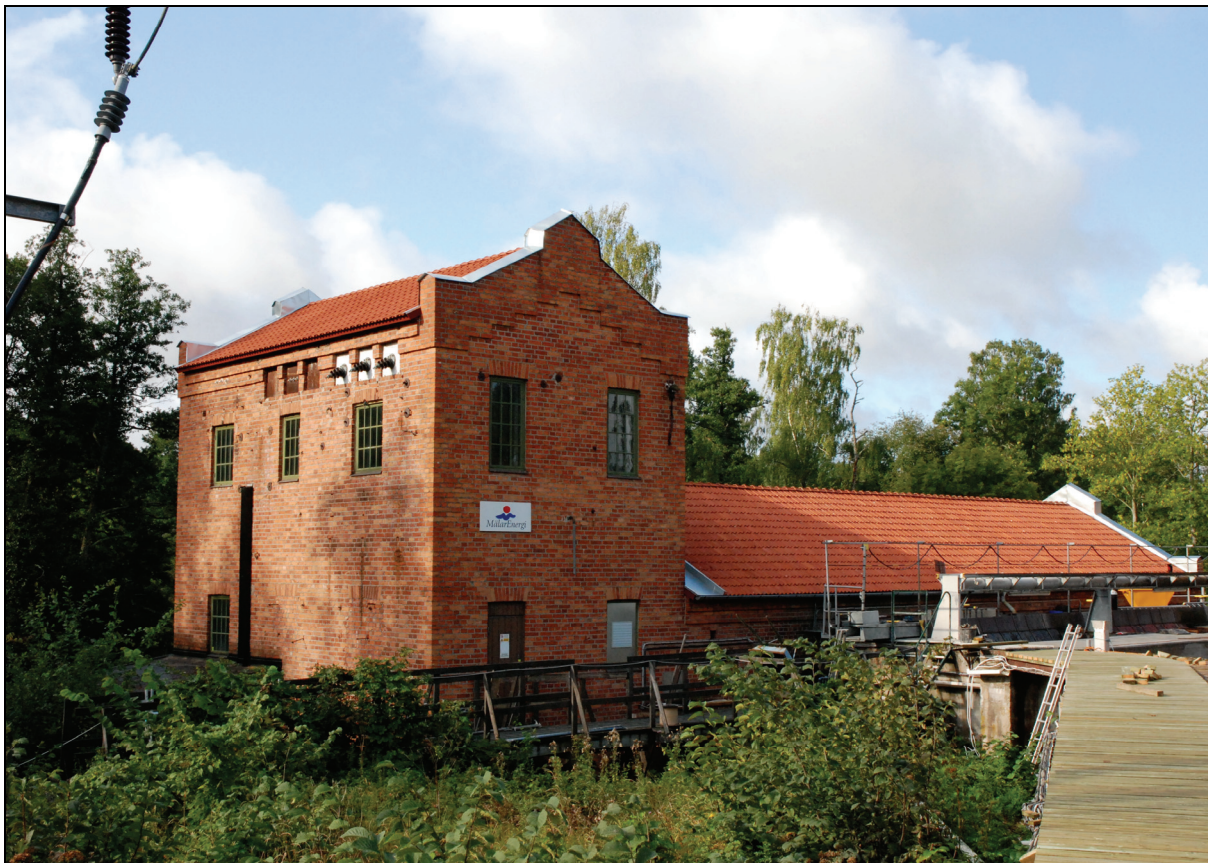
Västerkvarns kraftstation efter restaurering. Foto: Tobias Mårud, VLM.
