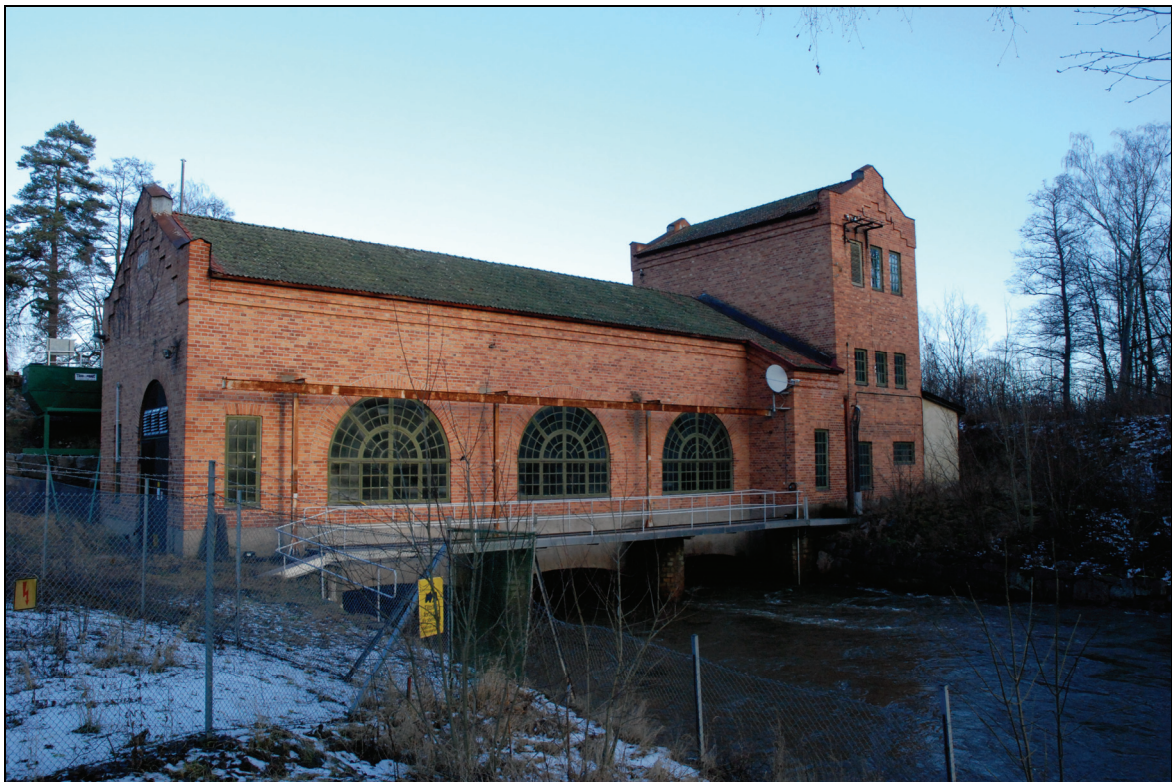
Västerkvarns kraftstation innan takrestaurering. Foto: Tobias Mårud, VLM.
