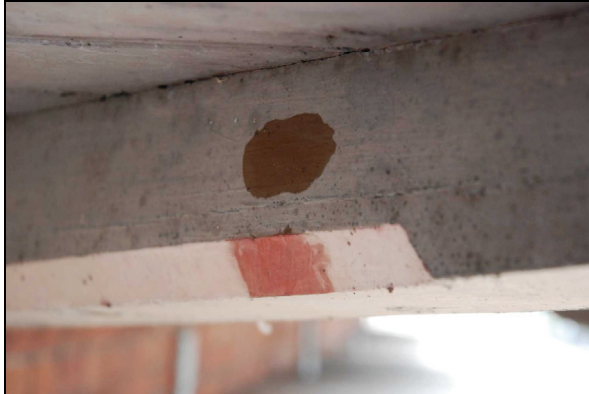
Bild 11 & 12. Takfoten var smutsig och färgen hade kritat sig så pass att det var svårt att se någon skillnad på takfotens färg och accentueringens (vänster bild). Bilden till höger är tagen efter slutfört arbete.
