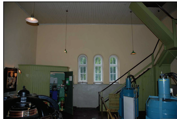
Bild 13 & 14. Omfattande skrapning och putslagning fick utföras på de övre väggpartierna (vänster bild). Bilden till höger är tagen efter slutfört arbete.
