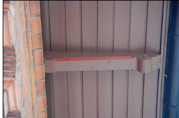
Bild 11 & 12. Takfoten var smutsig och färgen hade kritat sig så pass att det var svårt att se någon skillnad på takfotens färg och accentueringens (vänster bild). Bilden till höger är tagen efter slutfört arbete.
