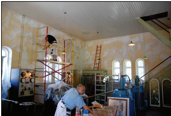
Bild 13 & 14. Omfattande skrapning och putslagning fick utföras på de övre väggpartierna (vänster bild). Bilden till höger är tagen efter slutfört arbete.
