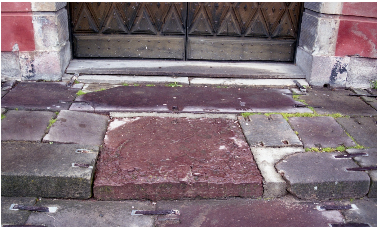
Trappan innan åtgärderna.
