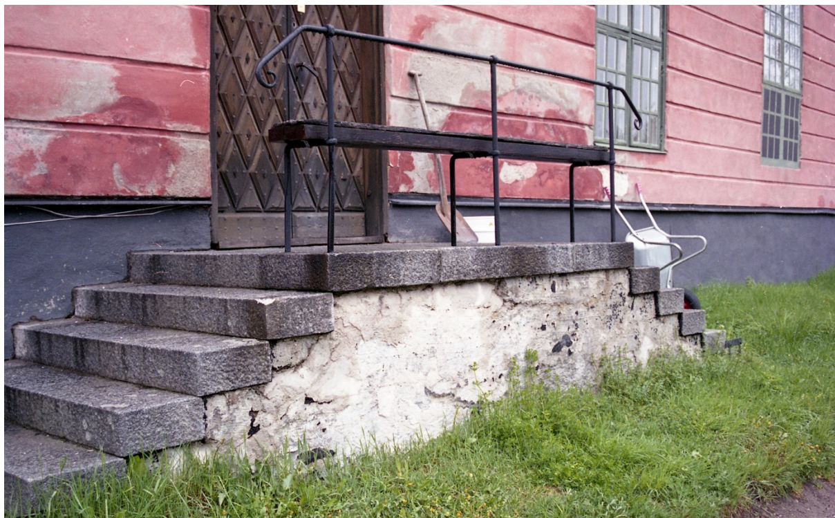
Trappan på slottets östra sida innan åtgärderna. Putsen på trappans front vittrade och det asfaltliknande materialet skymtar under putsen.
