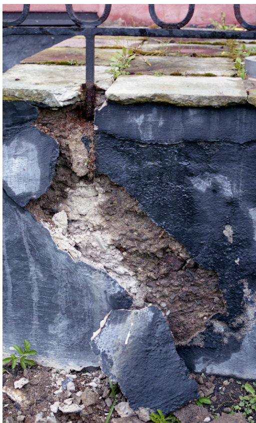
Detaljbild på den vittrande fronten och trappräckets infästning i terrassen. Räckets nedre del är kraftigt rostangripet vilket är ett resultat av den fuktiga miljön.
