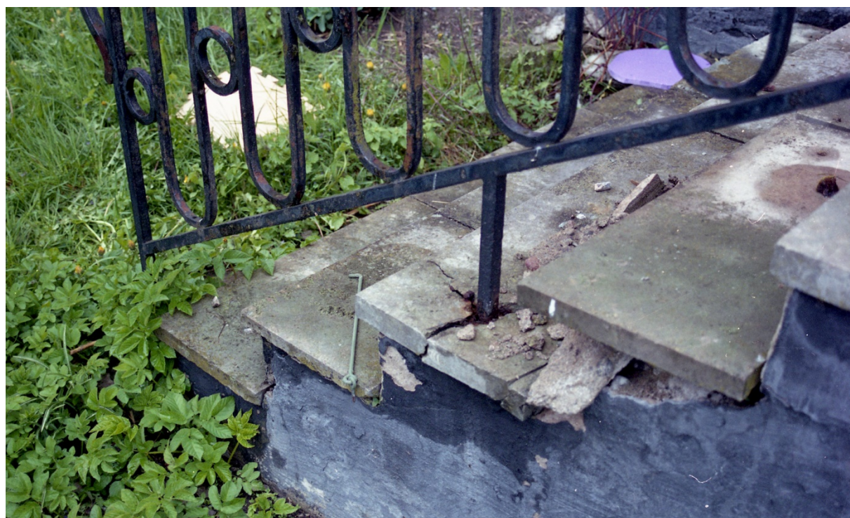
Frostsprängning mellan kalkstenen och trappräcket.
