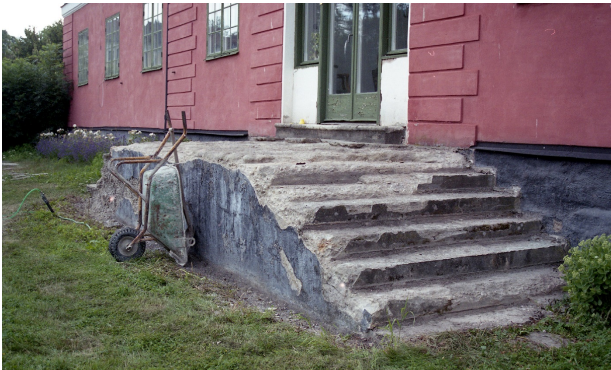
Efter att trappträcket, kalkstenarna och sättsanden tagits bort.
