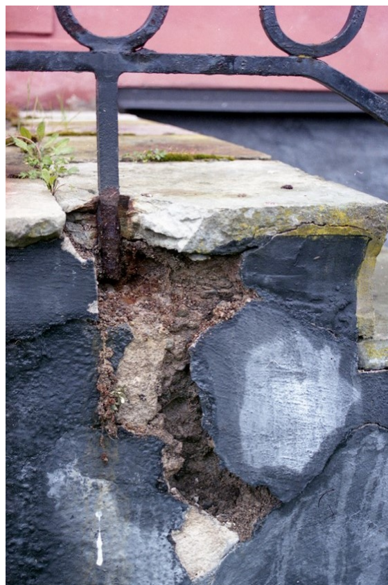
Detaljbild på den vittrande fronten och trappräckets infästning i terrassen. Räckets nedre del är kraftigt rostangripet vilket är ett resultat av den fuktiga miljön.
