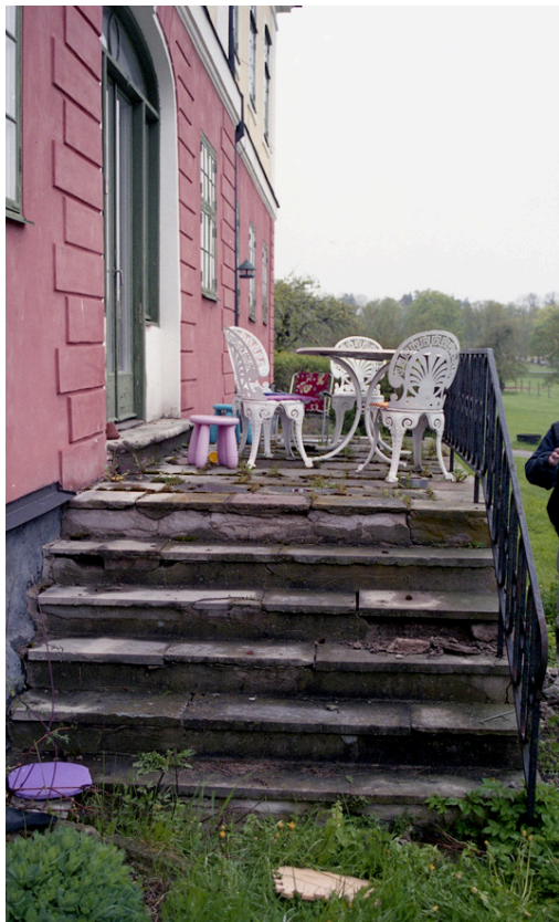
Trappstegen åt söder, innan restaureringen.
