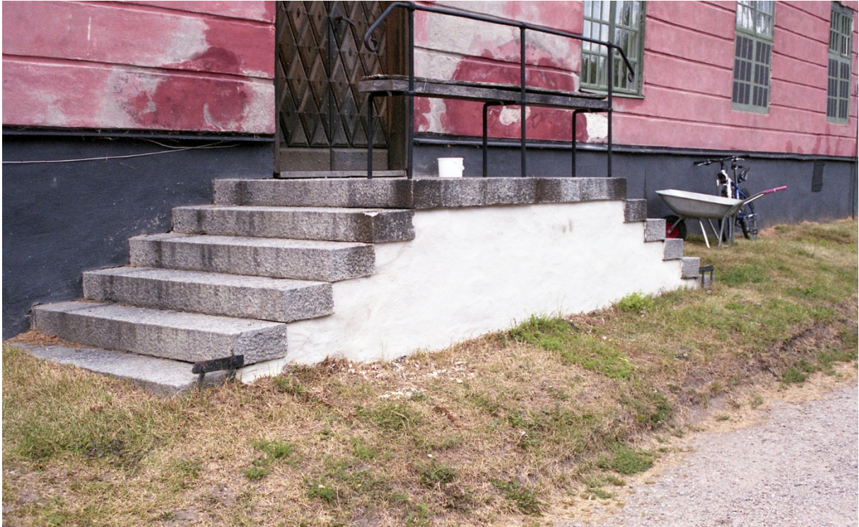
Slottets östra trapp med ny puts.
