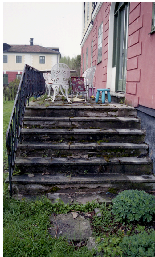
Trappstegen åt norr, innan restaureringen.
