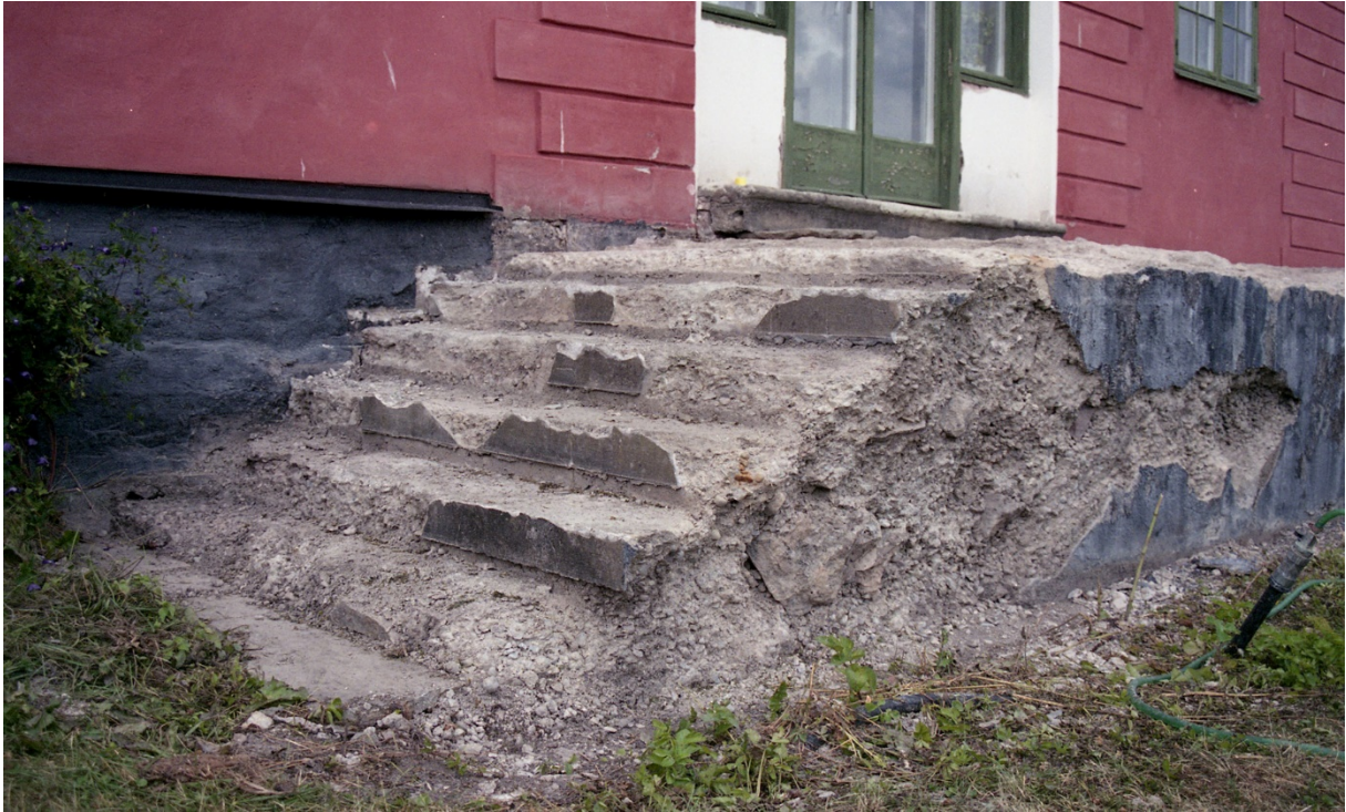
Det asfaltliknande materialet och cementbruket avlägsnades så mycket som var möjligt.
