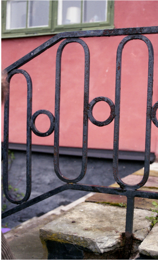
Trappräcket med rostangrepp.
