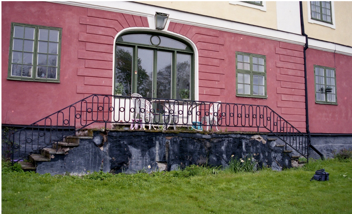
Trappa och terrass på östra slottsflygeln innan restaureringsarbetet påbörjats.
