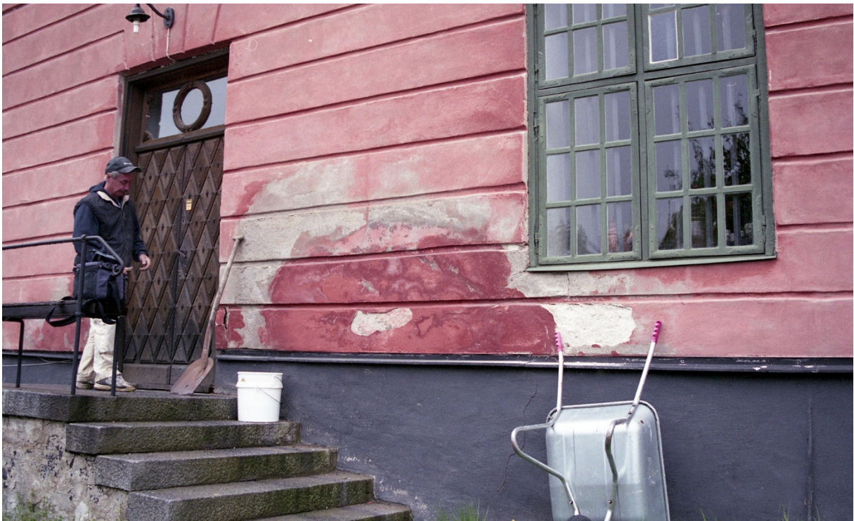
Delar av putsen på östra fasaden lagades.
