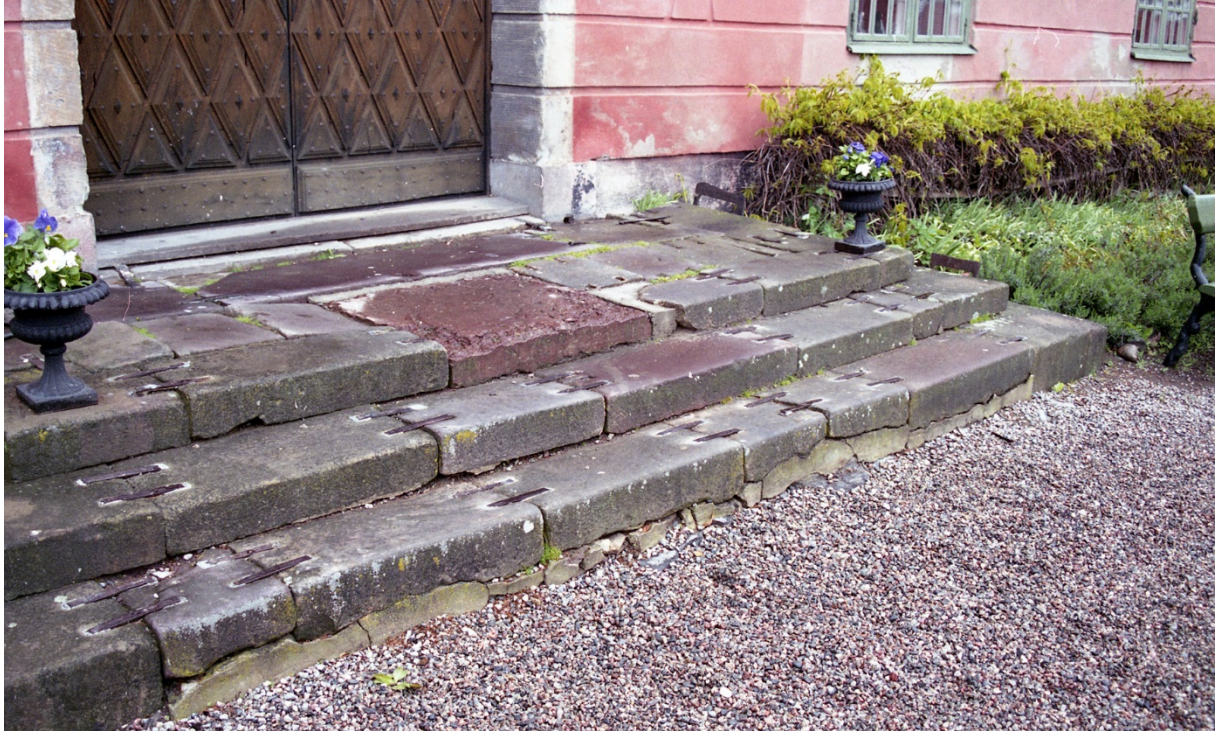
Trappstegen vid slottets huvudentré låg löst och ojämnt.
