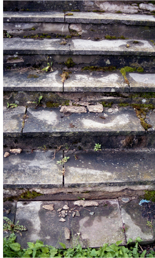
Sättstegen är delvis bestrukna med det asfaltliknande materialet och vittrar kraftigt.
