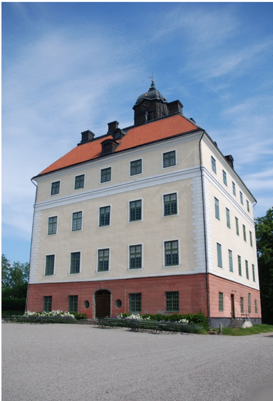
Ängsö slott våren 2009, vid östra trappan skyntas den nya putsen på fasad och trappans front.
