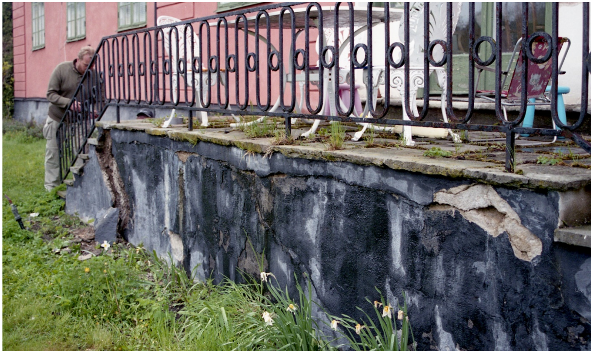
Terrassens front vittrade kraftigt. Fronten, bestående av cementbruk, var struket med ett asfaltliknande material i tjocka lager. Detta förekommer på grunden runt hela slottsflygeln.
