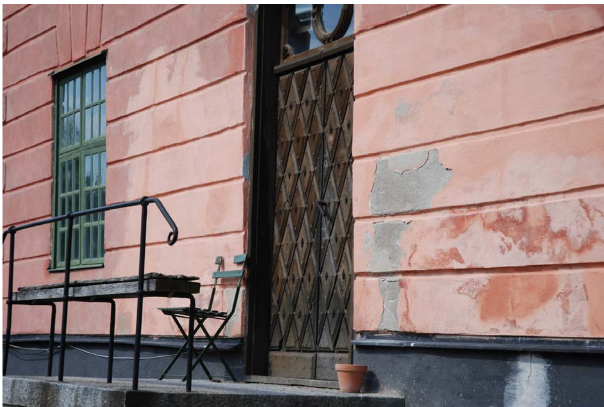
Den nya putsen på fasaden fick en för ljus infärgning. Vid besök våren 2009 hade delar av putsen lossnat.
