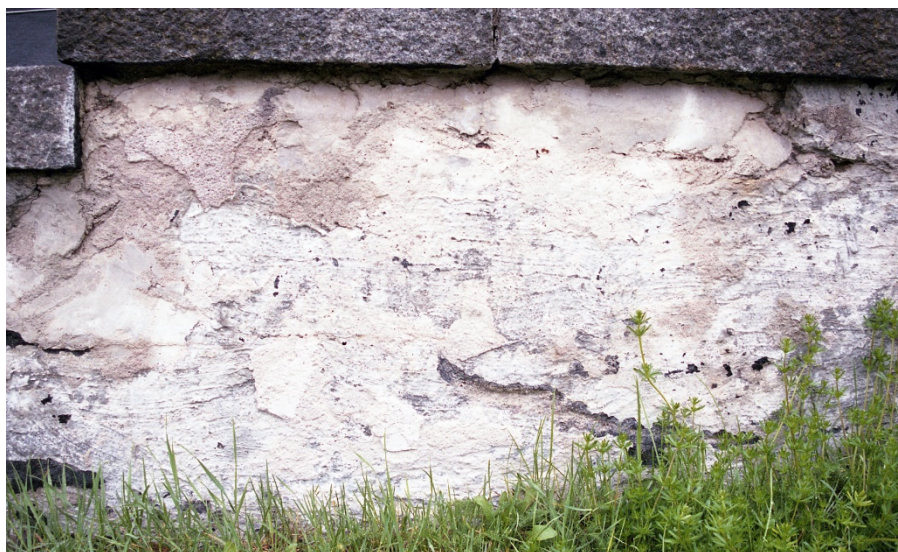
Detalj av trappan innan åtgärderna.
