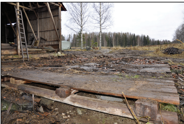
Golvet lämnades som klimatskydd för golvbjälklaget.
