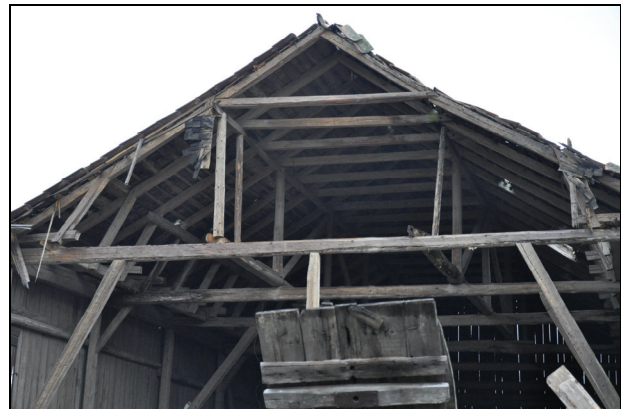
Den oskyddade takstolen var i dåligt skick.
