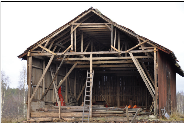
Takstolen säkrades med tvärställda ribbor och följare.
