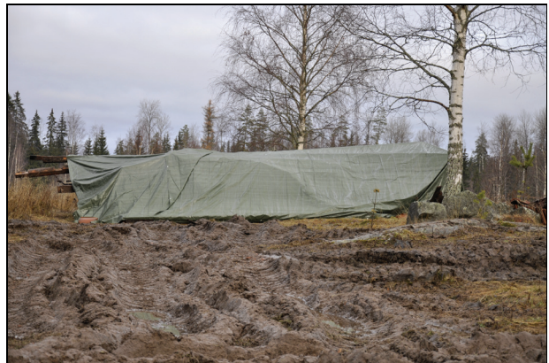
När arbetet avslutats täcktes det ihopsamlade materialet med en presenning.
