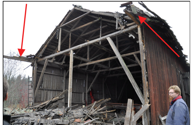
Utstickande delar av hammarband sågades av och några tegelpannor togs ned.
