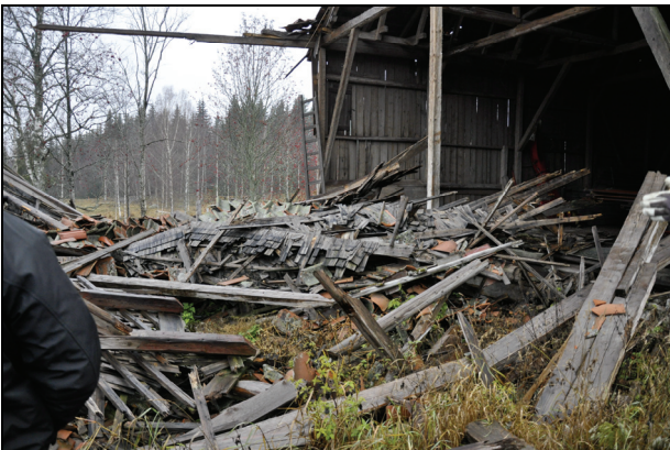
Den ihoprasade byggnadsdelen.
