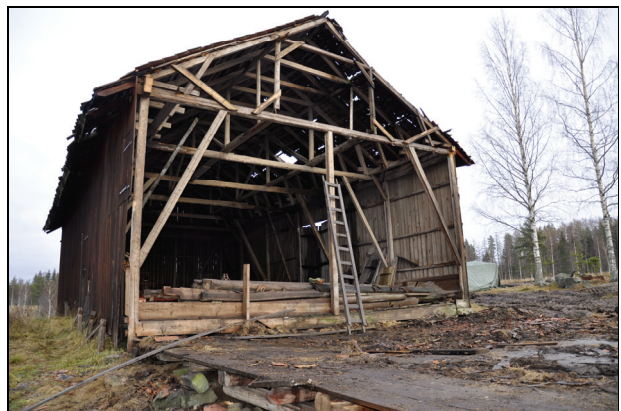
Byggnaden efter röjning och säkring.
