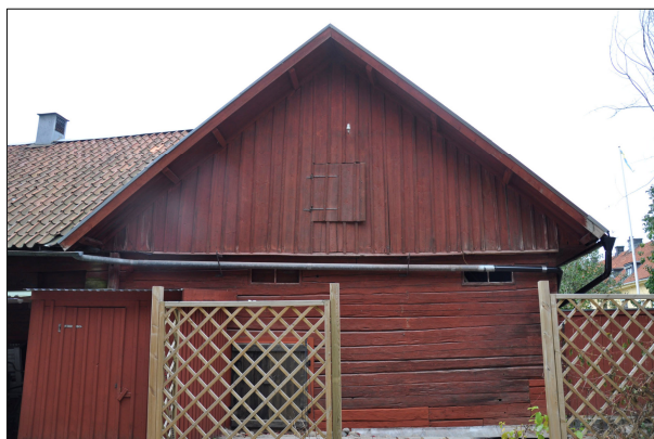
Vattnet från den norra fasaden leds genom byggnaden och ut på den södra gården.
