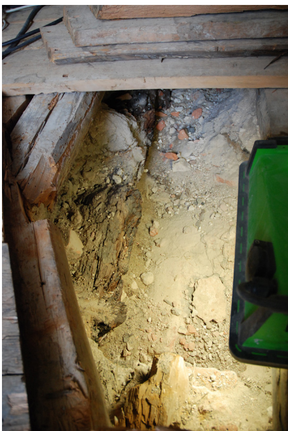
15-18. Även bjälkar var angripna av hussvamp. Vissa träpartier hade äldre insektsangrepp. Vid friläggandet kunde även, på vissa håll, lagt tegel skönjas.
