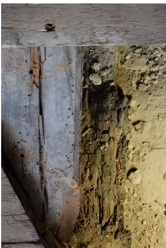
15-18. Även bjälkar var angripna av hussvamp. Vissa träpartier hade äldre insektsangrepp. Vid friläggandet kunde även, på vissa håll, lagt tegel skönjas.
