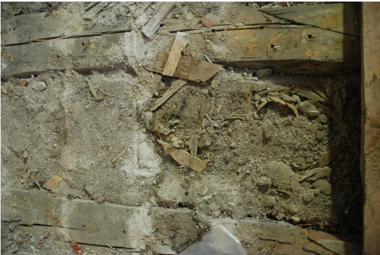
12-14. Mot rummets västra vägg var timret angripet av hussvamp. Delar av mycelet var synlig då undergolvet lyftes. Fyllnadsmassorna och det angripna träet destruerades.
