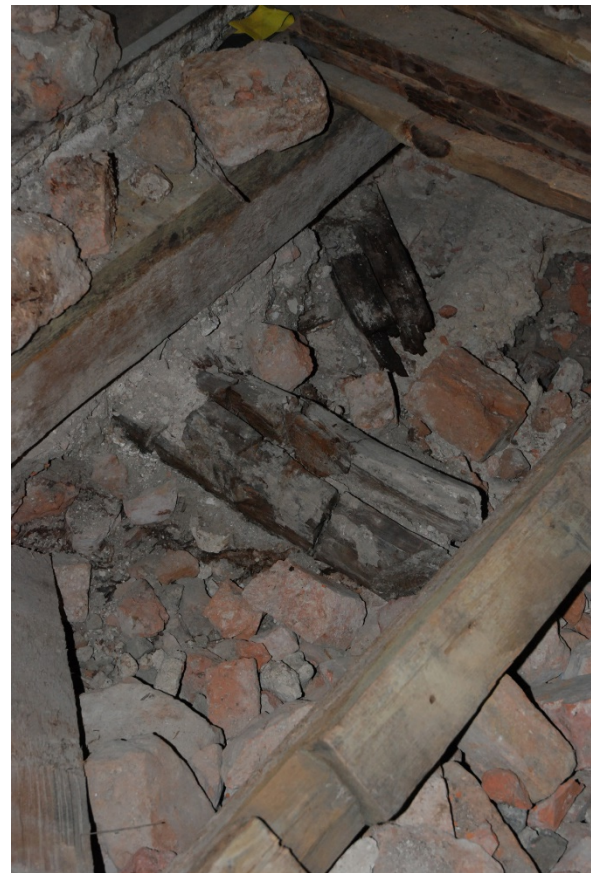
28-31. Över t.v. delar av värmekanaler från den öppna spisen. Stenfrisen hade sjunkit mot öster. Mycel var synligt på tegelstenar. Svampangripet material destruerades.
