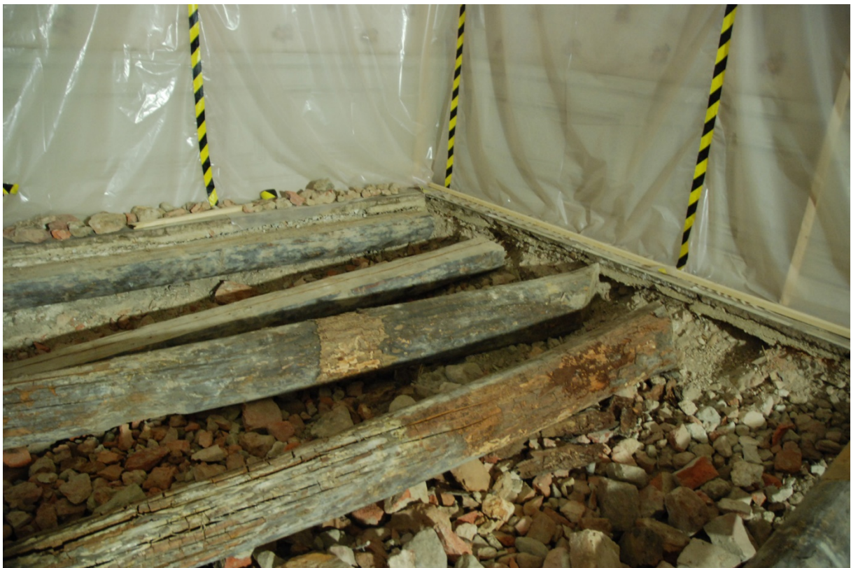
25-27. Svampangreppet var i stort koncentrerat till rummets sydvästra del. Där har det tidigare förekommit en vattenskada.
