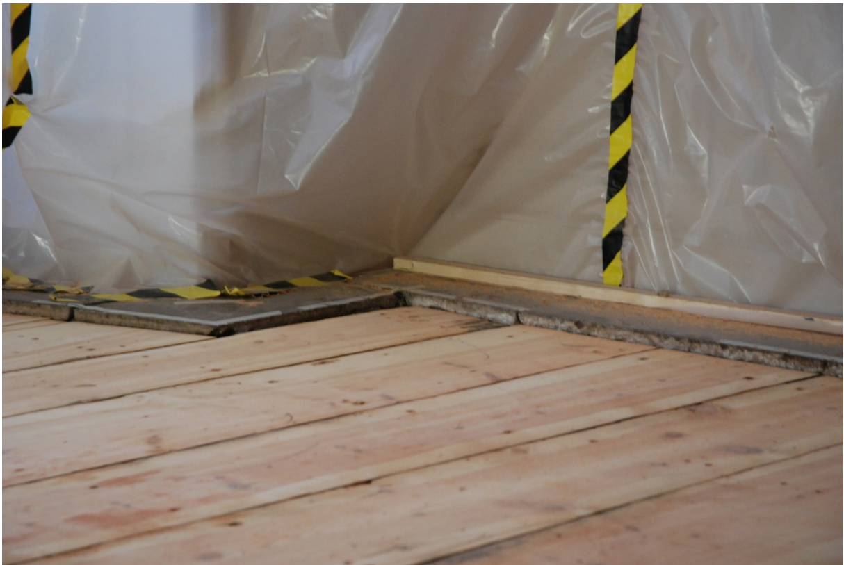
44. Stenfrisen och undergolv innan parkettaavlorna återlagts.
