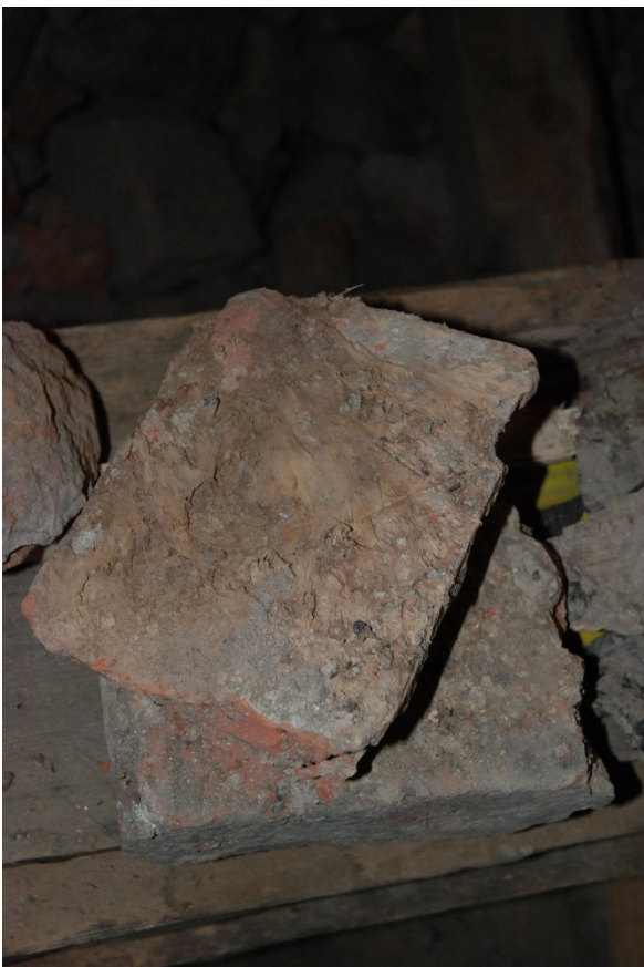
28-31. Över t.v. delar av värmekanaler från den öppna spisen. Stenfrisen hade sjunkit mot öster. Mycel var synligt på tegelstenar. Svampangripet material destruerades.
