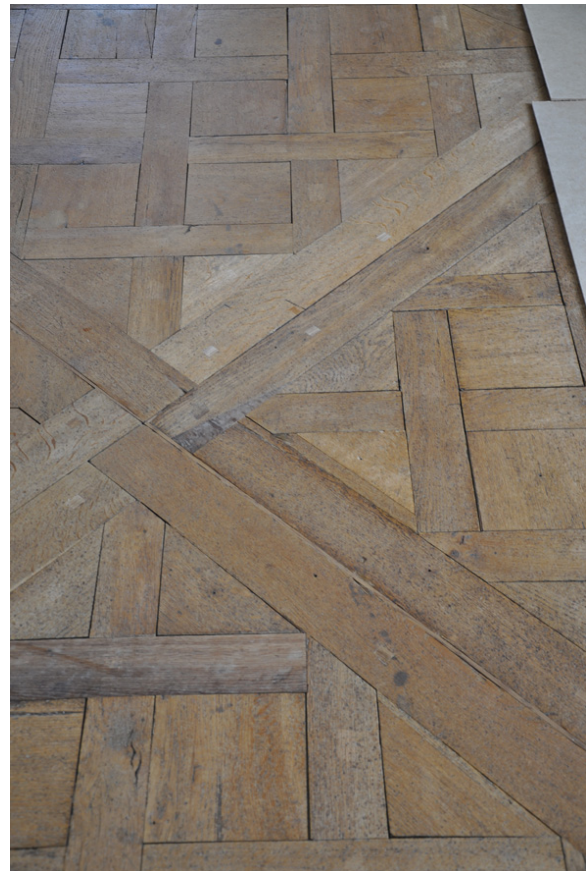
48–49. Ekpluggarna innan de retuscherats in. Så mycket som möjligt av det äldre parketten har bevarats. T.v. syns några mindre ilagningar, där man använt användbara delar av äldre kasserat trä.
