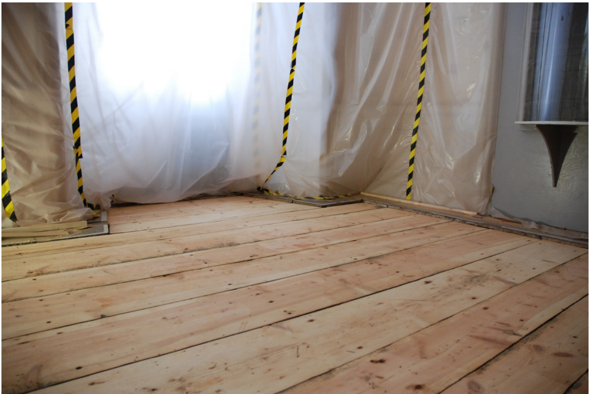
42. Stenfrisen mot sydost. Frisen t.v. har justerats då den sjunkit med ca 5 cm.
