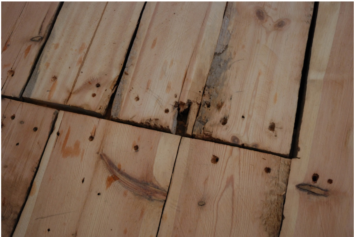
39-40. Audiensrummet mot söder. Hål efter tidigare fästning av undergolvet och parkettavlor.
