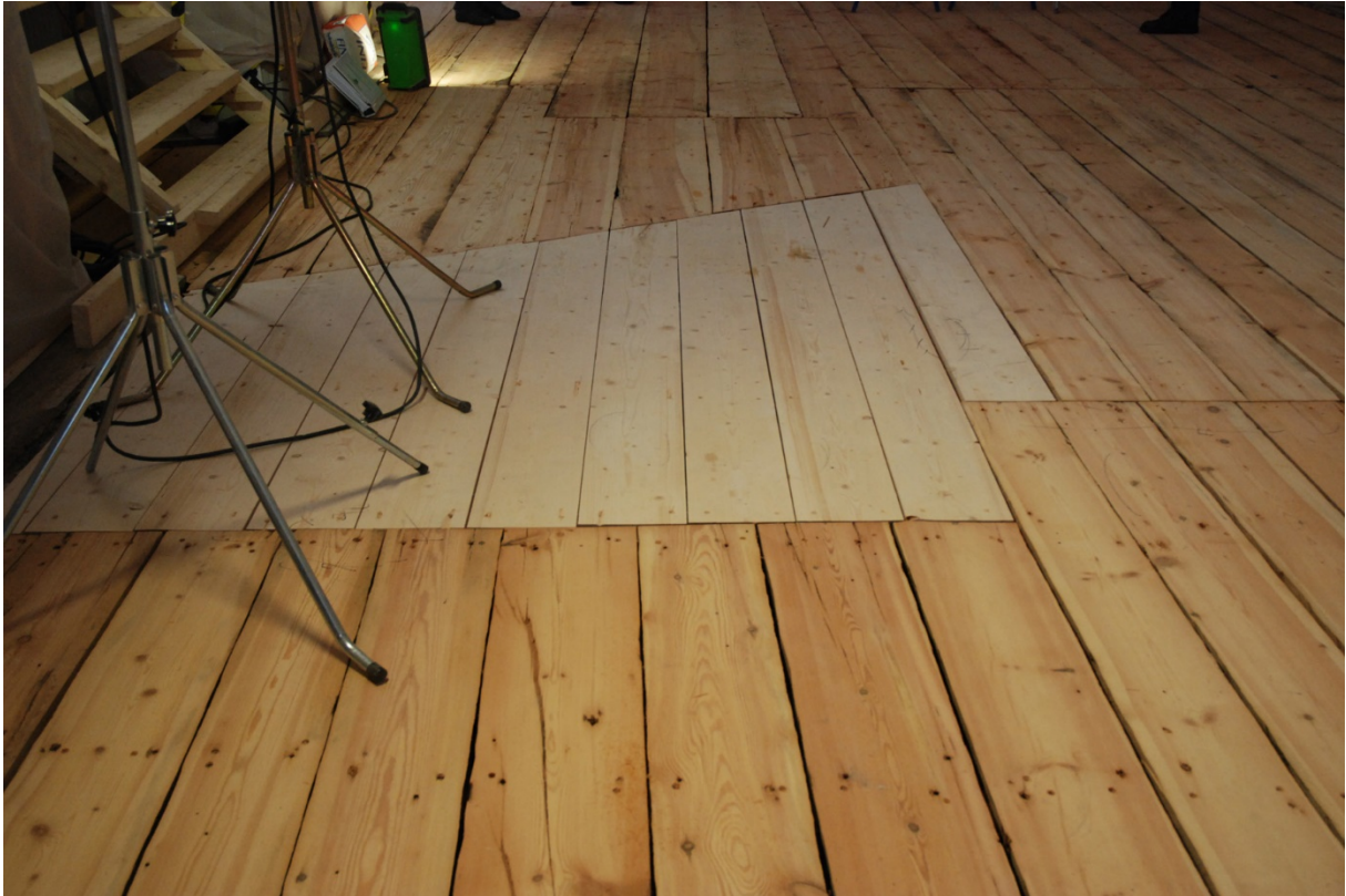
41. En mindre del av undergolvetts plankt fick bytas ut då det var för dåligt att läggas tillbaka.
