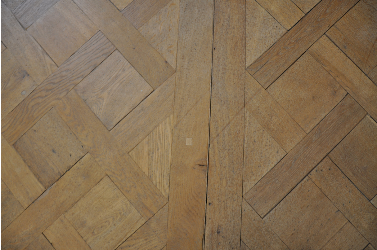
47. Tavlorna har spikats med klippspik alt. skruvats. Hålen har pluggats med en fyrkantig ekplugg.
