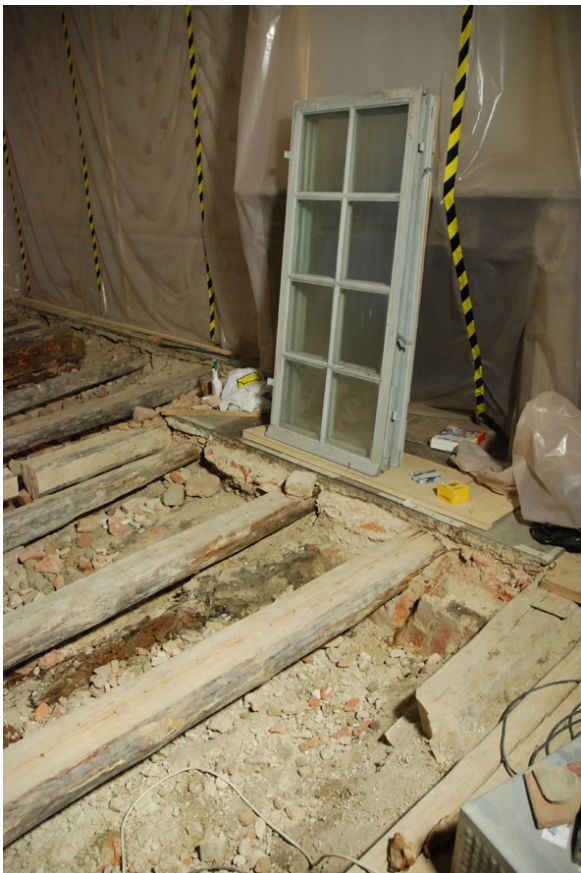
22-24. Fyllning av grov tegelkross. De bruna träesterna är äldre svampangripna bjälkar.
