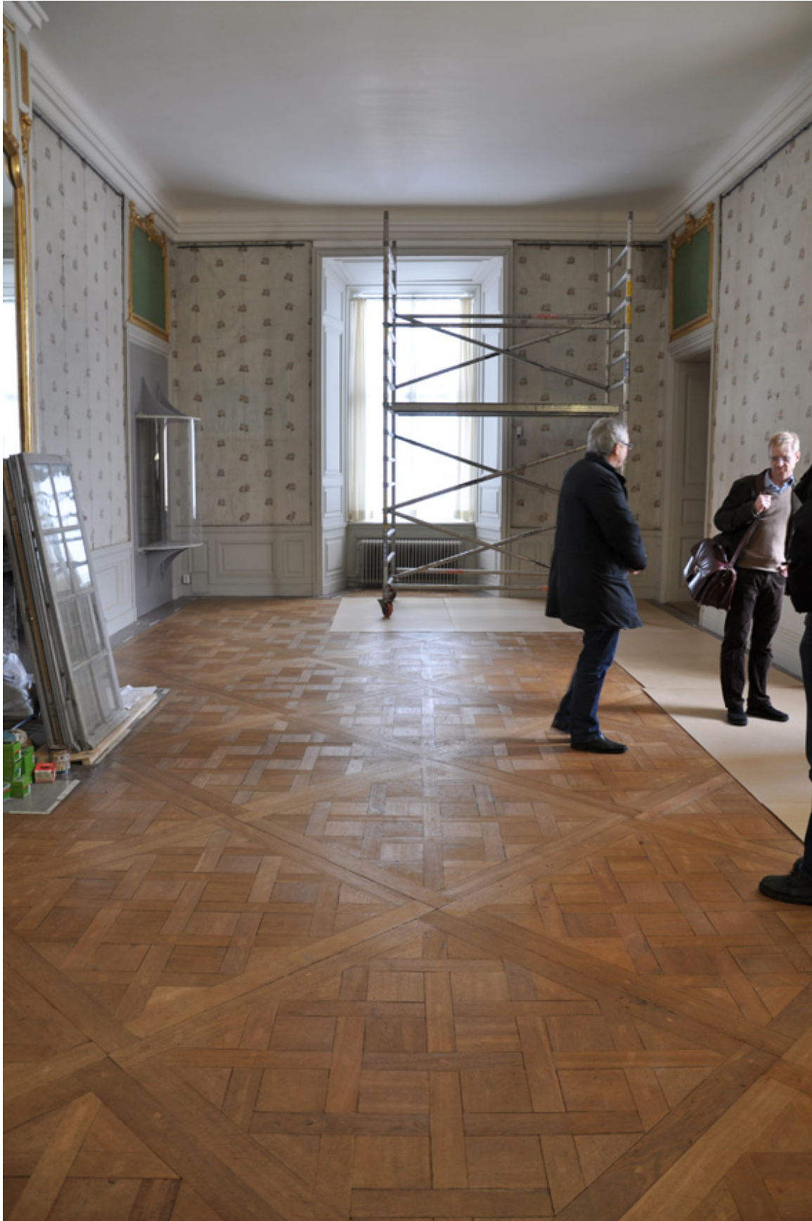
45. Det nyrenoverade parkettgolvet återlagt. Golvet är ännu ej behandlat.
