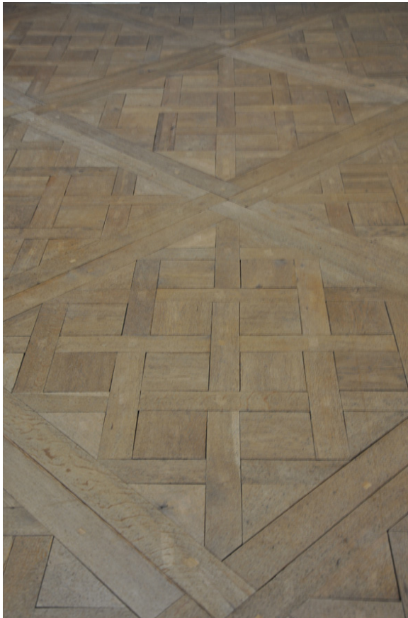
48–49. Ekpluggarna innan de retuscherats in. Så mycket som möjligt av det äldre parketten har bevarats. T.v. syns några mindre ilagningar, där man använt användbara delar av äldre kasserat trä.
