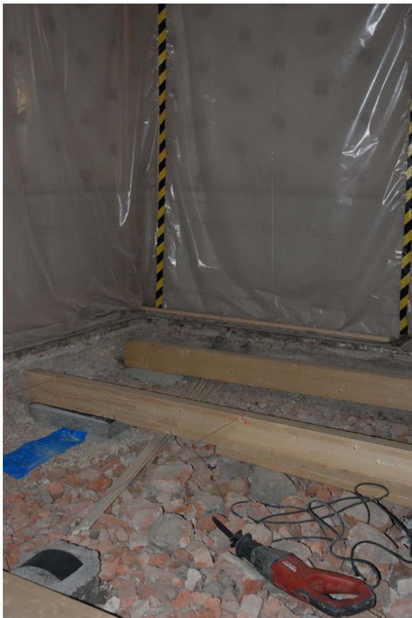
32-35. Kvarvarande fyllning behandlades med antisvampmedlet. De svampangripna bjälkarna ersattes med nya limträbjälkar. Dessa placerades på plintar av lecablock. Papp lades emellan.
