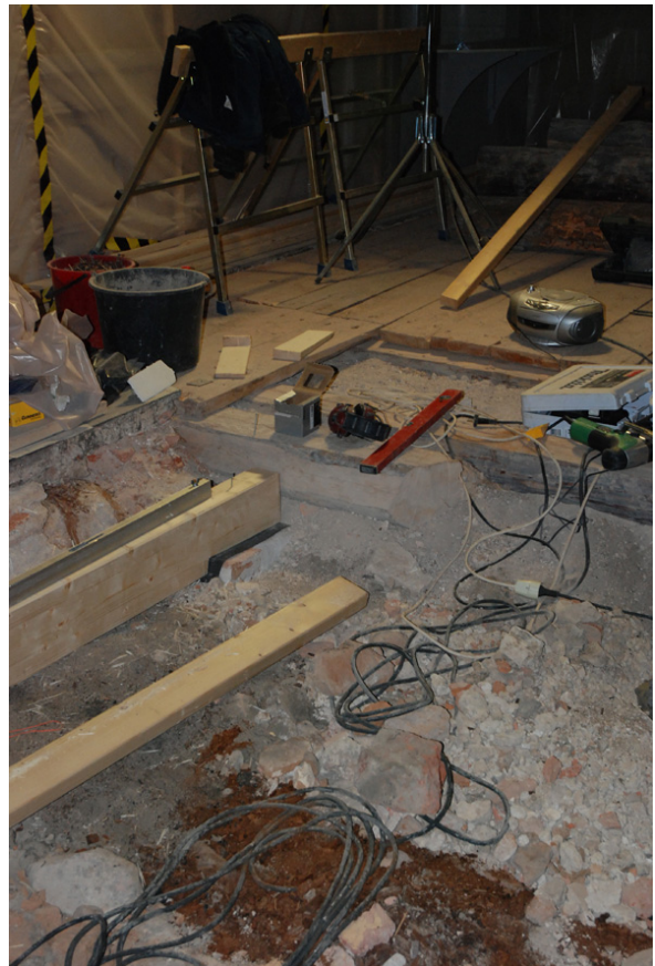
32-35. Kvarvarande fyllning behandlades med antisvampmedlet. De svampangripna bjälkarna ersattes med nya limträbjälkar. Dessa placerades på plintar av lecablock. Papp lades emellan.
