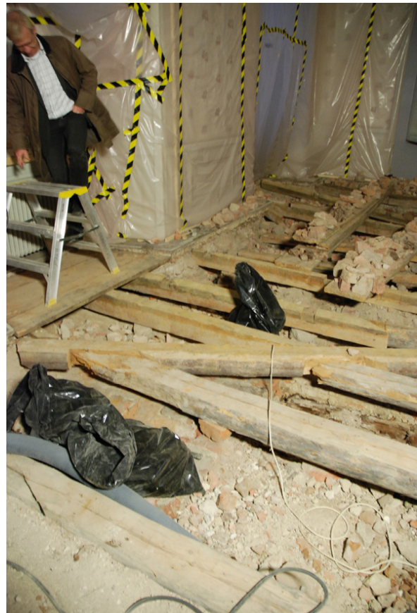
19–21. Bjälkarna var av olika dimension. I rummets östra del var bjälkarna av mindre och nyare karaktär. De härstammar troligen från tidigare renoveringar.
