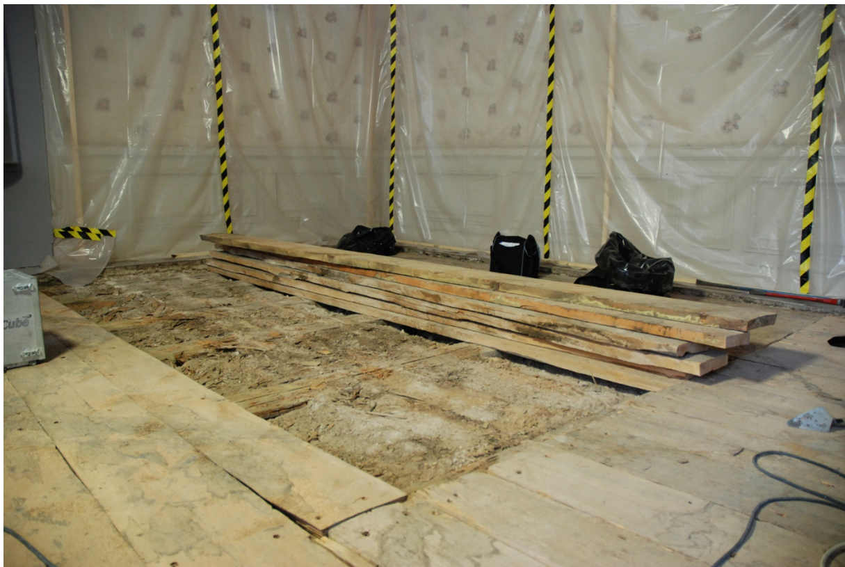
9-11. När undergolvet lyfts frilades golvkonstruktionen. Undergolvet vilade på tvärgående golvbjälkar. Fyllningen var en blandning mellan sand och tegelkross och spån. I fyllnadsmassorna hittades äldre keramiska föremål, synliga i bilden över t.v. Dessa har bevarats i en kartong på vinden.
