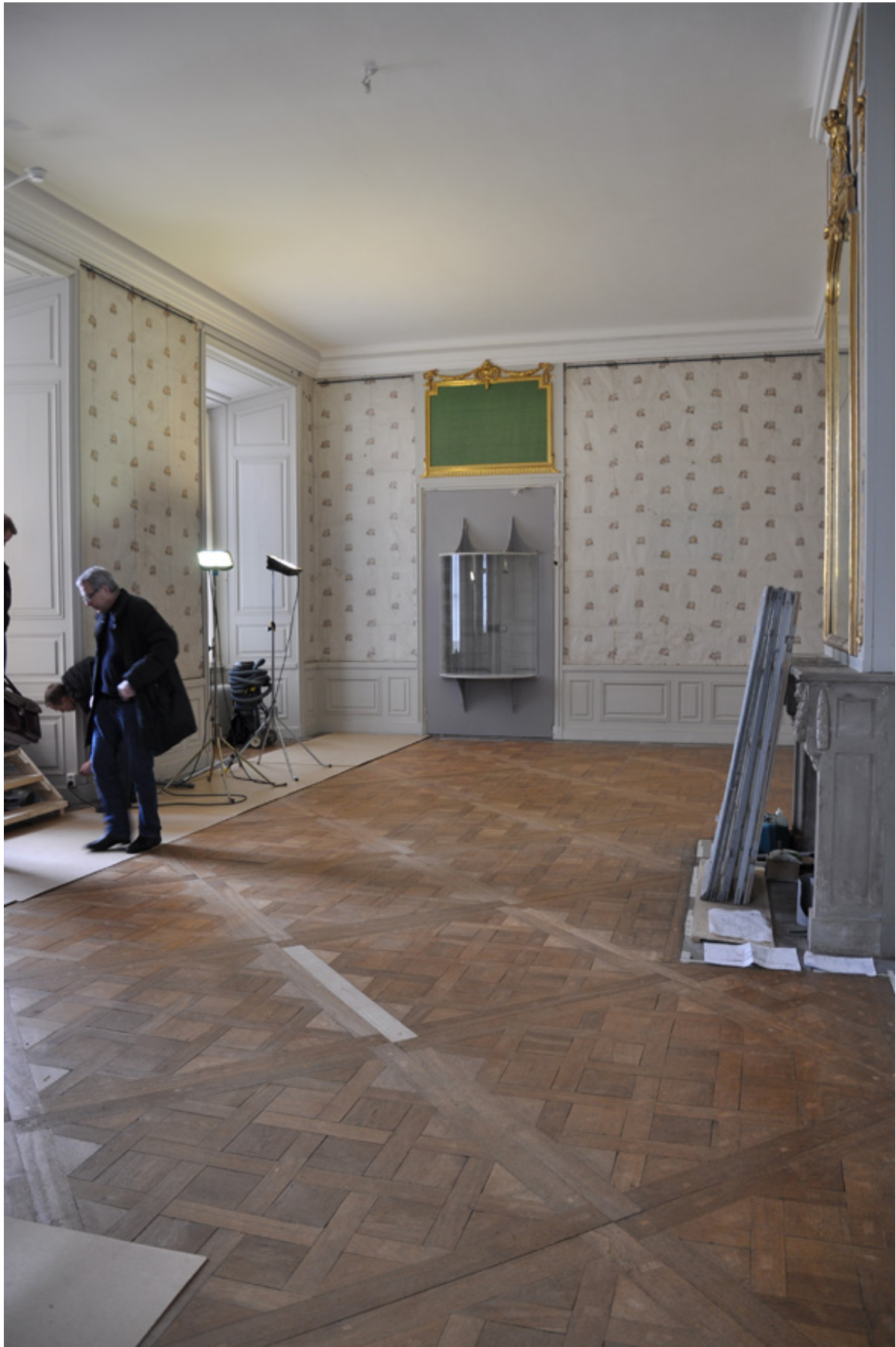
46. Det nyrenoverade parkettgolvet återlagt. I bild syns en del av en lagad ram med ett nytt trästycke innan det retuscherats in.
