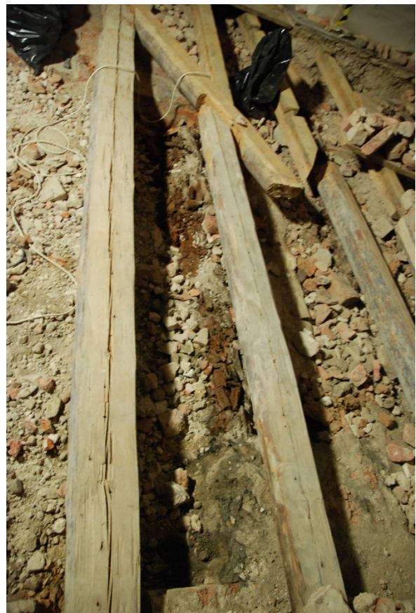
22-24. Fyllning av grov tegelkross. De bruna träesterna är äldre svampangripna bjälkar.
