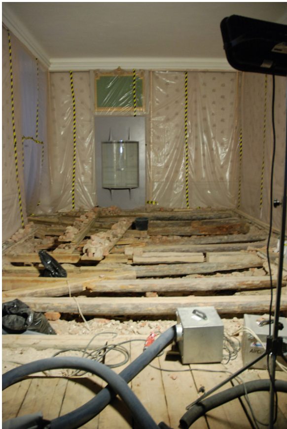
19–21. Bjälkarna var av olika dimension. I rummets östra del var bjälkarna av mindre och nyare karaktär. De härstammar troligen från tidigare renoveringar.
