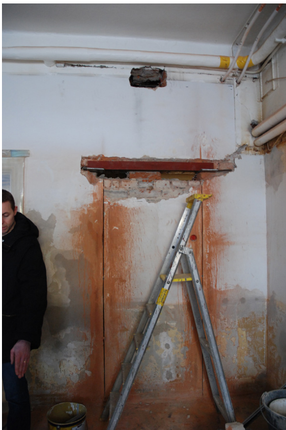
46-49. Dörr mot rum 214 sattes igen. Öppning mot 201 och håltagning och igensättning för ventilation.
