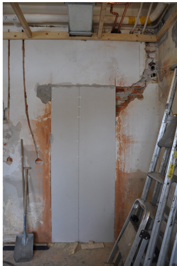
46-49. Dörr mot rum 214 sattes igen. Öppning mot 201 och håltagning och igensättning för ventilation.
