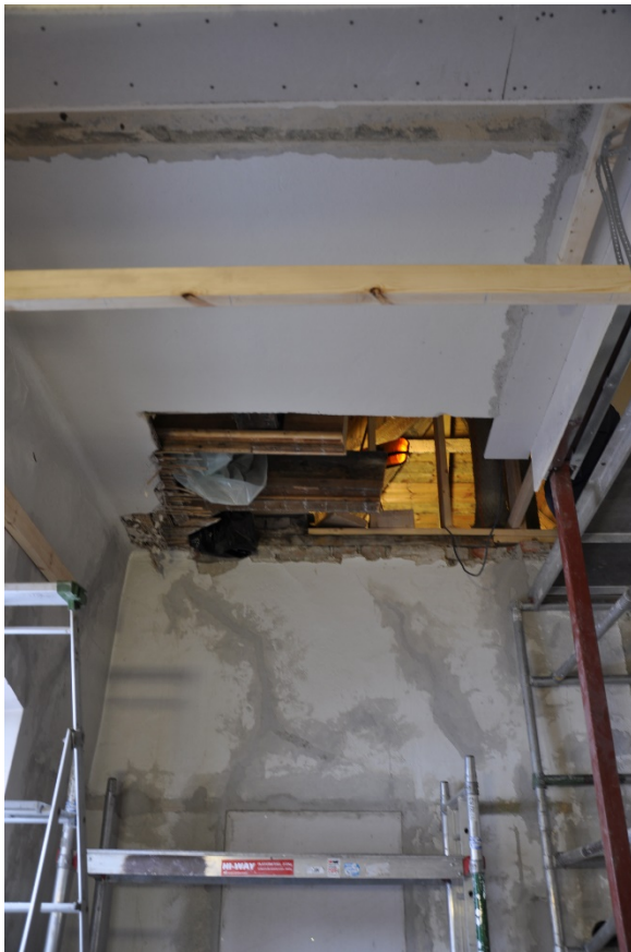
43-45. Håltagning i tak för ny trappa.
