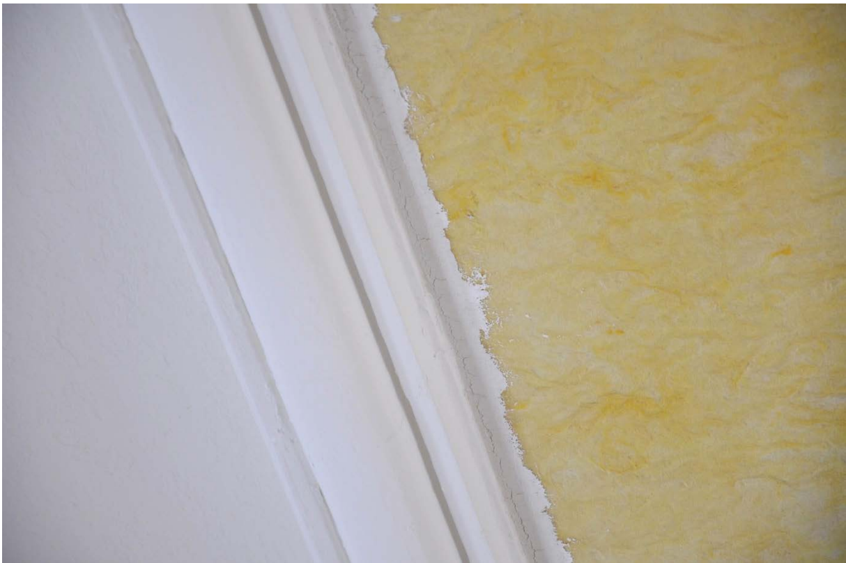
27-29. Ny akustikskiva med infästning mot listoerket.
