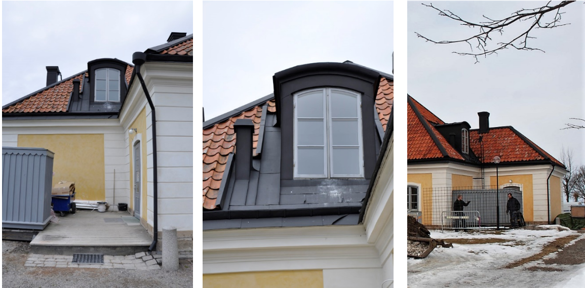
66-68. Innan utrymningstrappan monterats. T.h. Trappan monterad 2010.
