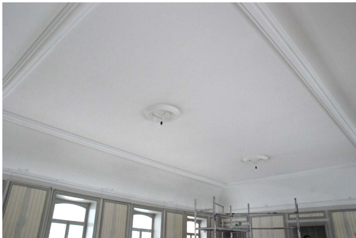
23-24. Lagningar i tak.
