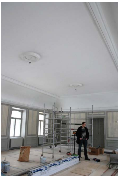
17-22. Snickerier målade med linoljefärg. Lagningar i vägg samt dokumentation av listverk och takrosett innan takrenovering.
