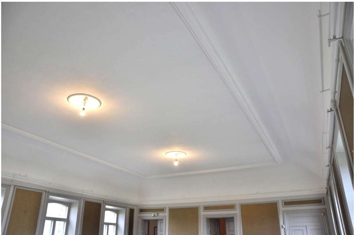
30-31. Ny akustikskiva med infästning mot listverk. Taket med infärgad akustikputs, vid slutbesiktning.
