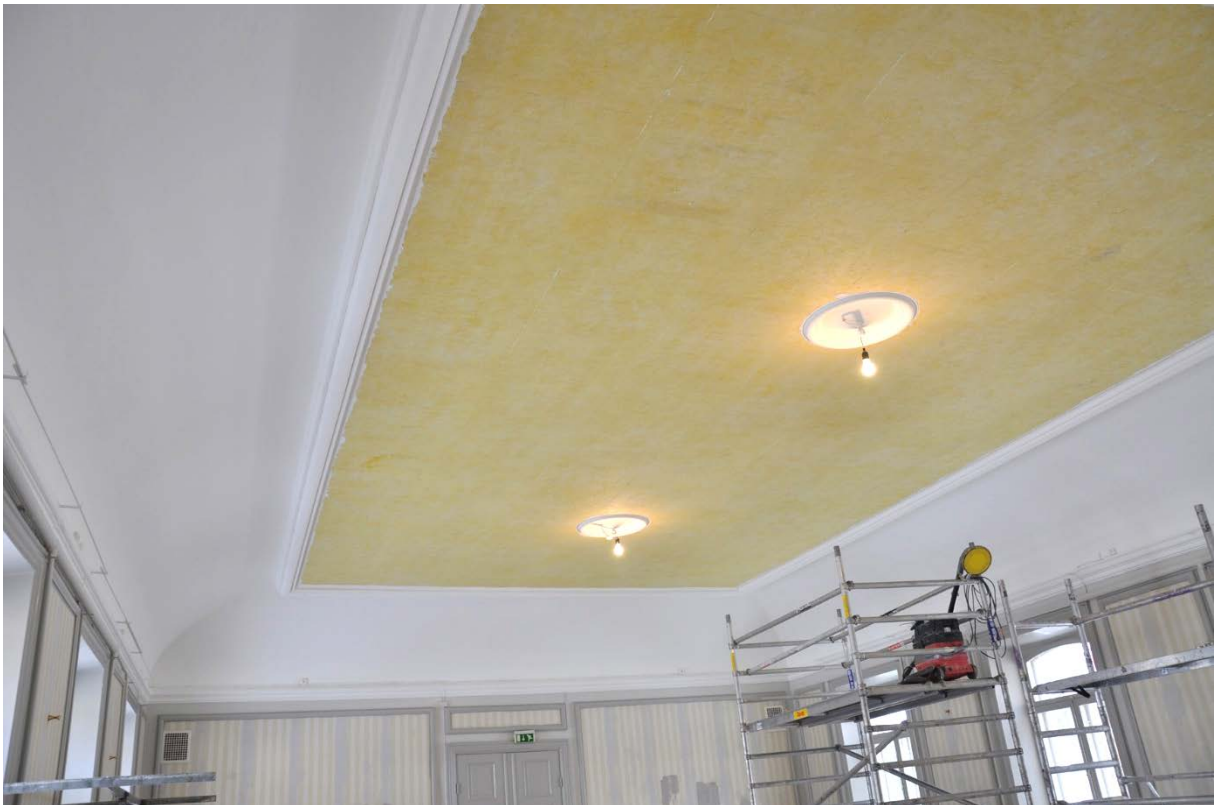
25–26. Nytt akustikskiva monterad.
