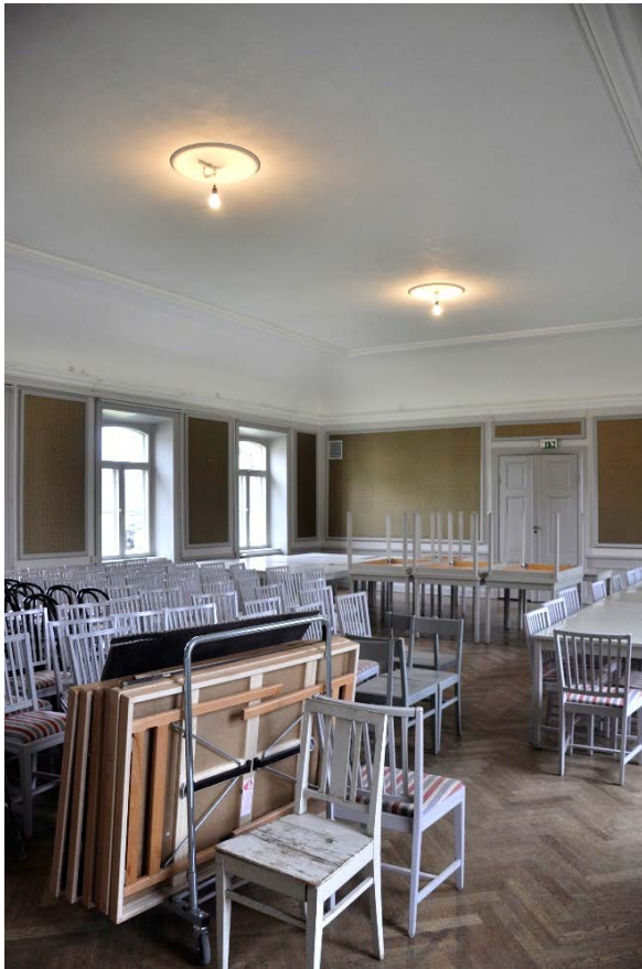
34-36. Taket med infärgad akustikputs och de nya tapeterna, vid slutbesiktning.
