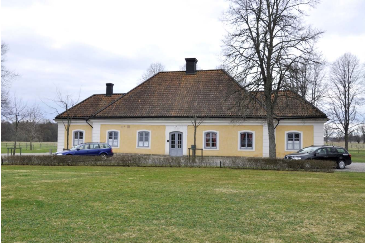
6. Stenköket med fasad mot norr, vintern 2009.
