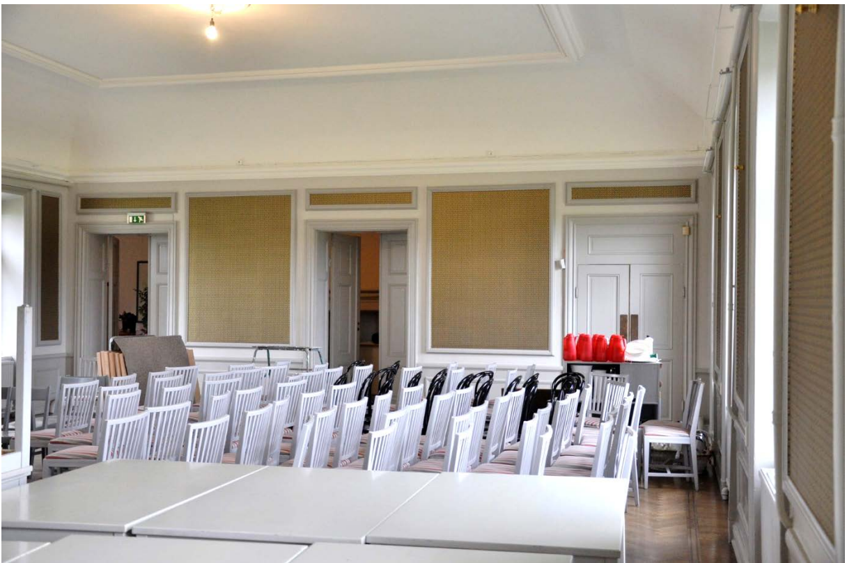
32–33. Taket med infärgad akustikputs och de nya tapeterna, vid slutbesiktning.
