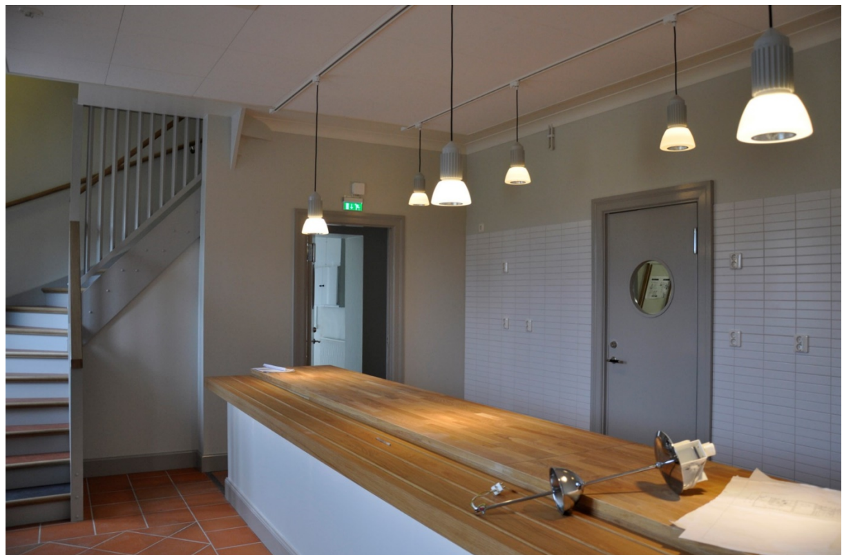
50-51. Rum 210 med den nya trappan, vid slutbesiktningen. På golv lades klinker och på väggarna sattes kakel.
