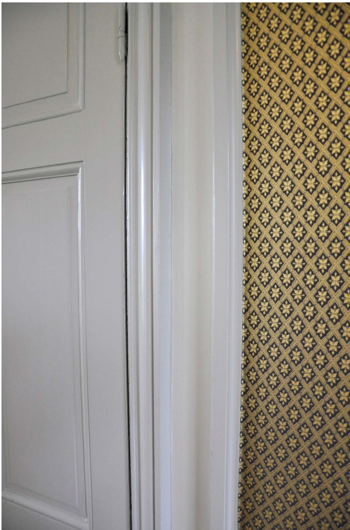
37. Snickerier målades med linolja.
