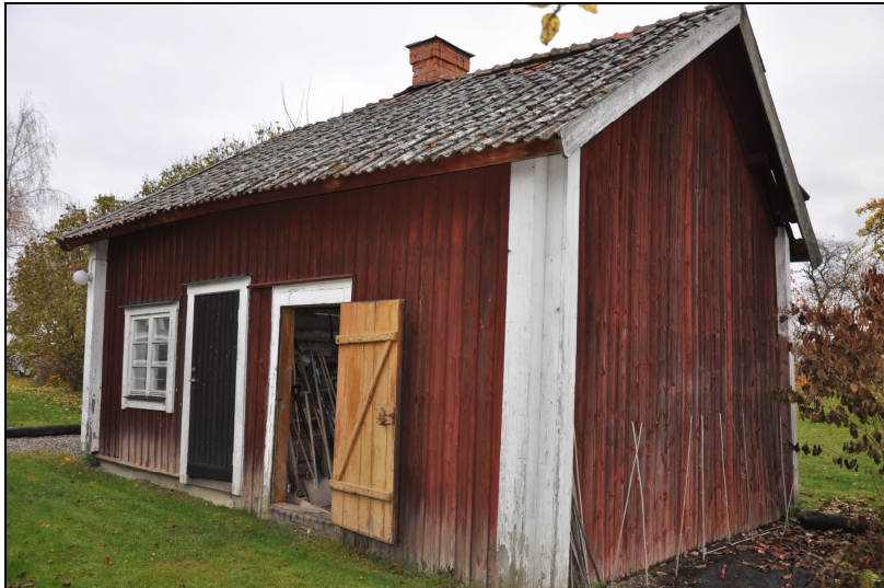
Byggnaden innan renovering, oktober 2009. Foto: Ia Manbo.
