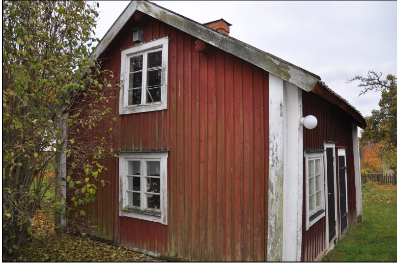
Byggnaden innan renovering, oktober 2009. Foto: Ia Manbo.
