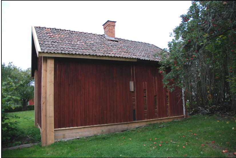
Byggnaden efter renovering, september 2010.
