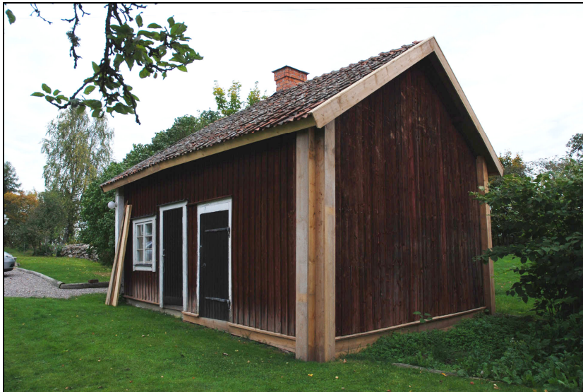
Byggnaden efter renovering, september 2010.
