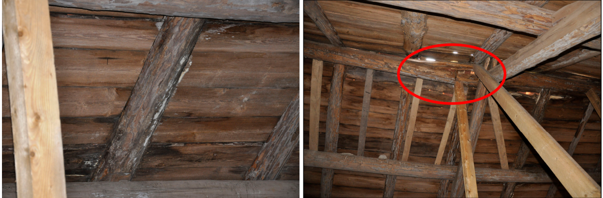
Ovan t v: Underlagsbrädorna var på flera ställen rötskadade. Ovan t h: Kroppåsen hade gått av på grund av vattenläckage.
