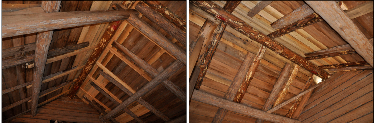
Kroppåsen byttes samt delar av undertaket.
