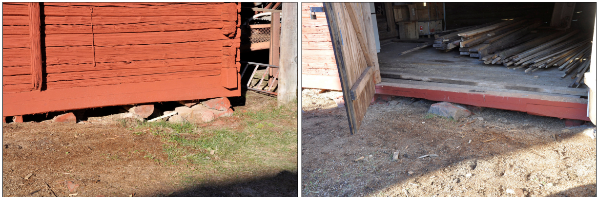
Ovan t v: Byggnadens ena hörn lyftes cirka 20 centimeter.
