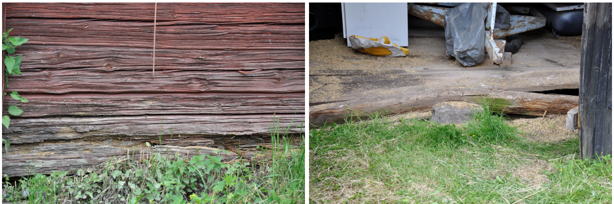
Ovan t v: Syllen var kraftigt rötskadad på grund av förhöjd marknivå. Ovan t h: På ett ställe hade syllen gått av.
