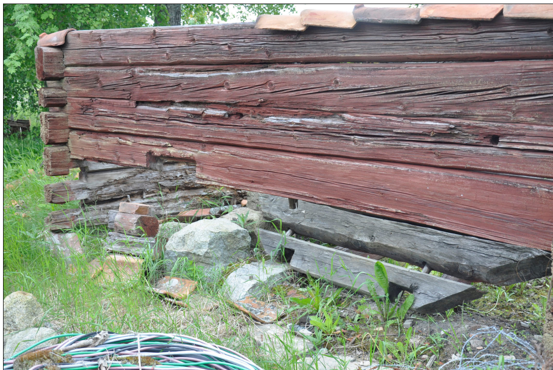
Bilder ovan: Flera av byggnadens timmerstockar hade rötskador. Takkonstruktionen hade helt rasat in.
