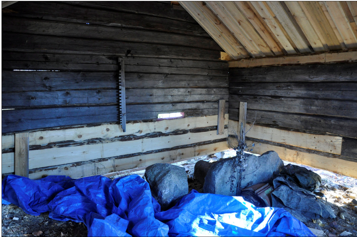
Byggnaden invändigt. Den blivande ässjan är markerad med stenar.
