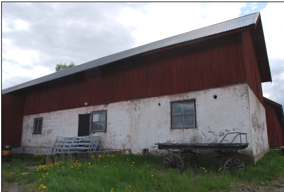
Ladugårdens baksida innan upprustning.
