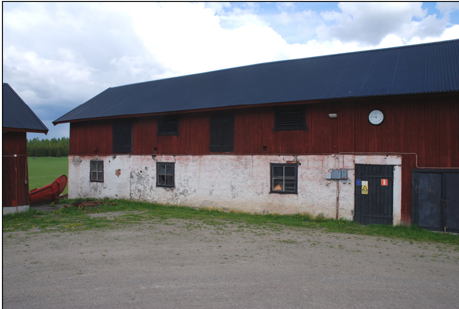
Ladugårdens framsida innan upprustning.
