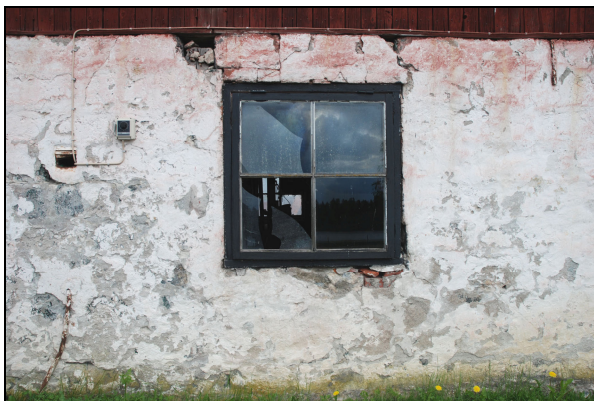
Fönster och delar av fasad innan upprustning.
