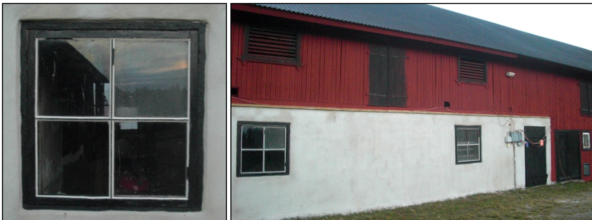
Fönster och fasad efter reovering. Foto: Mattias Persson.
