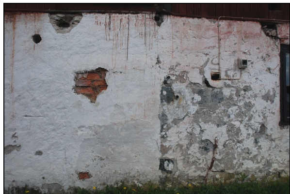
Skador och håltagningar i fasad innan upprustning.
