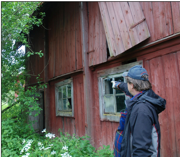
Fastighetsägare Håkan Persson vid ladugårdens norra fasad.
