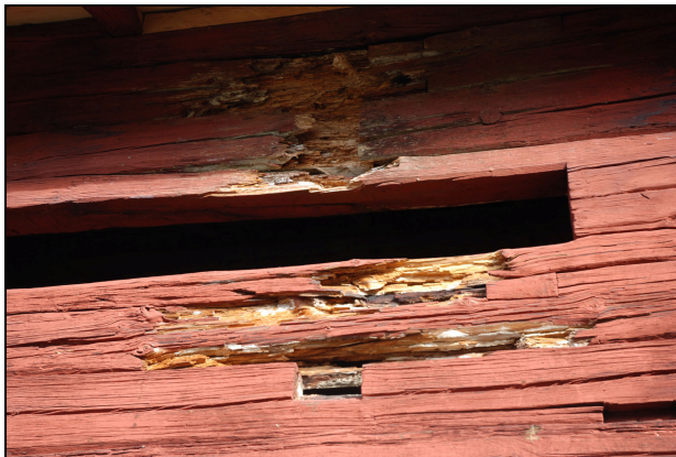
Rötskadade stockar under takutsprånget, västra fasaden.
