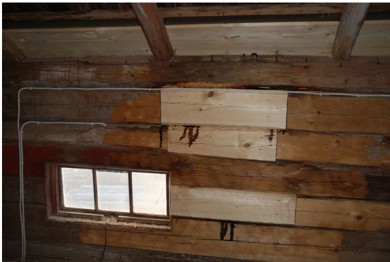
Rötskadat timmer lagat genom halvsulning, insidan av väggen över snickarboden/förrådet.
