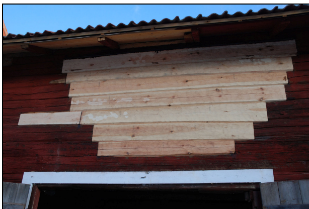
Nytt bilat timmer under takutsprånget, västra fasadens utsida.
