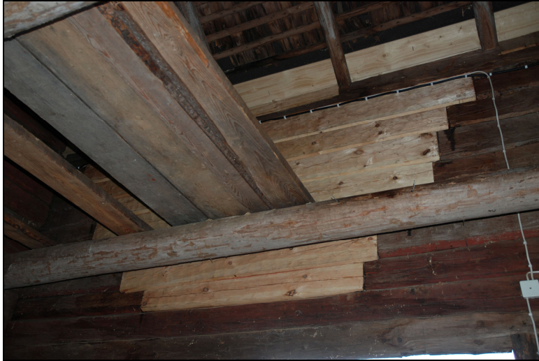
Nytt bilat timmer under takutsprånget, västra fasadens insida.
