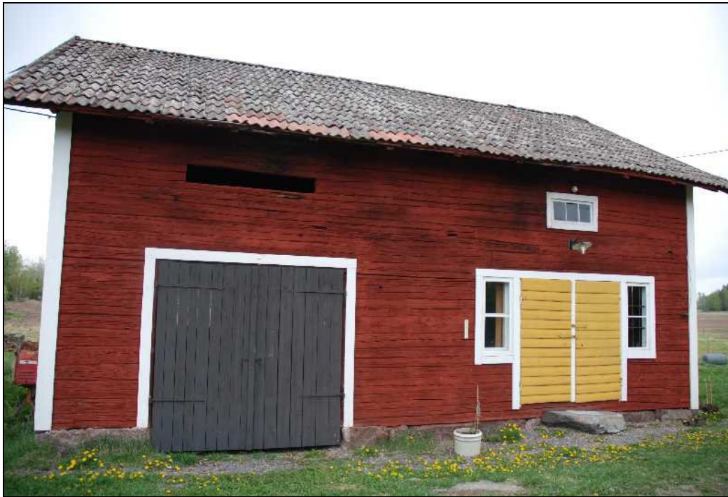
Vedboden innan renovering. Mörka skiftningar syns i de övre timmervarven.
