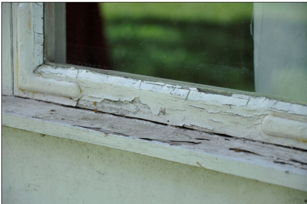
På fönstren flagnade färgen betydligt.
