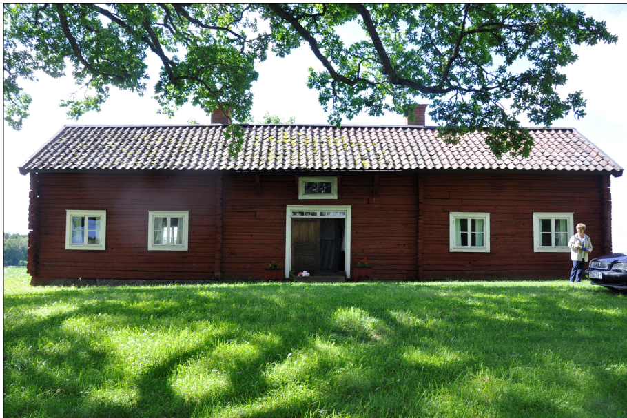
Byggnadens östra fasad före restaurering.
