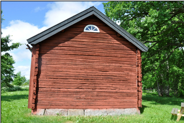
Byggnadens södra fasad före restaurering. Färgen hade flagnat betydligt, sydfasader är ofta mer utsatta på grund av den kraftiga solstrålningen.
