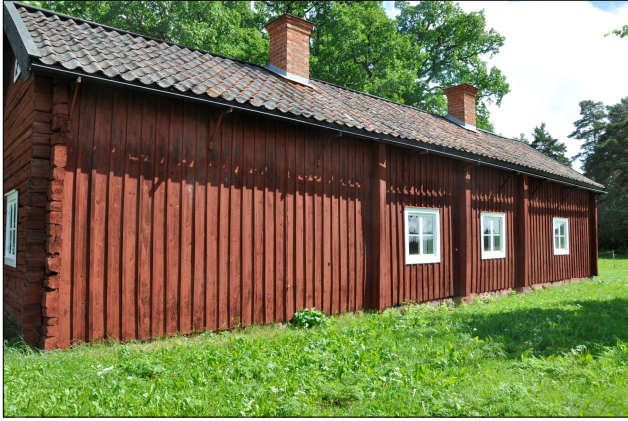
Byggnadens västra fasad före restaurering. Färgen hade flagnat vilket resulterat i mörkare partier på fasaden.
