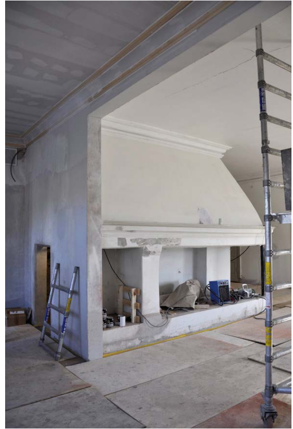
30-32. Pelarna har en fått en Monier konstruktion med armering, putsnät och puts. Ventilationsdon sattes upp i kapprummets östra vägg.
