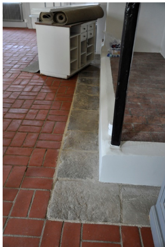
97–100. Detaljer av den renoverade spisen. Den äldre kalkstensfrisen lyftes upp till den nya golvnivån och lades runt spisen.
