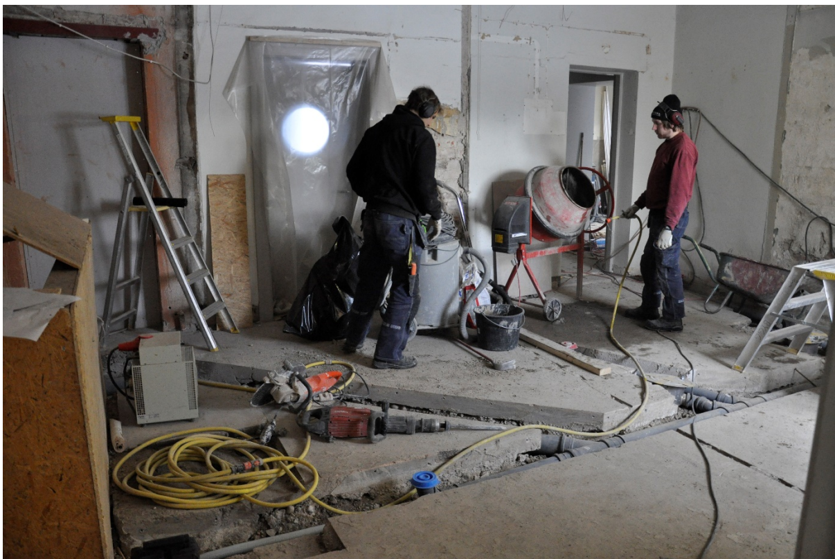
108–109. Överst det rivna trapphuset. Nedre bilden visar ledningsdragning i golvet.
