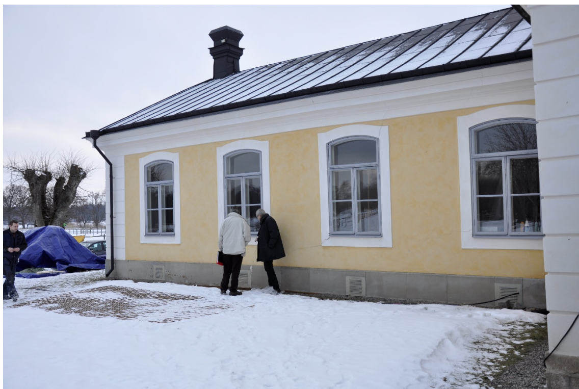
141–142. Inför grävning och håltagning för nya trappan.
