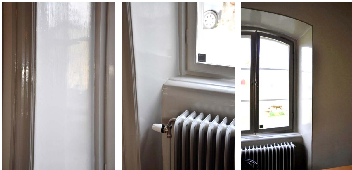
136–138. Snickerier, fönsternischer, fönster m.m. målades med linoljefärg.
