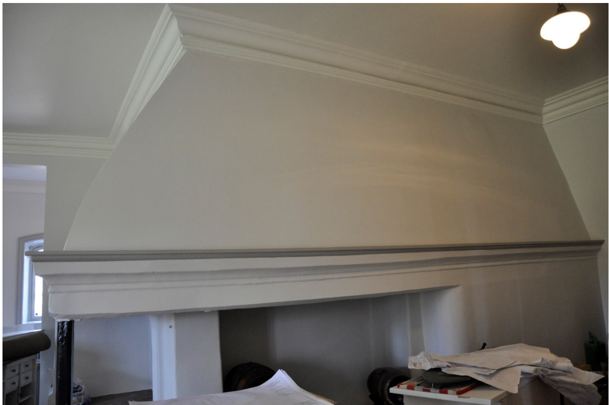
93-94. Sprickor i spisens kupa har lagats och därefter har kupan målats efter befintlig färgsättning i vitt och grått.
