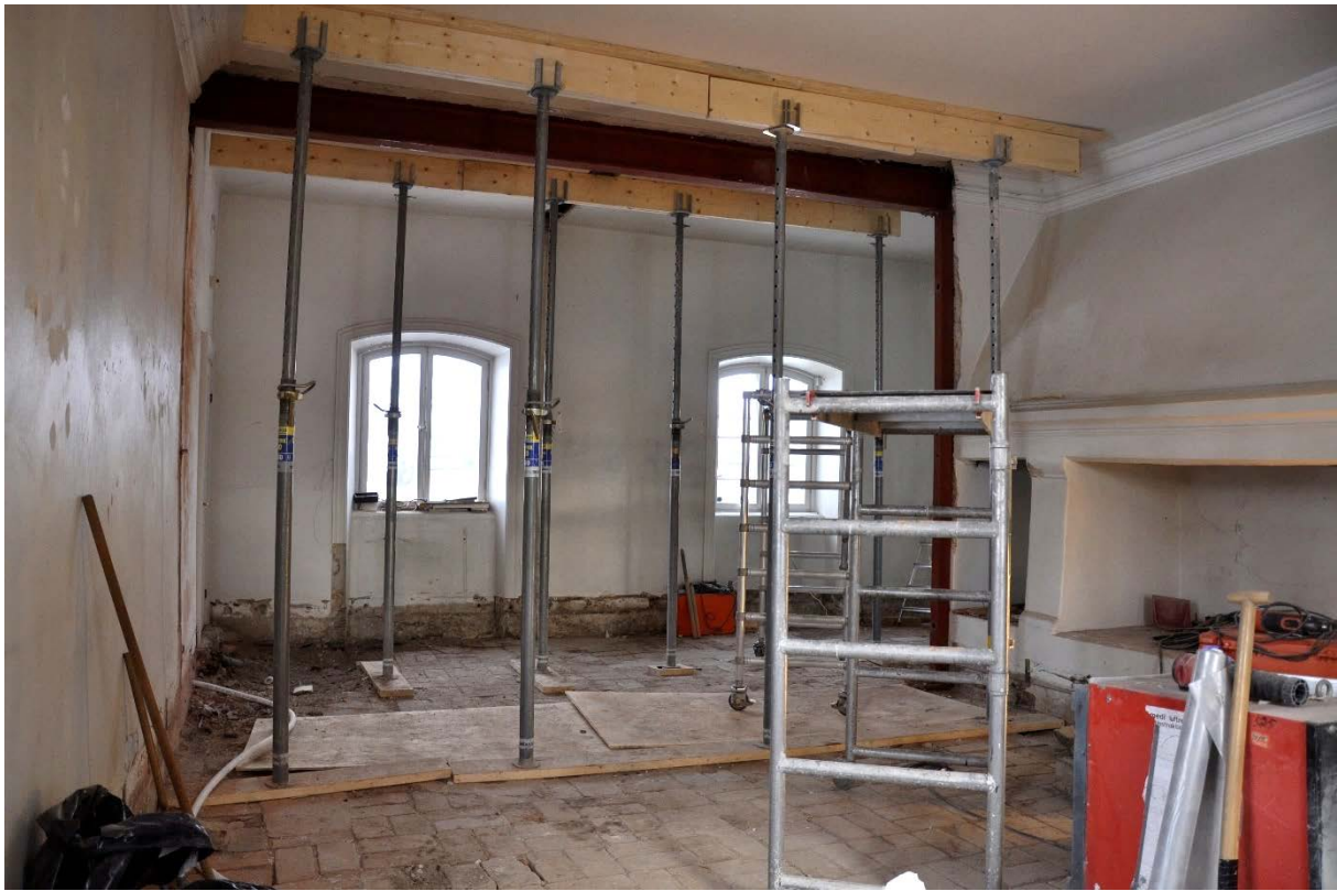
26-29. En avväxling med stålbjalkar och stålpelare för last mot väggarna.
