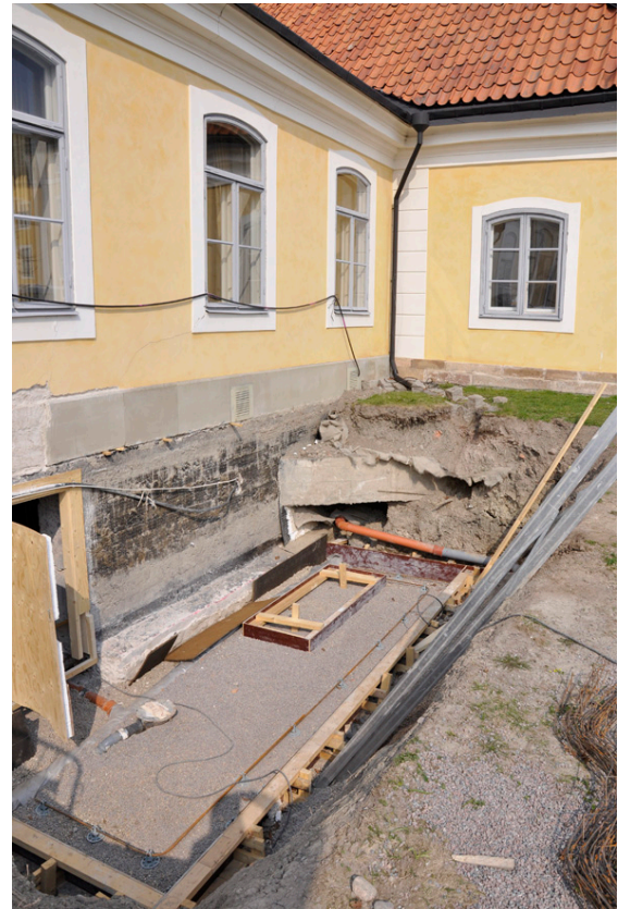
143-145. Håltagning för dörr är genomförd. Uppbyggnad av trappan har påbörjats.
