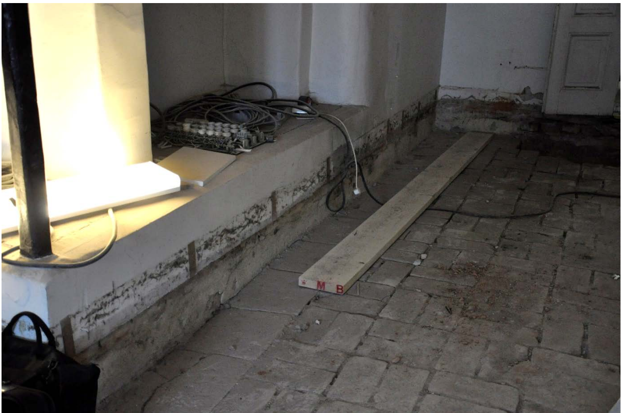
51. Runt eldstad och mot delar av ytterväggen fanns en kalkstensfris. Notera höjdskillnaden mellan den borttagna och den framtagna golvnivån.
