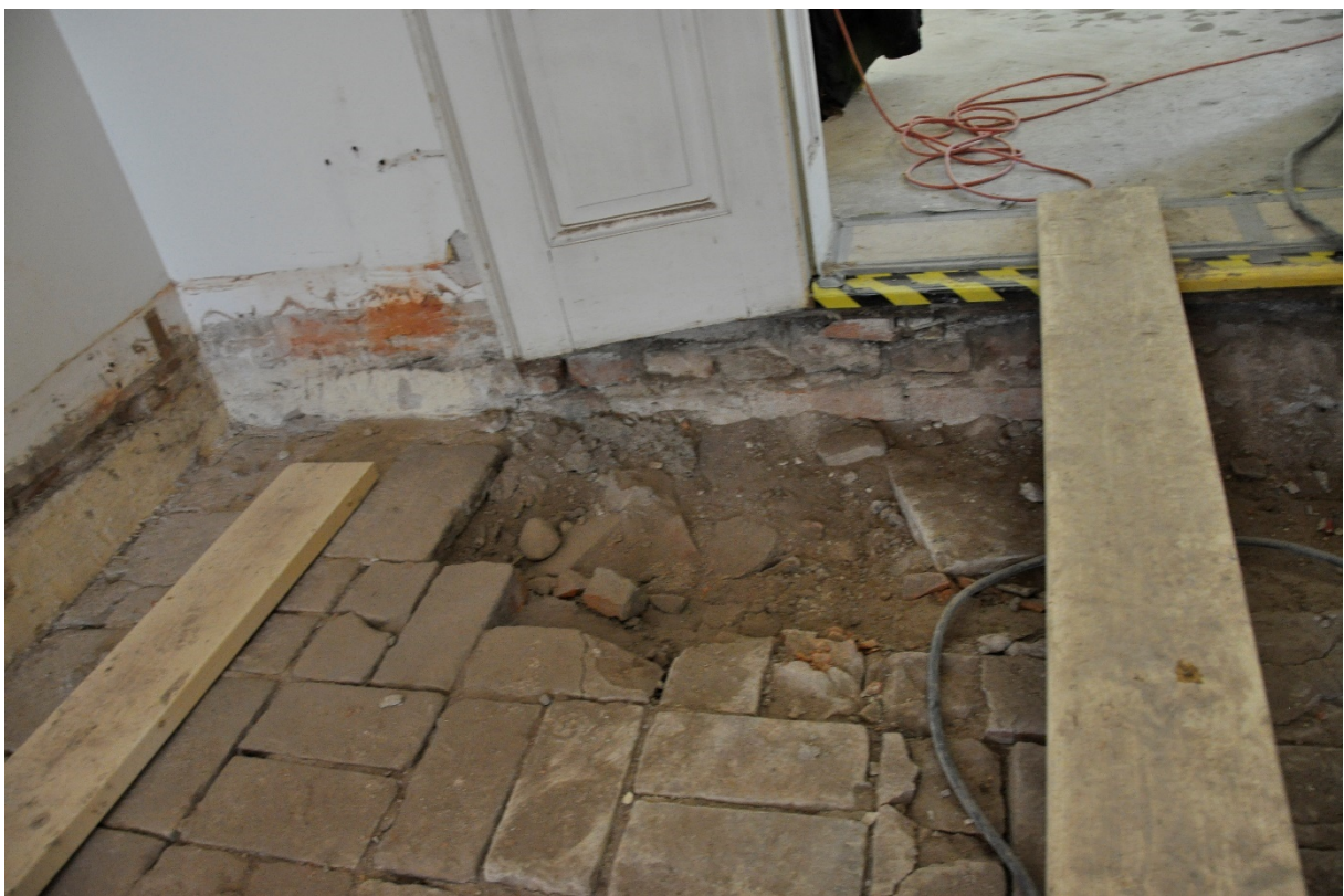
52-53. Överst: Tröskeln mellan det gjutna golvet i rum 202 och 203 och det framtagna tegelgolvet i rum 207. Nederst: Tröskeln in till rum 209.
