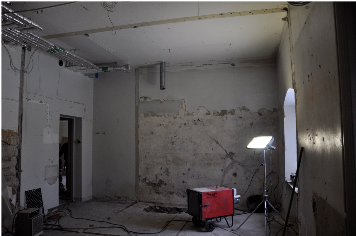
101. Det äldre diskrummet revs och väggar togs ned.
