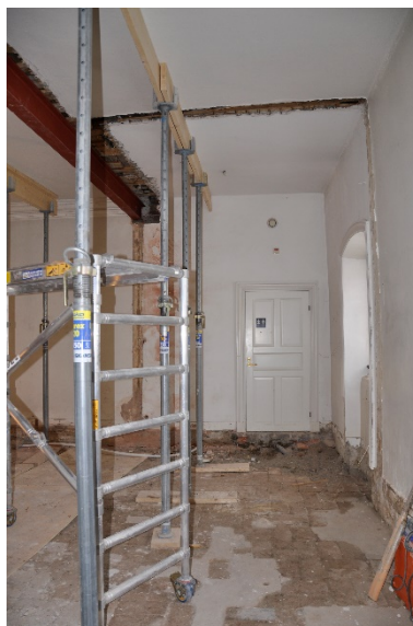
17-25. Under pågående rioning av väggar. Det äldre tegelgolvet har tagits fram.
