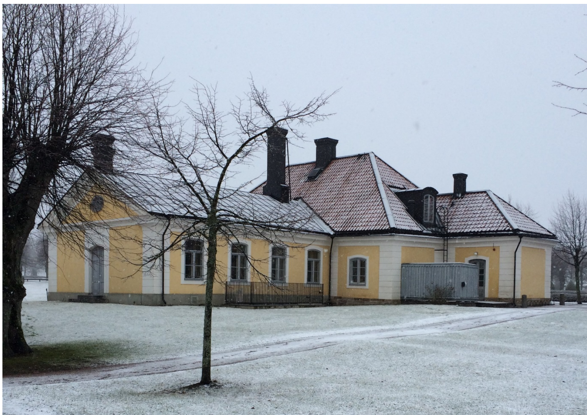
146. Trappan med räcke till källaren efter färdigställandet och skorstenen med det nya tilluftsintaget. Foto: Björn Norman.
