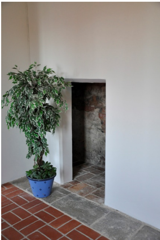
97–100. Detaljer av den renoverade spisen. Den äldre kalkstensfrisen lyftes upp till den nya golvnivån och lades runt spisen.
