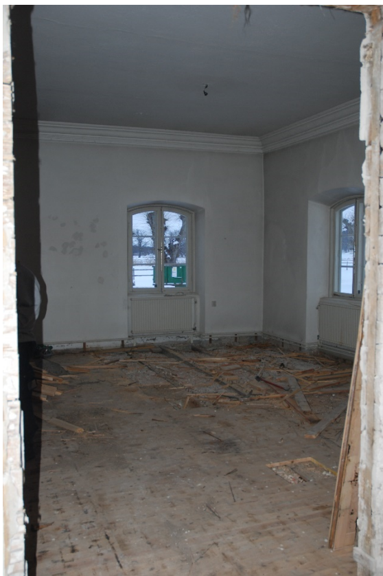
45–47. Rötskador konstaterades i golvet i rum 207. När flera lager av golv tagits bort fanns en golvkonstruktion med bjälkar vilande på tegel. Fyllningen bestod av tegel, bruksrester och sand. Under denna konstruktion fanns ett äldre golv av tegel lagt i holländskts mönster.
