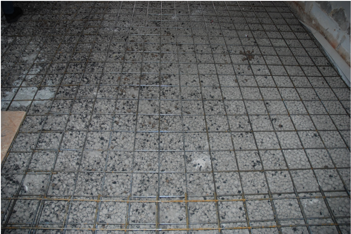
74–75. Detaljbilder av "tittskåps"-konstruktionen och golvkonstruktionen.
