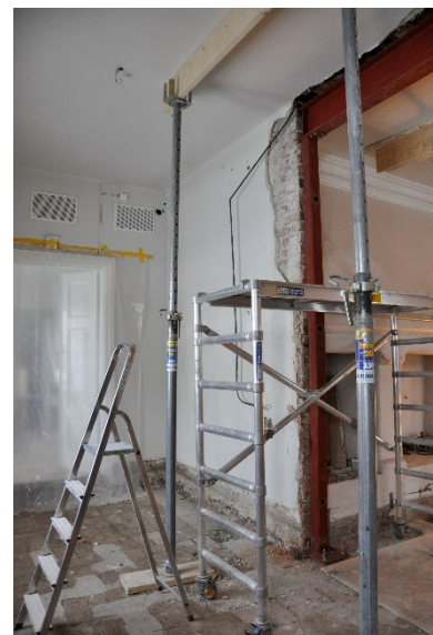
17-25. Under pågående rioning av väggar. Det äldre tegelgolvet har tagits fram.
