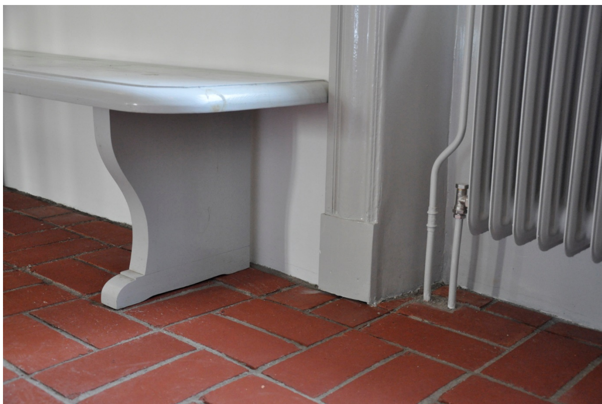
76-77. El- och vattenledningar lades i golvkonstruktionen och drogs upp via ytterväggarna.
