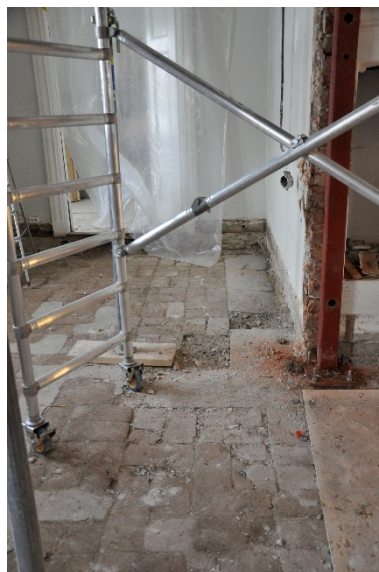
17-25. Under pågående rioning av väggar. Det äldre tegelgolvet har tagits fram.
