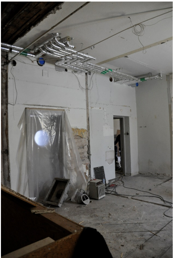
104–107. Trappan till våning 3 revs och trappan till våning 1 byggdes igen. Ledningar och avlopp bilades ner i det gjutna betonggolvet.
