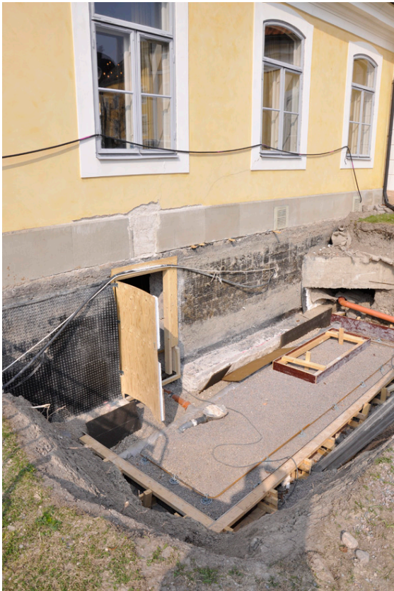
143-145. Håltagning för dörr är genomförd. Uppbyggnad av trappan har påbörjats.
