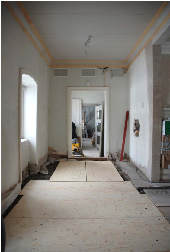
30-32. Pelarna har en fått en Monier konstruktion med armering, putsnät och puts. Ventilationsdon sattes upp i kapprummets östra vägg.
