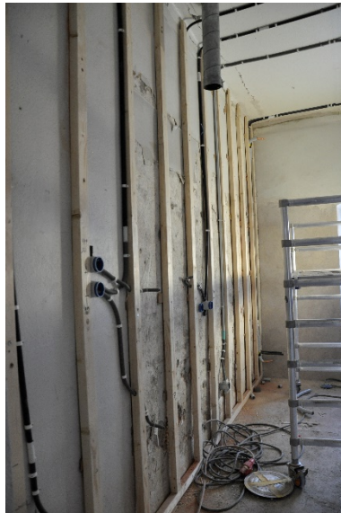
111–113. Nya väggar har reglats mot den äldre tegelväggen för att minska ingrepp i stommen. Vatten och el har fällts in för att minska påverkan på tegelväggen.
