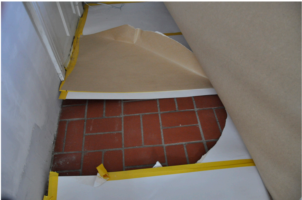
78–79. Överst: "Tittskåpet" vid slutbesiktningen innan den översta rutan monterats. Nederst: Ett nytt tegel i snarlikt storlek som det äldre teglet lades i samma mönster som det äldre golvet.
