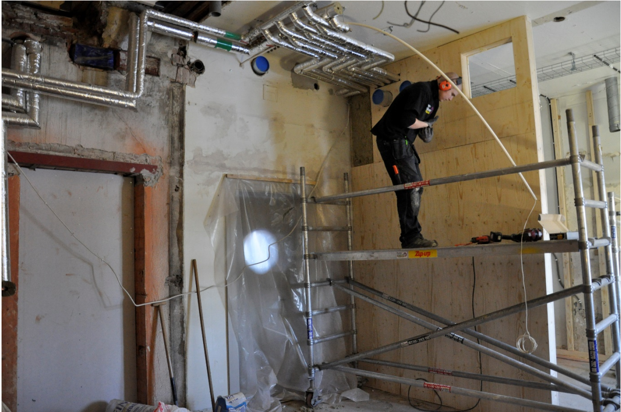
110. Ny vägg monteras.
