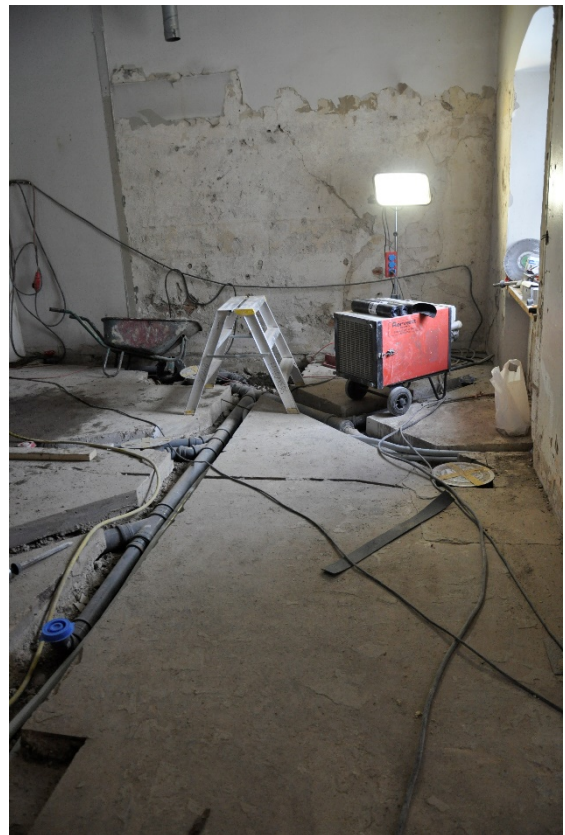
104–107. Trappan till våning 3 revs och trappan till våning 1 byggdes igen. Ledningar och avlopp bilades ner i det gjutna betonggolvet.
