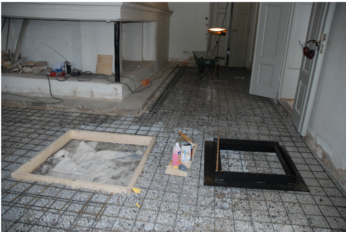
72–73. En ny golvkonstruktion lades med lättklinkergrus och armeringsjärn. Nedersta bilden visar konstruktionen för det "tittskåp" som byggts för att synliggöra det äldre tegelgolvet.
