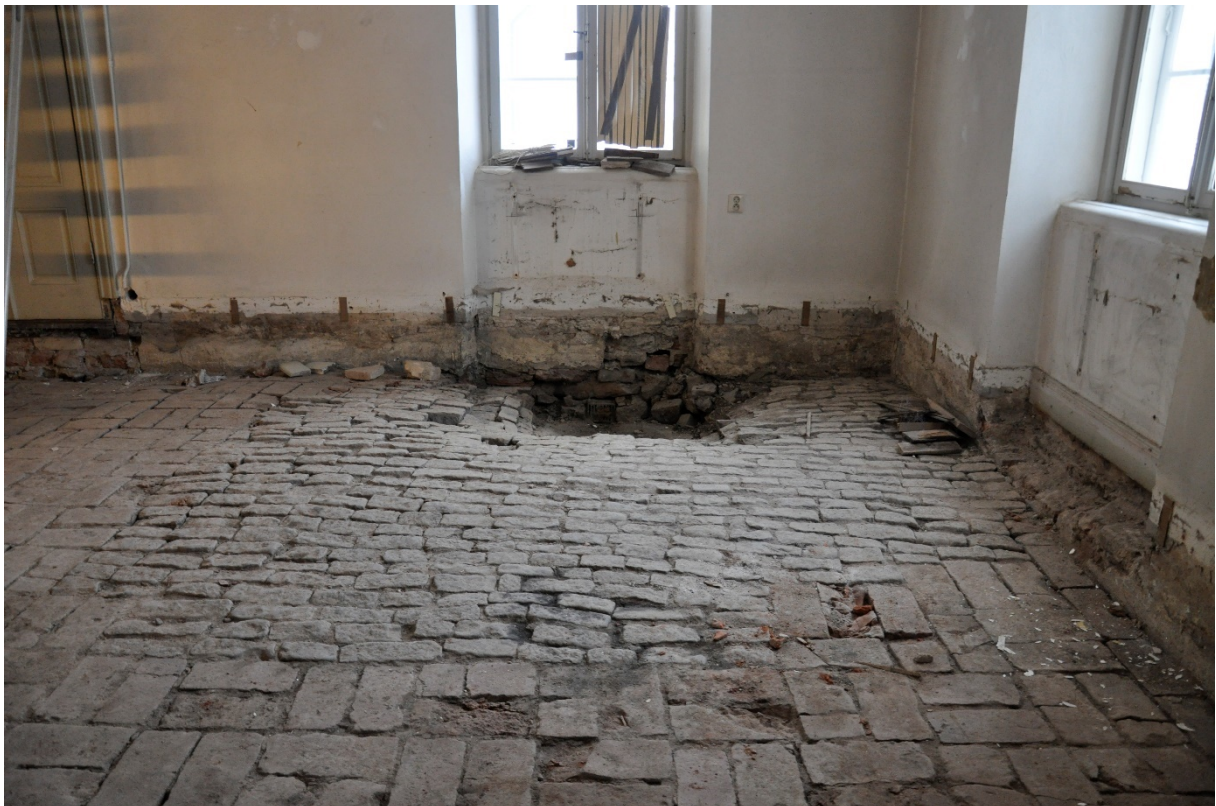
48-49. Det äldre tegelgolvet är med stor sannolikhet husets ursprungliga golv. I rummets sydvästra hör fanns en slask som leder ut från huset. Slasken är lagd med ensten i granit.
