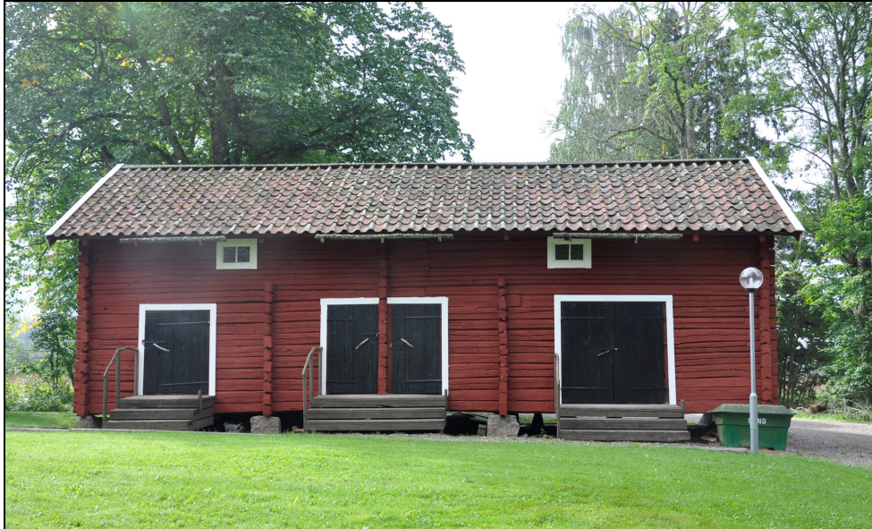
Bod efter ommålning. Foto: Vlm_kmvLS-433.
