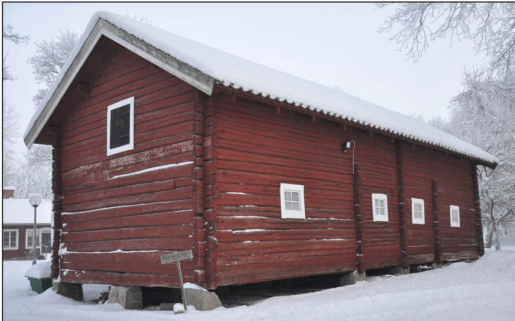
Bod före ommålning. Foto från Västmanlands läns museums besiktning 14 januari 2010.
