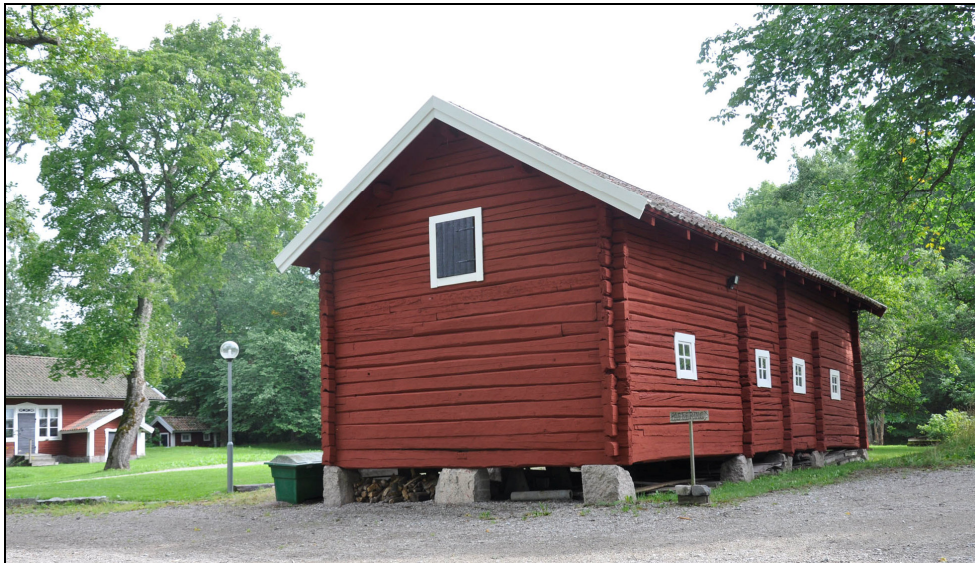
Bod efter ommålning. Foto: Vlm_kmvLS-435.
