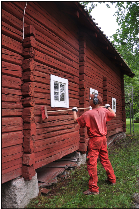
Löst sittande färg borstas bort. Foto: Vlm_kmvLS-426.
