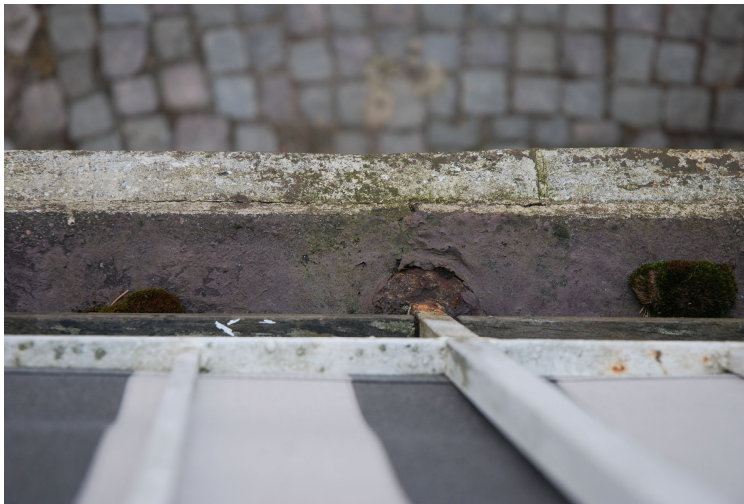
Räckets infästning i balkongen och uttjänt tätskikt.
