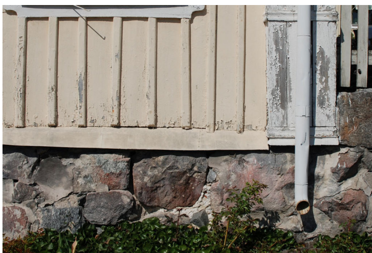
Mellan stenar i grundmuren har murbruk lossat, södra fasaden.
