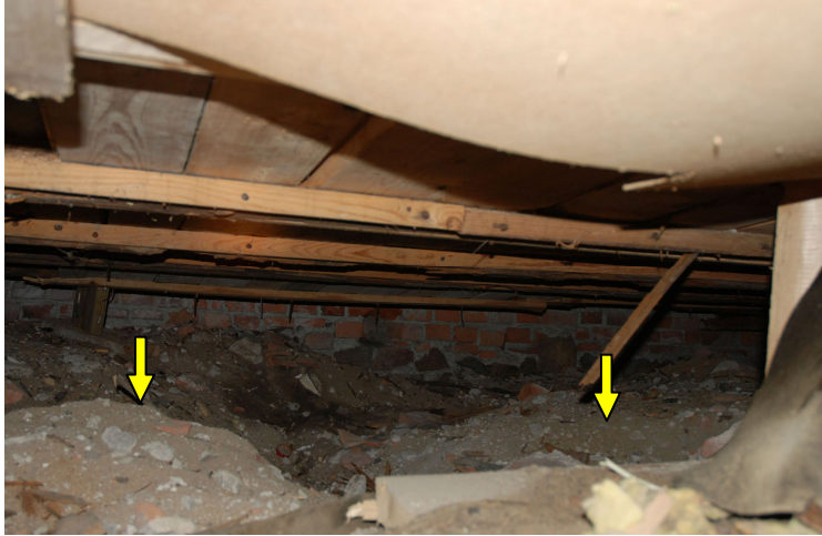
Pilarna visar rester efter byggskräp i kryppgrunden.
