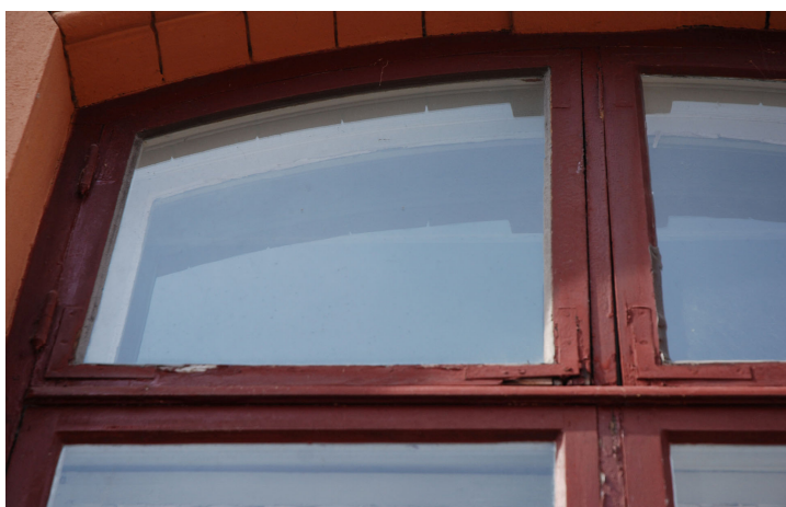
Vlm_kmvLS-1630 Kittbortfall, flagnande färg och hörnjärn i behov av översyn.
