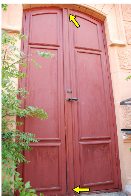
Vlm_kmvLS-1595 Skevt och otät dörr.
