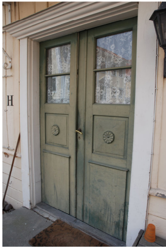
Vlm_kmvLS-1670 Pardörr på norra fasaden.
