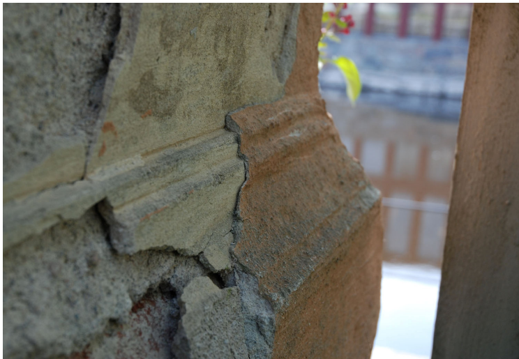
Putsskada som visar äldre och yngre skikt. Den äldre blekgula putsens listdragning har skarpa vinklar medan det yngsta skiktet ligger i ett tjockt och klumpigt lager.
