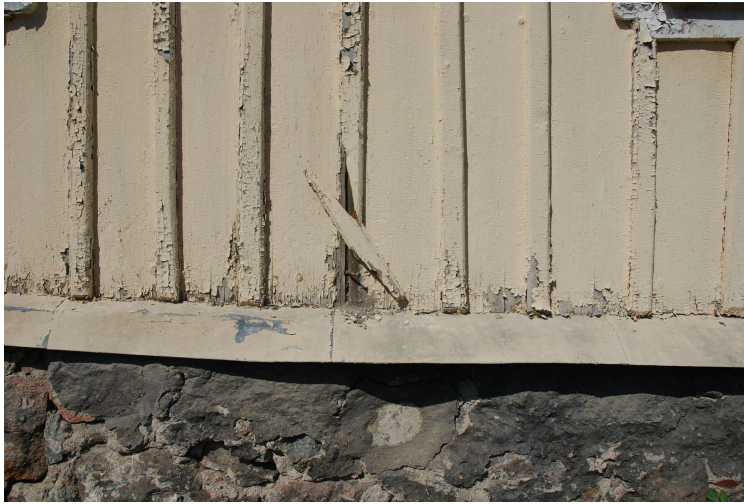
Flagnad färg och skadad locklist, södra fasaden.
