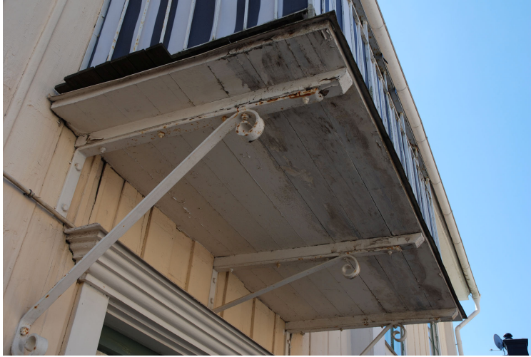
Balkong med missfärgad undersida och rostangripet smide.
