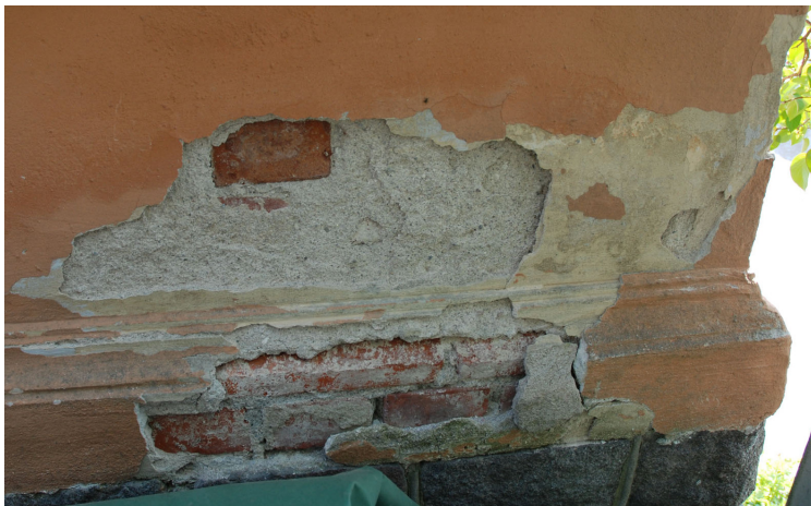
Putsskador där de äldre färgskikten framträder.
