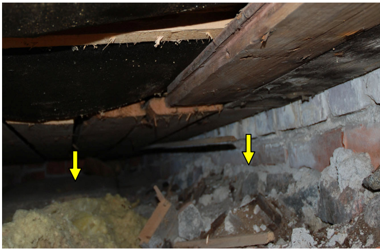
Pilarna visar rester efter byggskräp i kryppgrunden.
