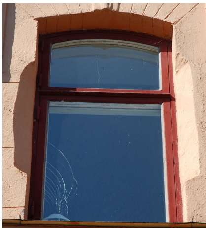
Vlm_kmvLS-1539 Sprucken ruta, södra fasaden.
