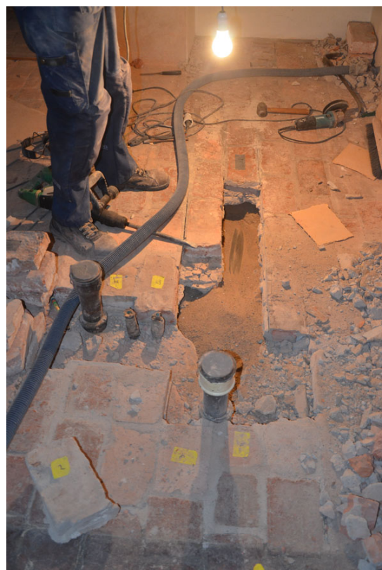
27-28. Teglet är satt i bruk och ledningarna ligger i sand. Inga spår av äldre bjälklag är synliga.
