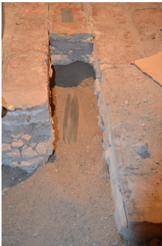
27-28. Teglet är satt i bruk och ledningarna ligger i sand. Inga spår av äldre bjälklag är synliga.
