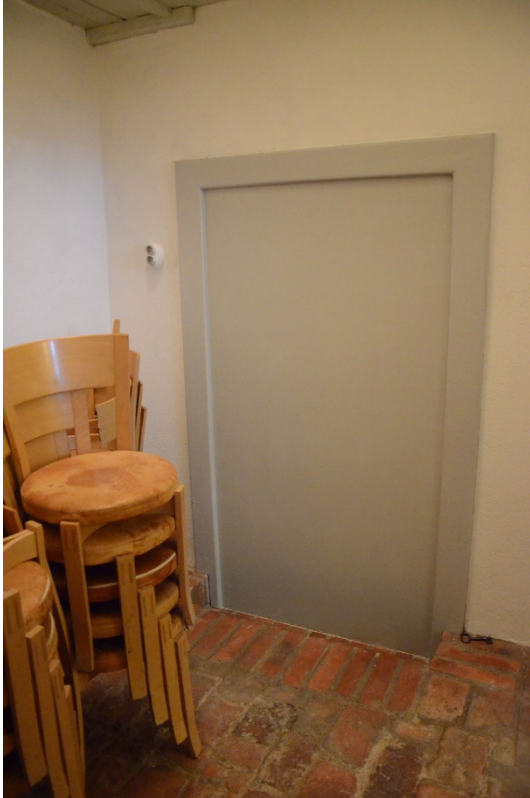
33. Dörrhålet mellan rum 142 och 141 är igensatt.
