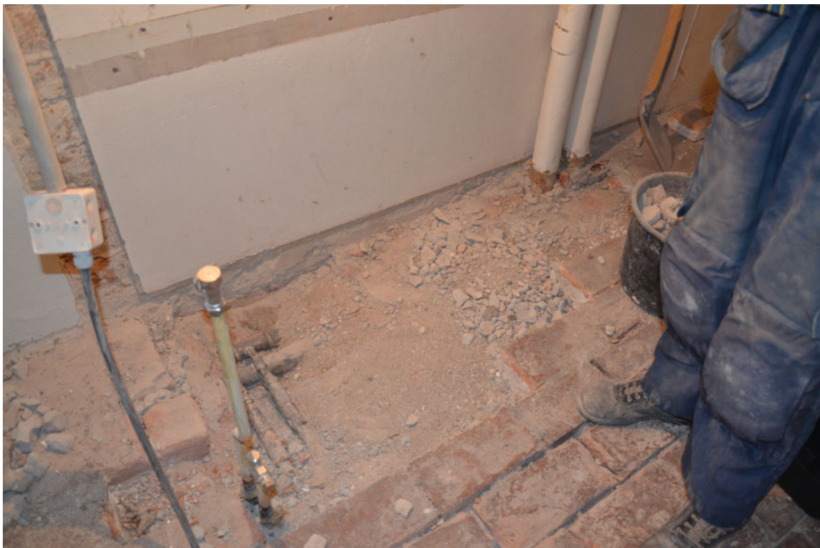
20-25. Det mönsterlagda tegelgolvet lyfts där nya ledningar ska dras. Det jämnas ut och fogas.
