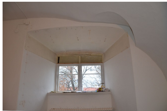
10 – 15. Rummet under röningsarbetet. Den upptagna dörröppningen med dörr till rum 142 är plats. Ventilationsledningarna är rivna och gallret för inluft i fönstret är frilagt.
