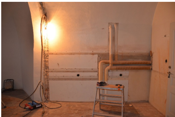
10 – 15. Rummet under röningsarbetet. Den upptagna dörröppningen med dörr till rum 142 är plats. Ventilationsledningarna är rivna och gallret för inluft i fönstret är frilagt.
