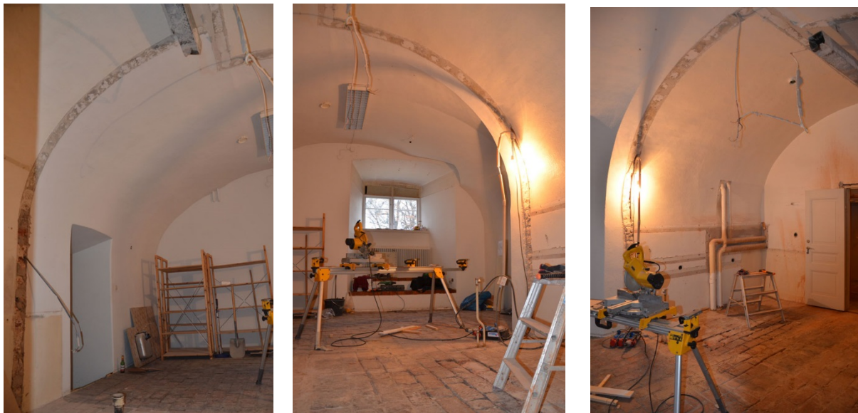
7–9. Väggarna mellan rum 138, 139 och 149 har rivits. Spår efter de tidigare väggarna syns i taket.
