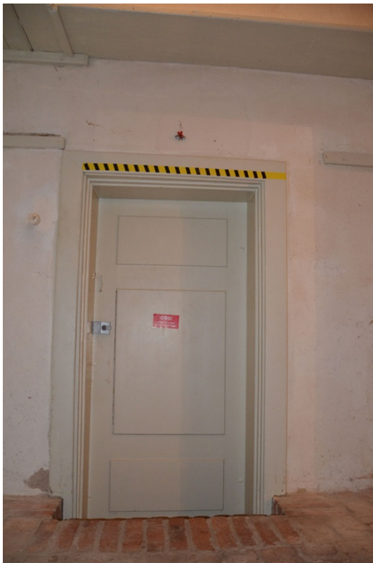
16-19. Fönstret byts ut efter äldre förlaga. Dörr mot 141 som ska sättas igen. Ny dörröppning mellan rum 139 - 142 har tagits upp.
