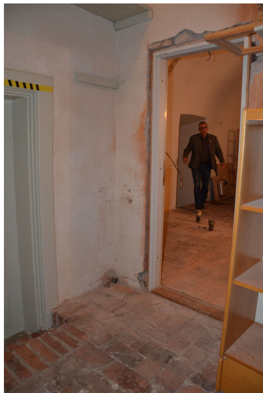
16-19. Fönstret byts ut efter äldre förlaga. Dörr mot 141 som ska sättas igen. Ny dörröppning mellan rum 139 - 142 har tagits upp.
