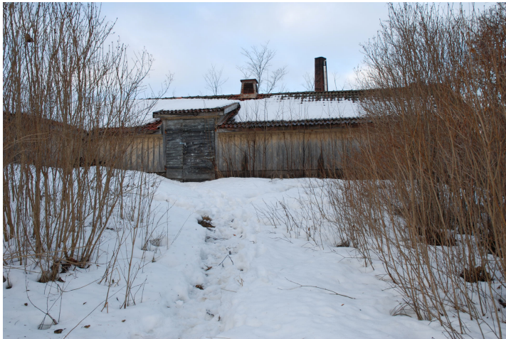
Bild 44. Jordkällaren från söder. Bildnr Vlm_kmvLS-1063
