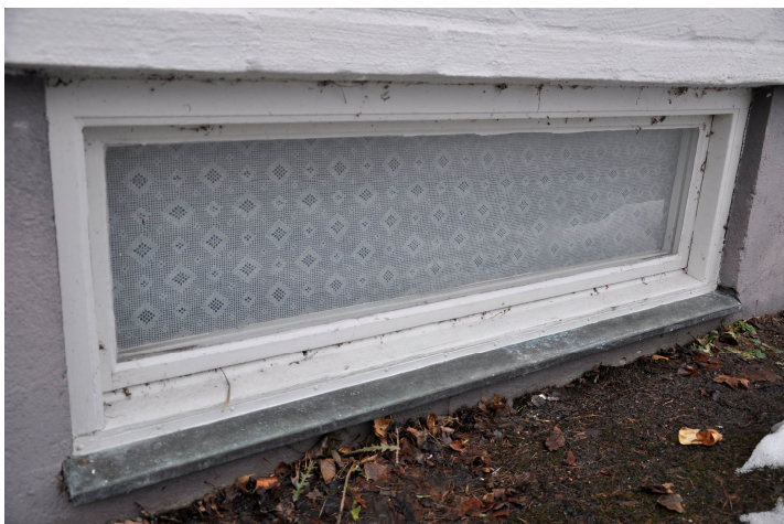
Bild 60. Källarfönster åt söder. Bildnr Vlm_kmvMM-68
