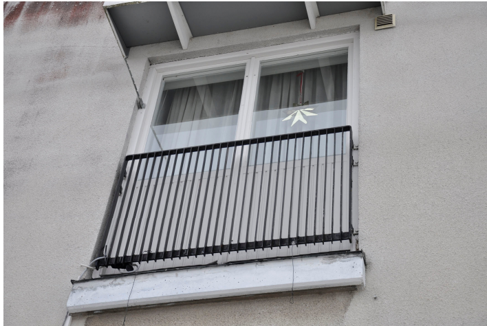
Bild 31. Fransk balkong på nordfasaden. Bildnr Vlm_kmvMM-216
