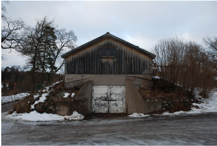
Bild 46. Jordkällaren från söder. Bildnr Vlm_kmvLS-1044
