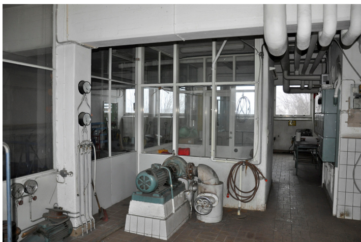
Bild 63. Panncentralen interiör från väster. Bildnr Vlm_kmvMM-96
