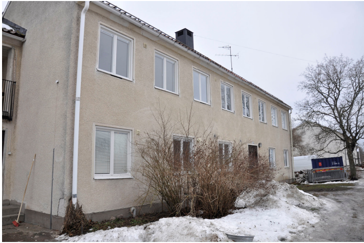
Bild 22. Västra fasaden. Bildnr Vlm_kmvMM-208
