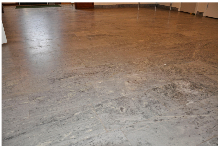
Bild 69. Marmorgolv i entréhallen. Bildnr Vlm_kmvMM-142
