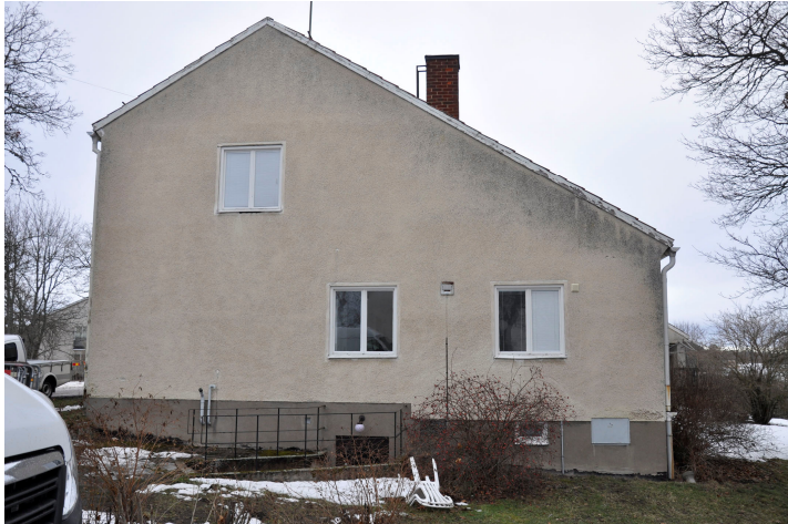
Bild 19. Lönngården, fasad åt söder. Bildnr Vlm_kmvMM-191
