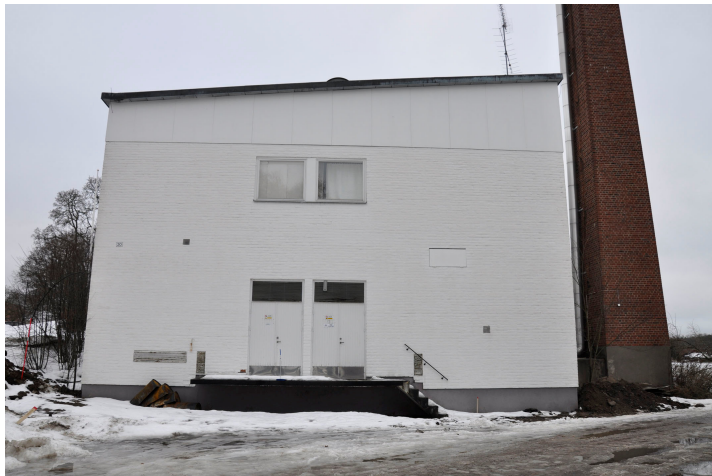
Bild 55. Panncentralen från norr. Bildnr Vlm_kmvMM-119
