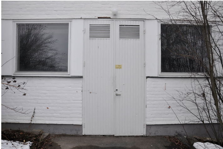
Bild 59. Entré åt öster till maskinrummet. Bildnr Vlm_kmvMM-83
