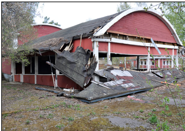
Utomhusteatern. Första bilden visar den kollapsade vingen som utgjort tak för ståplatspublik. Vlm_kmvMM-582. Andra och tredje bilden visar orkesterdiket och en av trapporna som leder in till scenhuset och logerna. Vlm_kmvMM-580 och Vlm_kmvMM-575. Samtliga foton av Maria Mellgren, Västmanlands läns museum.
