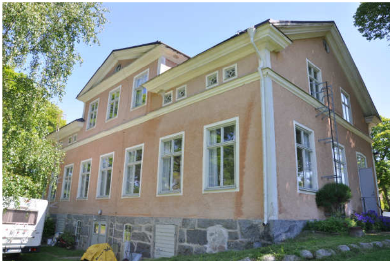
Badelunda kyrkskola innan restaurering. De sönderfrusna stuprörsknäna har lett till missfärgningar i putsen.
