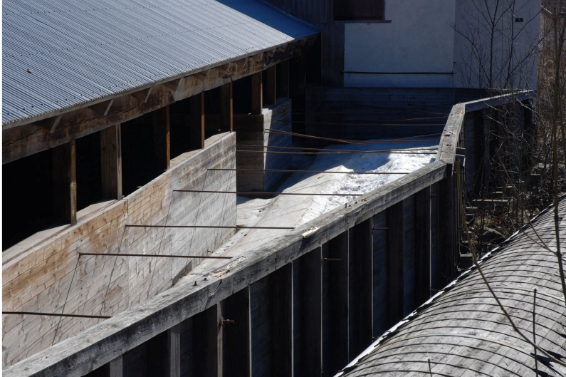
Vlm_kmoLS-1268. Rännan innan åtgärd.
