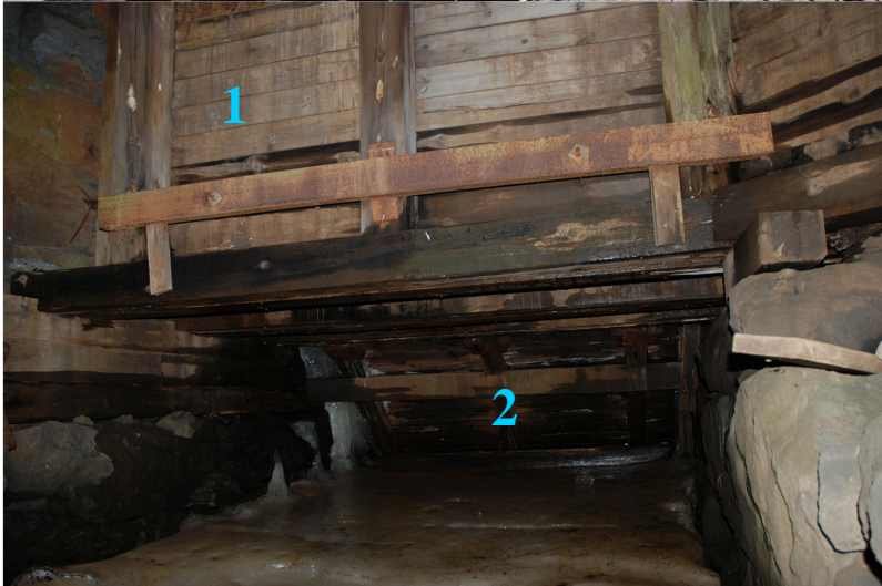
Vlm_kmoLS-1261. 1 anger rännans inplankning i förkammaren framför vattenhjulet. 2 visar skibordets undersida.
