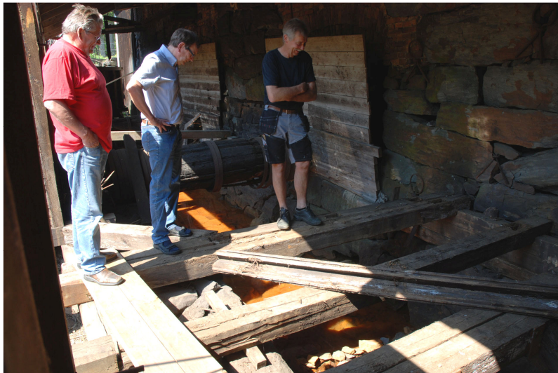
Vlm_kmvLS-1869. Förkammarens inplankning och skulbord är bortplockat. I bild syns från vänster: Stig Andersson från Karmansbo bruksmiljö, Bengt-Åke Andersson från Skinnskattebergs kommun och Mats Arnelid från MA Bygg.
