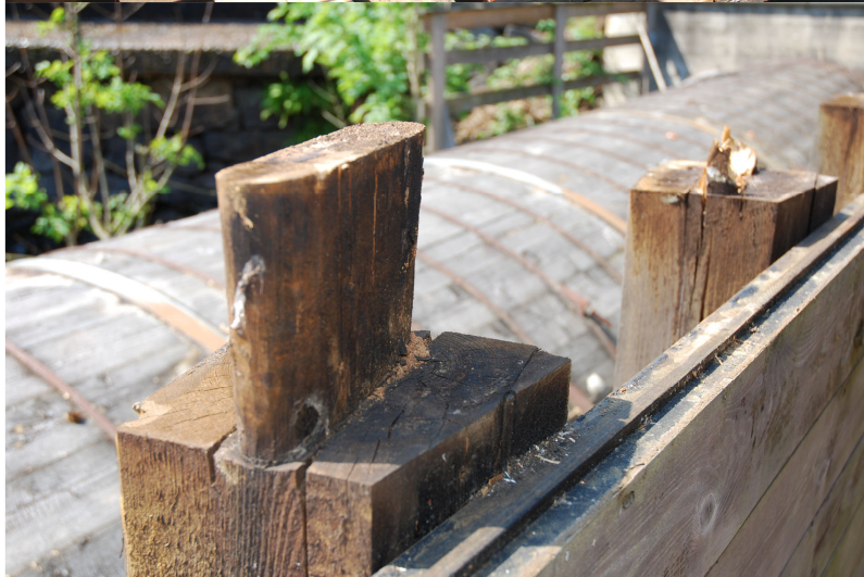
Vlm_kmvLS-1872. Närbild på tapp på stolpe till rännan. Tappen i stolpen bakom har ruttnat bort.
