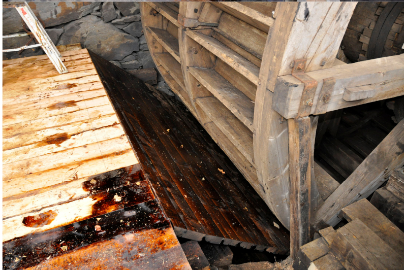
Vlm_kmvLS-2284. Skulbord i rännan och skibordet under hjulet är utbytt.
