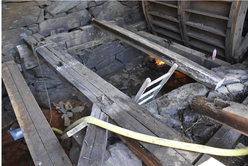
Vlm_kmvLS-2012. Rötskadade delar, mer virke än förväntat behövde bytas.
