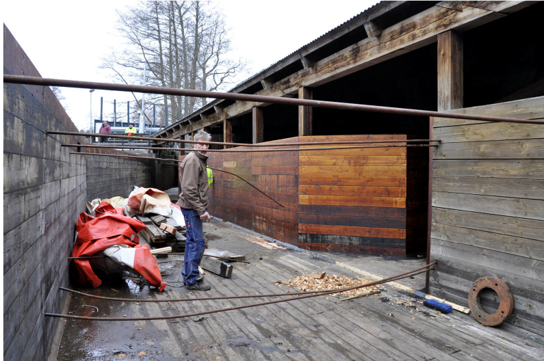
Vlm_kmvLS-2760. Foto innifrån rännan. Samtliga reparationer och tjärning av virke har slutförts. Mats Arnelid från MA Bygg i bild.
