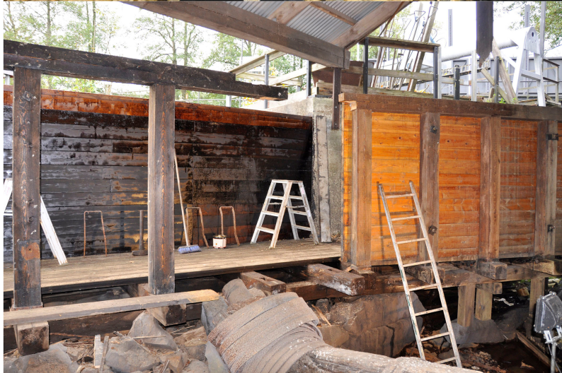
Vlm_kmvLS-2280. Restaurering med byte av stolpar och inplankning i rännan. Virke tjärstryks.
