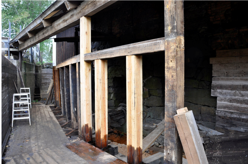
Vlm_kmvLS-2283. Rötskadade stolpar har bytts ut.
