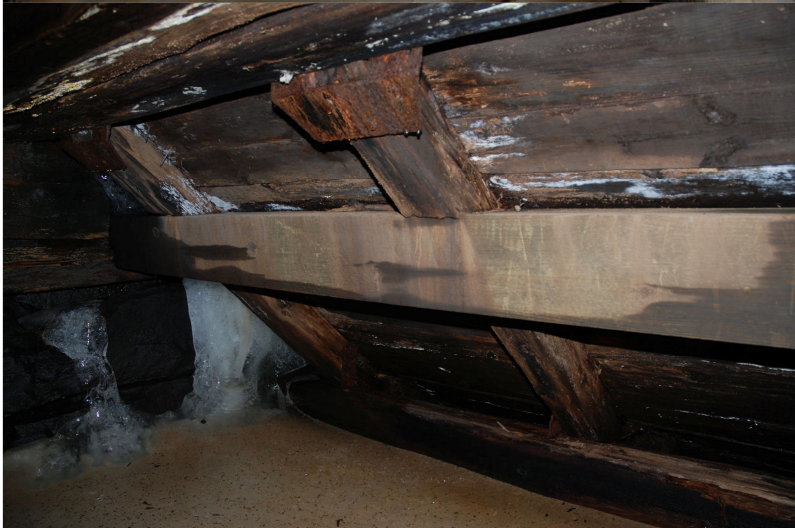
Vlm_kmoLS-1265. Skibordets undersida med rötskador i virket.
