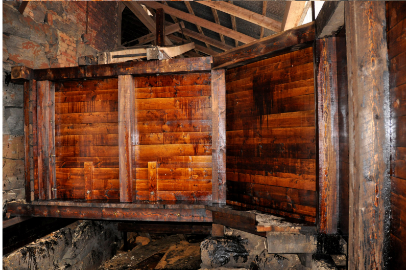
Vlm_kmvLS-2760. Del av rännans och förkammarrens inplankning.
