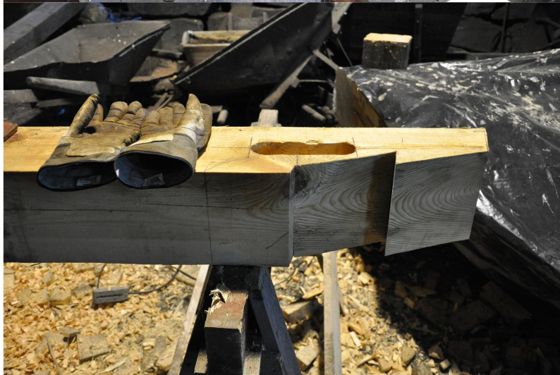
Vlm_kmvLS-2017. Del av ny överliggare med tapphål och blixtskarv.
