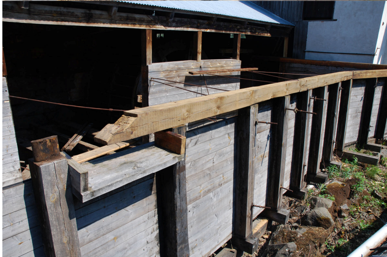
Vlm_kmvLS-1874. Ny överliggare ska monteras. Skarvar utförs med blyxtskarv.
