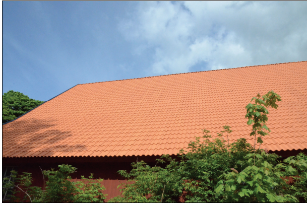
Byggnadens västra takfall efter takläggning. Bildnr Vlm kmvIM-1424 och 1425.
