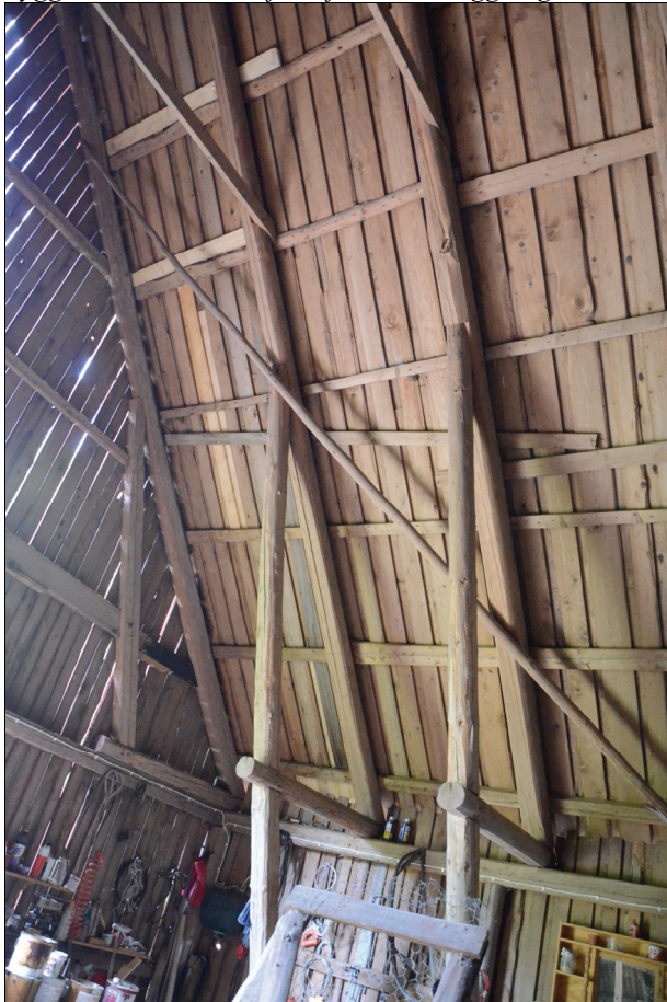
På undertaket gjordes mindre lagningar på de ställen som var rötskadade. Bildnr Vlm kmvIM-1430 och 1431.
