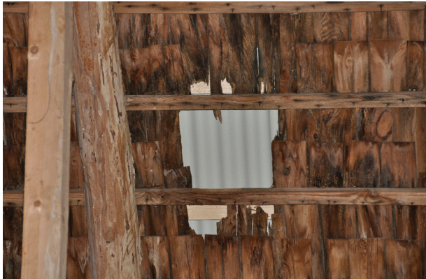
I och med den nya taktäckningen har rötangreppen i undertaket stoppats. Bildnr Vlm_kmvIM-1987 och 1988.
