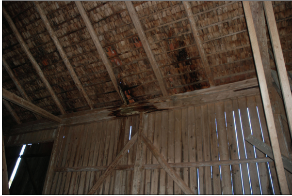
I byggnadens undertak fanns rötskador på grund av en längre tids vattenläckage. Bildnr Vlm_kmvIM-1294 och 1296.
