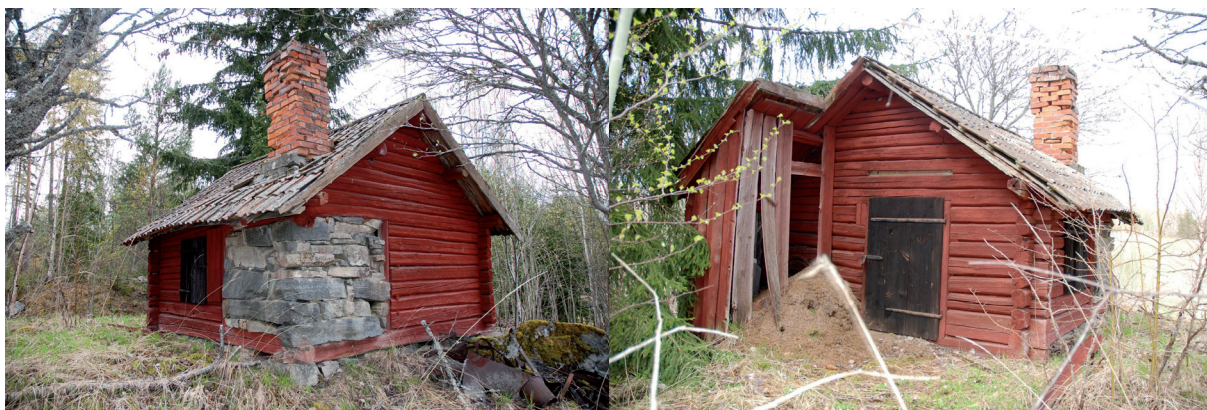
Den naturstensmurade ässjan är synlig i det sydöstra hörnet. Taket var i dåligt skick och läckte in vatten. Vlm_kmvLS_111
