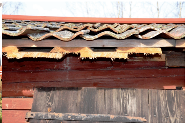
Det nya undertaksbrädorna var inte vattenhyvlade som de tidigare. Vlm_kmvFE-2026
