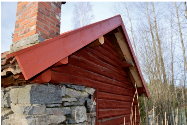
Vindskivor och täckbräda av trä sattes på. Dessa målades röda.
