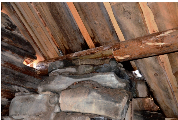
Reparationer skedde även i takåsarna.
