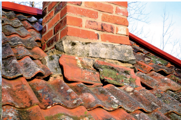
Skorstenen hade murats om och ska kläs in med plåt.
