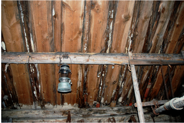
Undertaket hade skadats av vattenläckaget. Vlm_kmvLS_110
