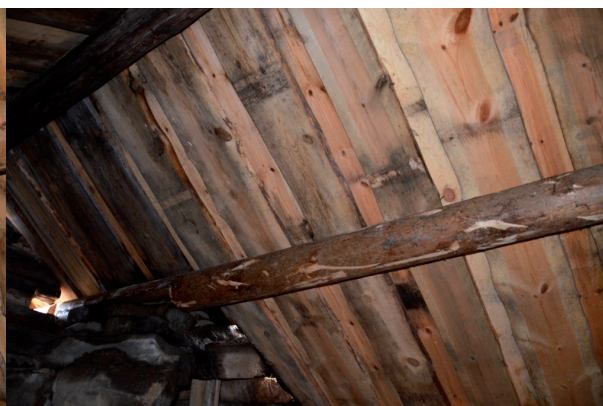
I stort sett hela undertaket har bytts ut mot nytt virke.
