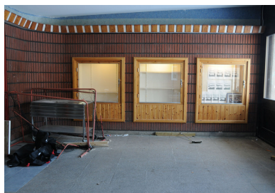
Vägg i entré. Tidigare exteriör, numer inbyggt. Vlm_kmvAB-051
