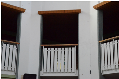
Pelare med mosaikklädda sidor i hallen. Vlm_kmvLS-2502
