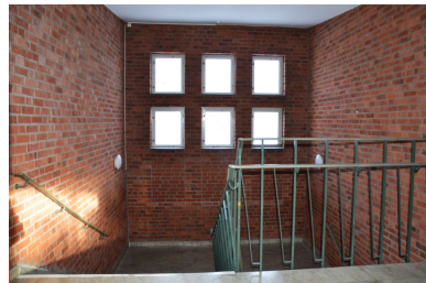
Trapphus i hallbyggnaden Vlm_kmvLS-2514
