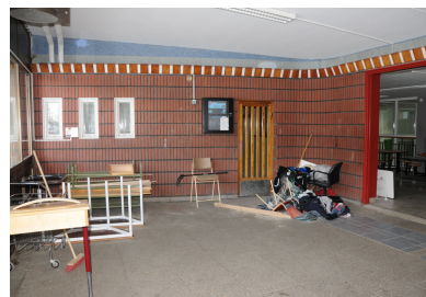
Vägg i entré. Tidigare exteriör, numer inbyggt. Vlm_kmvAB-050
