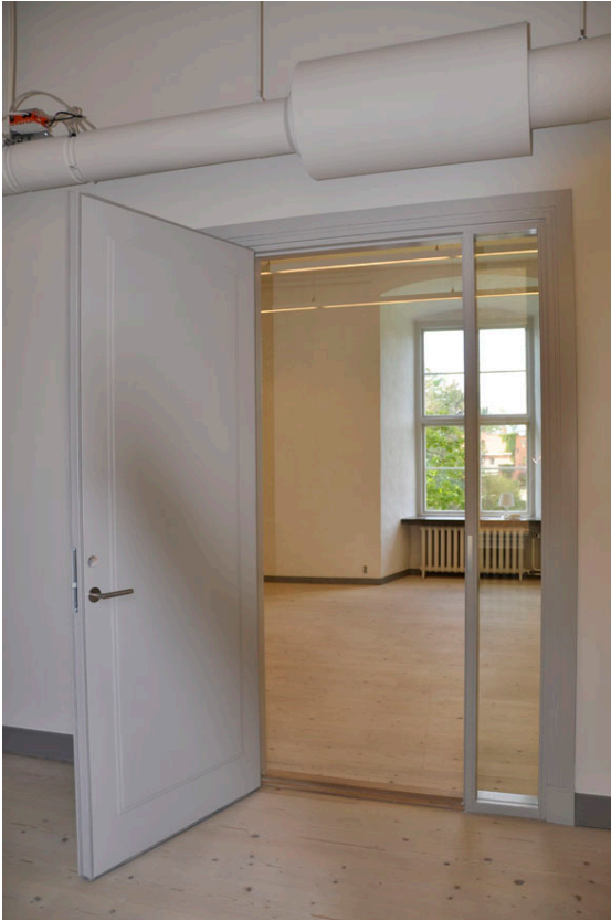
99 – 101. Rum 223 B efter renoveringen. Ventilation har monterats på den nyuppförda väggen.
