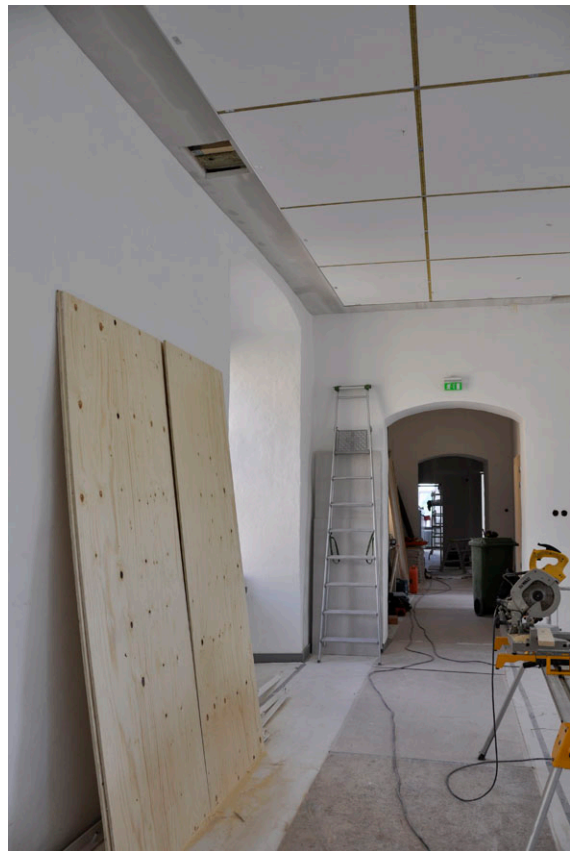
118 - 123. Rum 224, nytt akustisktak monteras.
