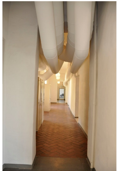
51–59. I hålrummet i rum 208, som är en del av loftet i 203, installerade ventilationsanläggningen. Ventilationsrören lades utanpå för att minska håltakning i murverket.
