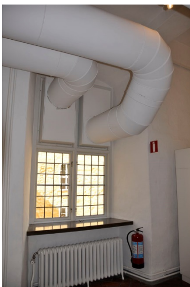
60 – 68. Ventilationsdragnig i gängen. Luft tas från ett fönster där ett ventilationsgaller placerats.
