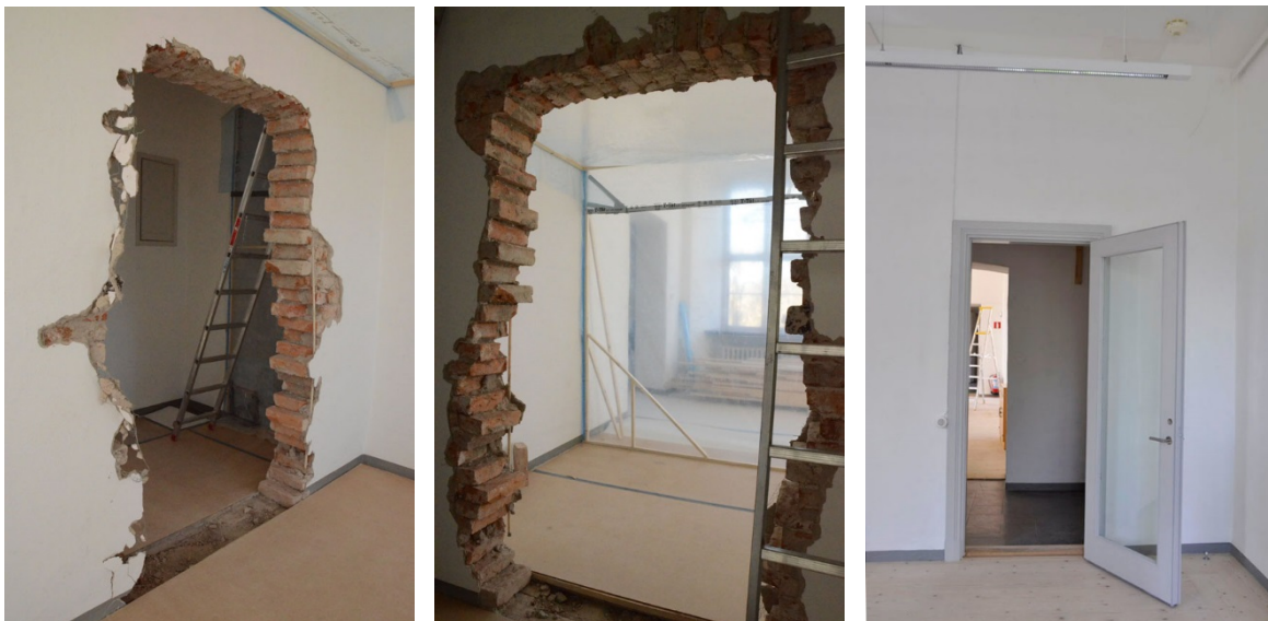
9-11. Ett äldre igensatt dörrhål öppnades upp och en ny dörr sattes in.
