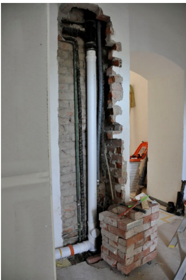
84 – 92. Rum 225 delas i tre delar. Överst: ny vägg och dörrpari. I mitten fläktrummet där luft tas från fönster. Toaletter installeras och rör friläggs inför ledningsdragning.
