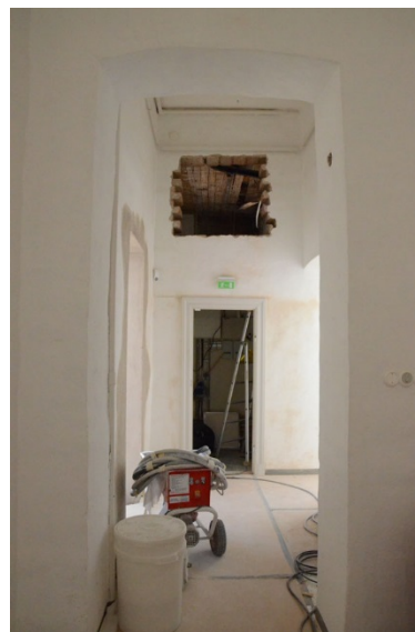
45-50. Gången innan reoveringen. Håltagning i murverk över rum 208 för ventilationsrören.
