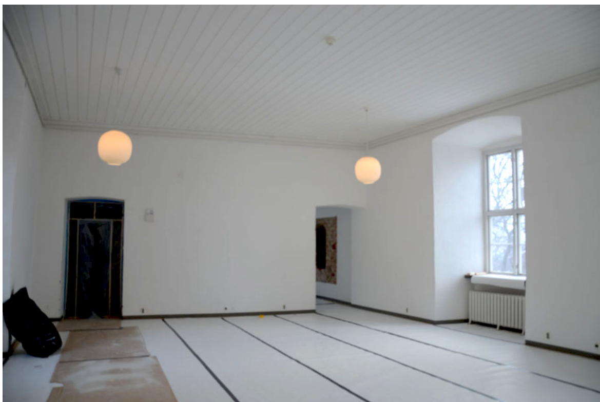
72. Rum 202 innan renoveringen. Portalen t.v. är täckt på grund av rivningsarbete.
