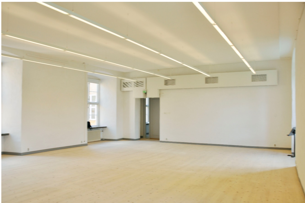
125. Rum 224 mot söder, ny ventilation och nytt akustiktak samt ny belysning.
