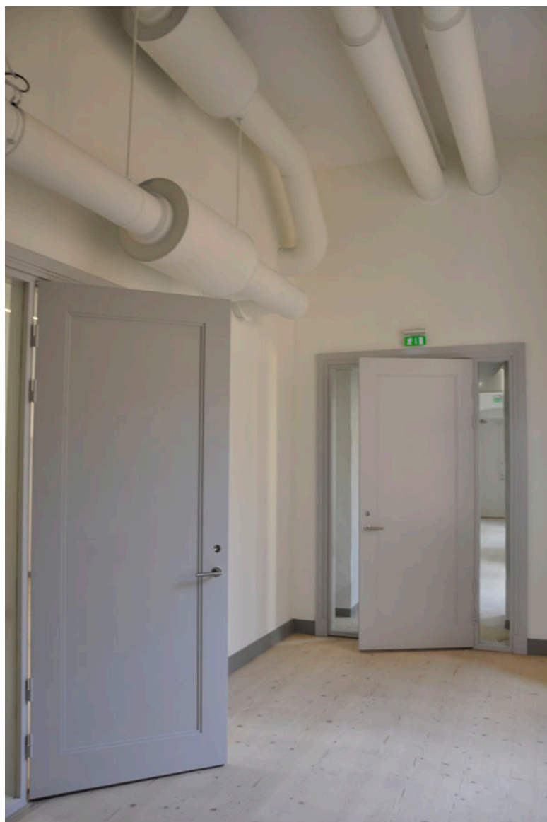
105 - 110. Passagen i rum 223. Utanpåliggande ventilationskanaler förutom mot rum 224 där ett murgenombrott skett för genomföring. Äldre dörrparit från år 2000 har ersatts med en ny.
