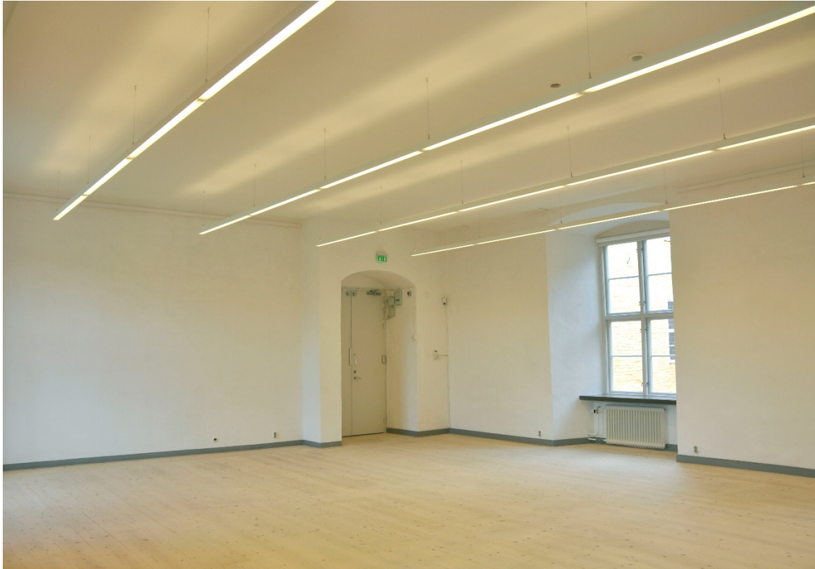
126. Rum 224 mot norr, ny ventilation och nytt akustiktak samt ny belysning.
