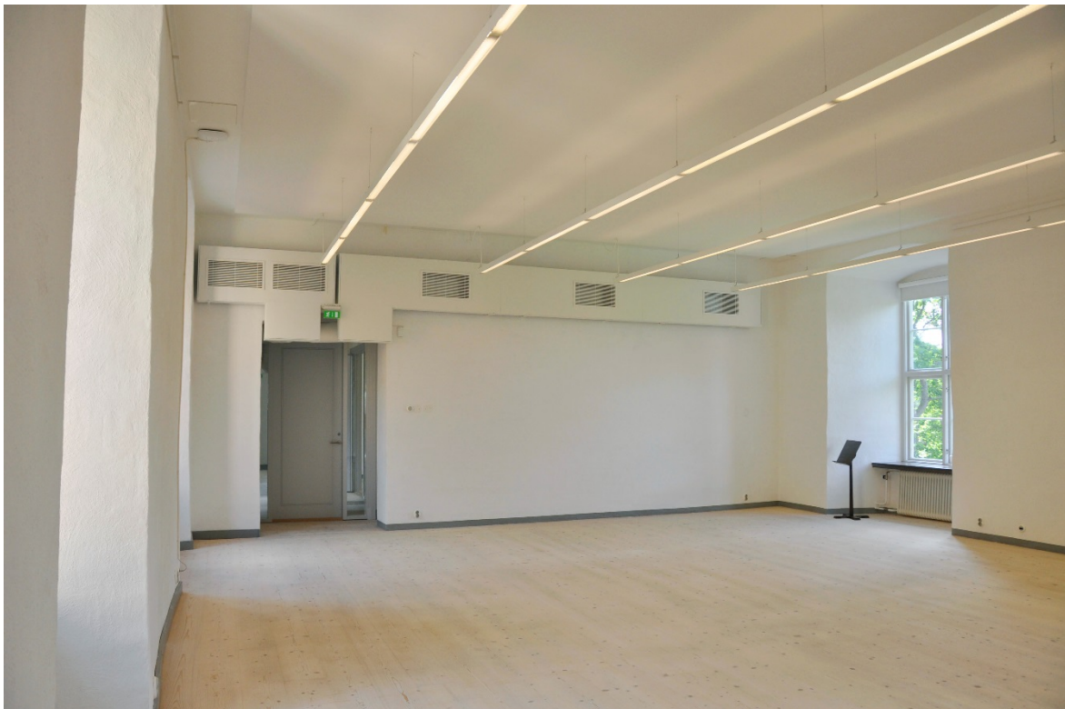
124. Rum 224, mot sydväst, ny ventilation och nytt akustiktak samt ny belysning.
