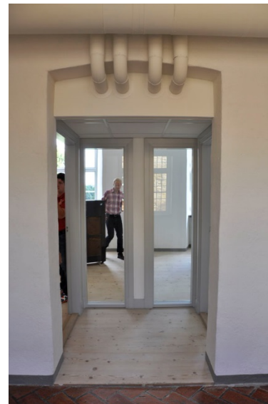
26–34. Rummen under ombyggnationen. Dörrnischerna mellan de olika rummen byggs igen för att få separat ljudsäkra rum. En ventilations och ljudkub byggs vid rummets entréer. Ny vägg i rum 205.
