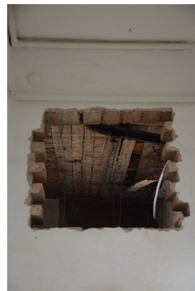
45-50. Gången innan reoveringen. Håltagning i murverk över rum 208 för ventilationsrören.
