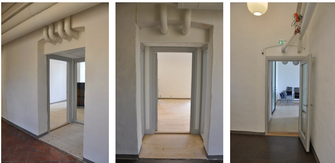
69 – 71. Ventilationsdragningen in till övningsrummen.
