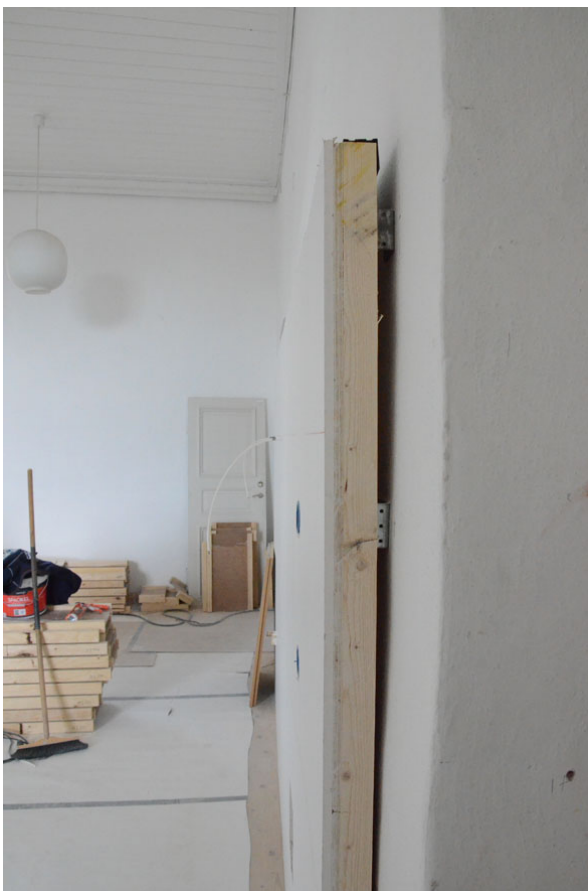
73– 79. Rum 202 under och efter renoveringen. Ett pentry monterades på en fristående skiva för att minska borrhål. Det äldre brädtaket är bevarat. Portalen t.h. har satts igen med ett ventilationsgaller.
