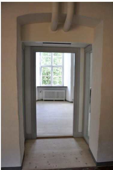
26–34. Rummen under ombyggnationen. Dörrnischerna mellan de olika rummen byggs igen för att få separat ljudsäkra rum. En ventilations och ljudkub byggs vid rummets entréer. Ny vägg i rum 205.
