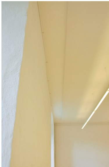
127-129. Rum 224, det nya akustiktaket och det nya dörrpartiet. Ventilationen är fäst på väggen.
