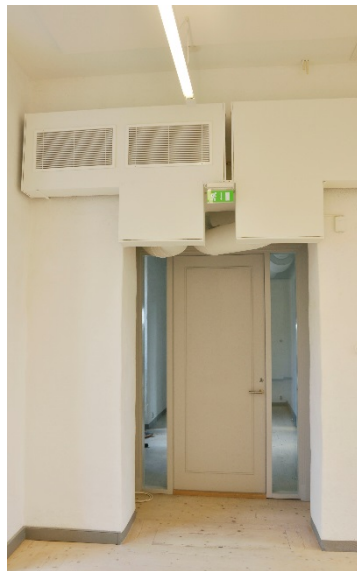
127-129. Rum 224, det nya akustiktaket och det nya dörrpartiet. Ventilationen är fäst på väggen.
