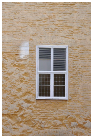
60 – 68. Ventilationsdragnig i gängen. Luft tas från ett fönster där ett ventilationsgaller placerats.
