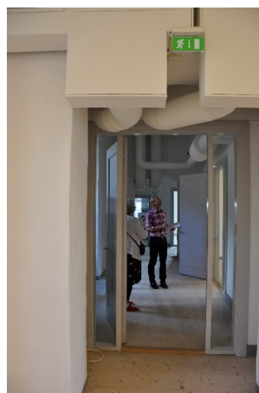
105 - 110. Passagen i rum 223. Utanpåliggande ventilationskanaler förutom mot rum 224 där ett murgenombrott skett för genomföring. Äldre dörrparit från år 2000 har ersatts med en ny.
