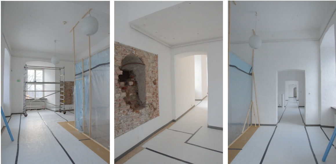
6 - 8. Rum 203 under ombyggnationen. Passagen till rum 202 och 205 sätts igen.
