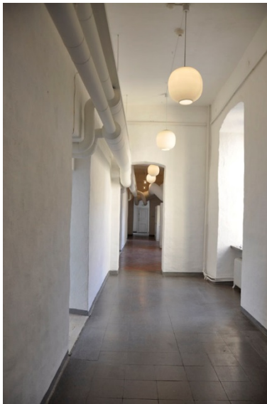
51–59. I hålrummet i rum 208, som är en del av loftet i 203, installerade ventilationsanläggningen. Ventilationsrören lades utanpå för att minska håltakning i murverket.
