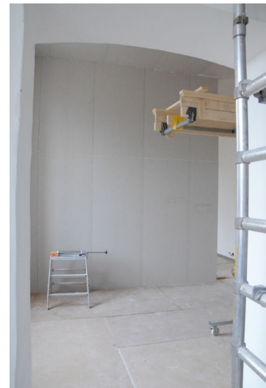
26–34. Rummen under ombyggnationen. Dörrnischerna mellan de olika rummen byggs igen för att få separat ljudsäkra rum. En ventilations och ljudkub byggs vid rummets entréer. Ny vägg i rum 205.
