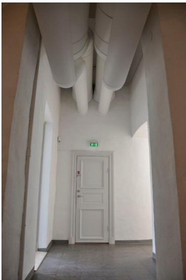
51–59. I hålrummet i rum 208, som är en del av loftet i 203, installerade ventilationsanläggningen. Ventilationsrören lades utanpå för att minska håltakning i murverket.
