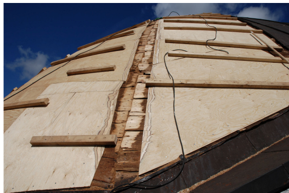
Ojämnheter i kortaket har åtgärdats genom att "åsarna" hyolats ner och "dalarna" utsalades med 6 mm boardskiivor. Vlm_kmvLS-1754
