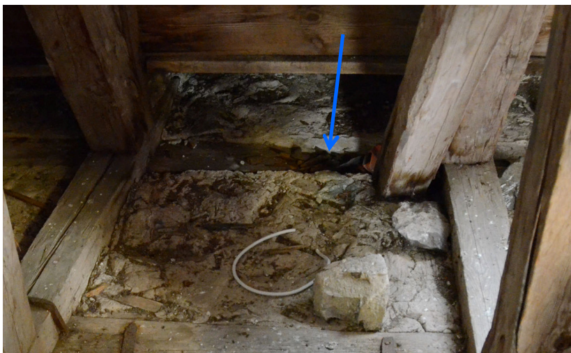
Pilen markerar rötskadat hammarband i tornet. Vlm_kmvAA-298
