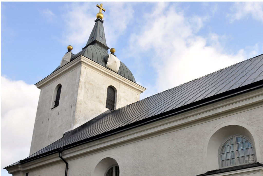
Takfoten efter infärgning och putskomplettering. Vlm_kmoLS-2233
