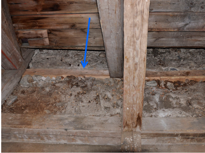
Nytt bilat timmer har lagats i hinnerbandet. Vlm_kmoLS-2417 Timmerhakar återanvändes. Vlm_kmoLS-2415
