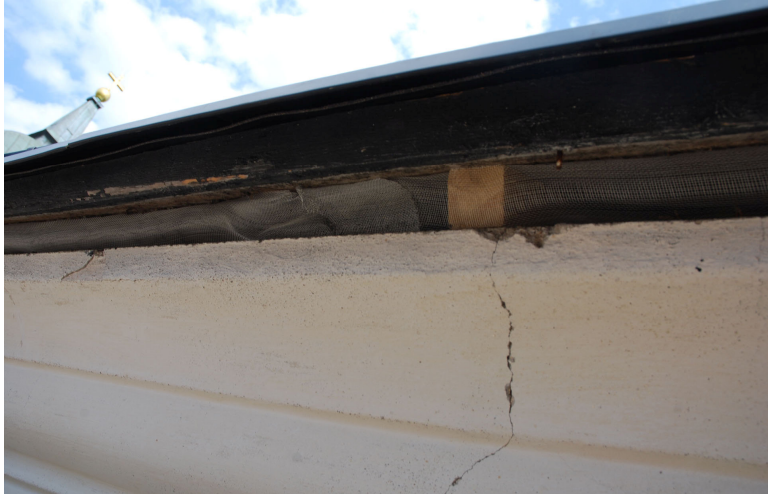
Takstolarna försågs med kilar så att en springa uppstår mellan takpanel och den putsade takfoten. Bilden är tagen innan kilarnas ändträ färgades. Vlm_kmoLS-1857
