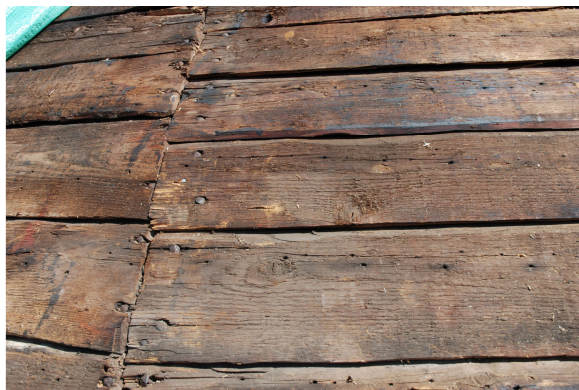
Takpanelen utgörs av ett bräddtak av ramsågat virke i varierande bredder. De är avfasade med yxa och ligger på så vis lite omlott. Vlm_kmvLS-1755
