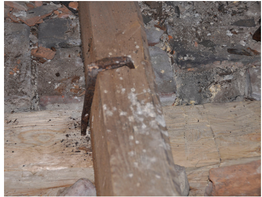
Nytt bilat timmer har lagats i hinnerbandet. Vlm_kmoLS-2417 Timmerhakar återanvändes. Vlm_kmoLS-2415
