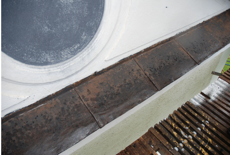
Plåtaotäckning i korets fronton som skrapats från färg. Vlm_kmvLS-2011
