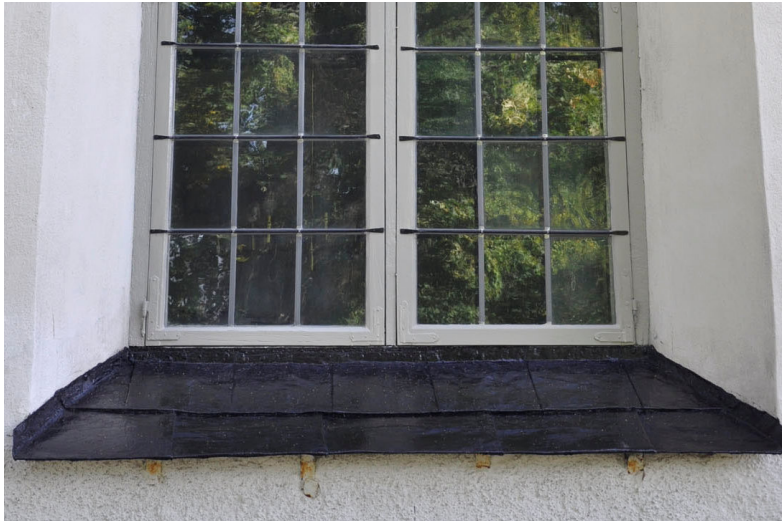
Solbänk efter skrapning, rostskyddsbehandling och målning. Vlm_kmvLS-2183.
