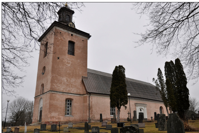
Kila kyrka i april 2011, före fasadrestaurering. Bildnr: Vlm_kmvMM-358.
