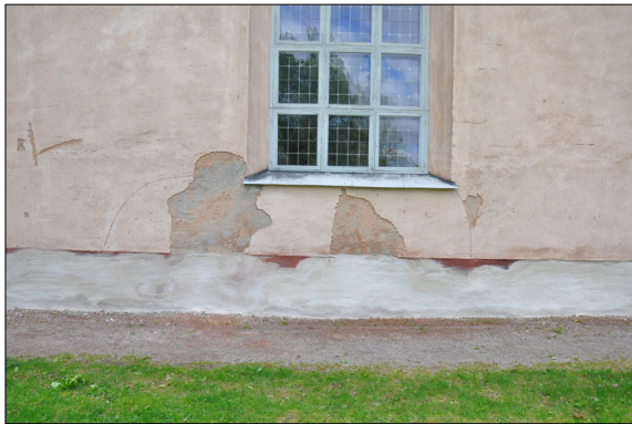
Putsskada vid fönster. Bildnr Vlm_kmvMM-706
