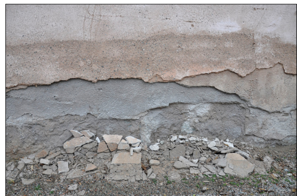
Flera olika putslager fanns på kyrkans fasader. Bildnr Vlm_kmvMM-357
