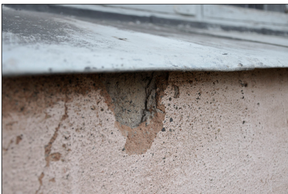
Detalj av putsskada under fönsterbleck. Bildnr Vlm_kmvMM-370
