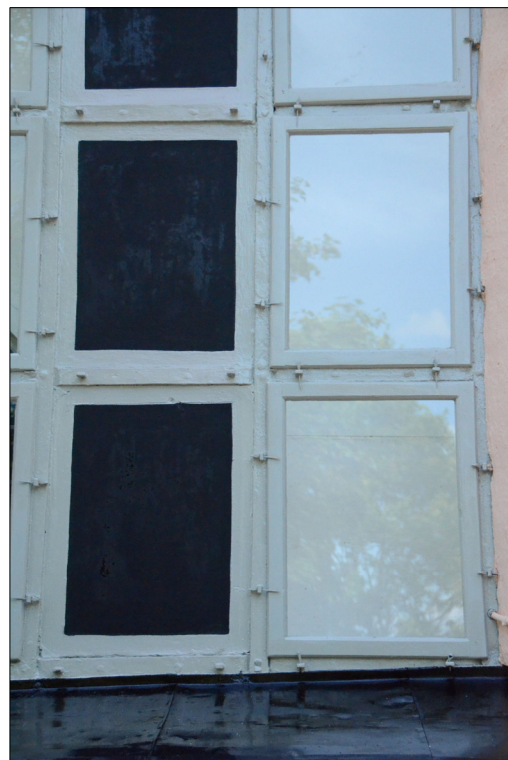
Detalj av fönster med blindering och hästkosöm. Bildnr Vlm_kmvAA-350.
