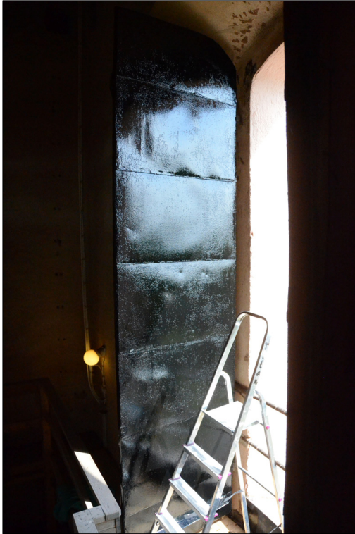
En av kyrkans ljudluckor efter lagning och målning. Bildnr Vlm_kmvAA-324.
