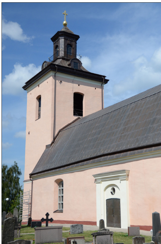
Del av kyrkans södra fasad efter restaurering. Foto: Anna Ahlberg, VLM. Bildnr Vlm_kmvAA-338.
