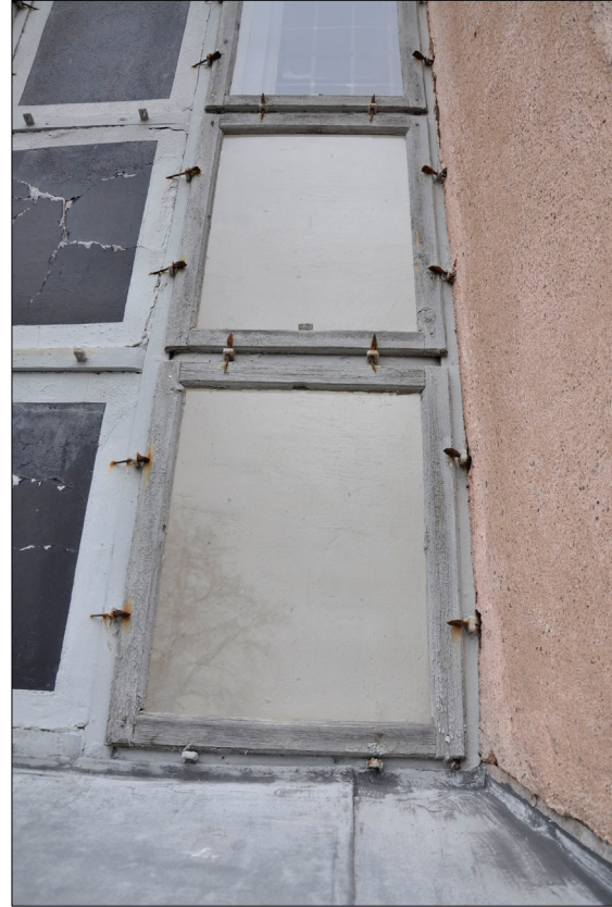
På fönsterbågarna flagnade färgen och hästkosömmen hade rostet. Bildnr Vlm_kmvMM-390.
