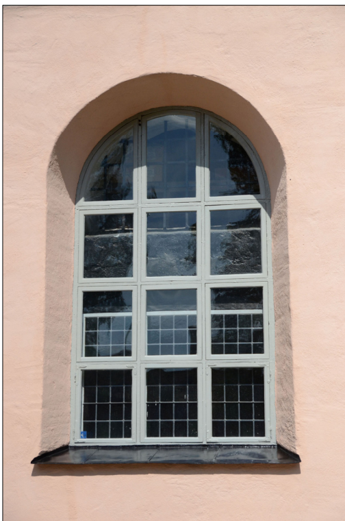
Restaurerat fönster med nymålat fönsterbleck Bildnr Vlm_kmvAA- 339.
