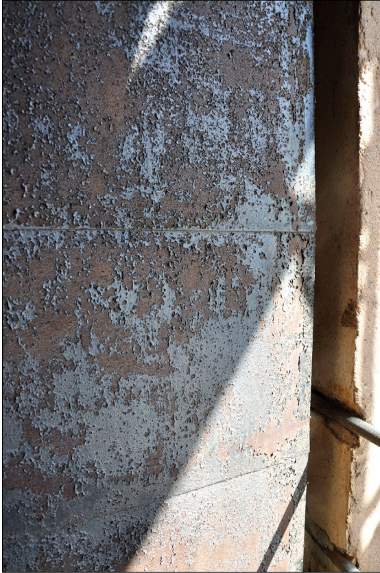
Färgen flagnade på ljudluckorna och de var rostanfrätta. Bildnr Vlm_kmvMM-659.
