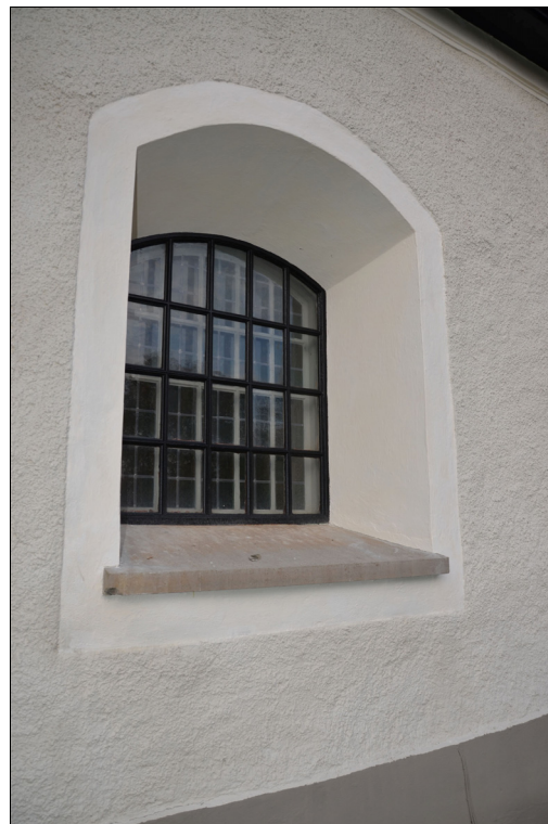
Gjutjärnsfönstren rostskyddsbehandlades och målades svart. Bildnr Vlm_kmvMM-1014 och 1021.
