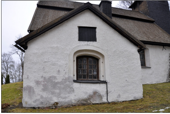
På kyrkfasaden fanns puts-skador på grund av saltutfällning. Bildnr Vlm_kmvMM-324.
