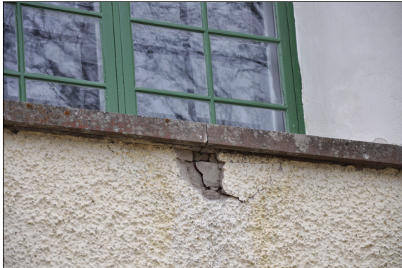
På grund av sprickor i solbänkarna hade putsen under sprängts loss. Bildnr Vlm_kmvMM-337.
