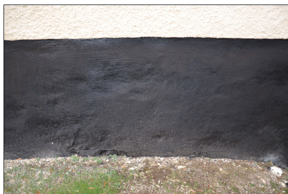
Sockeln efter målning med asfalttjära. Bildnr Vlm_kmvMM-990.
