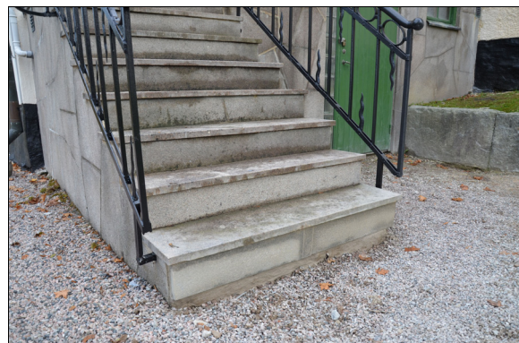
Trappan efter restaurering. Bildnr Vlm_kmoMM-983.
