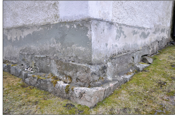
Kyrkans sockel med flagnad puts och färg. Bildnr Vlm_kmøMM-288.
