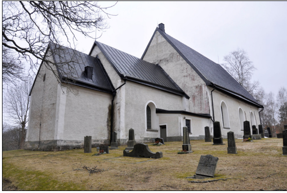
Kyrkan före restaurering. Putsen var missfärgad på grund av alg- och mosspåväxt. Bildnr Vlm_kmøMM-316.
