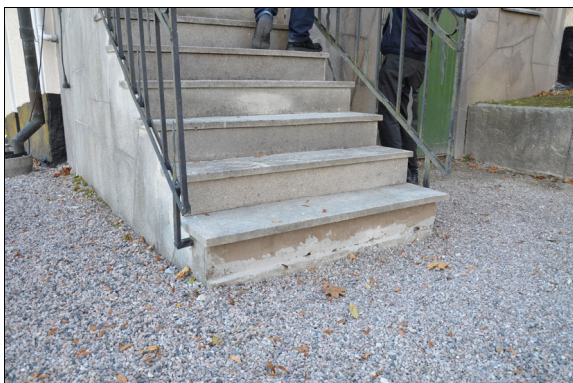
Trappan under restaurering. Det nedersta trappsteget är justerat. Bildnr Vlm_kmoMM-973.
