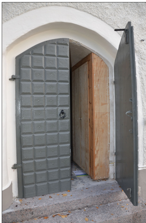
Kyrkans portar tvättades, skrapades och målades med linoljefärg. Bildnr Vlm_kmvMM-1013 och 1033.
