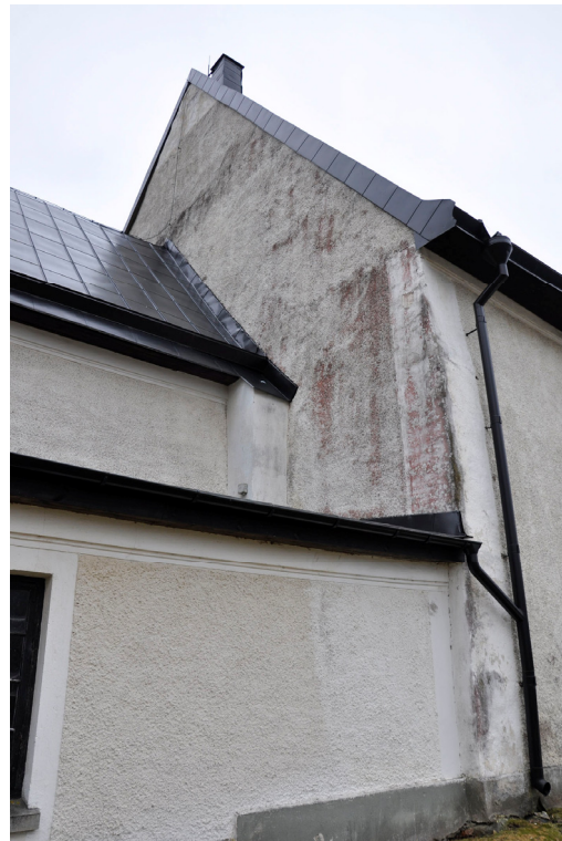
Röda alger växer gärna på puts med cementinblandning. Bildnr Vlm_kmøMM-291.
