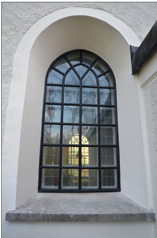
Gjutjärnsfönstren rostskyddsbehandlades och målades svart. Bildnr Vlm_kmvMM-1014 och 1021.
