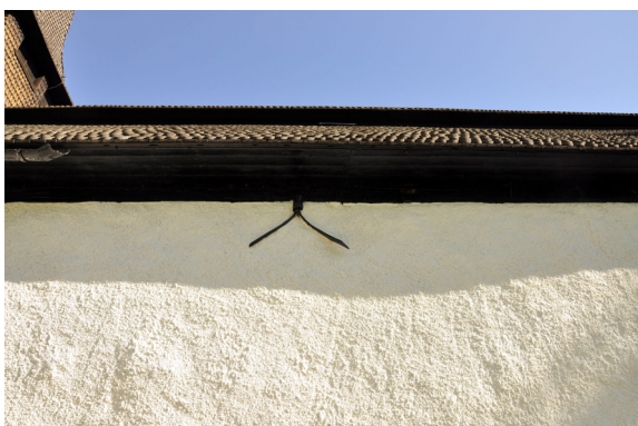
Detalj av takfoten. Takfot, hammarband och vindskivor tjärades. Bildnr Vlm_kmvMM-818.
