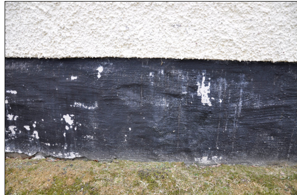
På den asfaltstrukna sockeln fanns viss färgbortfall. Bildnr Vlm_kmvMM-338.
