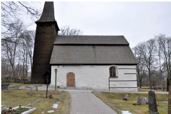
Kungs Barkarö kyrka före restaurering med svarta hörnjärn. Bildnr Vlm_kmvMM-319.
