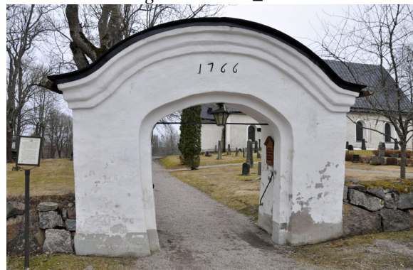
Äldre putsskador har lagats partiellt. Vlm_kmøMM-283.
