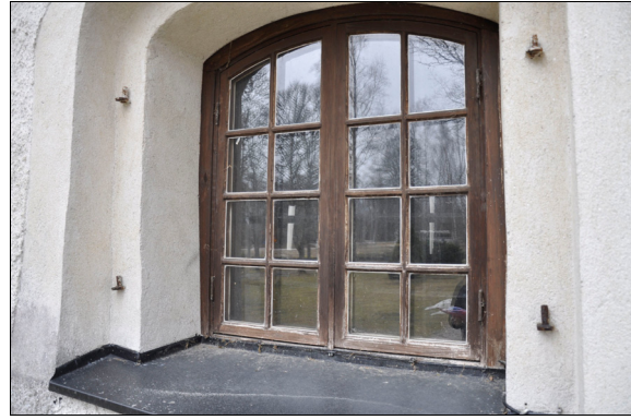
Fönsterbåge med i det närmaste bortbränd färg. Bildnr Vlm_kmvMM-325.
