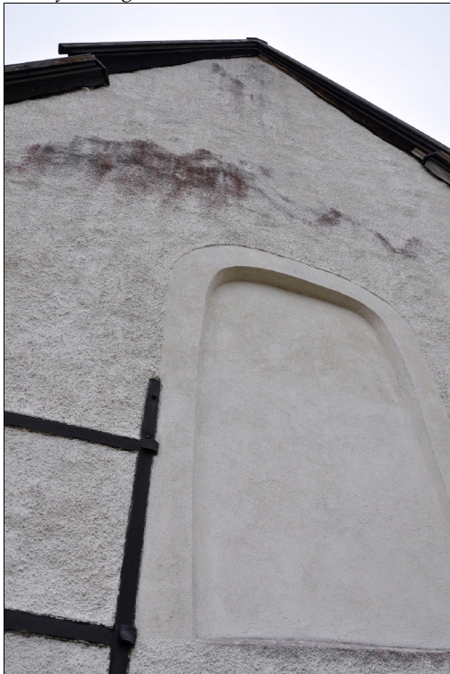
Fasaden var missfärgad av algpåväxt. Bildnr Vlm_kmvMM-332.
