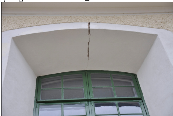
I samtliga fönsterbågar fanns sprickor. Bildnr Vlm_kmvMM-340.
