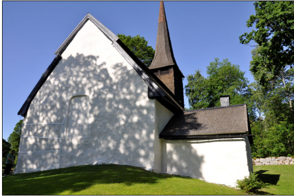
Kyrkans östra fasad efter resaturering. Bildnr Vlm_kmvMM-826.
