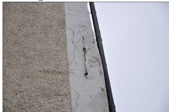
Både färg och puts flagnade på de släta omfattningarna. Bildnr Vlm_kmvMM-342.
