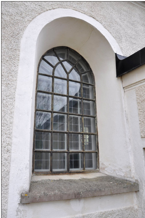
Fönstren var i stort behov av målning. Bildnr Vlm_kmøMM-289.
