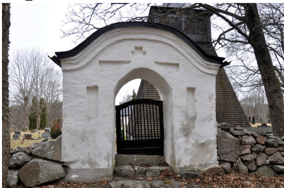
Puts- och färgbortfall på den ena stigluckan. Bildnr Vlm_kmøMM-312.
