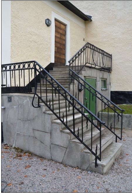
T h: Hela trappan efter restaurering. Trappfasaden är lagad, trappsteg och trapplan har justerats och räcket målat. Bildnr Vlm_kmvMM-986.
