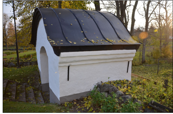
Smidesdetaljer i putsen målades med Isotrol och Isoguard Pansar. Bildnr Vlm_kmvMM-1057.
