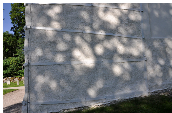
Hörnjärnen målades vita för att smälta in i putsen. Före restaureringen var de svarta. Bildnr Vlm_kmvMM-840.
