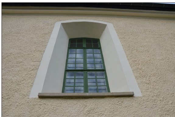
Fönstrets stickbåge renoverades långsiktigt med ekkilar för att problemet inte ska återkomma. Bildnr Vlm_kmvMM-993.
