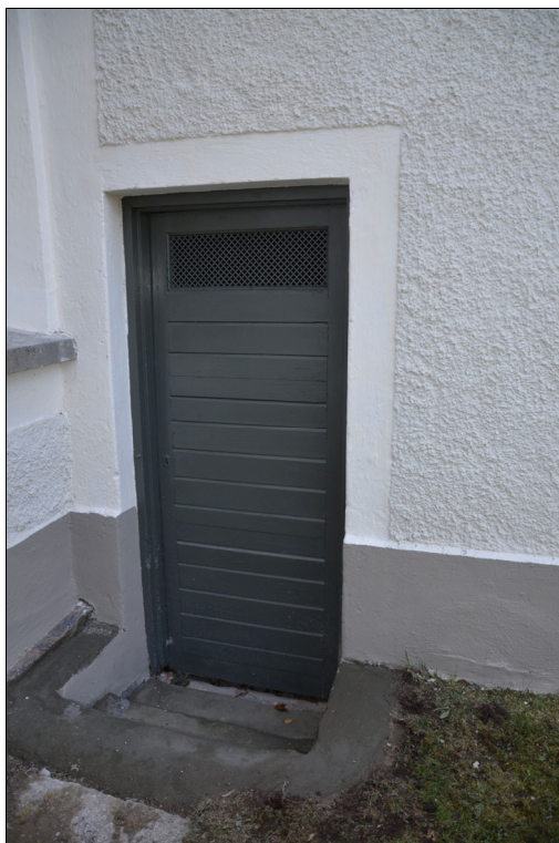
Kyrkans portar tvättades, skrapades och målades med linoljefärg. Bildnr Vlm_kmvMM-1013 och 1033.
