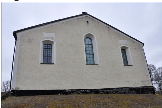
Putsen var missfärgad av alger. Bildnr Vlm_kmvMM-348.
