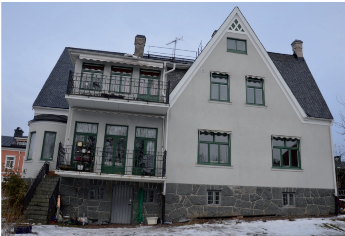
Översiktsbild över bostadshuset på Pamela 1 innan åtgärder. Vlm_kmvFE-2503
