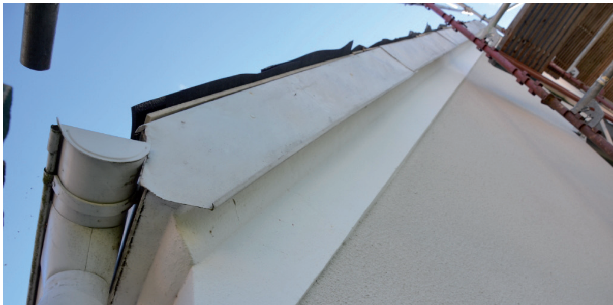
Vindskivor av plåt innan åtgärder Vlm_kmvFE-1741
