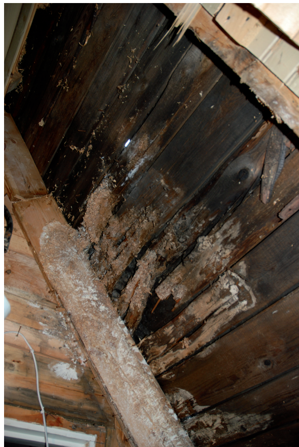
Taket hade omfattande skador på grund av vattenläckage, på vissa ställen var det hål rakt genom taket. Foton ovanifrån: Vlm_kmvFE-630, Vlm_kmvFE-622, Vlm_kmvFE-627.
