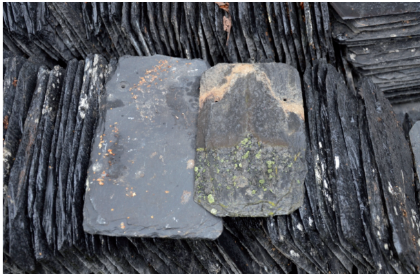
Komplettering av nytt skiffer gjordes med lite större plattor än befintligt (till vänster i bild). Vlm_kmvFE-2006.
