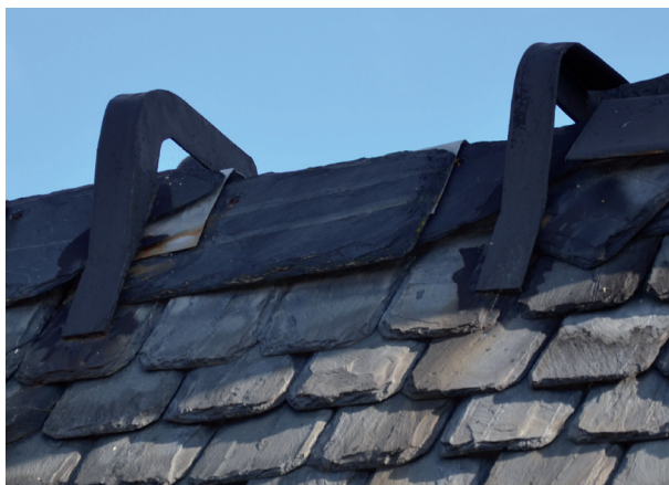
Sotarbryggans montering innan åtgärder. Vlm_kmvFE-1744
