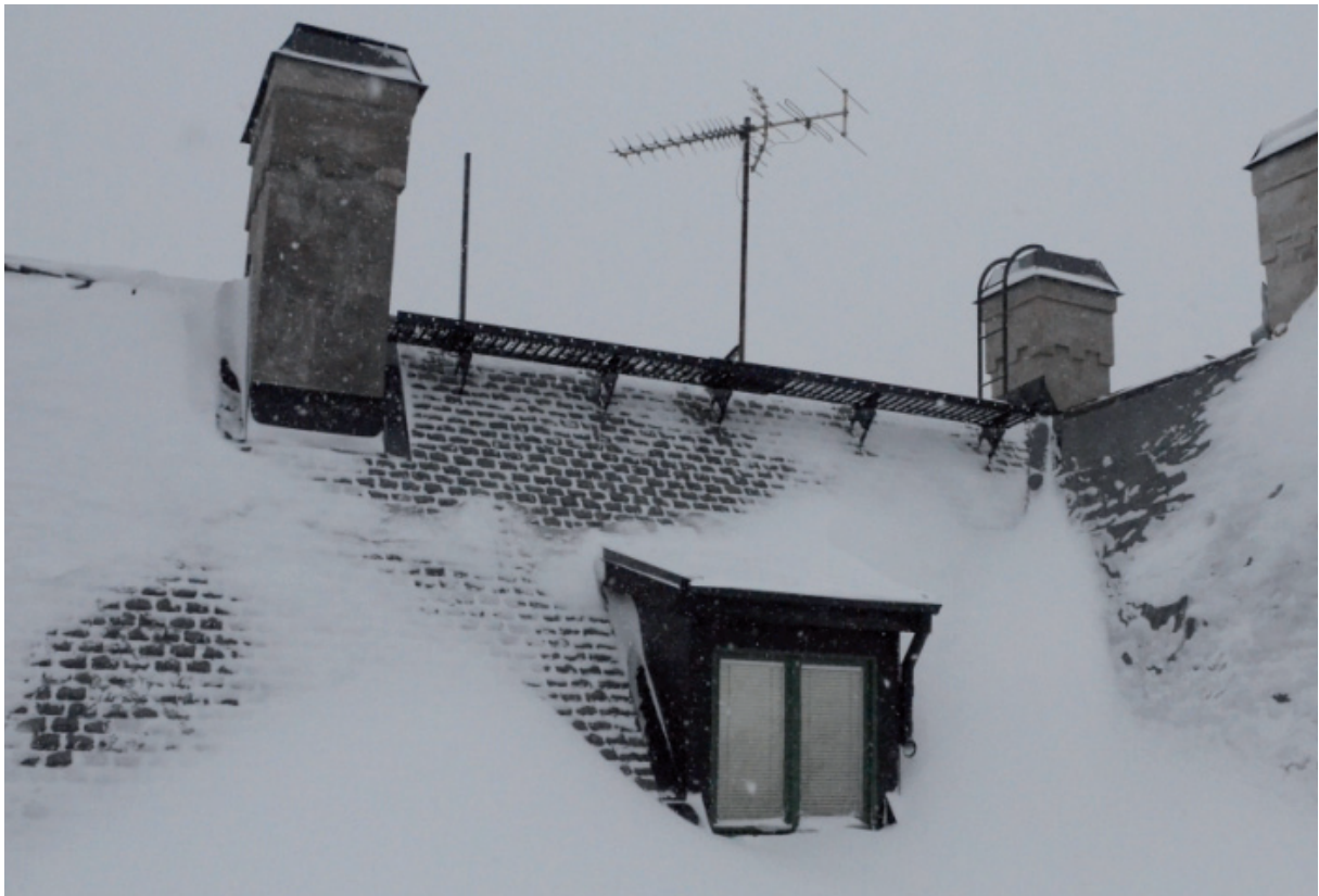
Den nya sotarbryggan monterades fast i undertaket för bättre stabilitet och mindre belastning på skiffret. Vlm_kmvFE-2304.
