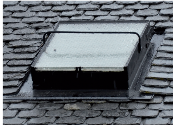
Kupan monterades bort, åtgärdades och sattes sedan tillbaka i taket. Vlm_kmvFE-2010
