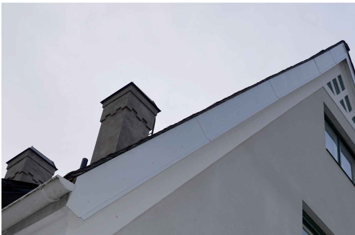
De nya vindskivorna av plåt monterades likt befintligt. Vlm_kmvFE-1747.
