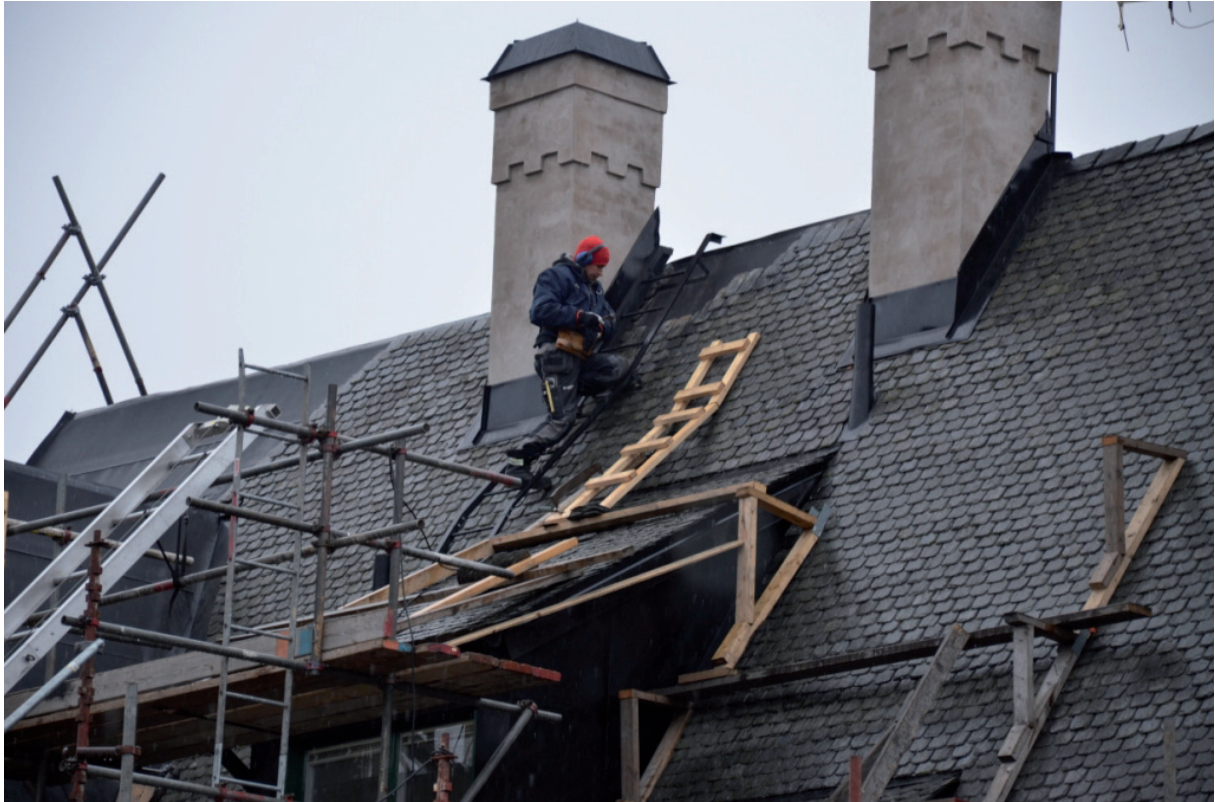
Taket under pågående arbete. Vlm_kmvFE-2005.
