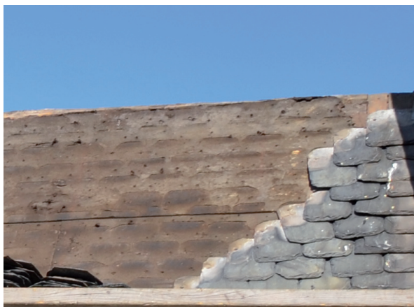
Taket innan åtgärder med den gamla boarden kvar. Vlm_kmvFE-1747
