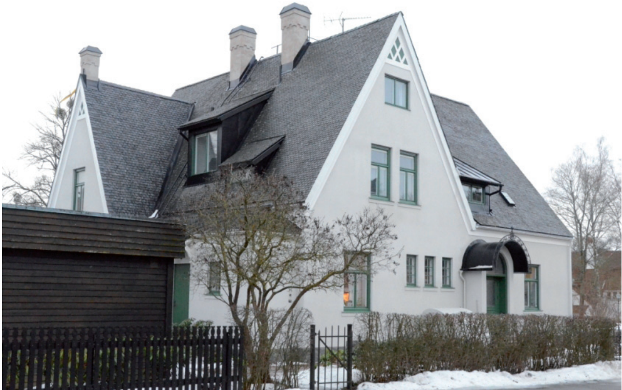
Taket efter genomförda åtgärder. Vlm_kmvFE-2515
