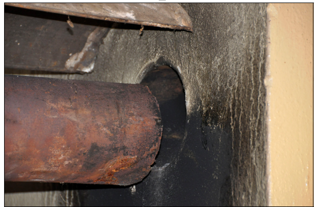
Före åtgärder sänkades ett stag närmare murstocken och rökröret kunde glida ur murstocken. Bildnr Vlm_kmvIM-2608 och 2535.
