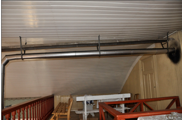
Det nya rökröret ovanför läktaren. Det nya staget syns längst till höger. Bildnr Vlm_kmvIM-2627.
