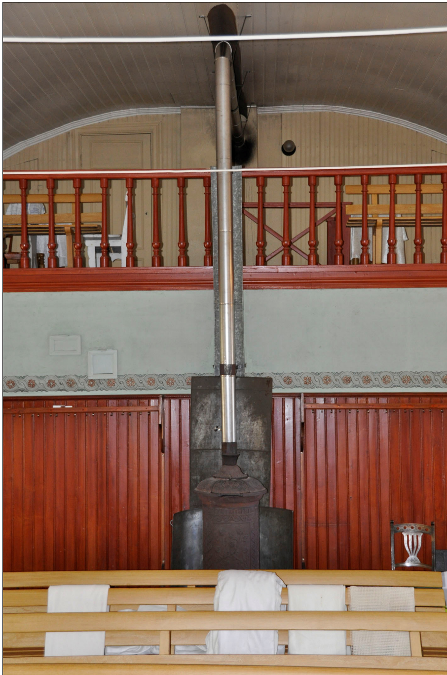
Kaminen med det nya rökröret. Bildnr Vlm_kmoIM-2643.
