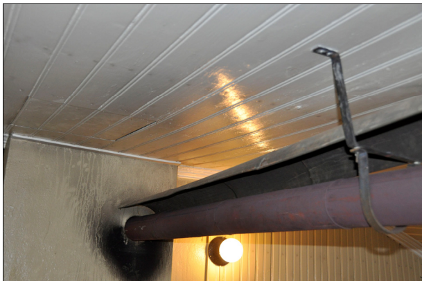
Före åtgärder sänkades ett stag närmare murstocken och rökröret kunde glida ur murstocken. Bildnr Vlm_kmvIM-2608 och 2535.
