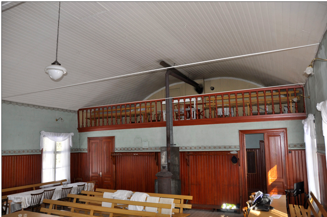
Kaminen och rökröret före renovering. Bildnr Vlm_kmvIM-2612.
