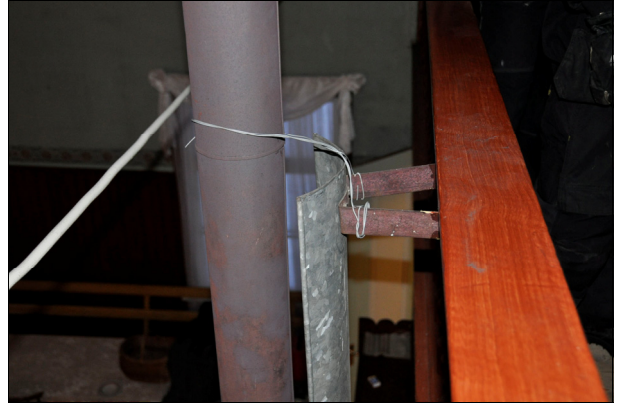
Den övre befintliga hållaren som hölls fast i rökröret med en ståltråd. Bildnr Vlm_kmvIM-2529.
