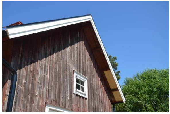
Nya vindskivor spikades på och målades vita. Vissa brädor är utbytta i undertaket. Vlm_kmvFE-3210
