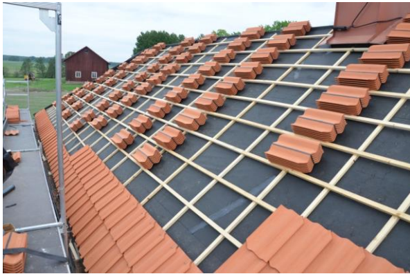
Takpapp och ny läkt spikades på det reparerade undertaket. Nya 2-kupiga tegelpannor lades på taket. Vlm_kmvFE-2987
