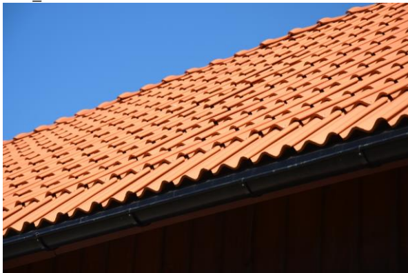
Takpapp och ny läkt spikades på det reparerade undertaket. Nya 2-kupiga tegelpannor lades på taket. Vlm_kmvFE-2987
