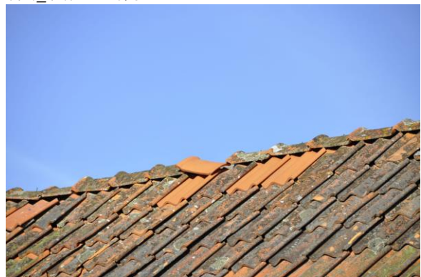
Nockpannor låg fel och teglet var slitet. Vlm_kmvIM-2705
