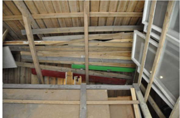
Undertaket består av ett brädtak i relativt gott skick. Vlm_kmvIM-2695
