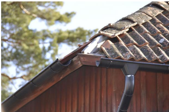
Hängrämmor hade dåliga anslutningar och tegelpannor saknades vid takfoten. Vlm_kmvIM-2709
