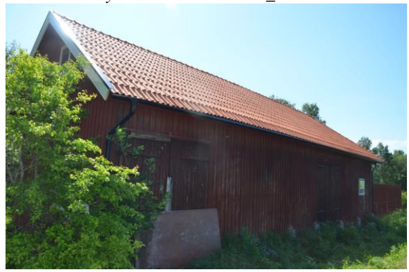
Nya vindskivor spikades på och målades vita. Vissa brädor är utbytta i undertaket. Vlm_kmvFE-3210
