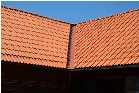
Ny rännadal och nya pannor. Vlm_kmvFE-3212
