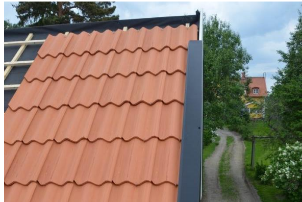
Nya täckbrädor av svart plåt spikades på byggnaden. Vlm_kmvFE-2989
