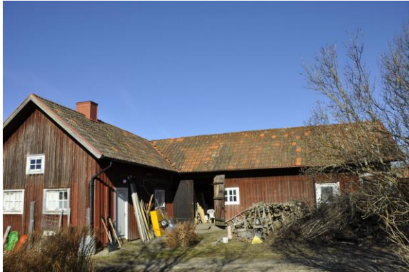
Ladugården innan åtgärderna. Vlm_kmvIM-2700
