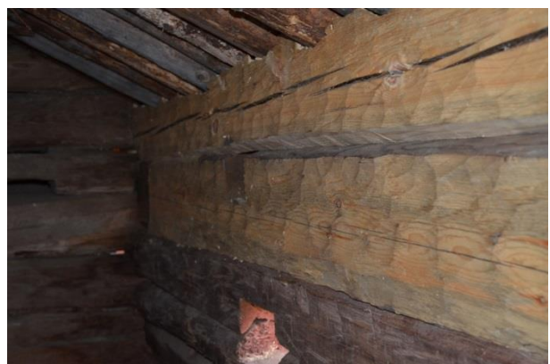
Timmerlagningar i stommen. Vlm_kmvFE-3764
