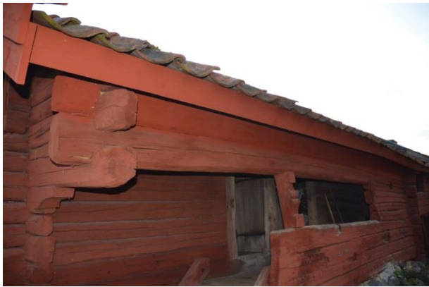
Timmerlagning i övre delen av stommen. Vlm_kmvFE-3752
