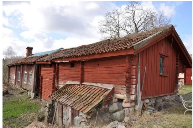
Loftboden innan åtgärder. Vlm_kmvIM-2716
