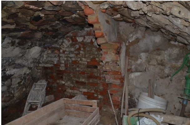
Jordkällare under loftboden. Vlm_kmvFE-1327
