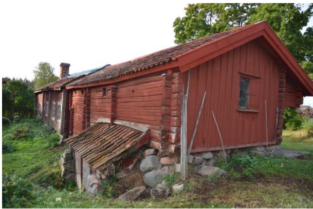
Lofsboden efter åtgärder och röjning av vegetation. Vlm_kmvFE-3754
