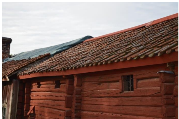
Omlagt tegeltak med återvunnet tegel. Vlm_kmvFE-3756
