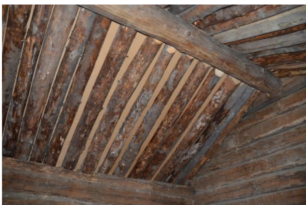
Undertaket lagades med kluvna slakor och oljehärdad board lades på slakorna. Vlm_kmvFE-3761
