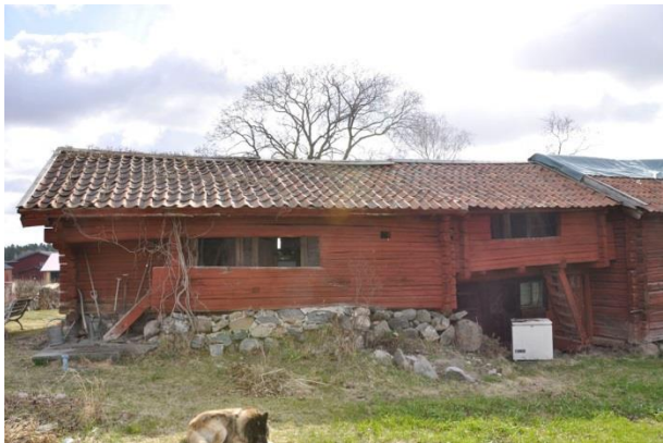
Loftboden innan åtgärder. Taket är ojämnt och det böljar mellan läkten. Vlm_kmvIM-2715
