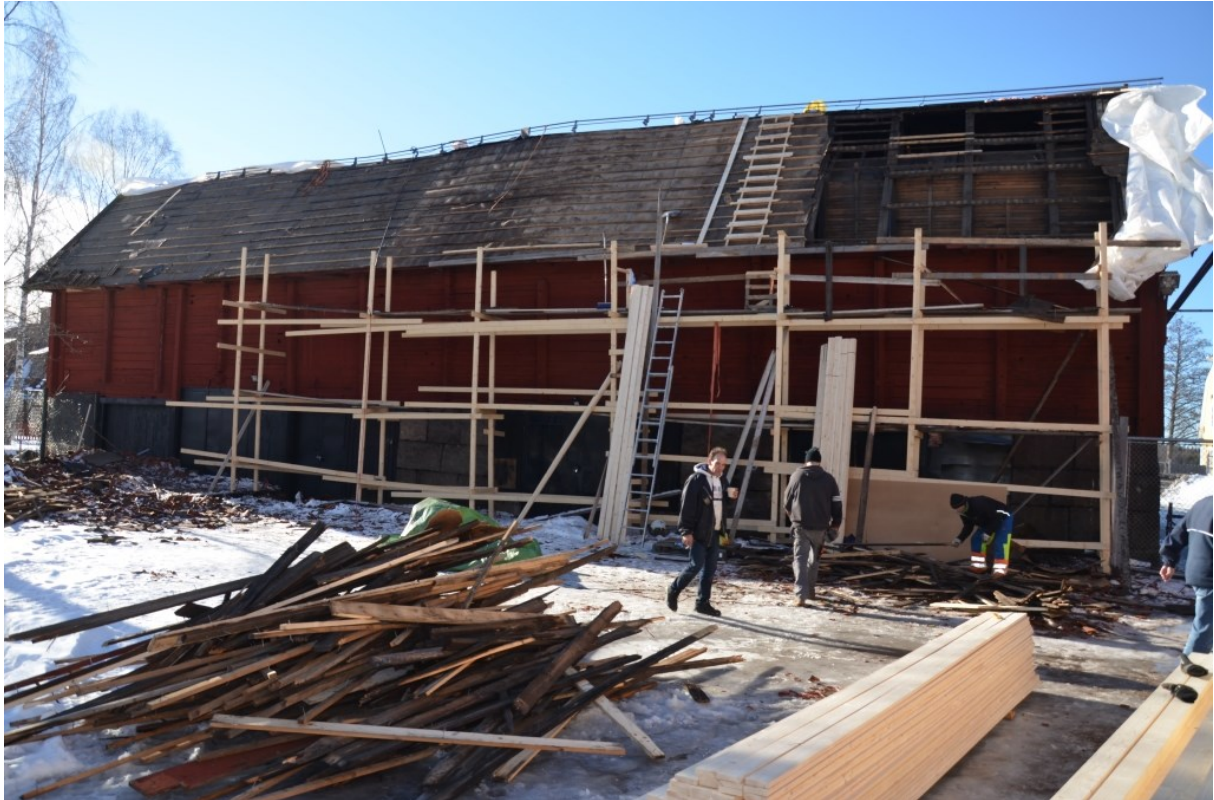
Takomläggningen påbörjad. Arbetet skedde i sektioner. Bärläkten var spikad direkt på boarden utan ventilering, skräp och regnvatten hade därför samlats på läkten och bildat rötskador. Vlm_kmvFE-2571.
