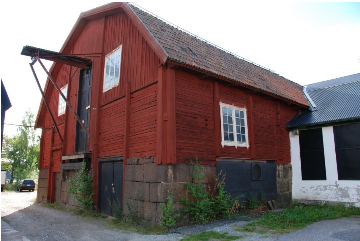
Kolhuset sett från väster. Innan takomläggning. Vlm_kmvFE-542
