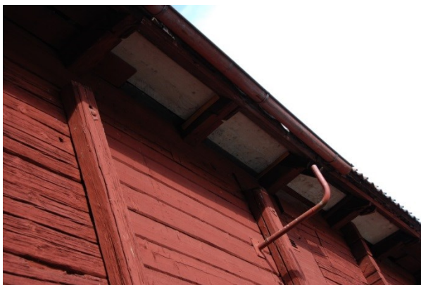
Takutsprång innan åtgärder. Vlm_kmvFE-555
