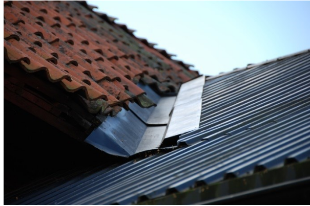
Anslutning mellan Kolhuset och den senare tillbyggda verkstaden. Regnvatten rann in under teglet tack vare felaktig konstruerad rännnal Vlm_kmvFE-548..
