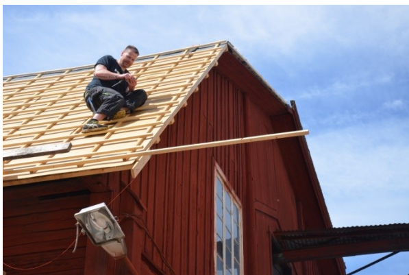
Pågående arbete på taket. Vlm_kmvFE-3068
