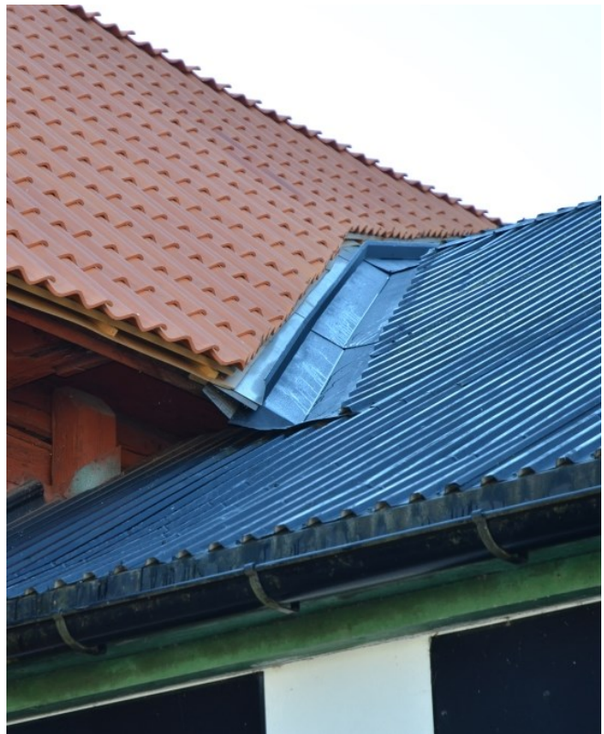
Anslutningen till verkstaden utformades så att regnvatten inte kunde rinna in under teglet. Vlm_kmvFE-3614.
