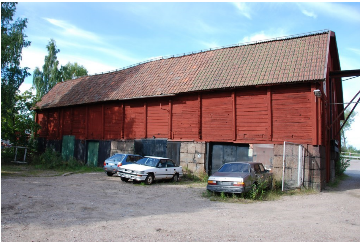
Kolhuset innan takomläggning, Från öster. Vlm_kmvFE-551
