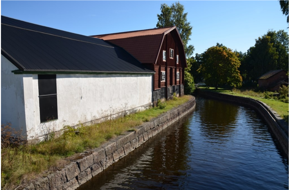
Översiktsbild över kanlen, verkstaden och kolhuset efter restaureringen. Vlm_kmvFE-3620
