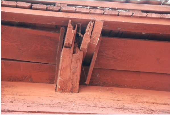
Skadad takstol i västra fasaden. Vlm_kmvFE-545
