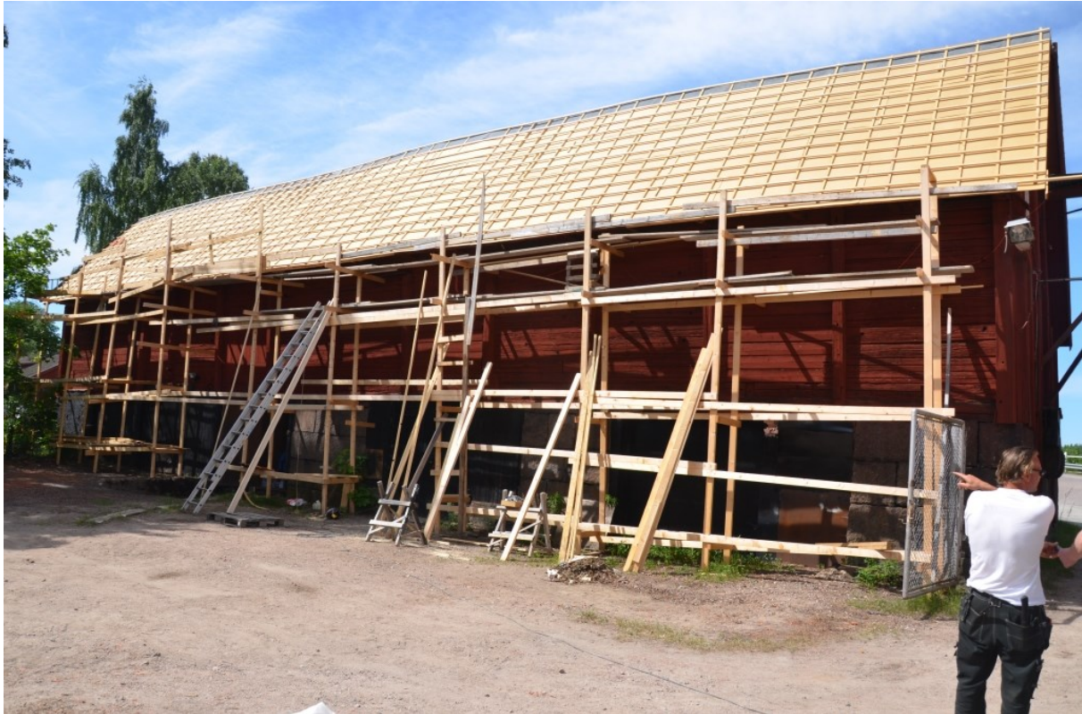
Pågående takomläggningen. Undertaket reparerat, ny board, strö- och bärläkt har spikats på. Från öster. Vlm_kmvFE-3067.
