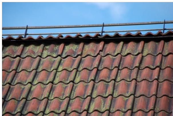
Nocktäckning saknades. Vlm_kmvFE-552
