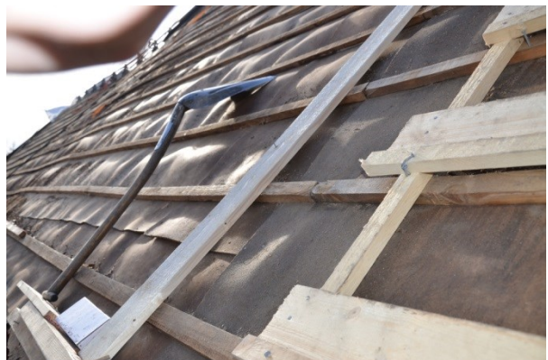
Pågående arbete att riva bort läkt och board. Vlm_kmvFE-2564
