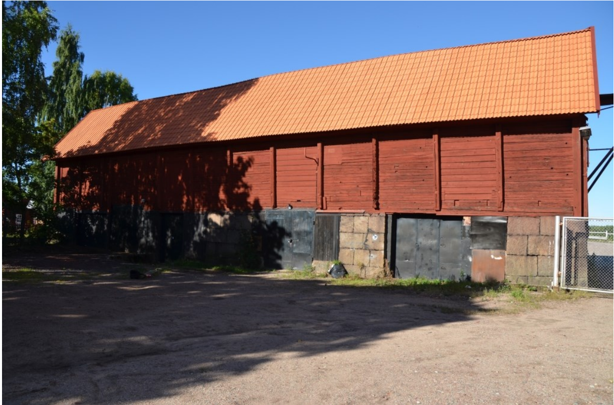
Kolhuset efter takläggningen, från öster. Vlm_kmvFE-3603.
