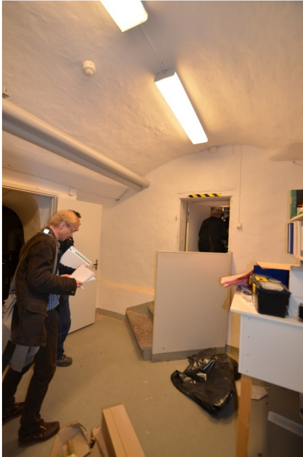
Bild 4, Källare direkt under kök innan håltagning
