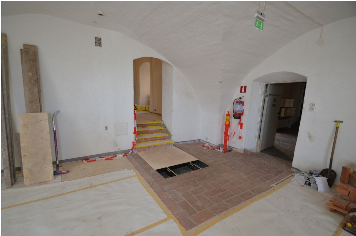
Bild 15, Nylagt trägolv som ger rummet en sammanhängande golvnivå
