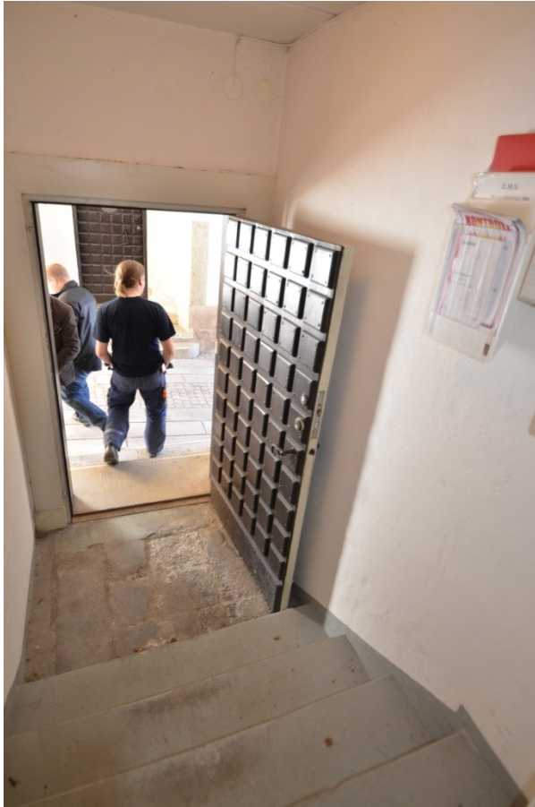
Bild 12, Befintlig dörr innan åtgärderna
