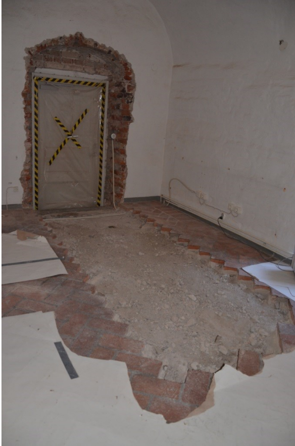
Bild 21, dörr mellan rum 022/026 rivning av tegelgolv
