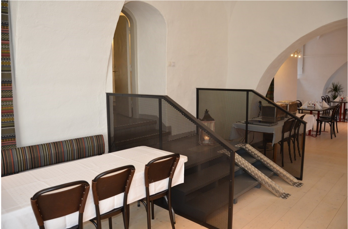
Bild 10, Ny trapp mellan rum 002 och 006
