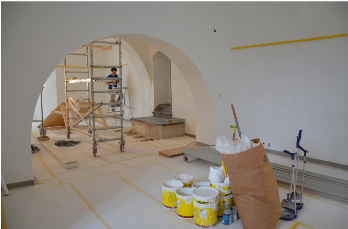
Bild 11, trappan på gång
