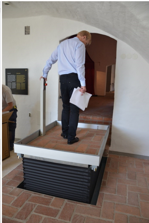
Bild 18, lyftbord installerat och i drift
