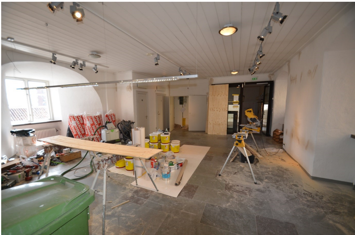
Bild 3, Rum 002 under ombyggnad
