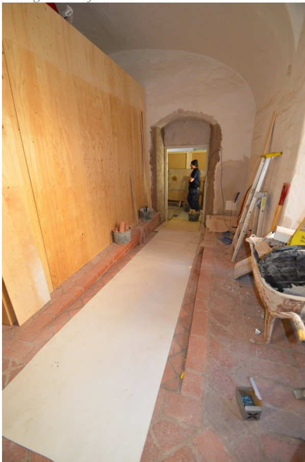
Bild 25, rampen klar och diskrummet påbörjat
