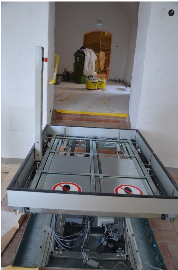
Bild 17, lyftbord under installation
