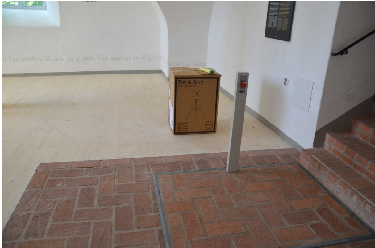
Bild 19, lyftbordet nedsänkt i tegelgolvet och det nya trägolvet
