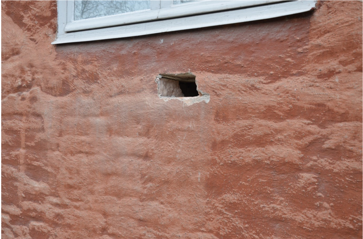
Bild 29, återupptagen kanal för ventilation in till diskrummet
