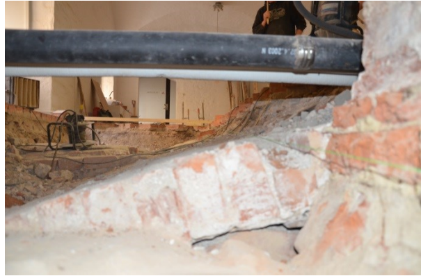
Bild 24, uppstickande valv från källaren
