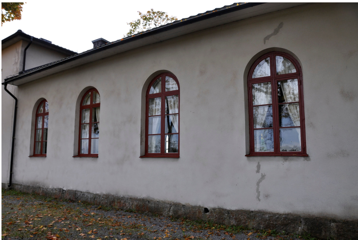
Bild 11: Byggnadens västra fasad efter fönsterrestaurering.
