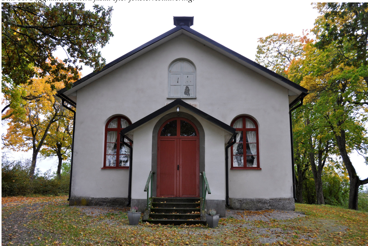
Bild 12: Byggnadens norra fasad efter restaurering.
