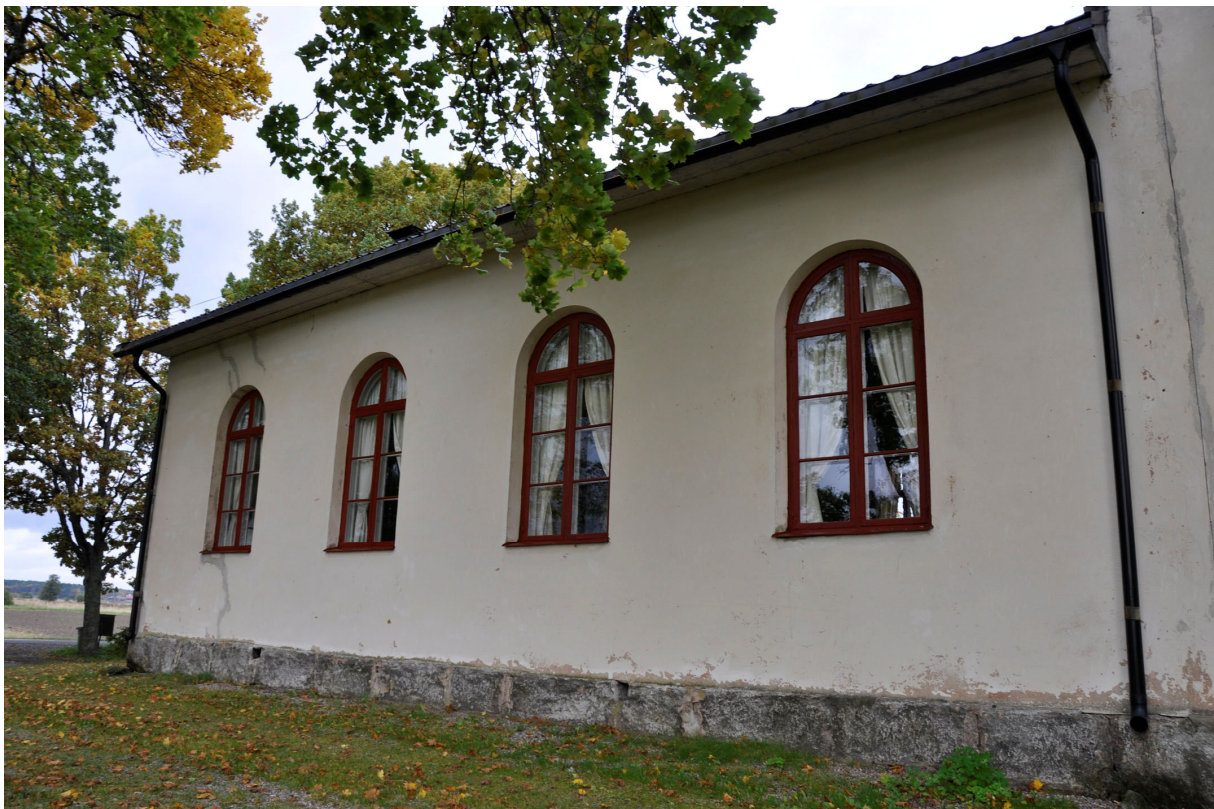
Bild 10: Byggnadens västra fasad efter restaurering.
