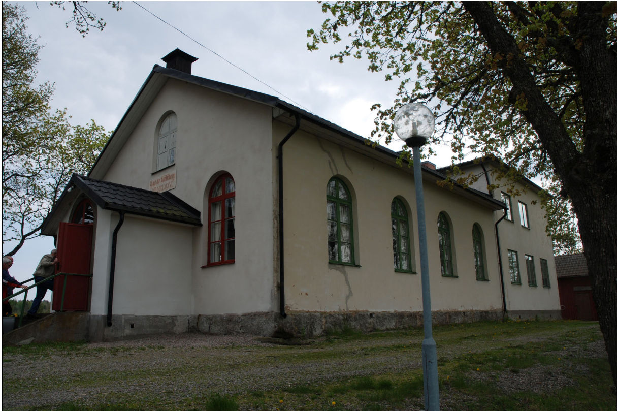
Bild 1: Missionshuset från nordväst före restaurering.
