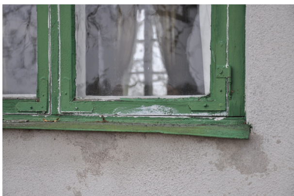
Bild 4 och 5: Behovet av restaurering var stort eftersom kitt hade fallit bort på flera fönsterbågar.
