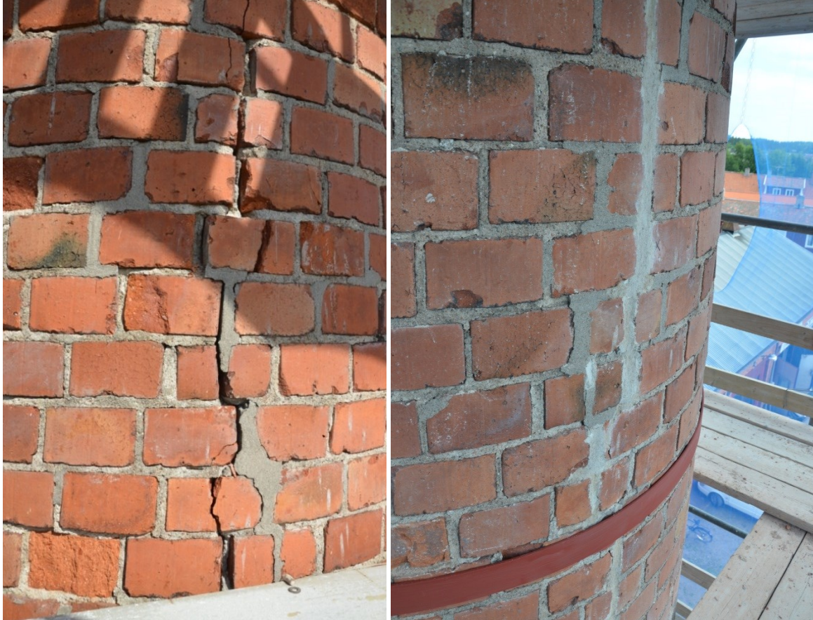
Bilden till vänster visar detalj från sprickan som fanns i skorstenen. På bilden till höger syns ett av de nya dragbanden som rostskyddsbehandlats, sprickan är fylld med bruk. Vlm_kmvFE-2786, Vlm_kmvFE-3135
