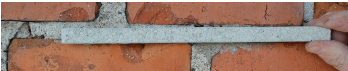
Fogstrykning skedde med Maxit. Bild på provsticka av fogen. Vlm_kmvFE-2783
