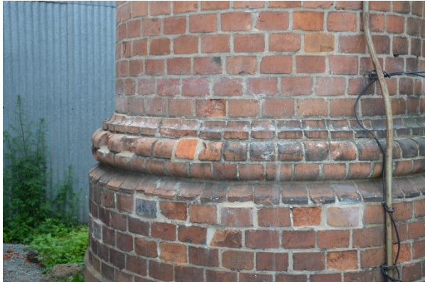
Utbytt sten i skorstenens nedre parti. Vlm_kmvFE-3156
