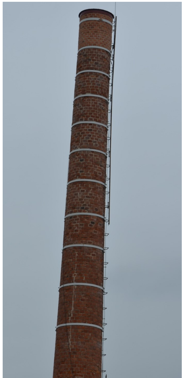
Samtliga dragband av järn rostskyddsbehandlades och målades med vit oljefärg. På bilden syns även den 4 meter långa sprickan som åtgärdades med två nya dragband. Vlm_kmvFE-3155.
