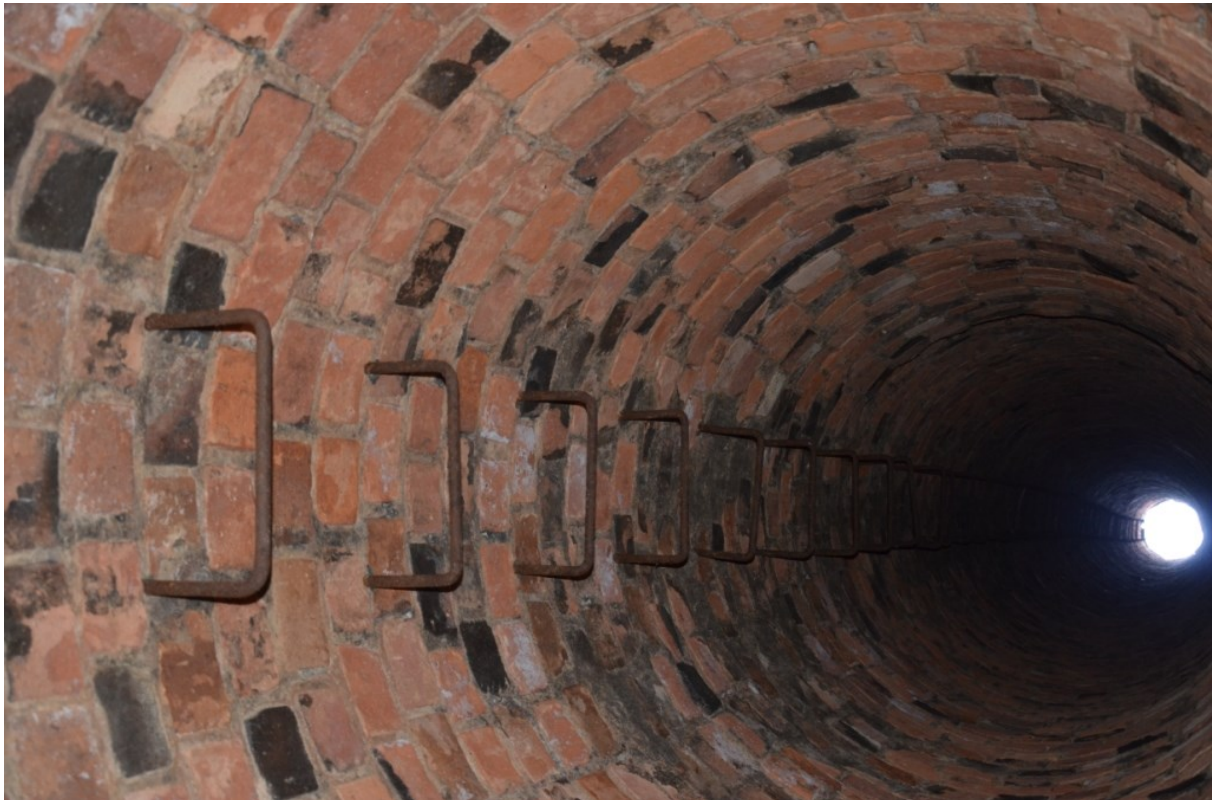
Skorstenens insida. Foto taget från en lucka i skorstenens grund. Vlm_kmvFE-2795
