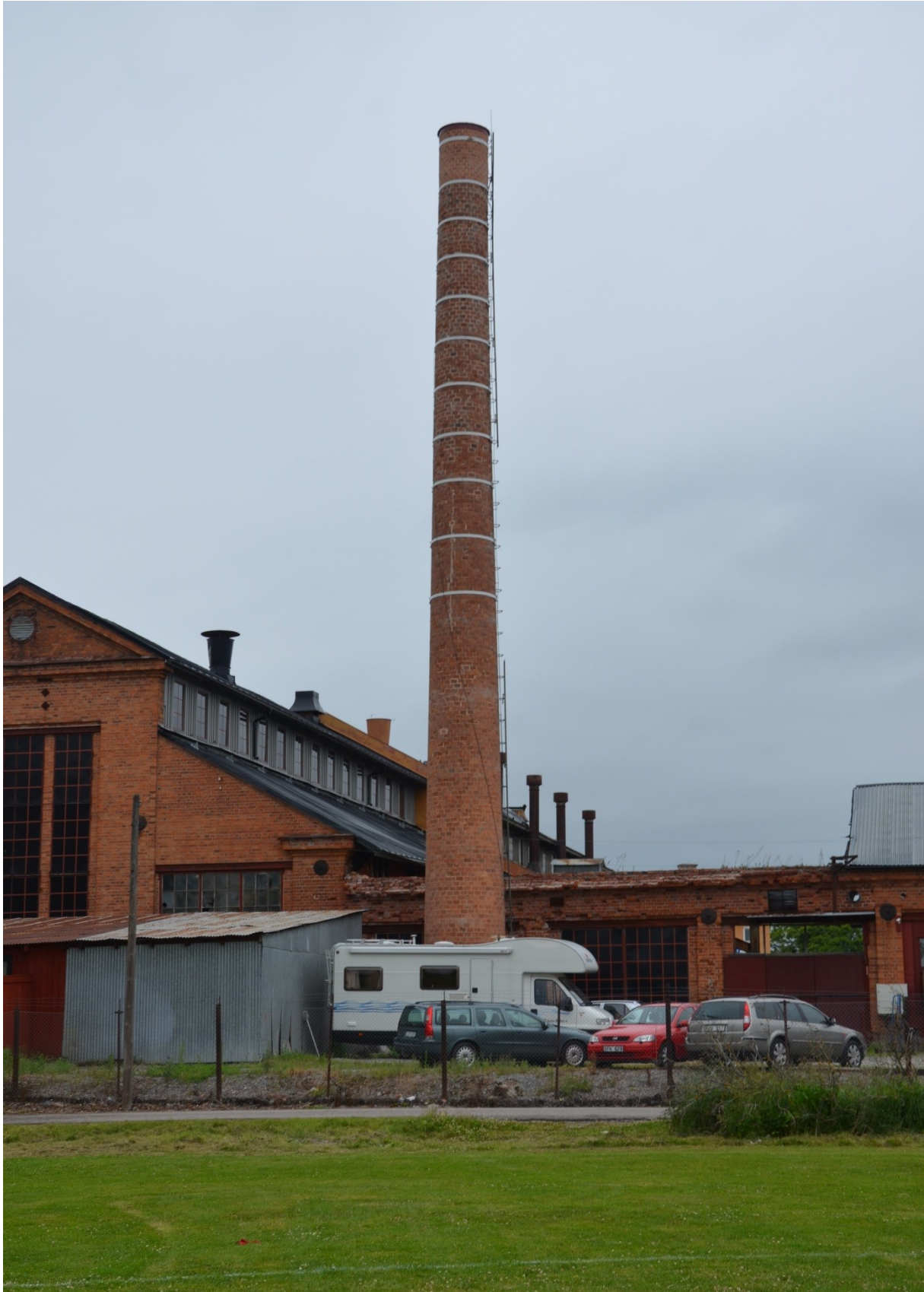
Skorstenen efter genomförda åtgärder och byggställningen är bortplockad.. Vlm_kmvFE-3153
