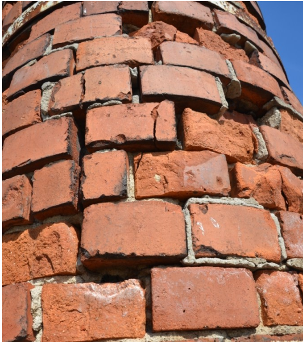
Frostsprängda tegelstenar. Vlm_kmvFE-2791
