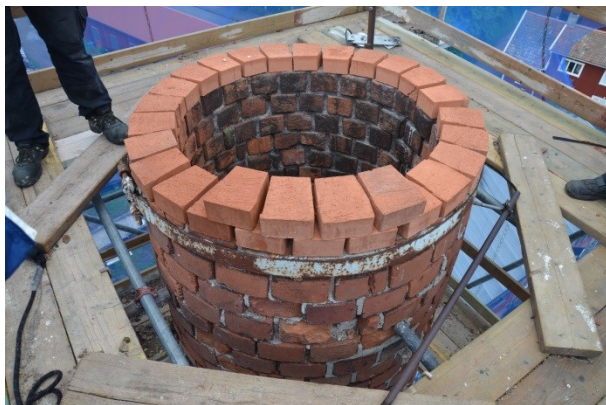
Toppen av skorstenen nedplockad och återuppbyggnad påbörjad. Vlm_kmvFE-2864.
