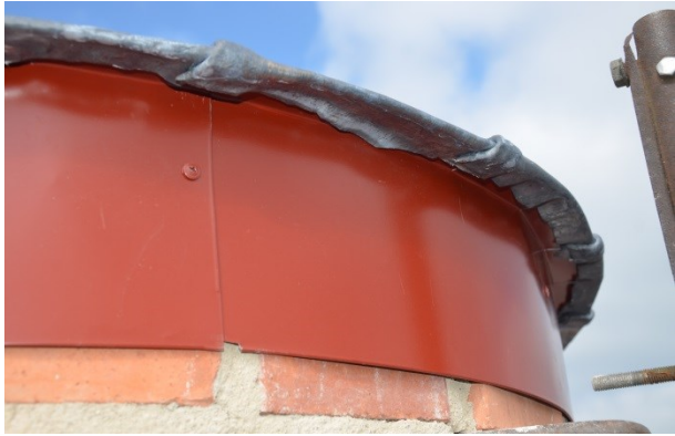
Närbild på dropplisten pej blyplåten. Vlm_kmvFE-3143
