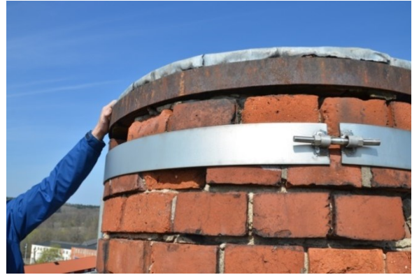
Mynningens skydd innan åtgärder. Vlm_kmvFE-2789.
