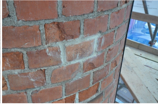
Utbytt sten i skorstenen. Vlm_kmvFE-3149
