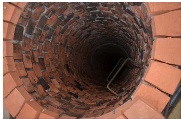
Skorstenens kondition på insidan verkad relativt god. Vlm_kmvFE2861
