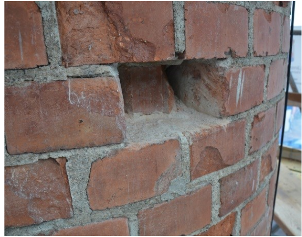
Tegelsten borta från muren, ersättning skedde med ny sten i dimension likt befintlig. Vlm_kmvFE-2857
