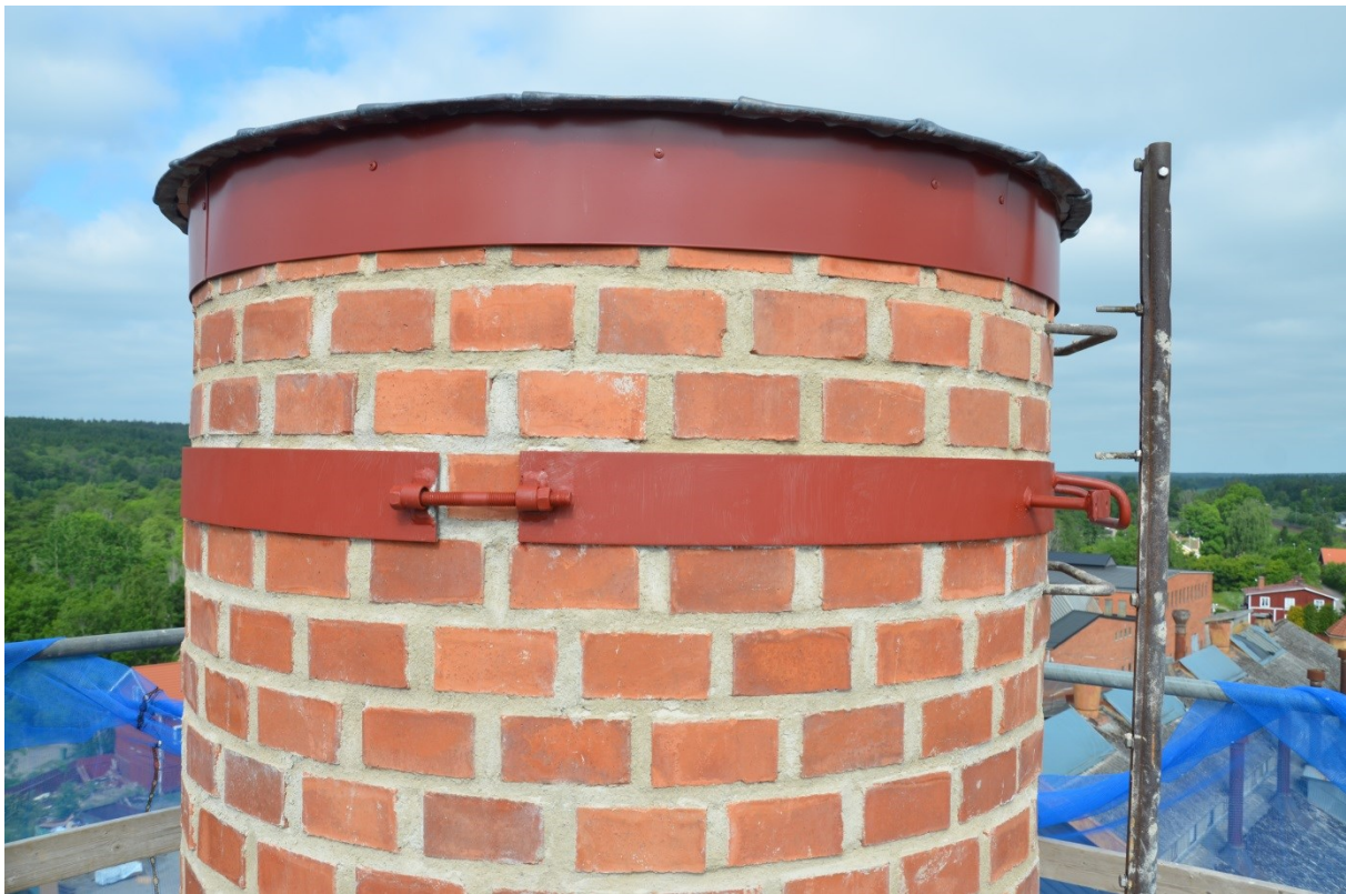
Skorstenen efter återuppmurning. Dragbanden har rostskyddsbehandlats i väntan på målning. Vlm_kmvFE-3142
