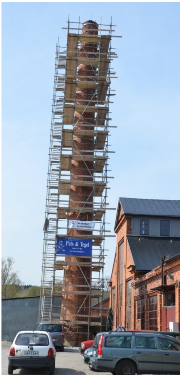
Byggställningen täckte hela skorstenen och gjorde att besiktningarna kunde utföras på ett bra och effektivt sätt. Området kring skorstenen spärrades av då det fanns risk för fallande tegelstenar. Vlm_kmvFE-2798.
