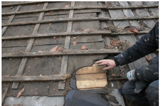
På södra delen av byggnaden, på ett avgränsat område låg råspont istället för den äldre locklagda panelen. Foto: Ramnäs bruk AB
