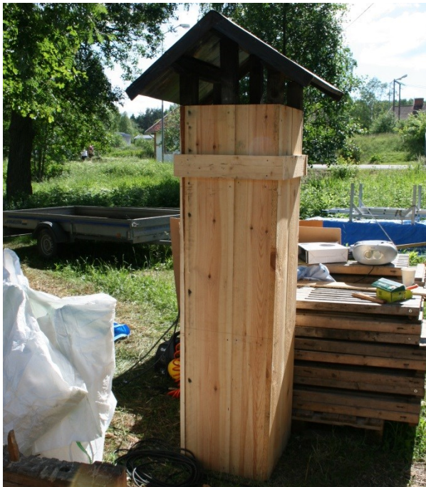
Takryttaren reparerades, stor del av virket var så pass skadat att det fick bytas ut. Foto: Ramnäs bruk AB
