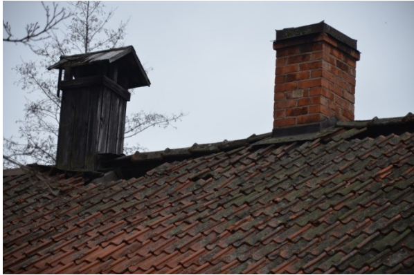
Nocken och takryttaren hade kraftiga rötskador och tegelpannor hade fallit bort. Vlm_kmvFE-2724.
