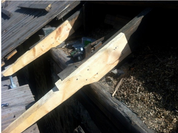
Lagade takstolar, bjälklaget bestod av bilade stockar och takstolarna av sågat virke. Reparationer skedde Likt befintligt. Foto Ramnäs bruk
