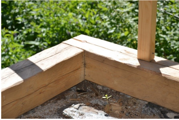
Muremnen ersattes med nytt virke i vissa delar, här syns en reparerad knut. Vlm_kmvFE-3046
