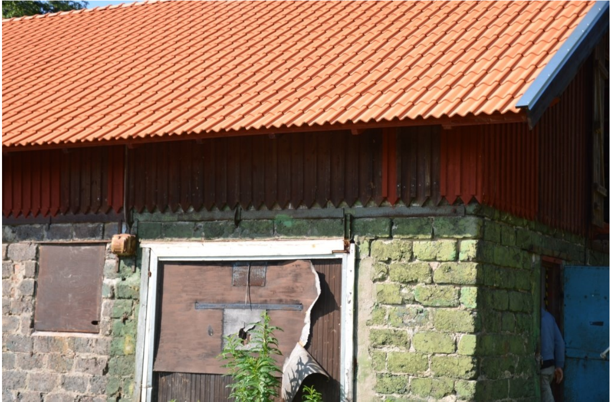
Bilden visar platsen för den tidigare tillbyggnaden som i samband med projektet revs bort. Nya täckskivor av galvaniserad plåt lades även på byggnaden, likt befintlig lösning. Vlm_kmvFE-3370.
