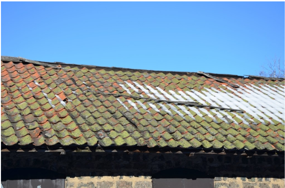
Nockskivorna var rötskadade och saknades helt på vissa ställen. Vlm_kmvTM-975
