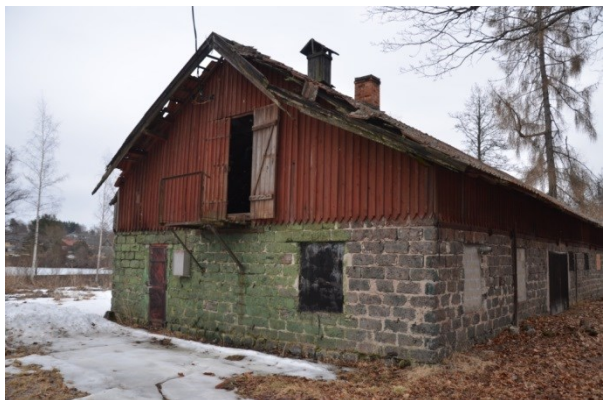
Vid nocken och gavlarna saknades tegelpannor, virket var rötskadat och taket var på väg att rasa in i byggnaden. Vlm_kmvFE-2730 och Vlm_kmvFE-2729.
