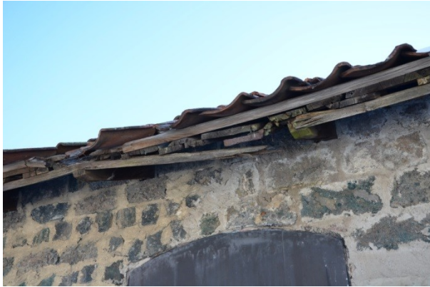
Det fanns rötskador i läkten och vid takfoten. Vlm_kmvTM-989
