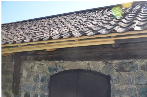
Takfoten reparerad och pannorna lagda på plats. Vlm_kmvFE-3035
