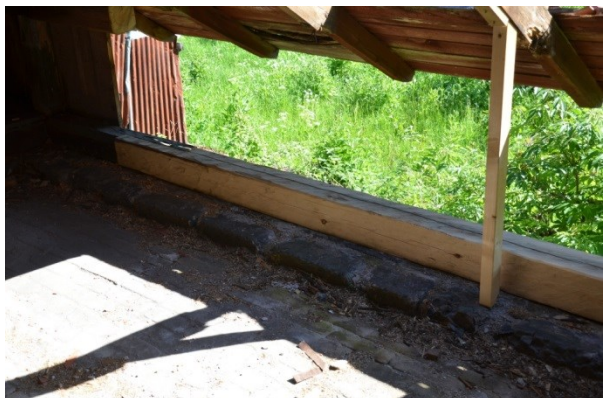
Pågående arbete med att reparera murremmen och stolpverksdelen. Vlm_kmvFE-3044
