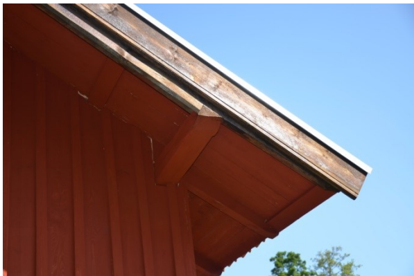
Byggnaden fick nya vindskivor som utformades likt befintlig utformning. Vlm_kmvFE-3365.
