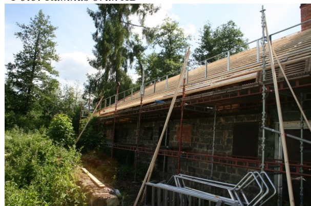
Pågående arbete med att lägga tak. Arbetet var omfattande då det fanns stora skador på både takkonstruktion och stolpverkskonstruktionen över slaggstensmuren. Foto: Ramnäs bruk AB.
