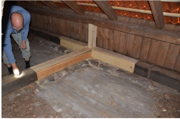
Reparerad murrem, anslutning mellan innerväg och ytterväg. Vlm_kmvFE-3382
