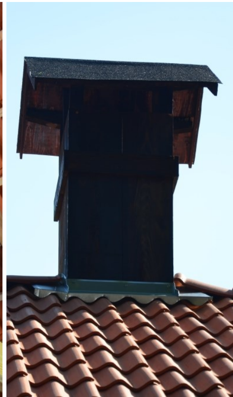
Takryttaren utvändigt nyligen tjärstruken Vlm_kmvFE-3361
