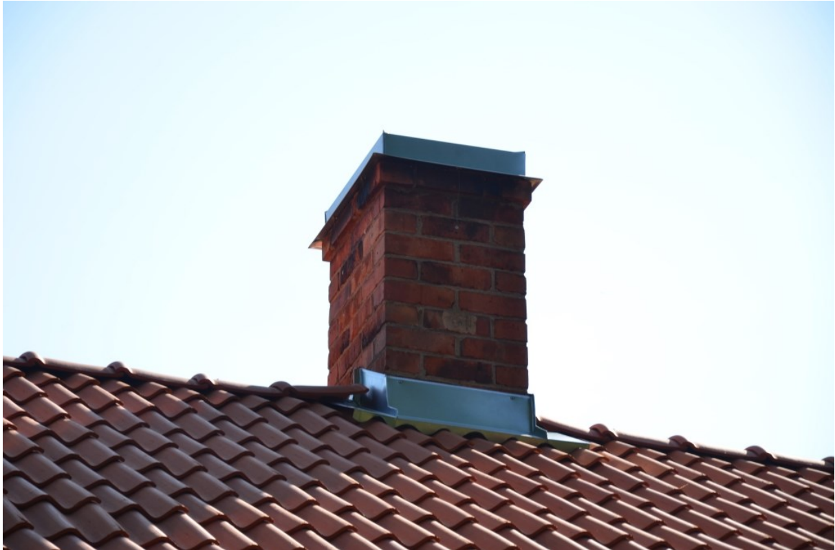
Skorstenen fick ny skoning av omålad galvaniserad plåt. Nockpannor lades på likt befintligt. Vlm_kmvFE-3362.
