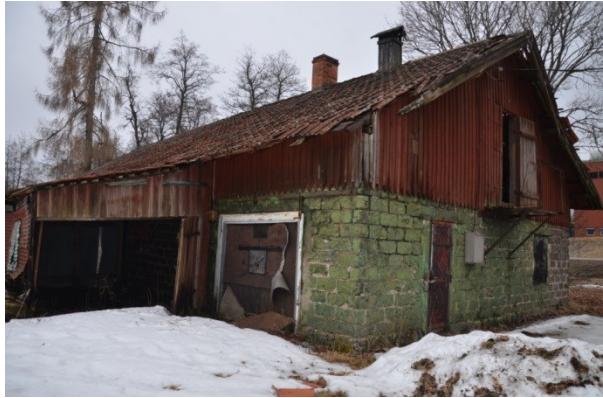
Vindskivor saknades i stort sett då de fallit bort, till vänster i bild syns den fallfärdiga tillbyggnaden. Vlm_kmvFE-2731
