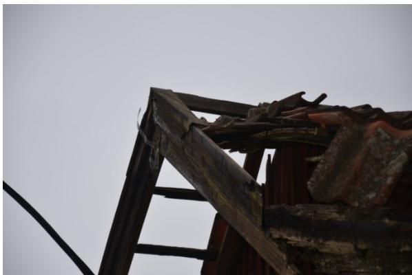
Vid nocken och gavlarna saknades tegelpannor, virket var rötskadat och taket var på väg att rasa in i byggnaden. Vlm_kmvFE-2730 och Vlm_kmvFE-2729.
