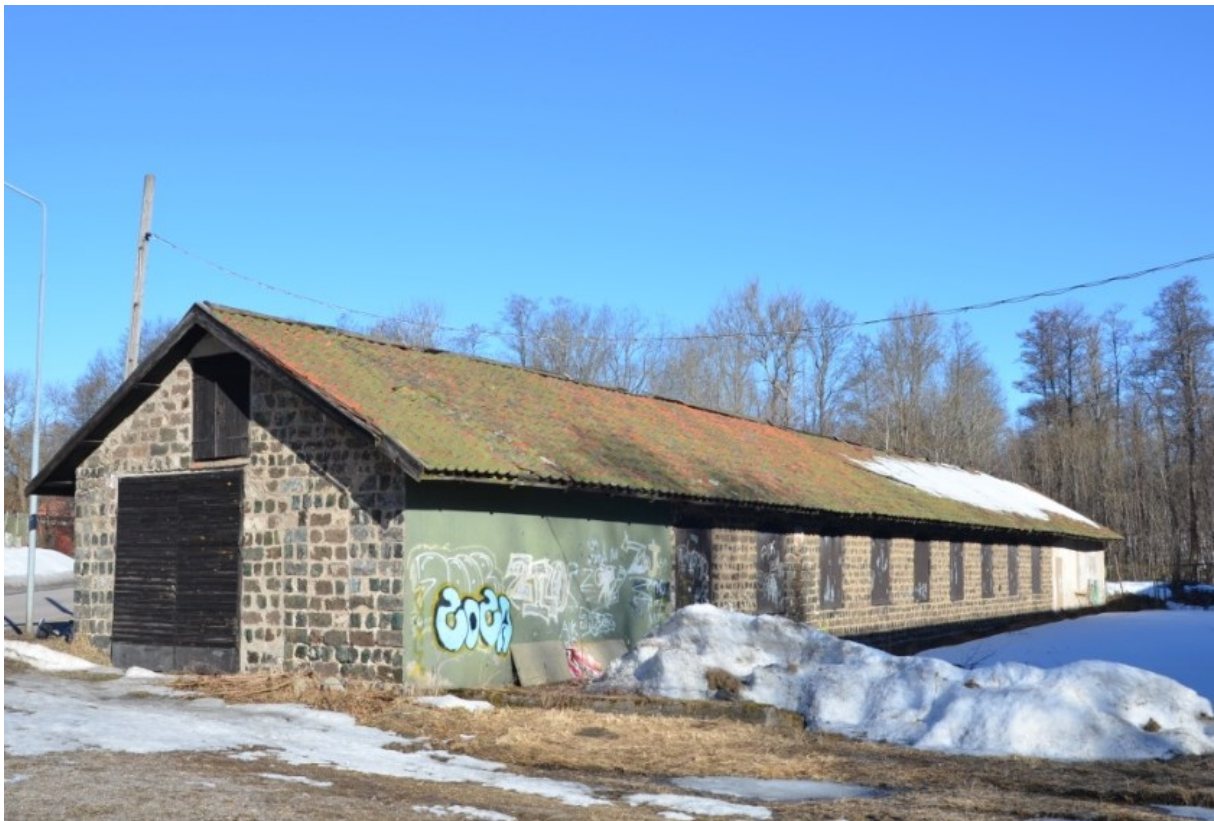
Sträckprovshuset innan omläggningen och reparationen av taket.. Vlm_kmvTM-973.
