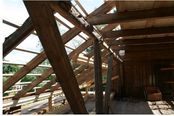
Takomläggning under arbete. Foto: Ramnäs bruk AB
