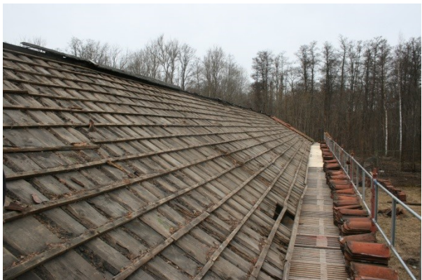
Teglet plockades bort och pannornas skick bedömdes. Foto: Ramnäs bruk AB
