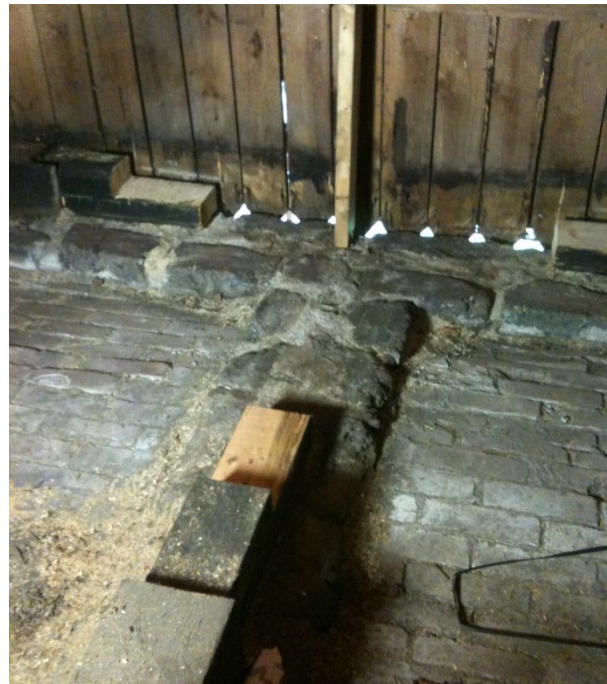
Pågående reparation av murrem vid anslutningen mellan bärande innervägg och yttervägg. Foto: Ramnäs bruk AB
