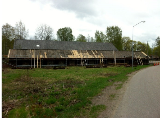
Åtgärdernas omfattning på undertaket. Västra takfallet Foto: Ramnäs bruk
