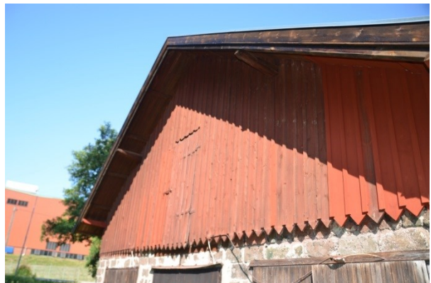
Panelen i stolpverkskonstruktionen utformades likt den befintliga och målades med röd slamfärg. Vlm_kmvFE-3366
