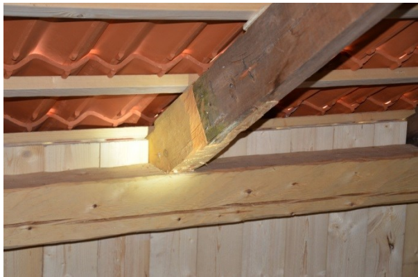
Närbild på reparationer i takstol mm Vlm_kmvFE-3387
