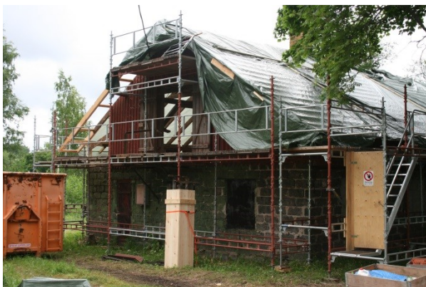
Pågående arbete med att lägga tak. Arbetet var omfattande då det fanns stora skador på både takkonstruktion och stolpverkskonstruktionen över slaggstensmuren. Foto: Ramnäs bruk AB.
