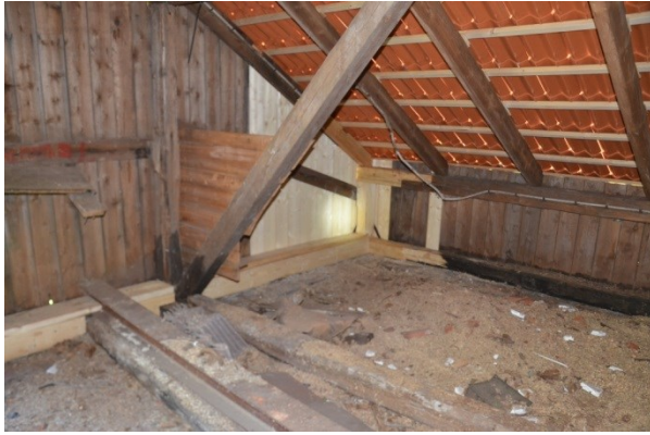
Reparerad murrem och panel samt omlagt tak. Vlm_kmvFE-3389
