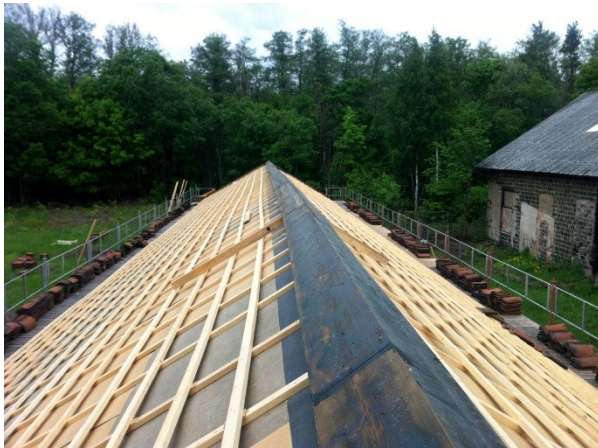
Board, läkt och nockbrädor lagda på taket. Nock-Brädorna tjärades innan de spikades på byggnaden. Foto: Ramnäs bruk
