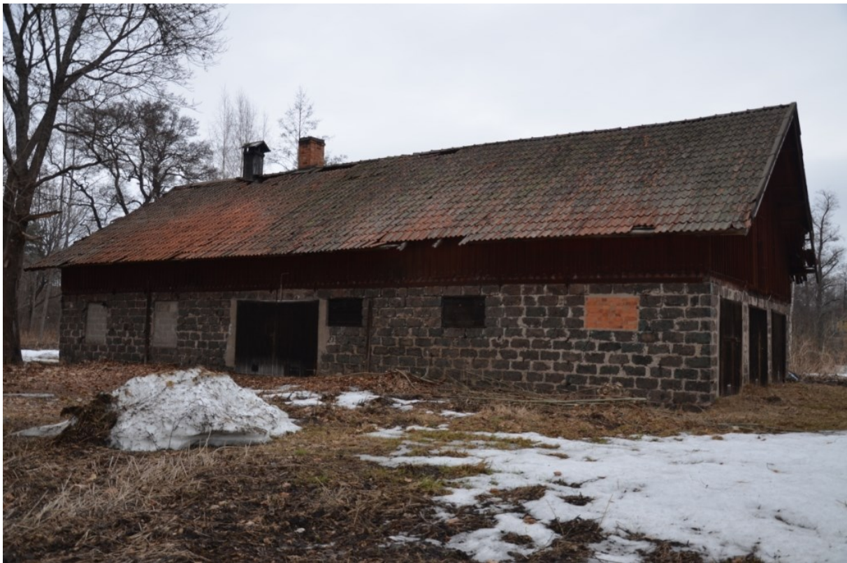
Byggnaden var i fallfärdigt skick och används idag främst som förråd. Vlm_kmvFE-2723.
