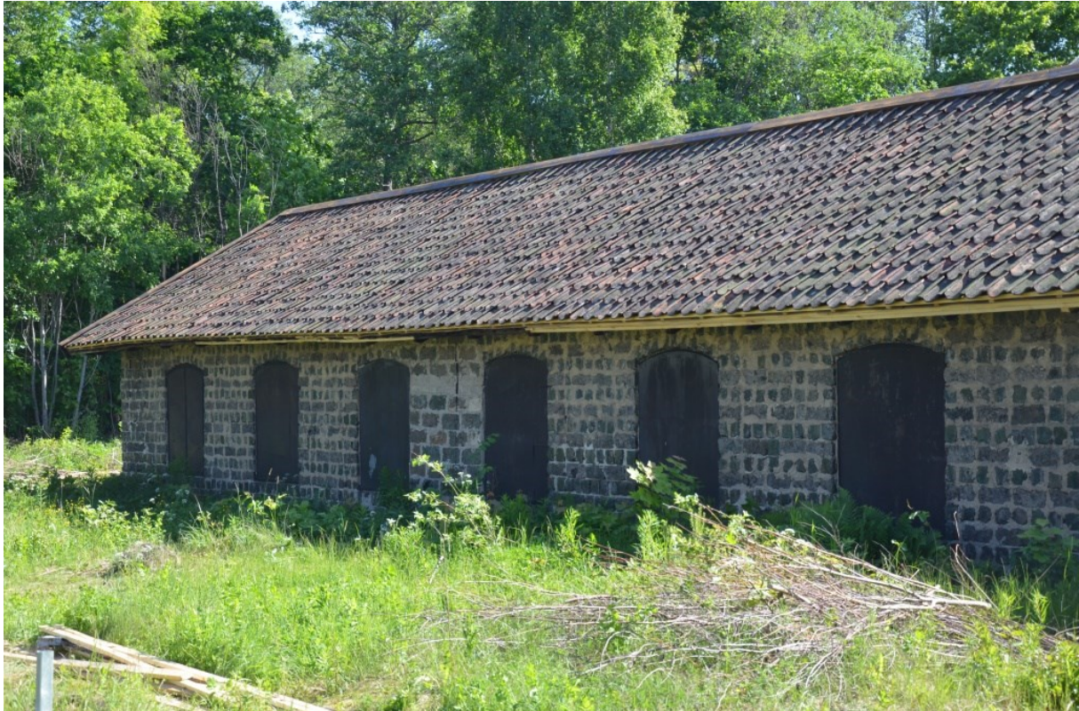
Byggnaden efter takomläggningen. Taket riktades upp i den norra delen för att fånockbrädan att ligga rakt och bra. Vlm_kmvFE-3036
