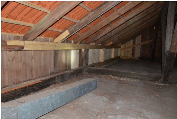
Reparationer i stolpverkskonstruktionen, murrem och Panel. Vlm_kmvFE-3384
