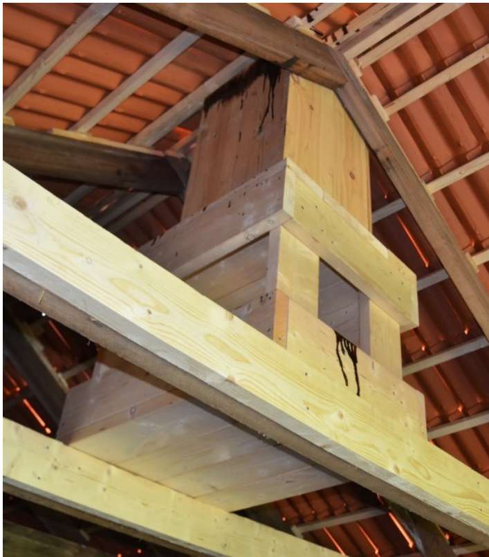
Takryttarens konstruktion invändigt byttes ut helt och hållet. Vlm_kmvFE-3378
