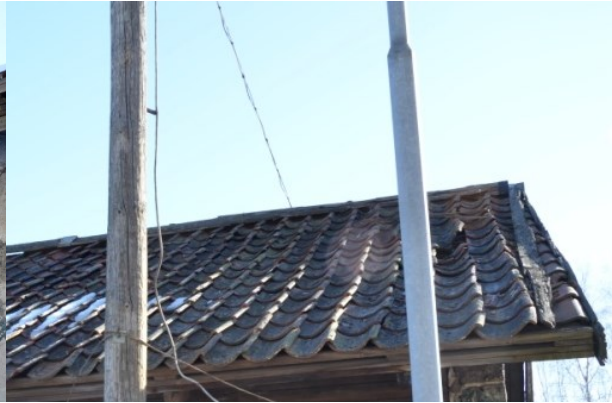
Skador fanns även på täck- och vindskivor. Vlm_kmvTM-983
