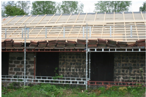
Takomläggningen under arbete. Foto: Ramnäs bruk
