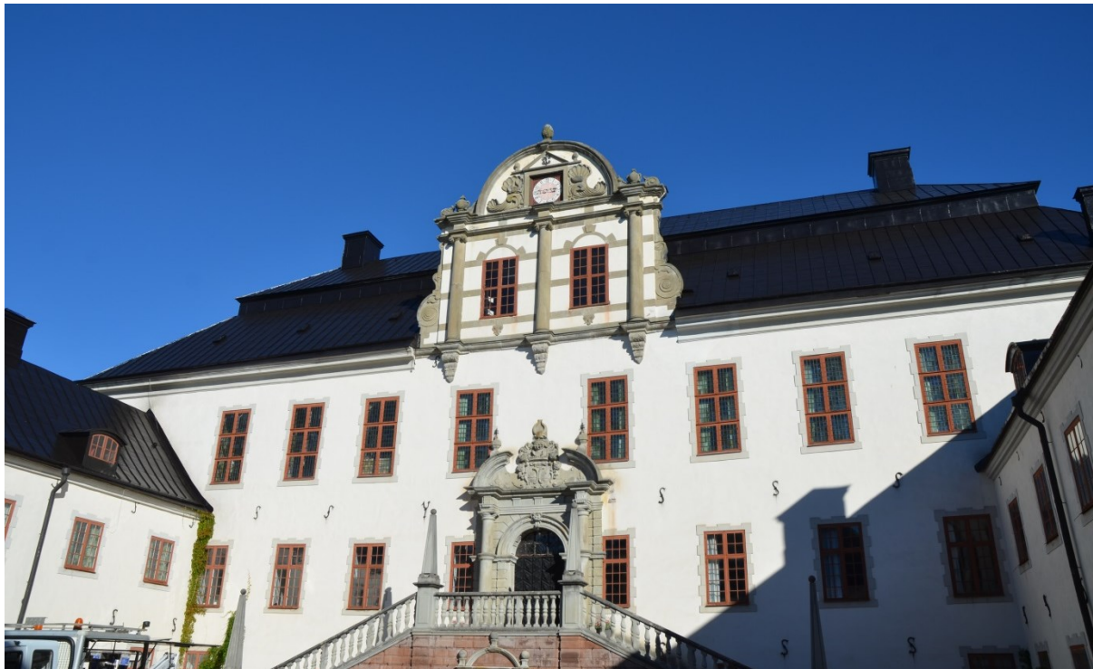
Bild 9, Efter slutstrykning med linoljefärg
