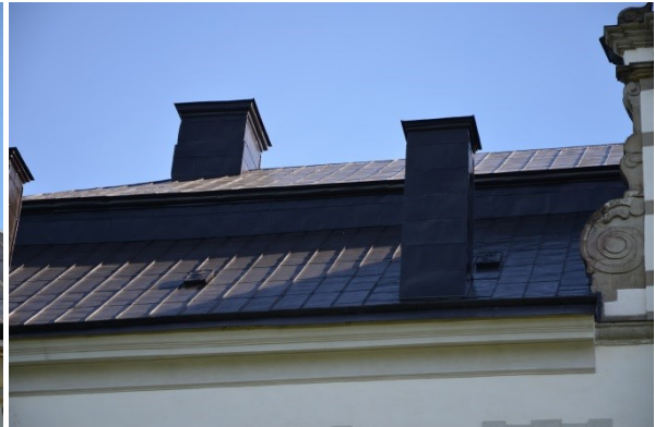
Bild 13, Detaljbild av nymålat tak
