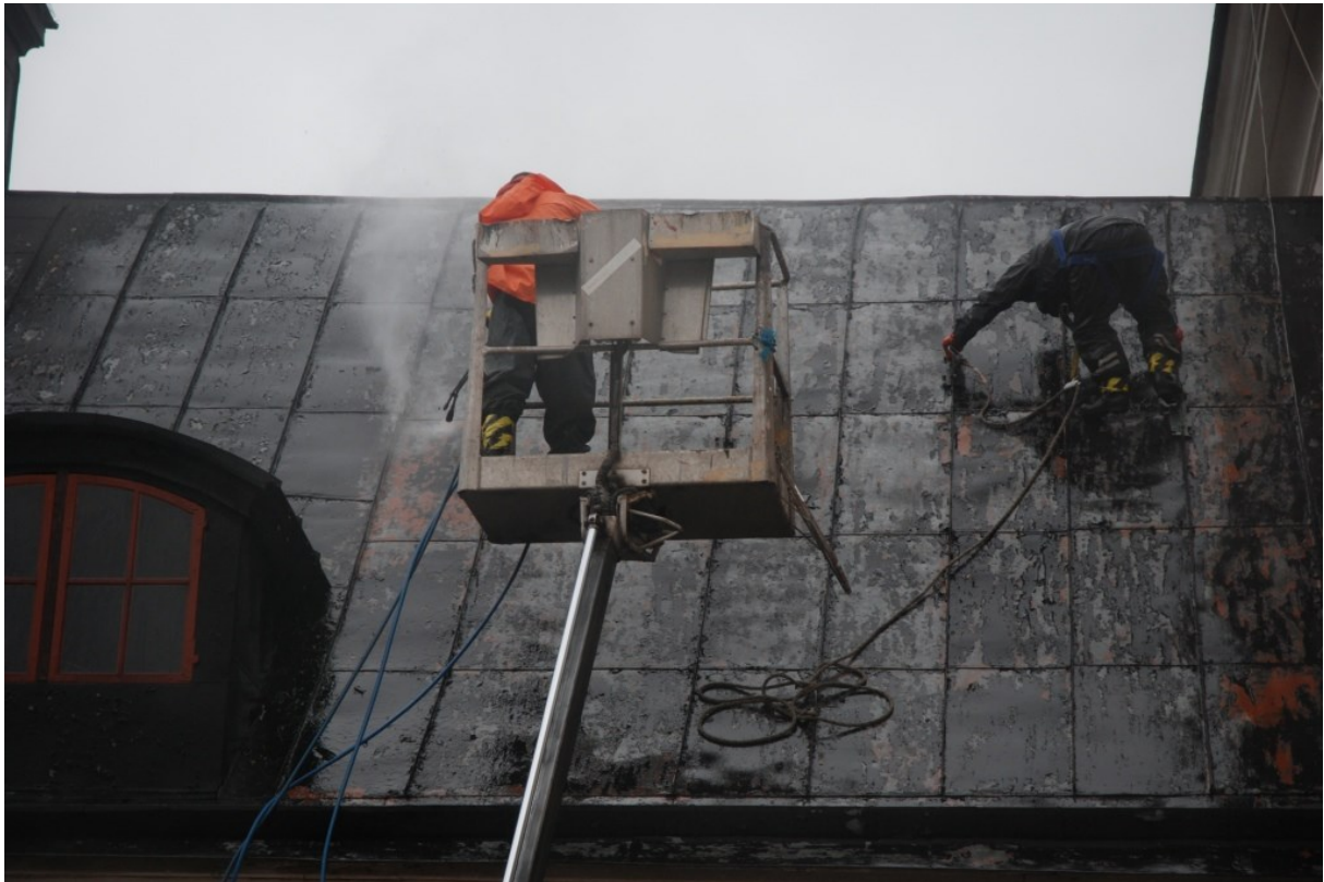
Bild 4, Pågående vattenblästring
