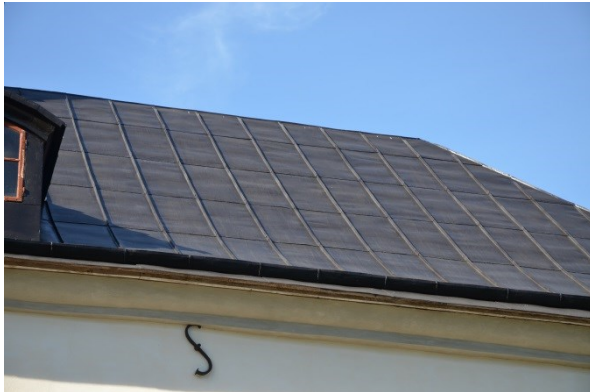
Bild 12, Detaljbild av nymålat tak
