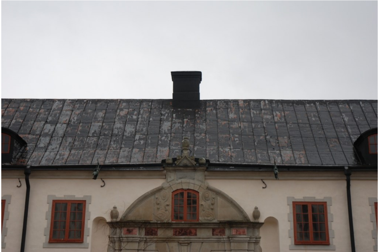
Bild 3, Tidö slott i oktober 2012 under pågåend rengöring.
