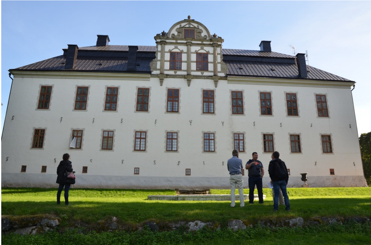
Bild 11, under slutbesiktning, slottets sydöstra fasad
