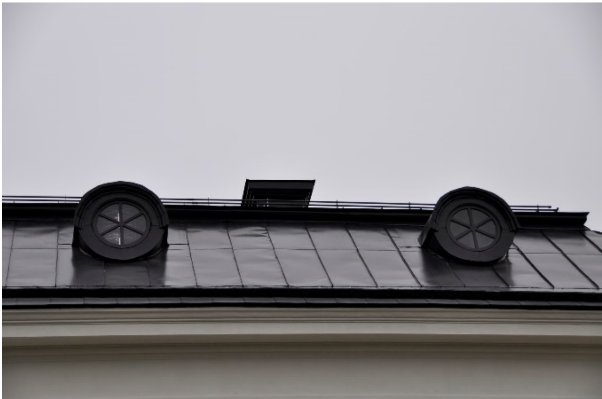
Taket och takfönster efter ommålningen.
