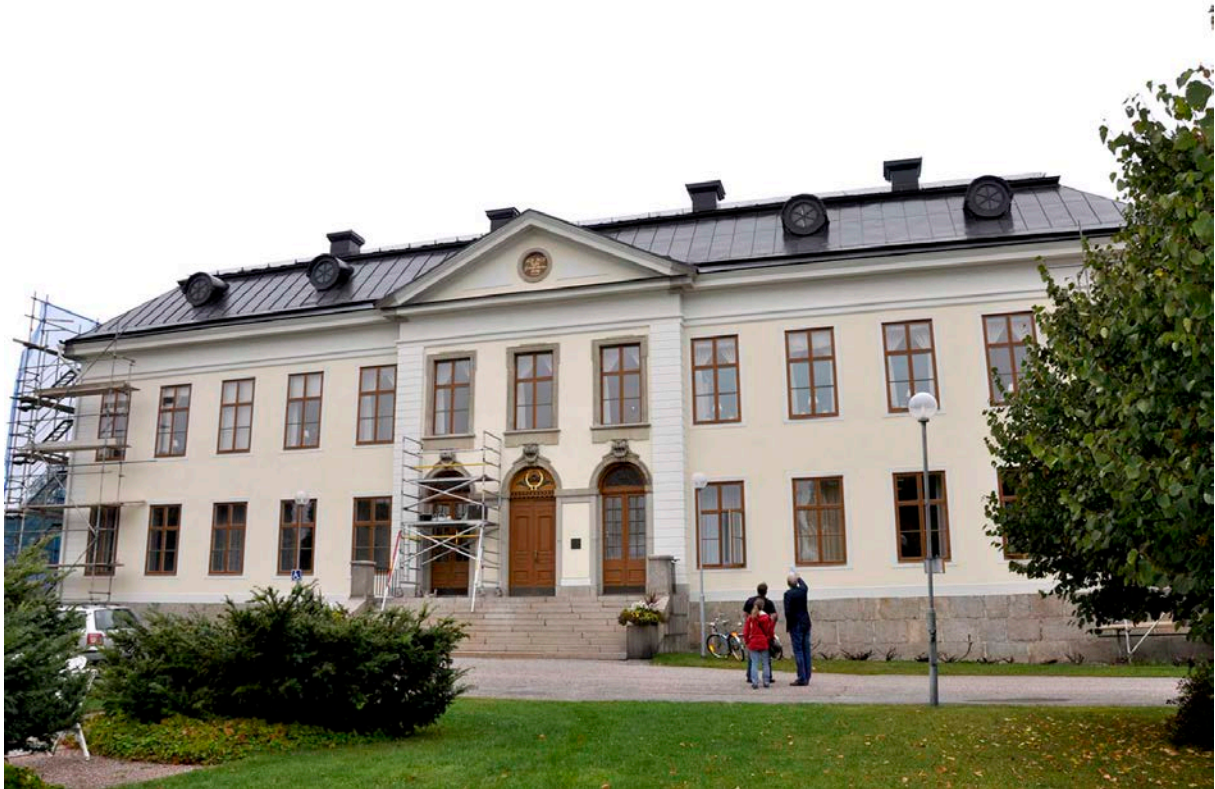
Huvudbyggnaden med färdigputsad fasad åt söder, målat tak och fönster. Konservering av sandstensdetaljerna över entrén pågår, september 2013.
