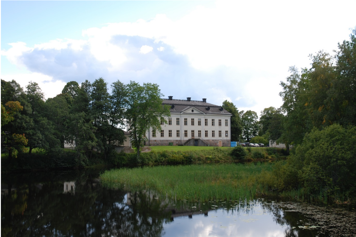
Skinnskattebergs herrgård mot norr vid projektstart 2011.
