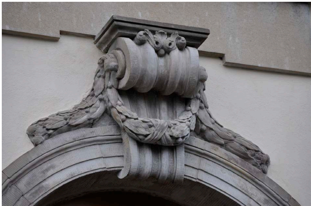
Dörromfattning i sandsten vid södra entrén, efter konserveringsåtgärder 2013.
