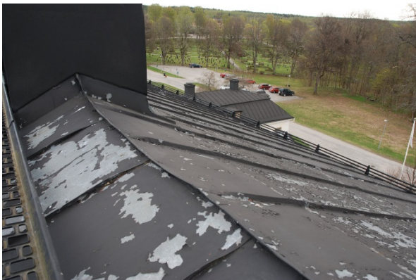
Taket hade omfattande färgsläpp.
