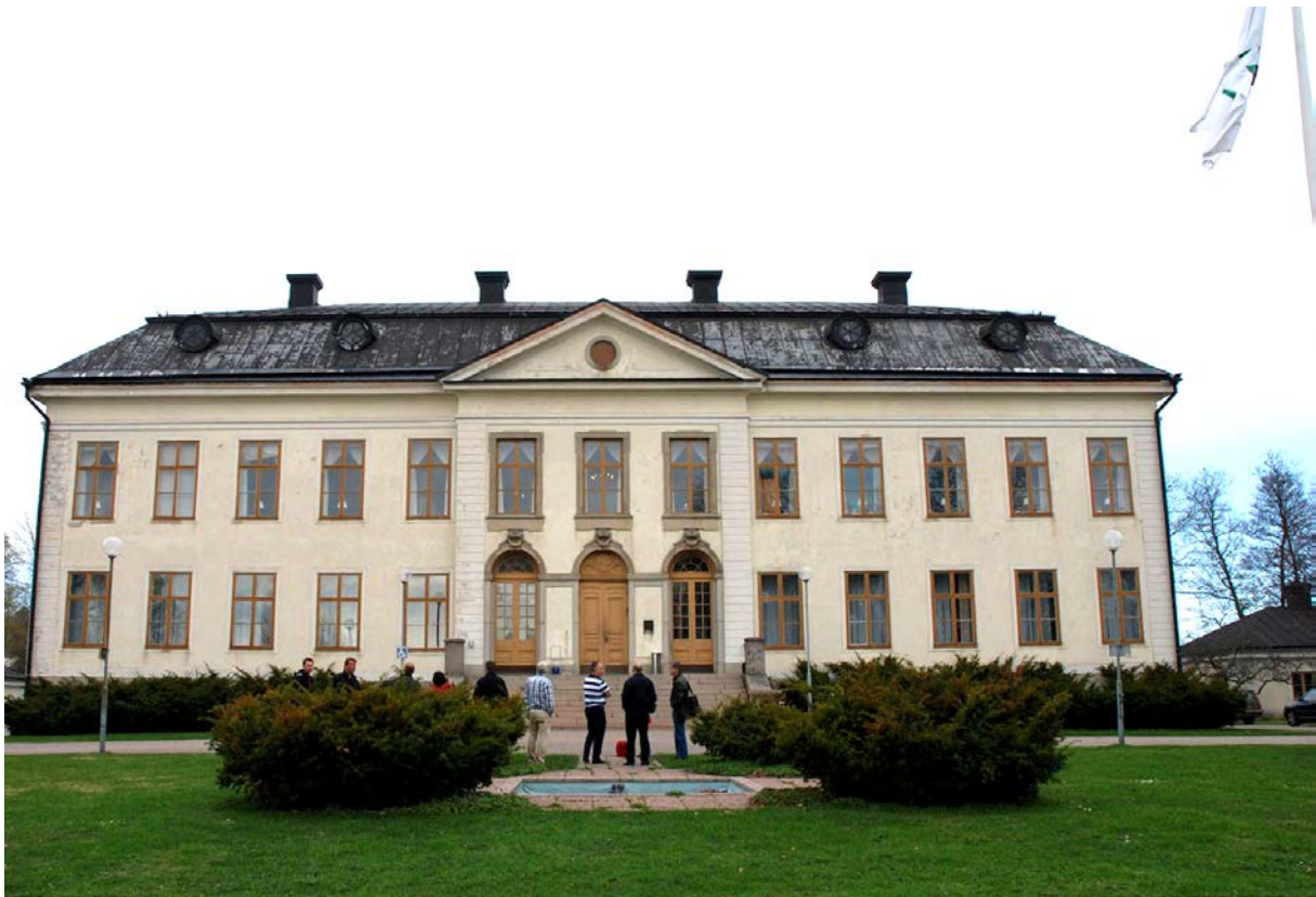
Huvudbyggnaden vid byggmöte inför renovering, 2011.
