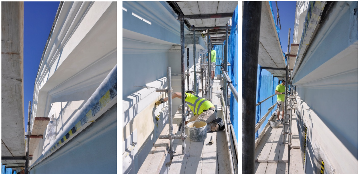
Fasad och listverk under avfärgning.
