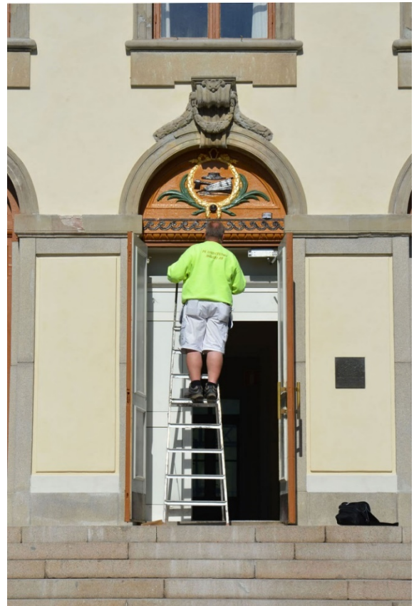
Färglagret skrapades bort och överstycket målades med de kulörer som framkommit i undersökningen.
