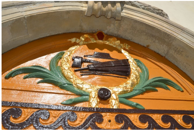
Dörröverstycket var övermålat med ett tjockt lager av alkydoljefärg.
