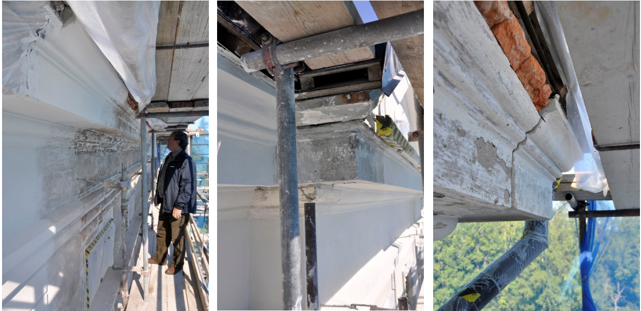
När den tidigare putsen togs bort upptäcktes att delar av listverket är uppförd i sandsten.
