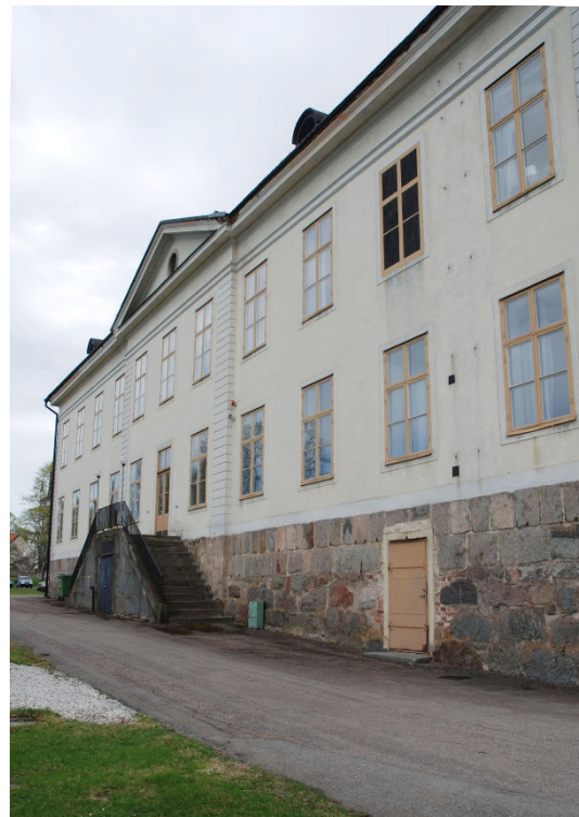
Norra fasaden 2013, innan renovering.
