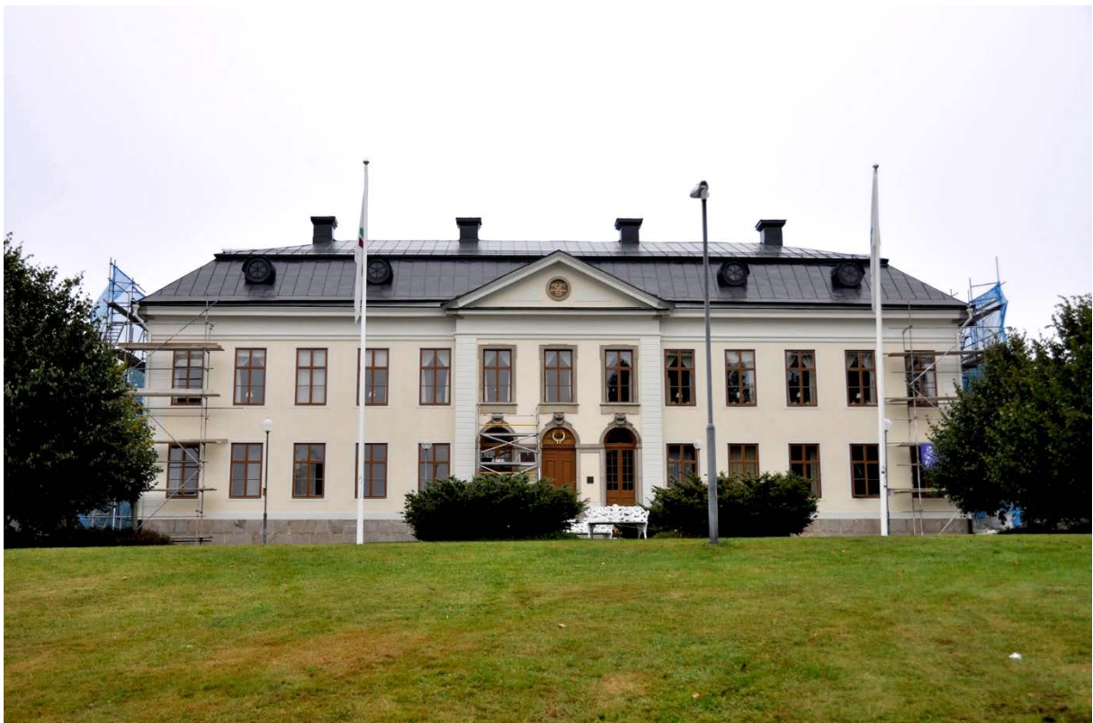
Huvudbyggnaden med färdigputsad fasad åt söder, målat tak och fönster. Konservering av sandstensdetaljerna över entrén pågår samt målning av gavlarna, september 2013.
