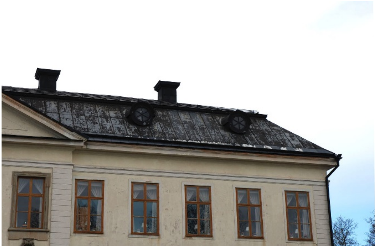
Södra takfallet innan rengöring.
