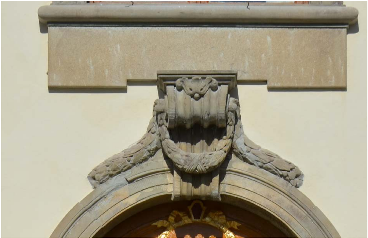
Dörromfattning i sandsten vid södra entrén, vid konserveringsåtgärder 2013.
