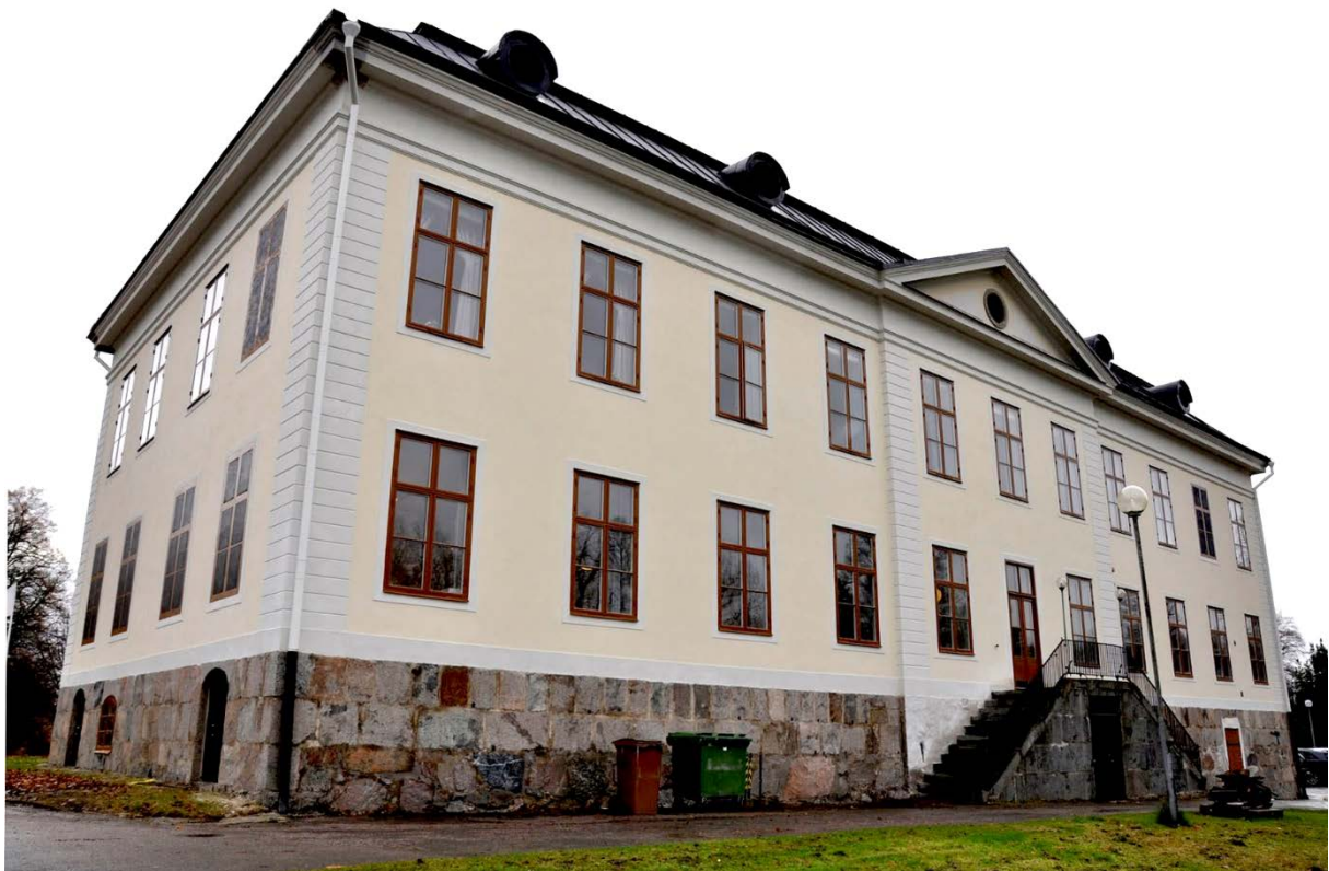
Huoudbyggnaden efter renoveringsåtgärderna, hösten 2013.
