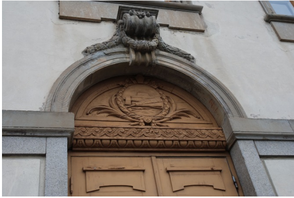
Dörröverstycket var övermålat med ett tjockt lager av alkydoljefärg.
