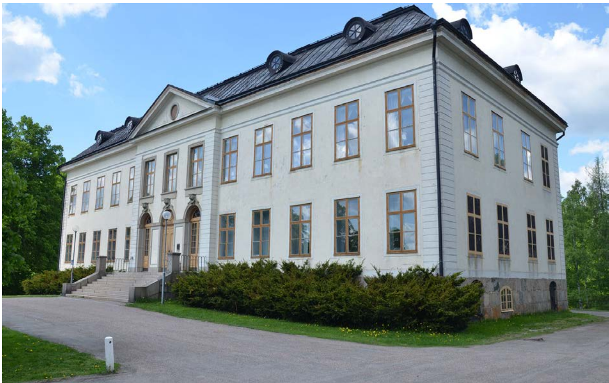
Huvudbyggnaden från sydöst innan renovering, 2013.
