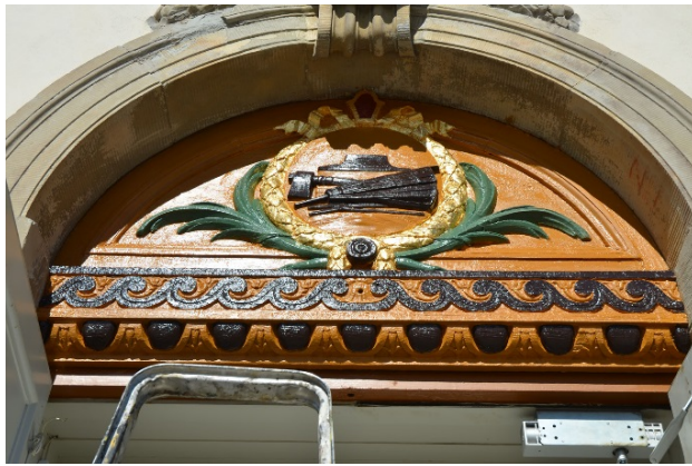
Färglagret skrapades bort och överstycket målades med de kulörer som framkommit i undersökningen.
