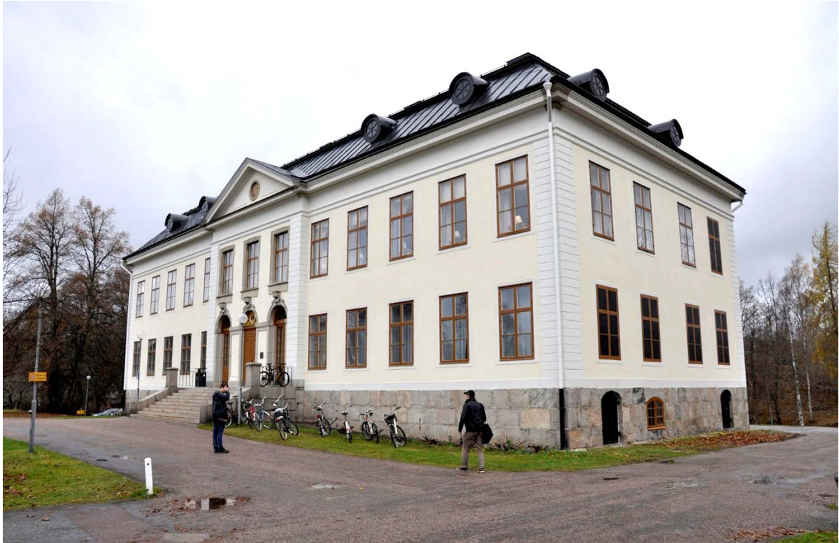
Huoudbyggnaden efter renoveringsåtgärderna, hösten 2013.
