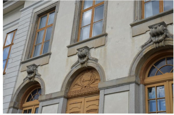
Dörröverstycket var övermålat med ett tjockt lager av alkydoljefärg.
