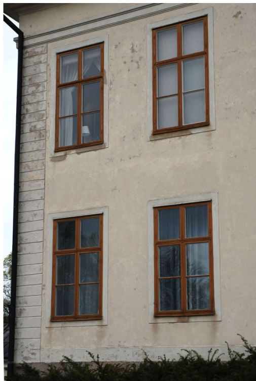
Färgsläpp på fasad mot sydväst
