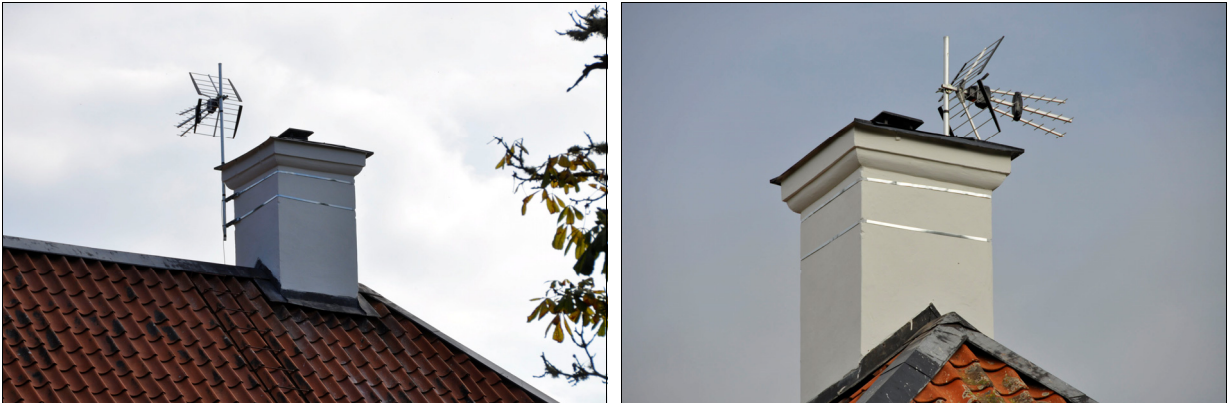
Bild 6 och 7: Skorstenen efter restaurering.
