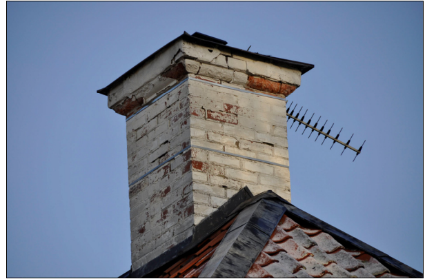
Bild 3: Skorstenen från sydväst före restaurering.
