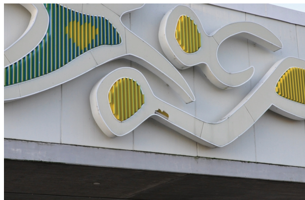
Skada på konstverket "En baddare i badet". Foto: Tobias Mårud, Vlm_kmvTM-788, beskuren.
