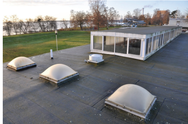
Figur 27. Lanternin och kupolfönster på omklädningspaviljongens tak. Foto: Tobias Mårud, VLM, Vlm_kmvTM-746.
