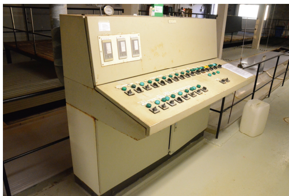
Figur 38. Manöveringscentral för den tekniska utrustningen. Foto: Fredrik Ehrlton, VLM, Vlm_kmvFE-2074.
