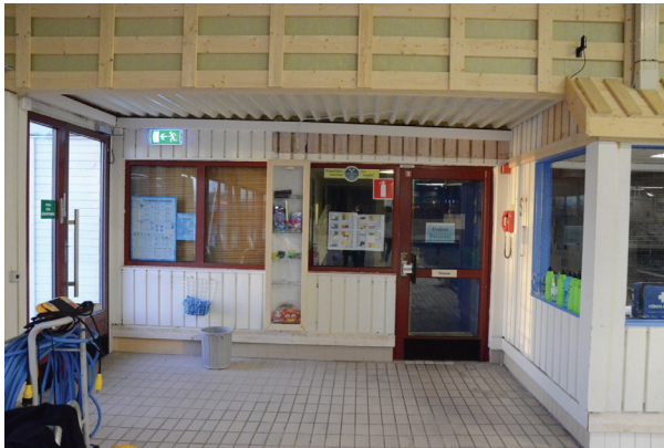
Funktionärsbyggnadens östra fasad numera inne i simhallen. Foto: Fredrik Ehlton, Vlm_kmvFE-2069.
