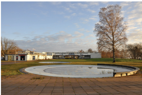
Plaskdammar samt entré- och omklädningsbyggnad sedd från väster. Foto: Tobias Mårud, Vlm_kmvTM-770.
