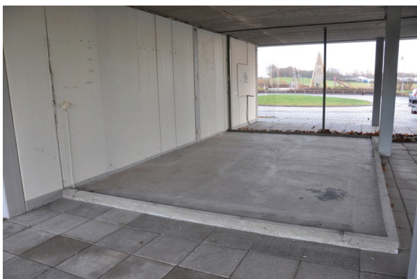
Endast bottenplattan finns kvar från entréns biljettlucka. Foto: Tobias Mårud, Vlm_kmvTM-728.
