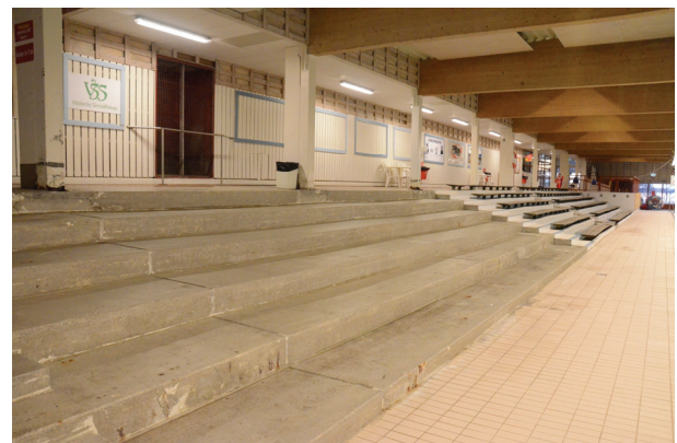
Figur 34. Läktaren var ursprungligen okaklad med sittbrädor i trä, här sektion under renovering. Foto: Fredrik Ehlton, VLM, Vlm_kmvFE-2060.
