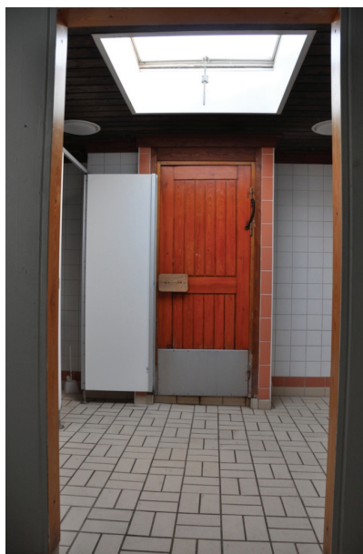
Figur 21. Duschrum med mönsterlagt kakelgolv, kupolfönster och dörr till bastu. Foto: Tobias Mårud, VLM, Vlm_kmvTM-731.
