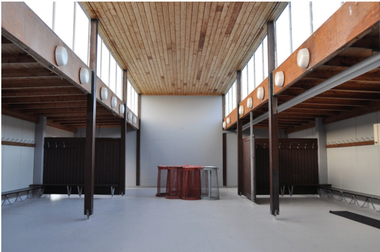
Figur 28. Omklädningspaviljongen är konstruerad likt en treskeppig basilika. Foto: Tobias Mårud, VLM, Vlm_kmvTM-720.
