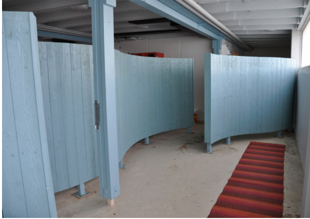
Figur 23. Omklädningsrummen är avdelade med böljande rumsavskiljare. Foto: Tobias Mårud, VLM, Vlm_kmvTM-730.
