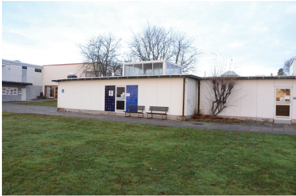
Figur 26. Massomklädnadsdelen, västra änden av omklädningspaviljongen. Foto: Fredrik Ehltton, VLM, Vlm_kmvFE-2096.
