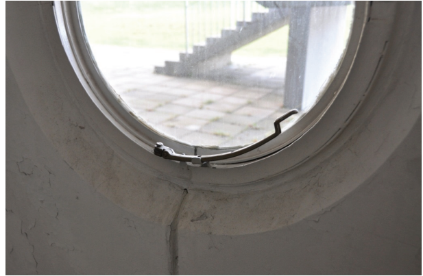
Stilfulla fönsterhakar på personalutrymmenas runda fönster. Foto: Tobias Mårud, Vlm_kmvTM-723.
