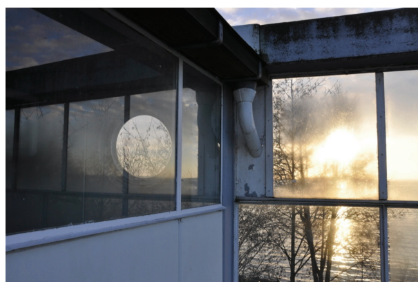
Figur 19. Bilden visar bland annat detaljlösning på vattenavrinningen, södra delen av soldäcket. Foto: Tobias Mårud, VLM, Vlm_kmvTM-751.
