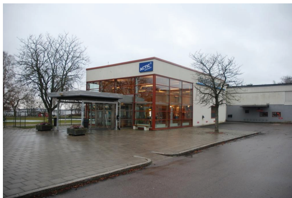
Den nya entrébyggnaden. Foto: Tobias Mårud, Vlm_kmvTM-586.
