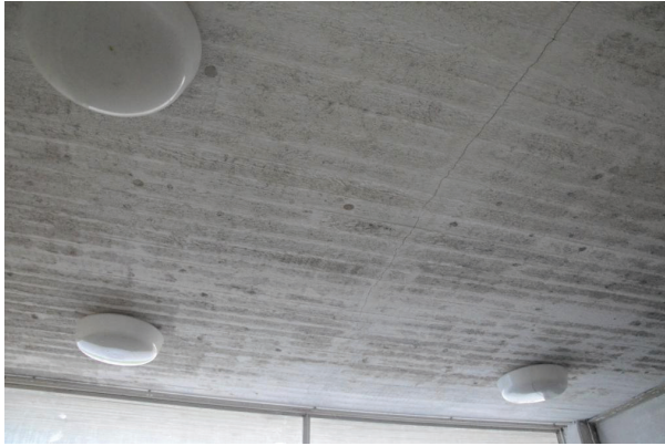
Det gjutna innertaket visar spår av gjutformarnas brädor. Tidsenliga armaturer. Foto: Fredrik Ehlton, Vlm_kmvFE-2102.
