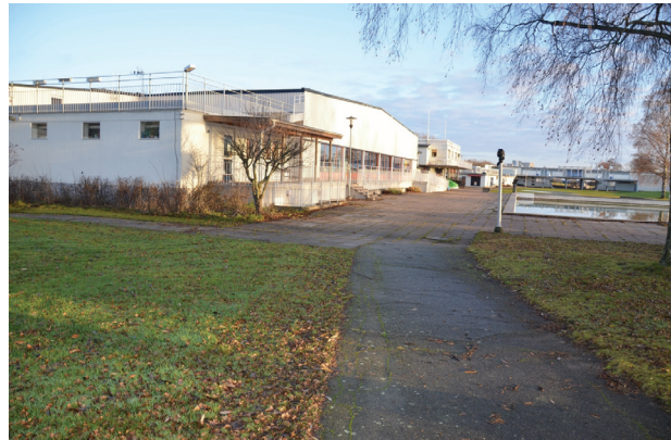
Badets byggnader sett från väster. Foto: Fredrik Ehlton, Vlm_kmvFE-2143.
