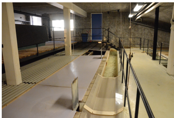
Figur 36. Mycket av den tekniska utrustningen är ännu i bruk, här filtrering och flockningsbassäng till höger. Foto: Fredrik Ehrlton, VLM, Vlm_kmvFE-2077.
