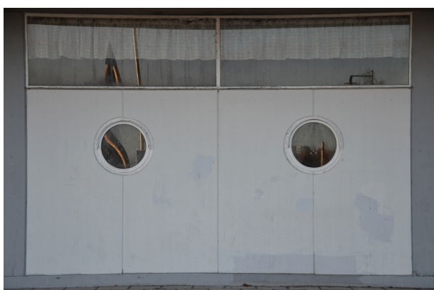
Figur 18. Sektion av entrébyggnadens östra fasad som visar den sparsmakade och väl genomtänkta fönstersättningen. Foto: Fredrik Ehlton, VLM, Vlm_kmvFE-2156.
